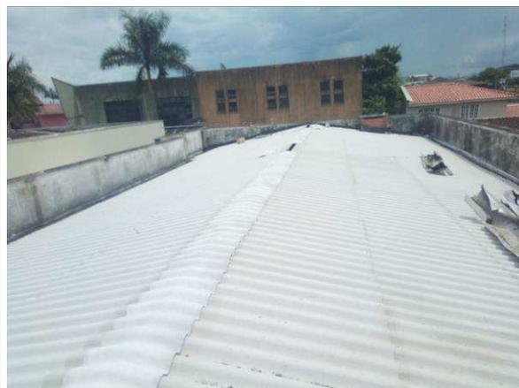
Figura 02c: cobertura do anexo arquivo - telhas substituídas
