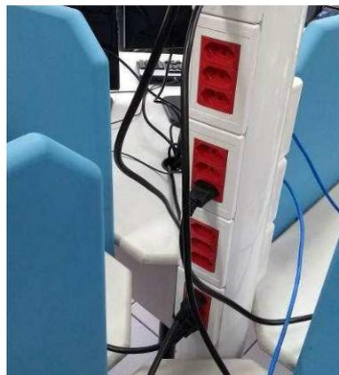
Figura 24: Coluna técnica, porta equipamentos, tomadas e blocos cegos
