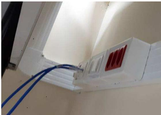
Figura 23: Canaleta de alumínio e tomadas elétricas e lógicas
