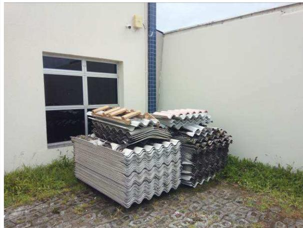
Figura 08c - telhas removidas
