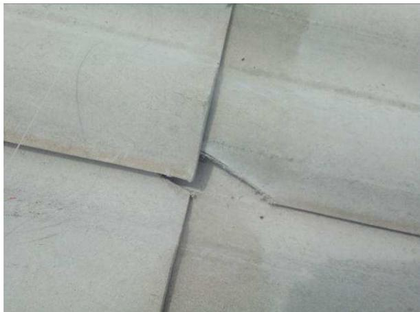
Figura 07c: recorte na telha fibrocimento
