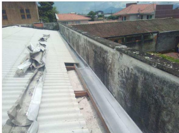
Figura 03c: calhas instaladas no anexo arquivo
