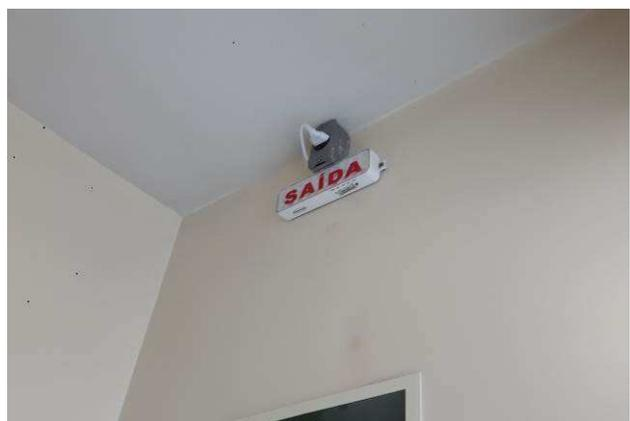
Figura 19: Bloco de iluminação de emergência
