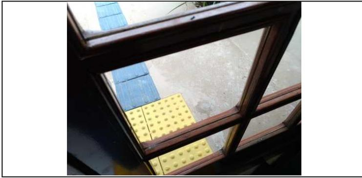
Figura 2 - Substituição de vidros comuns, por vidro temperado, inclusive a colocação de baquetes.
