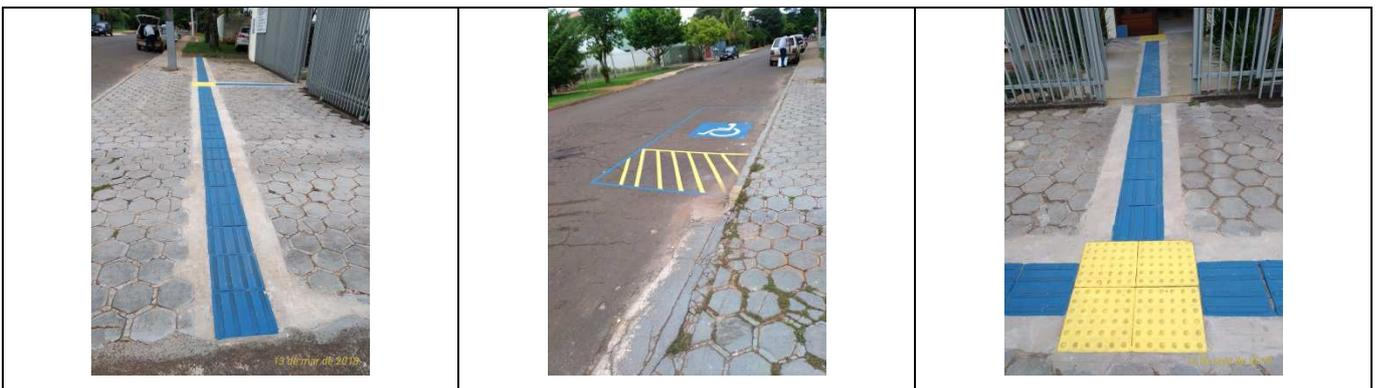
Figura 4 - Complementação de calçada em concreto, instalação e pintura de piso podotátil externo. Pintura faixa de demarcação em vaga especial.
