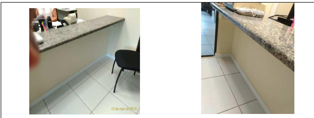
Figura 6 - Adaptação de balcão em gesso acartonado e tampo em granito.
