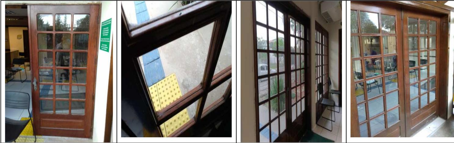
Figura 14: Recolocação da porta de madeira da fachada e fornecimento e instalação de vidros temperados com baquetes.
