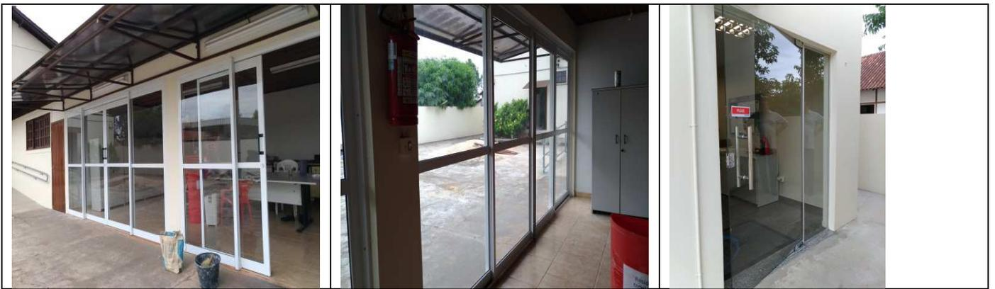
Figura 15: Fornecimento e instalação de porta janela em alumínio com vidro comum na área de vivência. Porta janela em vidro temperado na secretaria.
