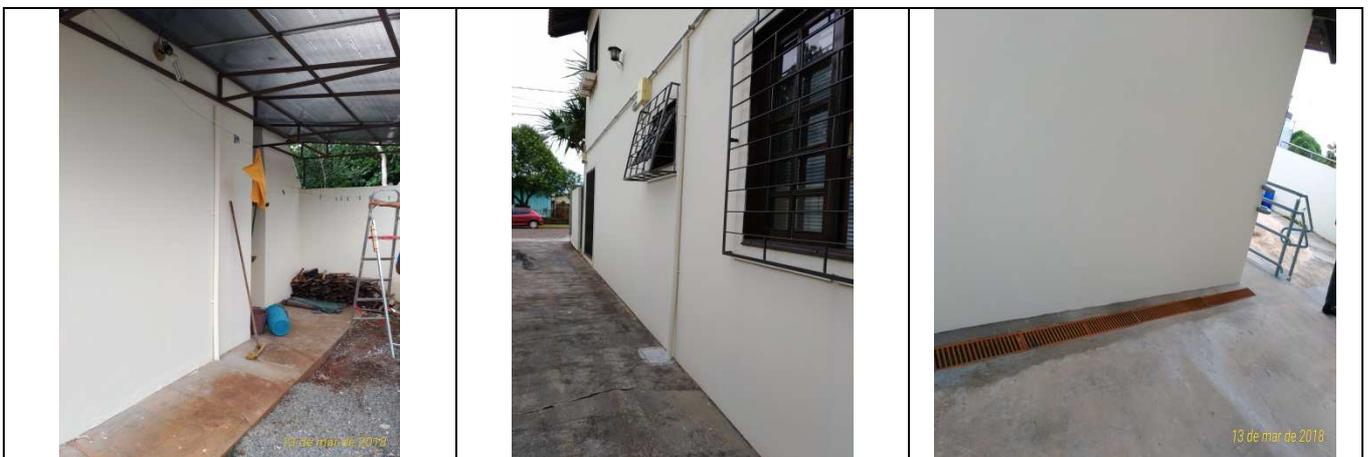
Figura 23 - Pintura externa - Paredes onde houve intervenções.
