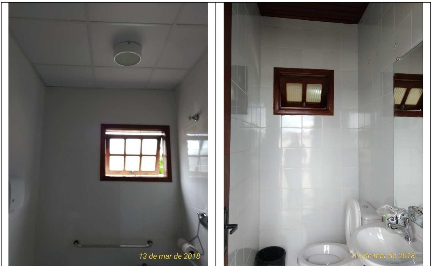
Figura 18 - Azulejos no banheiro adaptado e no banheiro externo.
