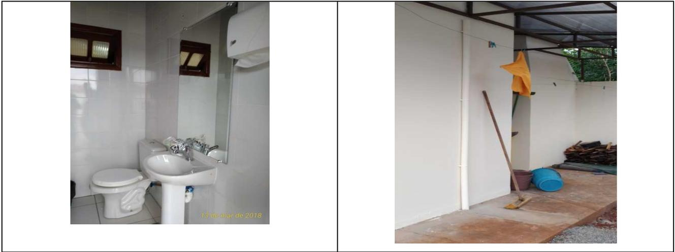
Figura 11: Vaso Sanitário com caixa acoplada, assento, lavatório de coluna, espelho, saboneteira, papelarias, torneira presmatic, toalheiro tipo gancho e ponto de ventilação do esgoto.
