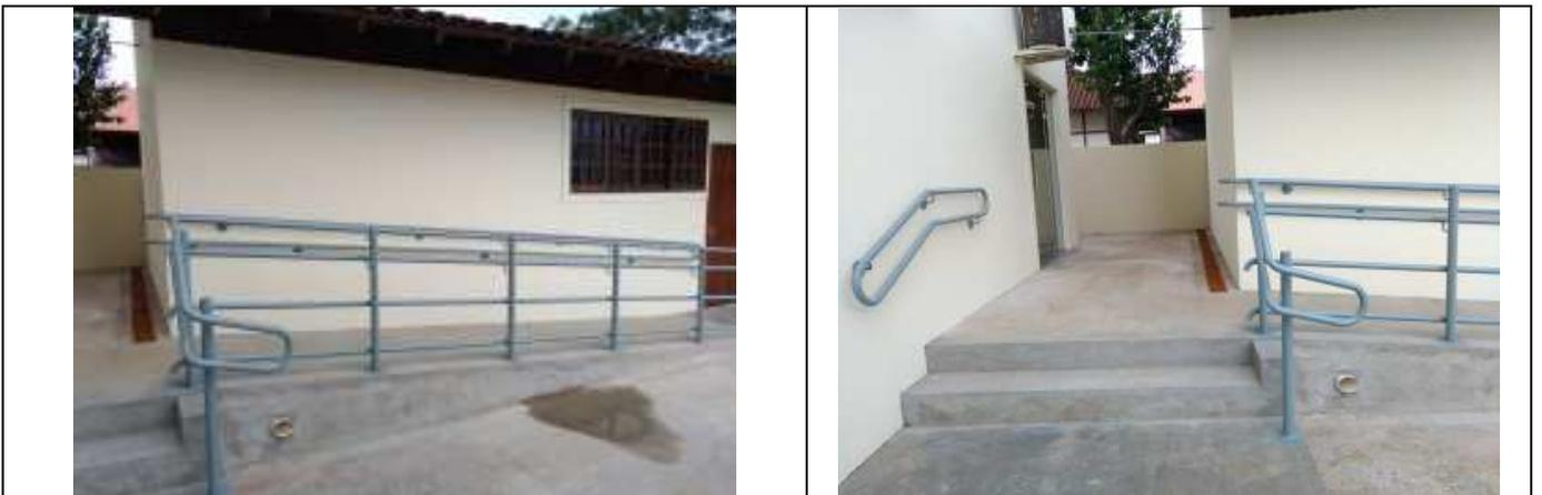
Figura 16: Fornecimento e instalação de corrimão e guarda corpo em rampa externa.
