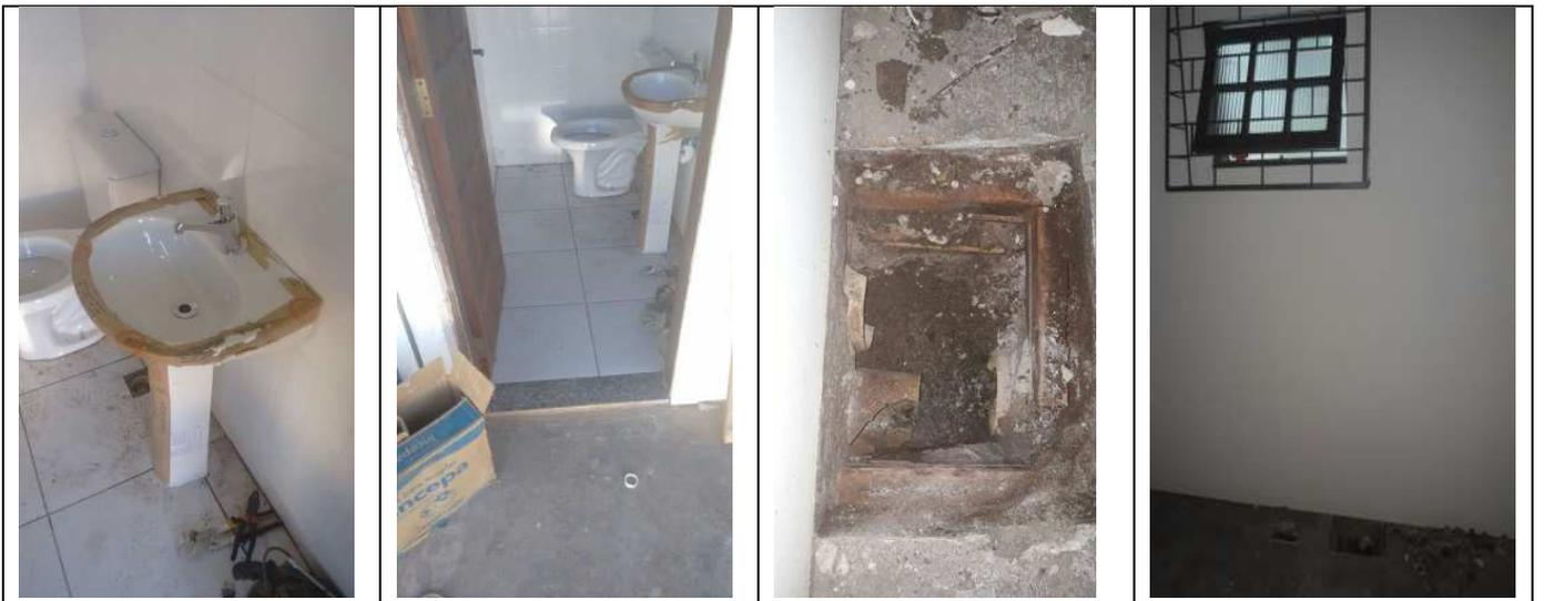
Figura 1 - Foram substituídas as louças / aparelhos sanitários, demolição de calçada para instalação de ventilação esgoto
