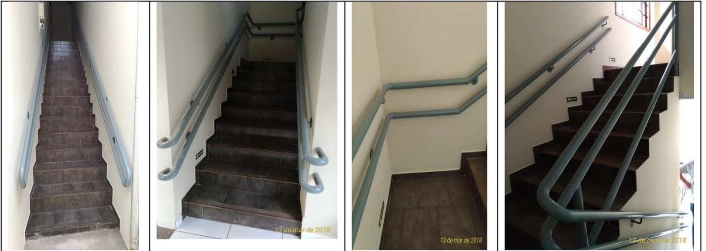
Figura 17: Fornecimento e instalação de corrimão e guarda corpo em escadas.
