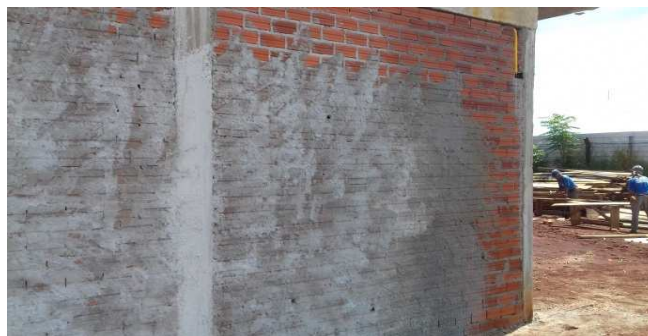
Figura 23C: segmento de parede com chapisco parcial
