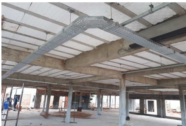
Figura 01E: Eletrocalha #200x50, L e T, perfilados - bloco esquerdo
