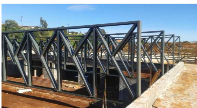
Figura 13C: Tesouras metálicas instaladas no bloco central
