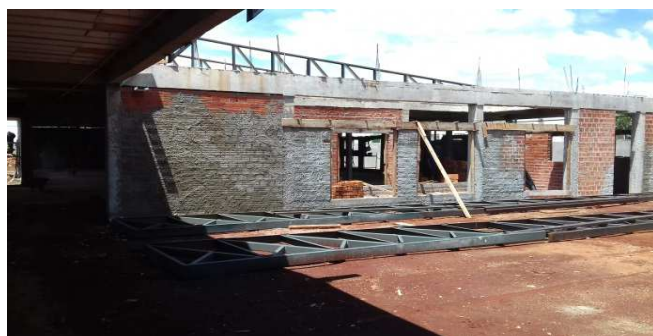
Figura 10C: Detalhe de alvenaria e seu encunhamento na viga
