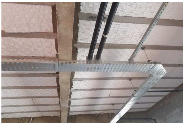
Figura 19E: Eletrodutos PVC rígidos 2"
