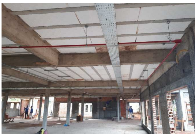
Figura 25E: Eletroduto rígido PVC, condutes - SDAI
