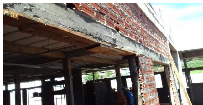
Figura 05C: Vergas em janelas - bloco central
