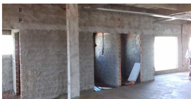
Figura 09C: Alvenaria interna concluída, no bloco da direita
