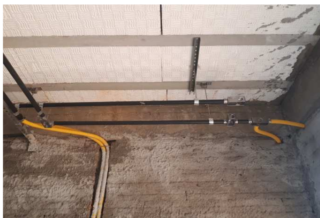
Figura 31E: Eletroduto rígido de 1" e condutores para Sistema de CFTV
