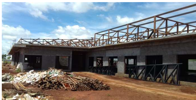
Figura 20C: Chapisco em paredes externas - frontal
