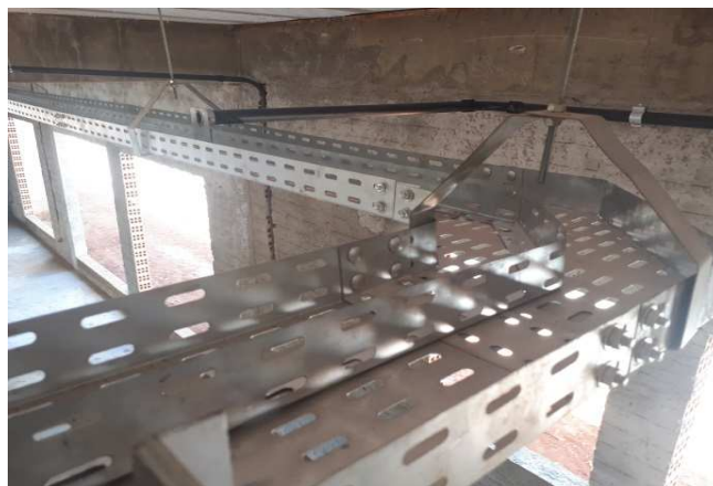
Figura 08E: Instalação de Septos divisores em toda eletrocalhas
