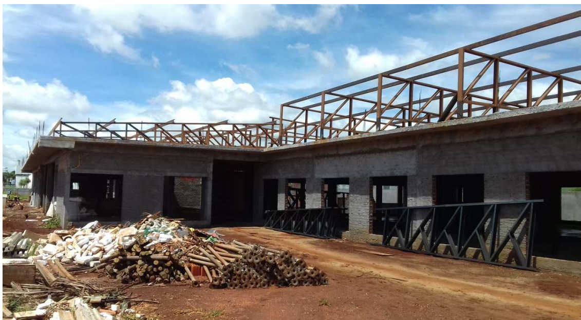
Figura 01C: Visão geral da obra
