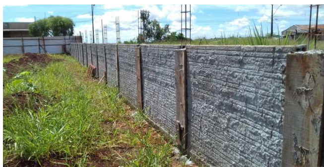
Figura 28C: Chapisco em muro - lateral esquerda
