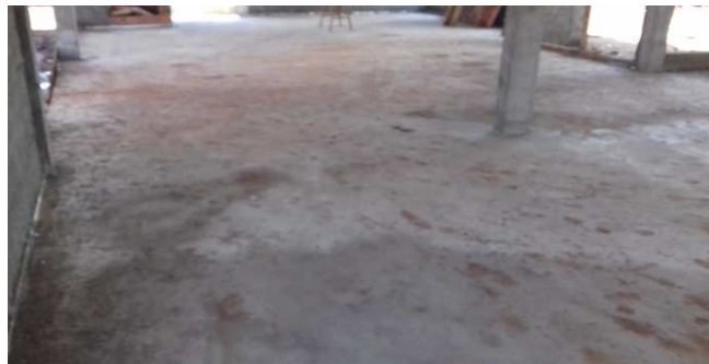
Figura 27C: Contrapiso já com camada regularizante - bloco esquerdo
