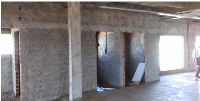
Figura 16C: Chapisco interno, executado no bloco da direita
