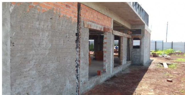
Figura 21C: Chapisco em paredes externas - lateral esquerda
