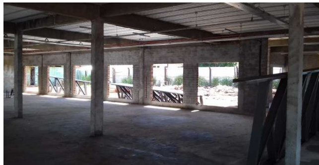
Figura 17C: Chapisco interno, executado no bloco da direita
