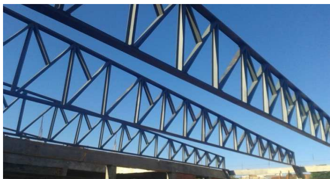
Figura 14C: Tesouras metálicas instaladas no bloco central
