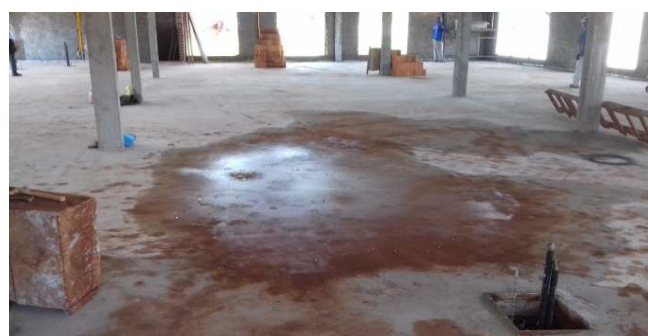
Figura 25C: Contrapiso executado e já com camada de regularização - bloco esquerdo
