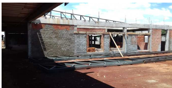
Figura 18C: Chapisco parcial, executado no bloco central
