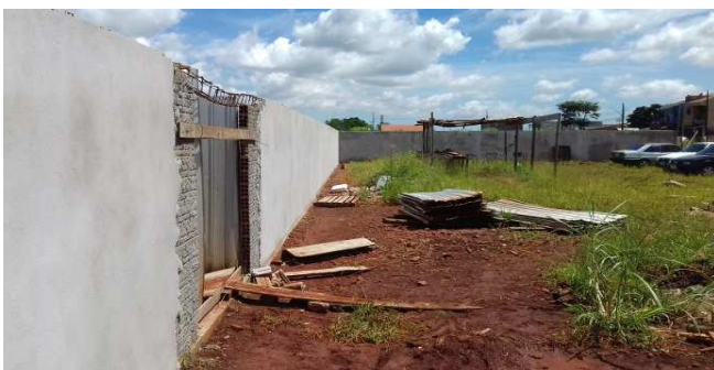
Figura 31C: Muro dos fundos e lateral direita - Rebôco
