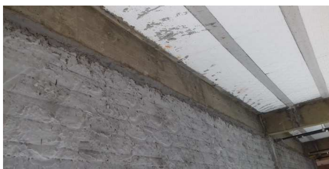
Figura 10C: Detalhe de alvenaria e seu encunhamento na viga
