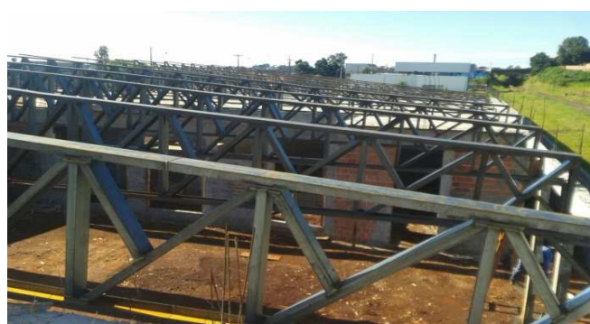
Figura 12C: Tesouras metálicas instaladas no bloco central
