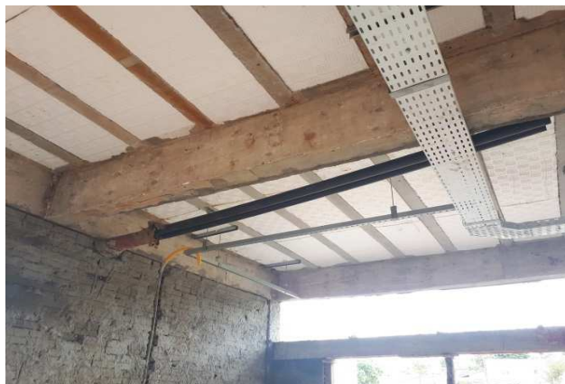
Figura 20E: Eletrodutos PVC rígidos 2"
