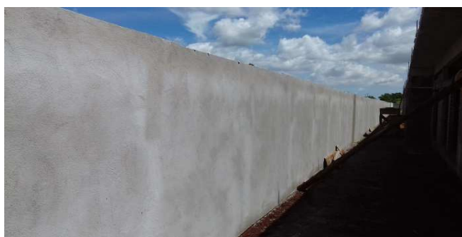
Figura 30C: Reboco da face interna do muro - fundos
