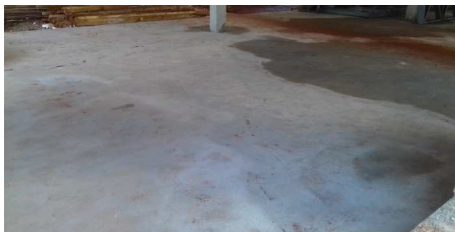
Figura 26C: Contrapiso regularizado no bloco da direita
