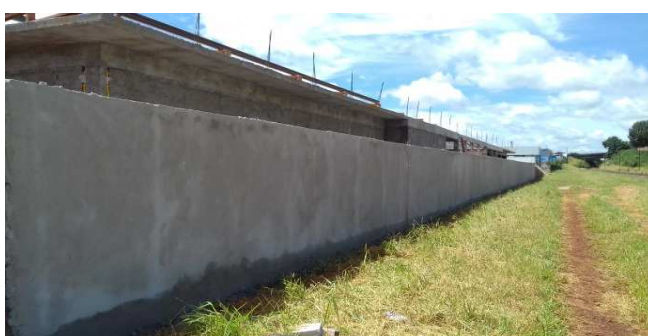
Figura 29C: Emboço/Rebôco do muro dos fundos - face externa
