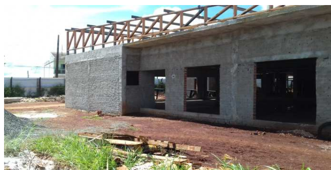
Figura 22C: Chapisco em paredes externas - lateral direita
