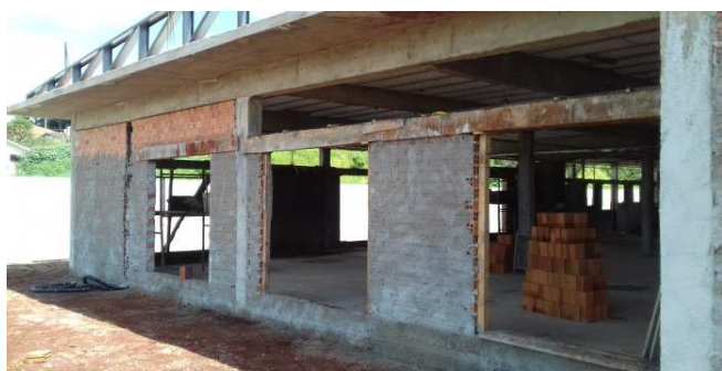
Figura 08C: Panos de alvenaria (1 vez), na lateral esquerda do obra
