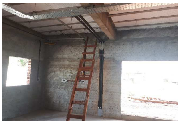
Figura 17E: Eletrodutos PVC rígidos 2"
