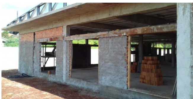
Figura 04C: Vergas e contravergas em janelas - face esquerda da obra
