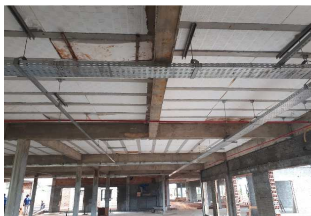
Figura 26E: Eletroduto rígido PVC, condutes - SDAI
