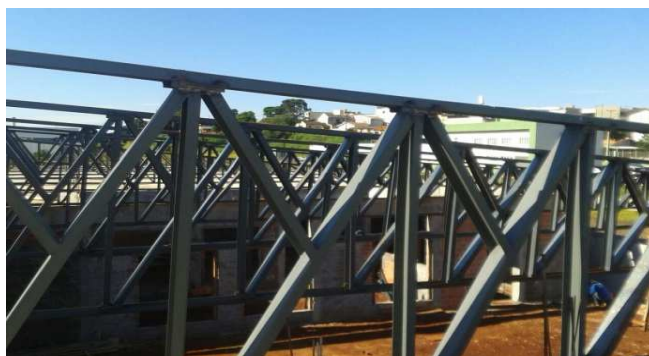
Figura 15C: Tesouras metálicas instaladas no bloco central
