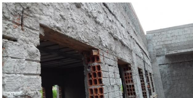
Figura 06C: Contravergas instaladas em todo o prédio principal e arquivo
