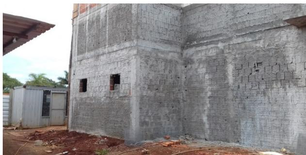
Figura 17C: Chapisco executado em toda a face externa das paredes
