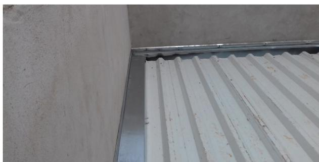
Figura 09C: Rufos instalados nas coberturas
