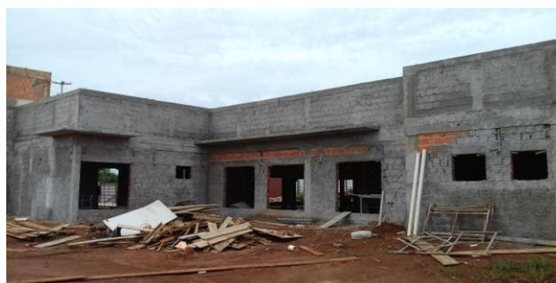
Figura 16C: Chapisco executado em toda a face externa das paredes - lateral direita
