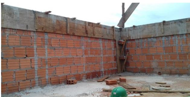
Figura 03C: Vigas e pilares do reservatório
