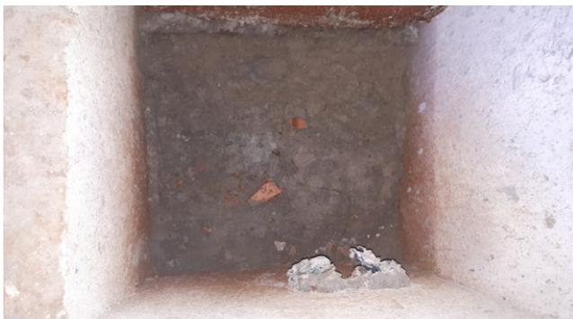
Figura 27E: Caixa 50x50cm para entrada de telecomunicações, instalada no site.
