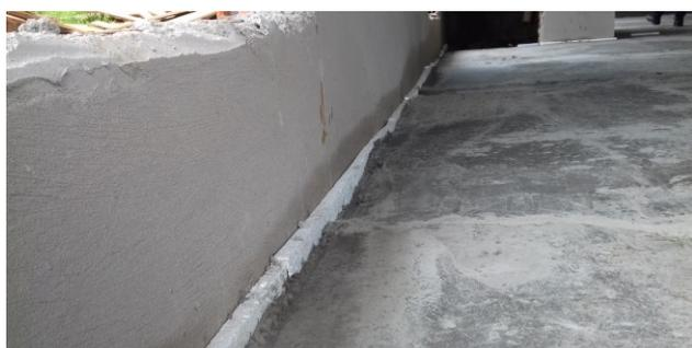
Figura 23C: Detalhe de EPS instalado para dessolidarizar contrapiso da alvenaria
