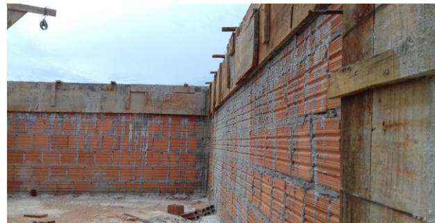
Figura 04C: Vigas e pilares do reservatório
