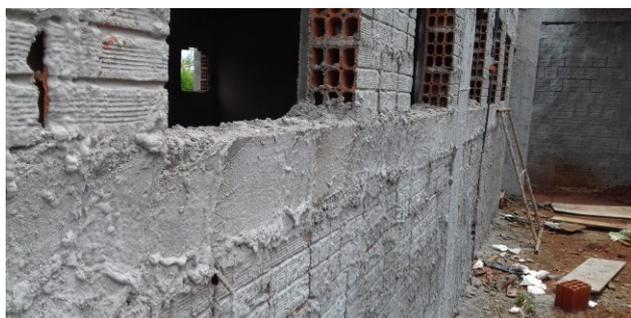
Figura 05C: Contravergas instaladas em todo o prédio principal e arquivo
