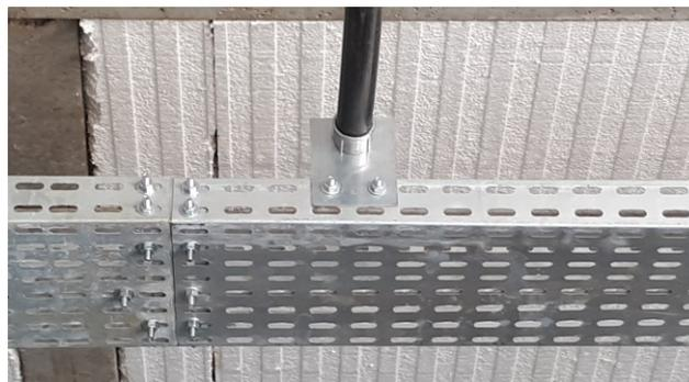
Figura 18E: Infraestrutura de eletrodutos e caixas 2x4" e 4x4".
