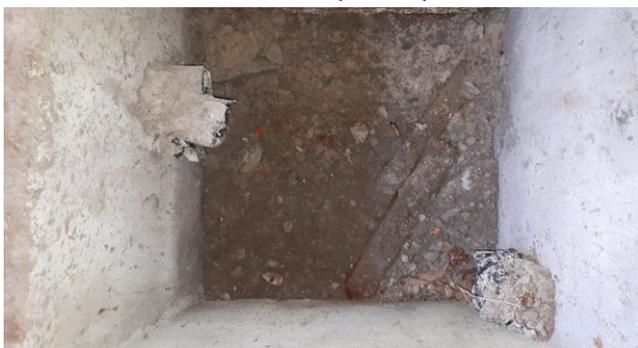
Figura 5E: Caixa 50x50 instalada na sala técnica para passagem do cabeamento de entrada - QDG
