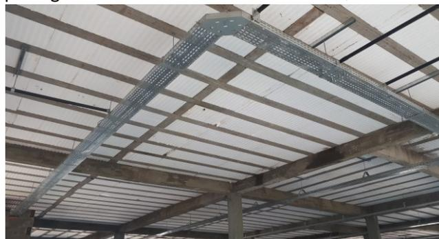
Figura 7E: Infraestrutura de eletrocalhas, perfilados e eletrodutos.
