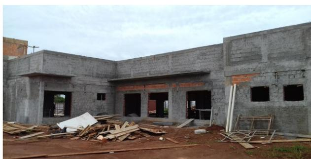
Figura 07C: alvenaria concluída nos dois blocos
