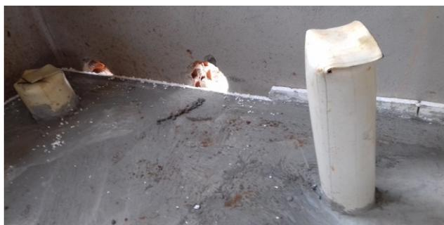
Figura 27C: Ponto de esgoto primário no arquivo - vaso sanitário
