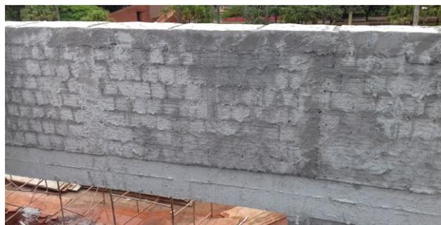
Figura 18C: Chapisco executado em toda a face externa das paredes - volume frontal
