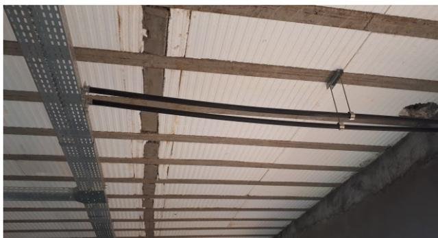
Figura 21E: Infraestrutura de eletrodutos e caixas 2x4" e 4x4".
