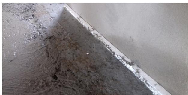
Figura 24C: Detalhe de EPS instalado para dessolidarizar contrapiso da alvenaria
