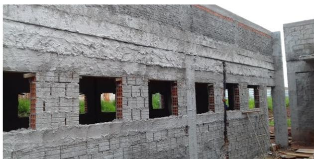
Figura 15C: Chapisco executado em toda a face externa das paredes - fundos
