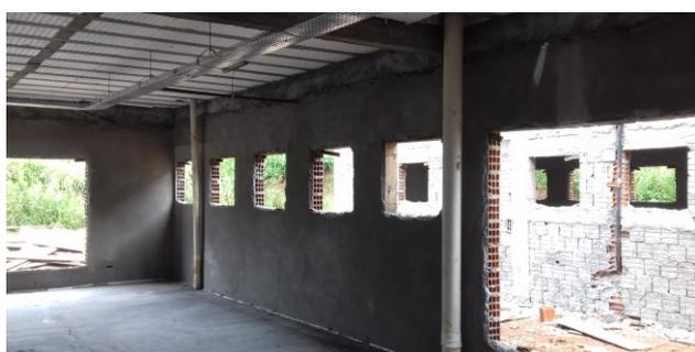
Figura 13C: Chapisco e emboço com rebôco executados nas faces internas das paredes
