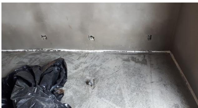
Figura 17E: Infraestrutura de eletrodutos e caixas 2x4" e 4x4".
