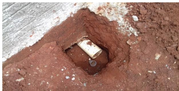
Figura 02C: Valas abertas para passagem de tubulação de esgoto
