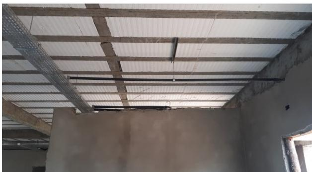
Figura 22E: Infraestrutura de eletrodutos e caixas 2x4" e 4x4".
