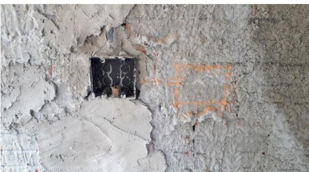
Figura 16E: Infraestrutura de eletrodutos e caixas 2x4" e 4x4".
