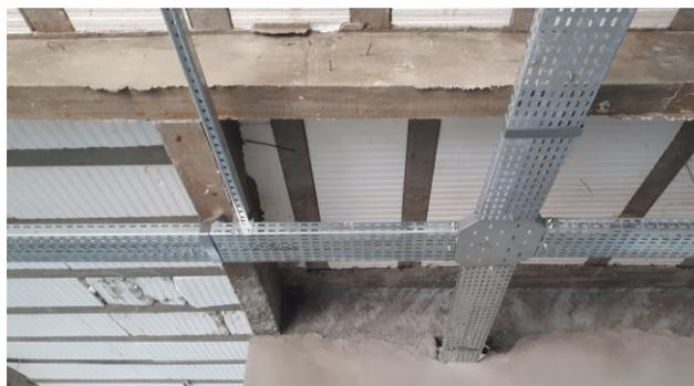
Figura 12E: Infraestrutura de eletrocalhas, perfilados e eletrodutos.
