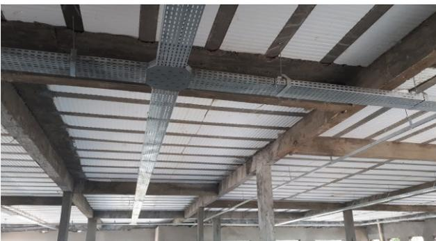
Figura 8E: Infraestrutura de eletrocalhas, perfilados e eletrodutos.
