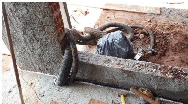
Figura 2E: Eletrodutos PEAD de entrada de energia elétrica e entrada de telecomunicações.
