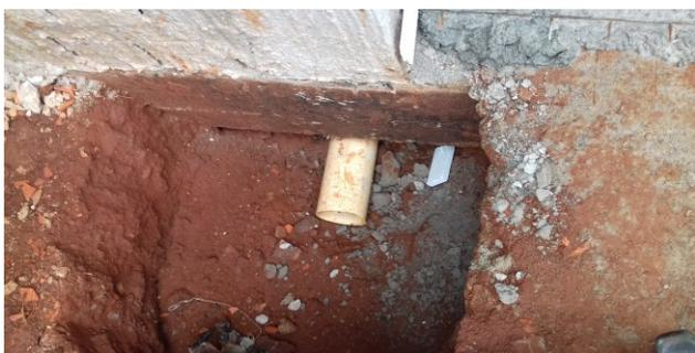
Figura 01C: Valas abertas para passagem de tubulação de esgoto
