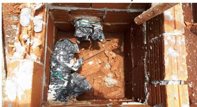
Figura 3E: Caixas 50x50 externas para passagem do cabeamento de entrada - QDG e QDPab
