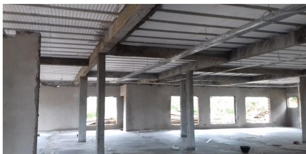
Figura 11C: Chapisco e emboço com rebôco executados nas faces internas das paredes
