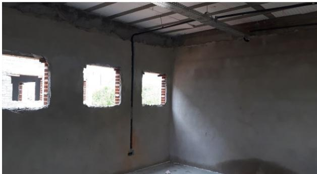
Figura 20E: Infraestrutura de eletrodutos e caixas 2x4" e 4x4".
