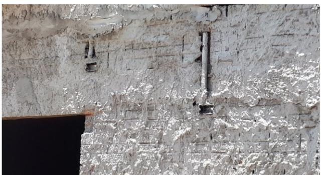
Figura 15E: Infraestrutura de eletrodutos e caixas 2x4" e 4x4".
