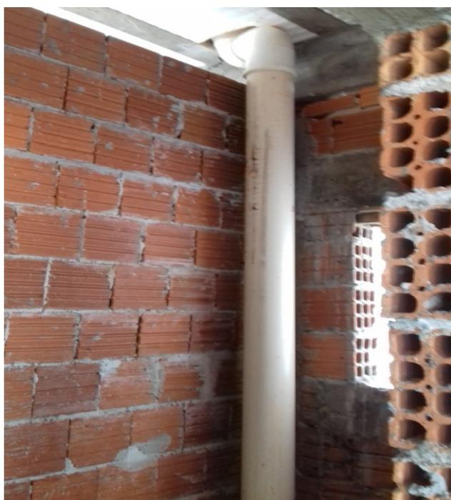
Figura 30: Prumada pluvial de 100mm no prédio principal
