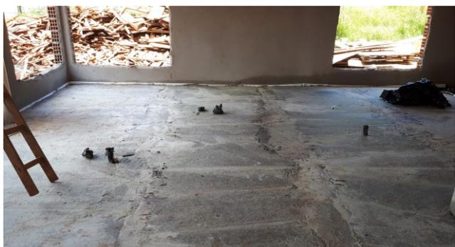
Figura 23E: Infraestrutura de eletrodutos e caixas 2x4" e 4x4".
