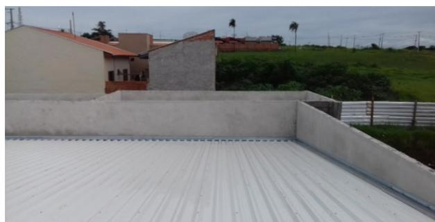
Figura 10C: Rufos instalados nas coberturas
