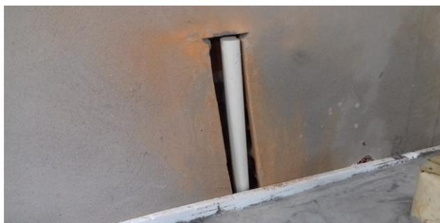
Figura 25C: Ponto de esgoto secundário no arquivo - lavatório
