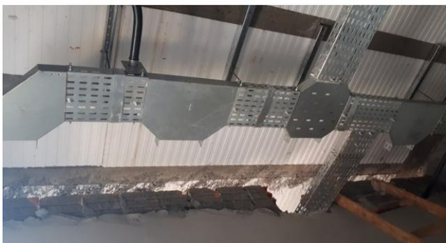
Figura 11E: Infraestrutura de eletrocalhas, perfilados e eletrodutos.
