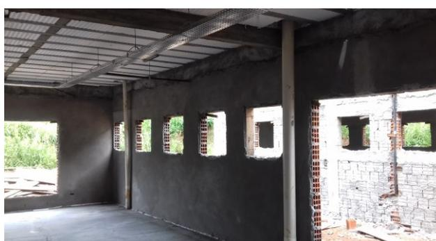
Figura 29: Prumadas pluviais de 150mm no prédio principal
