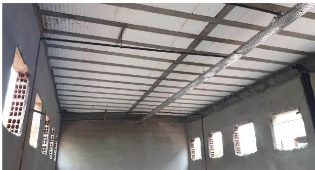
Figura 19E: Infraestrutura de eletrodutos e caixas 2x4" e 4x4".
