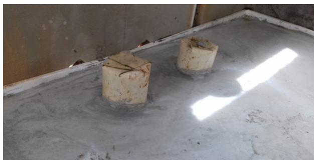
Figura 26C: Ponto de esgoto primário no arquivo - vaso sanitário
