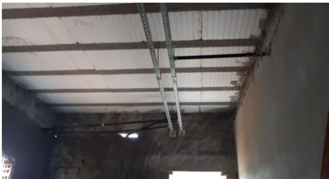
Figura 13E: Infraestrutura de eletrocalhas, perfilados e eletrodutos.
