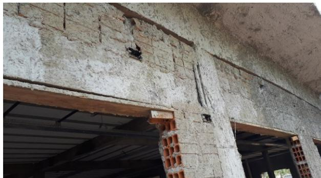
Figura 14E: Infraestrutura de eletrodutos e caixas 2x4" e 4x4".
