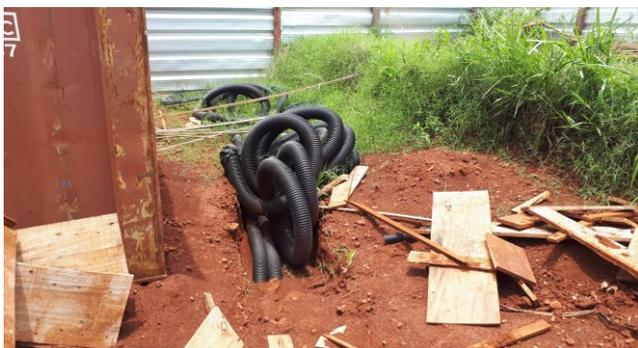
Figura 1E: Eletrodutos PEAD de entrada de energia elétrica e entrada de telecomunicações.
