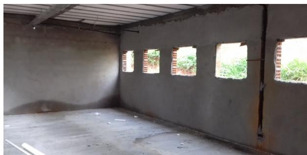
Figura 12C: Chapisco e emboço com rebôco executados nas faces internas das paredes
