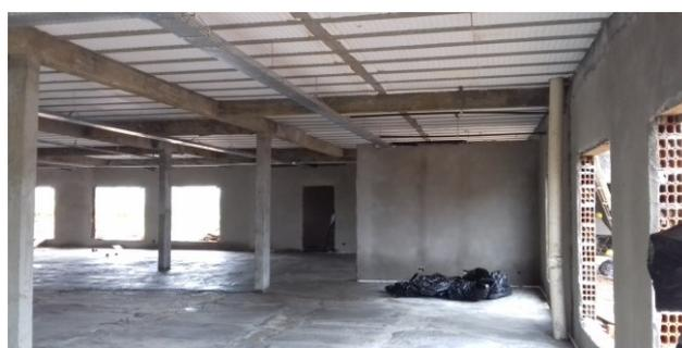
Figura 14C: Chapisco e emboço com rebôco executados nas faces internas das paredes
