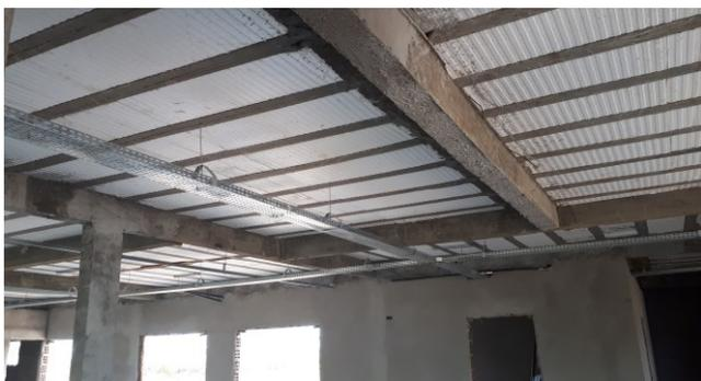
Figura 9E: Infraestrutura de eletrocalhas, perfilados e eletrodutos.
