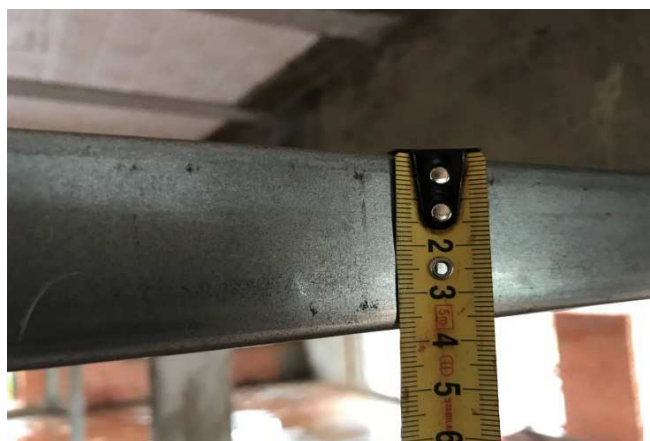
Figura 12E: Aferição da altura do perfilado - 38mm
