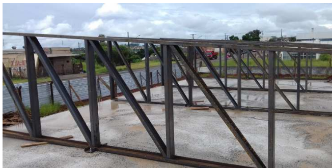
Figura 27C: Tesouras metálicas instaladas no bloco da esquerda - treliças tipo A
