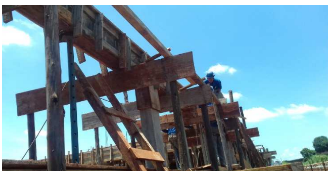
Figura 09C: Fôrmas de viga localizada nos fundos - porção central
