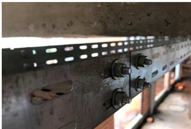
Figura 05E: Detalhe de emenda executada entre eletrocalhas
