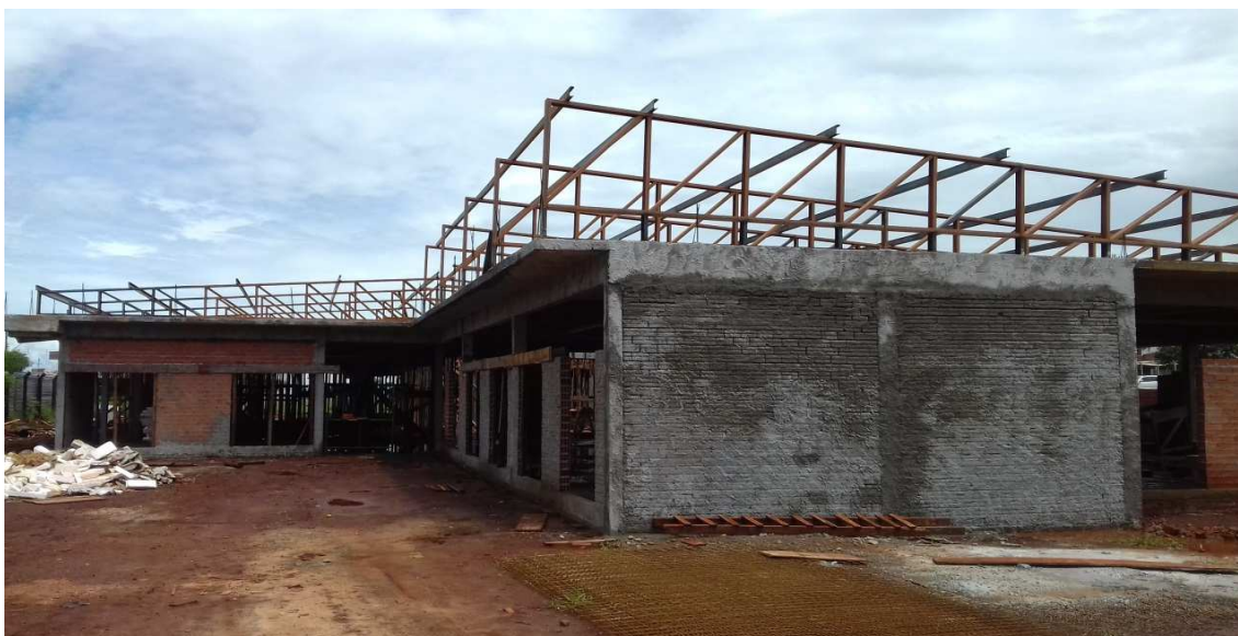
Figura 01C: Visão geral da obra
