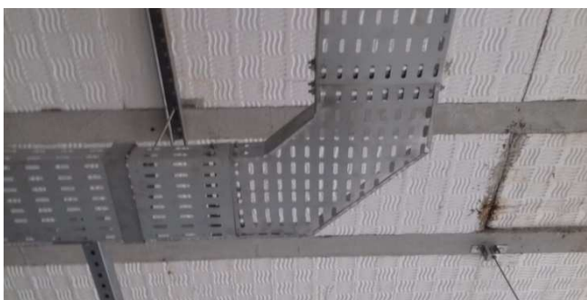
Figura 13E: Curva de 90 graus em eletrocalha
