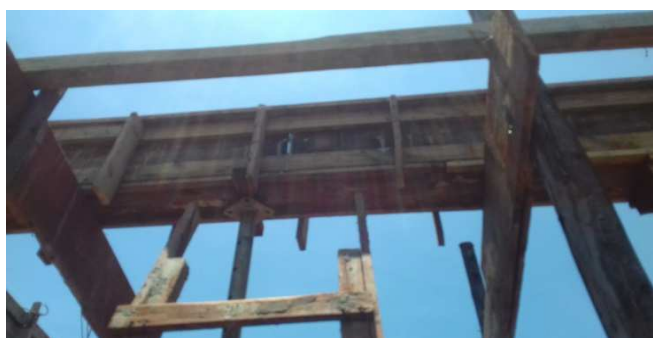
Figura 08C: Fôrmas de viga localizada nos fundos - porção central
