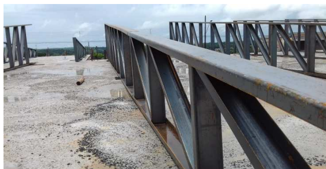
Figura 30C: Tesouras metálicas (tipo A), em perfil
