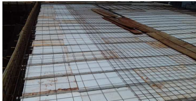
Figura 07C: Vigotas, lajotas de EPS e armadura de distribuição (tela soldada) em laje pré - porção central, na frente do imóvel
