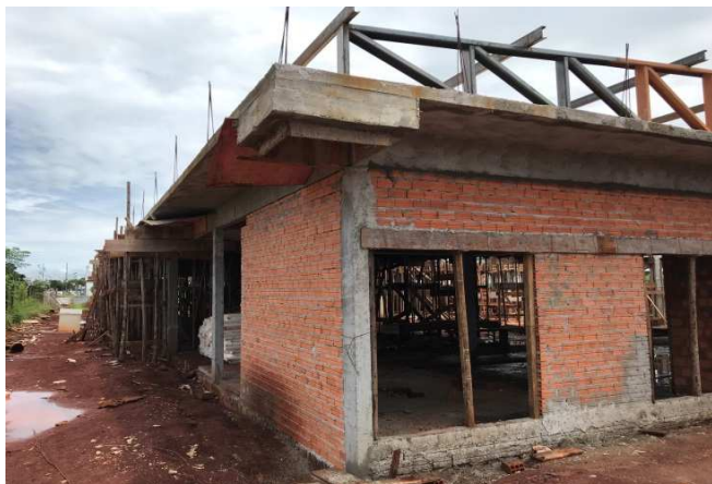
Figura 21C: Alvenaria externa na lateral direita, também alcançando a altura do fundo da viga
