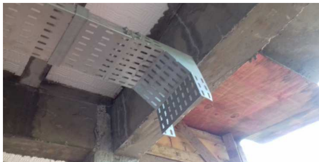
Figura 17E: Curva de inversão 90 graus, para descida de eletrocalha
