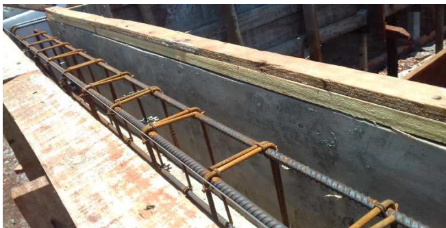
Figura 04C: Fôrmas e armaduras de viga na porção central - frente
