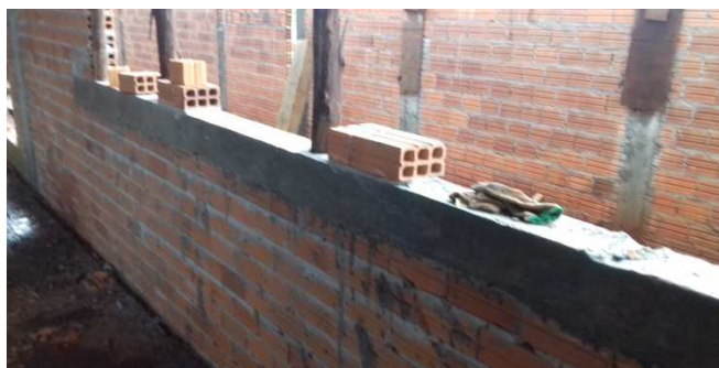
Figura 16C: Contravergas executadas na porção direita (parede dos fundos)
