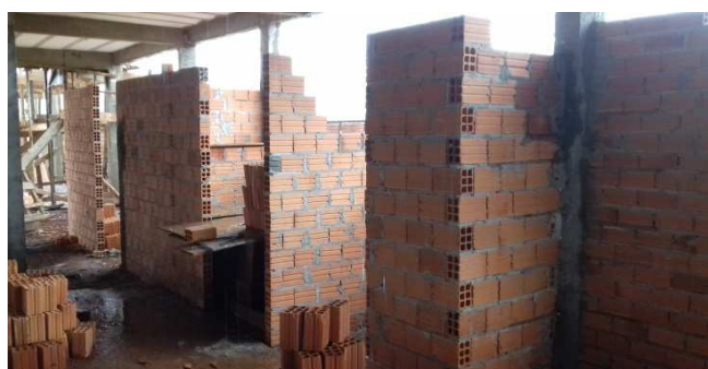
Figura 20C: Alvenaria internas até meia altura, na região da copa e sanitários
