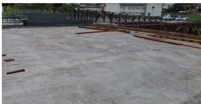
Figura 13C: Panos de lajes da porção frontal (centro) após concretagem
