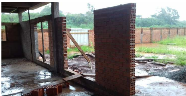
Figura 23C: Alvenarias externas executadas até meia altura em trecho da lateral direita
