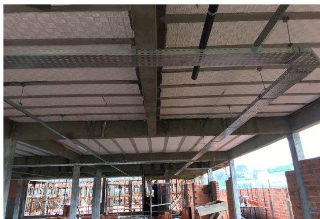
Figura 08E: Trechos de eletrocalha #200x50 fazendo uma curva de 90 graus
