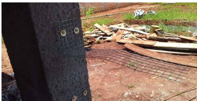
Figura 25C: Detalhe da tela de solidarização alvenaria-pilar
