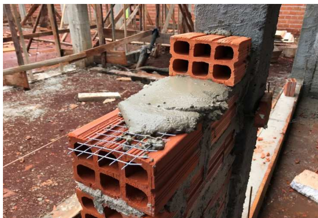
Figura 22C: Fiada de alvenaria sendo rejuntada, com o detalhe da tela de solidarização com coluna
