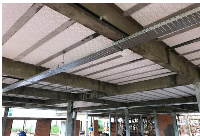
Figura 06E: Segmento de eletrocalha #200x50, instalado no bloco da direita
