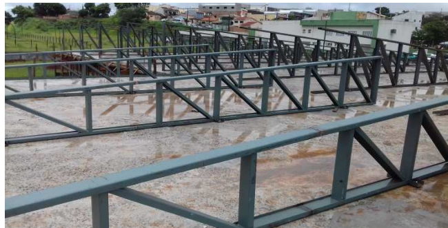
Figura 28C: Tesouras metálicas instaladas no bloco central (frente) - treliças tipo B
