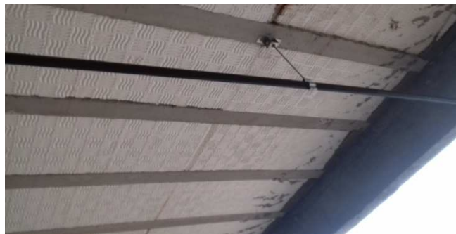
Figura 17E: Curva de inversão 90 graus, para descida de eletrocalha
