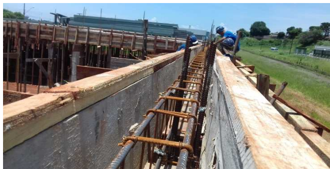
Figura 05C: Fôrmas e armaduras de viga na porção central - fundos
