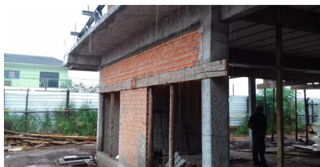
Figura 15C: Vergas executadas na porção direita (parede lateral)
