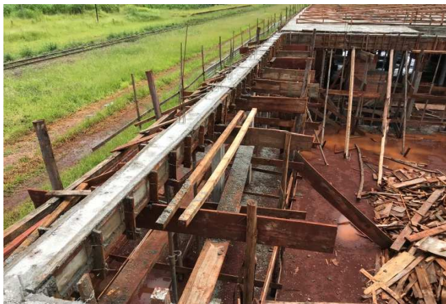
Figura 10C: Mesma viga da figura 09C, após concretagem
