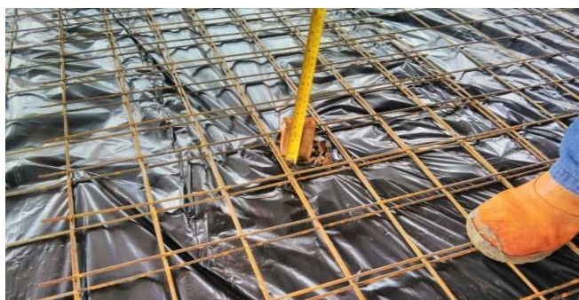
Figura 31C: Lona plástica preta instalada antes da concretagem do contrapiso
