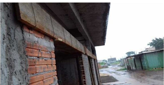
Figura 14C: Vergas executadas na porção direita (parede frontal)
