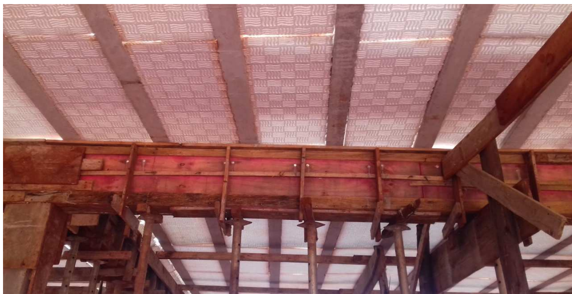
Figura 03C: Fôrmas e escoramento de viga na porção central do imóvel
