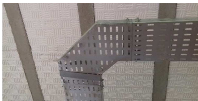
Figura 14E: Curva de 90 graus em eletrocalha
