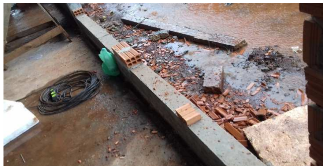
Figura 17C: Contravergas executadas na porção direita (parede frontal)
