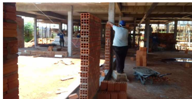
Figura 24C: Operário levantando parede frontal, no bloco da direita do imóvel
