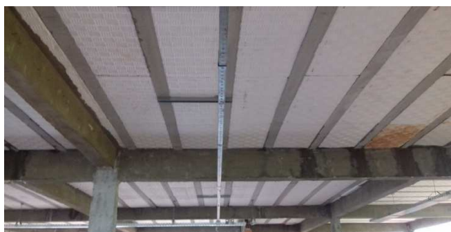
Figura 09E: Segmento de perfilado #38x38, no bloco da direita
