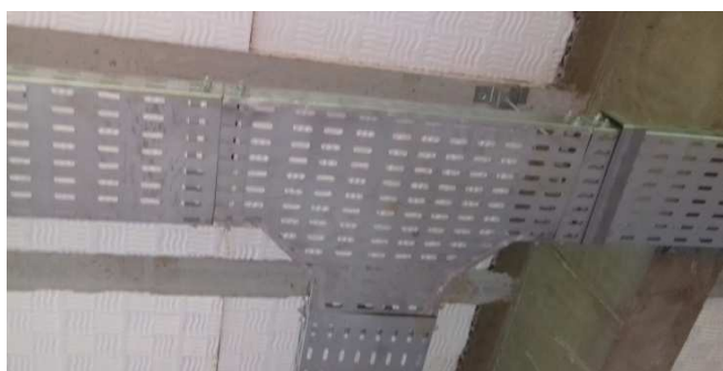
Figura 15E: Ligação em T, instalada no bloco da direita
