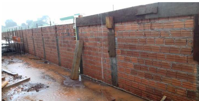
Figura 33C: Alvenaria alcançando a altura final, no muro de fechamento do terreno (visão do fundo)
