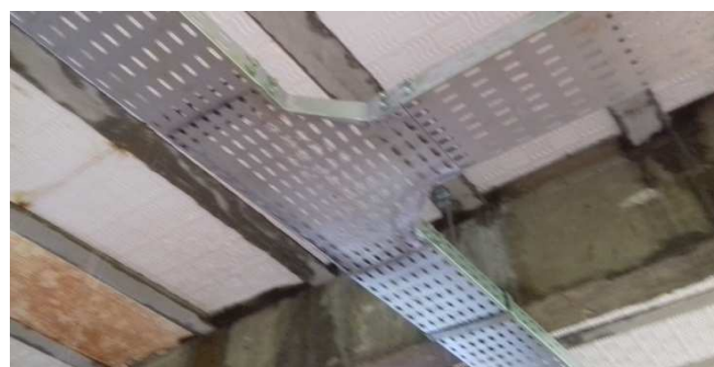
Figura 16E: Ligação em T, instalada no bloco da direita
