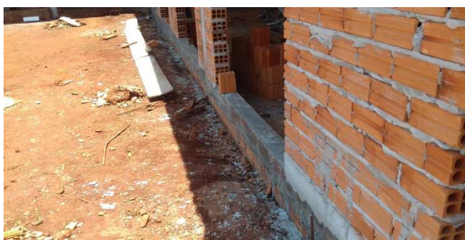
Figura 18C: Contravergas executadas na porção direita (parede frontal)
