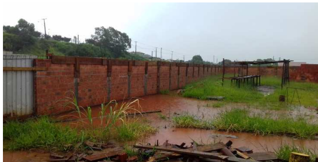
Figura 34C: Alvenaria alcançando a altura final, no muro de fechamento do terreno (fundo e lateral)
