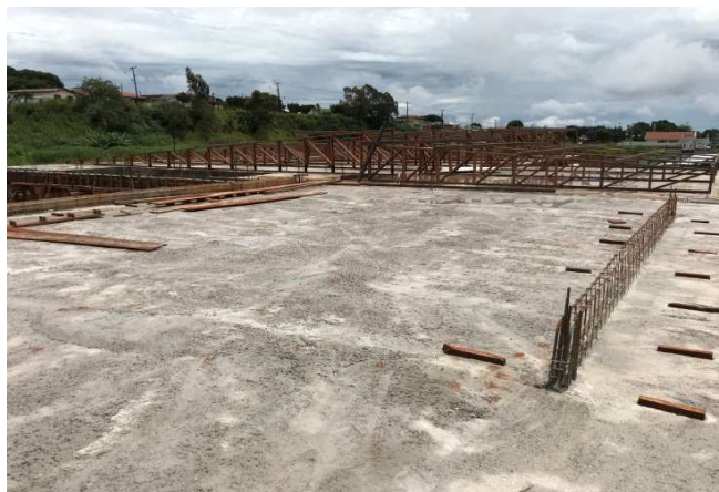
Figura 11C: Panos de lajes da porção frontal (centro) após concretagem
