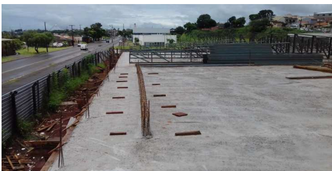
Figura 12C: Panos de lajes da porção frontal (centro) após concretagem
