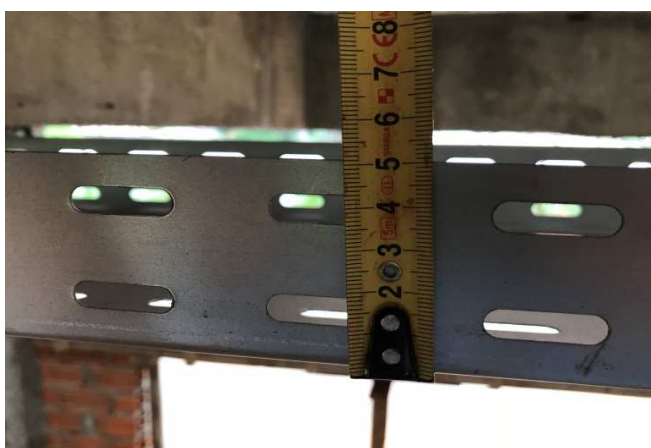
Figura 03E: Aferição da altura da eletrocalha #200x50 - 50mm
