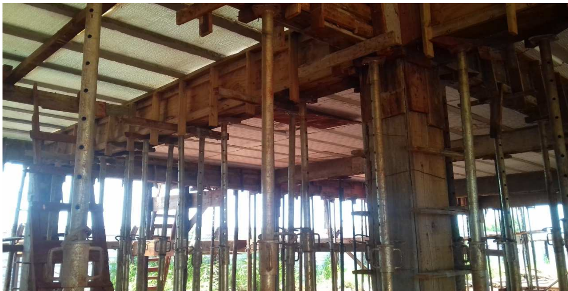
Figura 02C: Escoramento de vigas e lajes - porção central do imóvel
