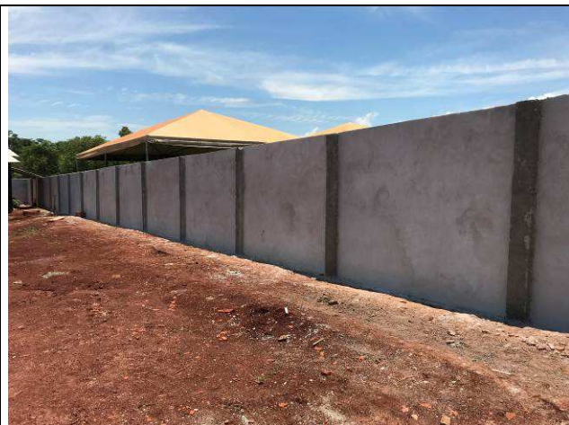
Figura 107C: Muro de fechamento - fundos.
