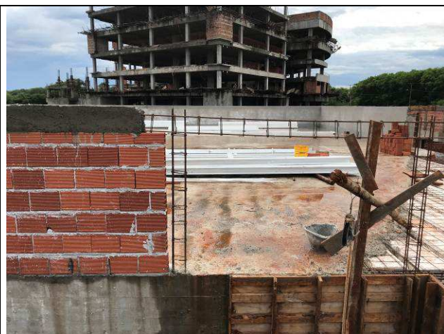
Figura 60C: Pilaretes e cintas da platibanda do prédio principal.
