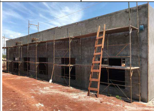
Figura 74C: Alvenaria das paredes externas do arquivo.
