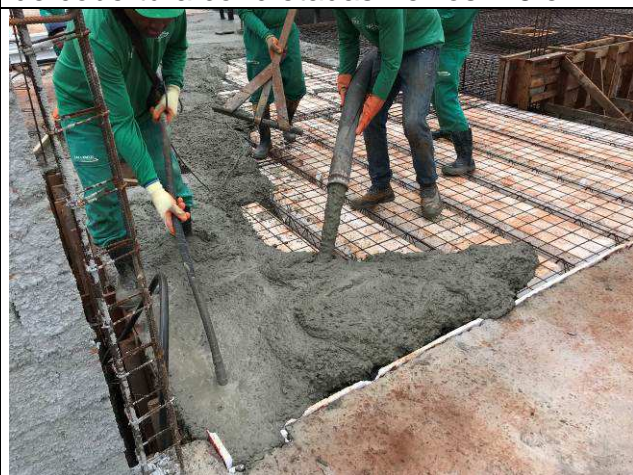
Figura 52C: Concretagem das lajes e vigas de cobertura concretadas - eixos 4-6 e E-H.
