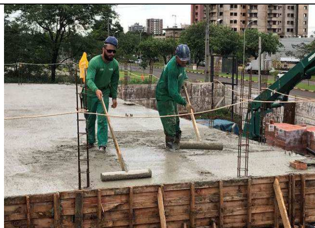
Figura 35C: Concretagem das lajes e vigas de cobertura - eixos 6-10 e G-I.
