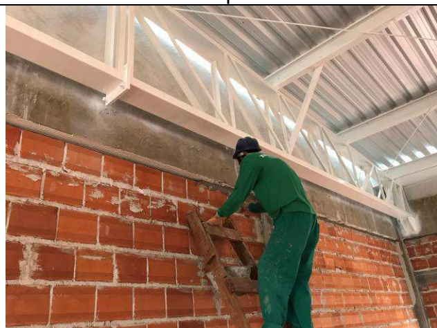
Figura 75C: Encunhamento com argamassa expansiva - arquivo.
