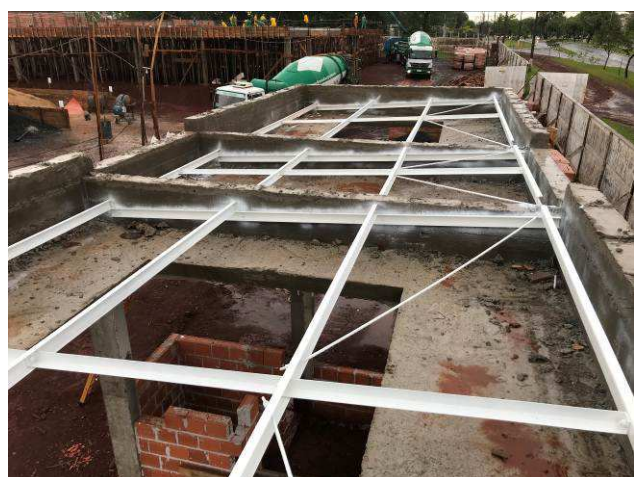
Figura 91C: Estrutura metálica de cobertura - guarita.
