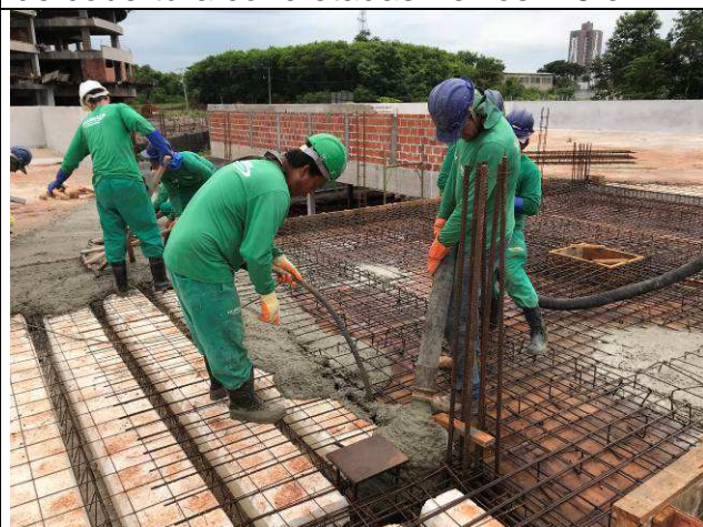
Figura 51C: Concretagem das lajes e vigas de cobertura concretadas - eixos 4-6 e E-H.
