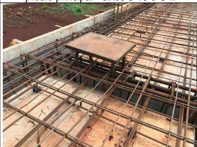
Figura 25C: Lajes e vigas de cobertura do prédio principal - eixos 6-10 e G-I.
