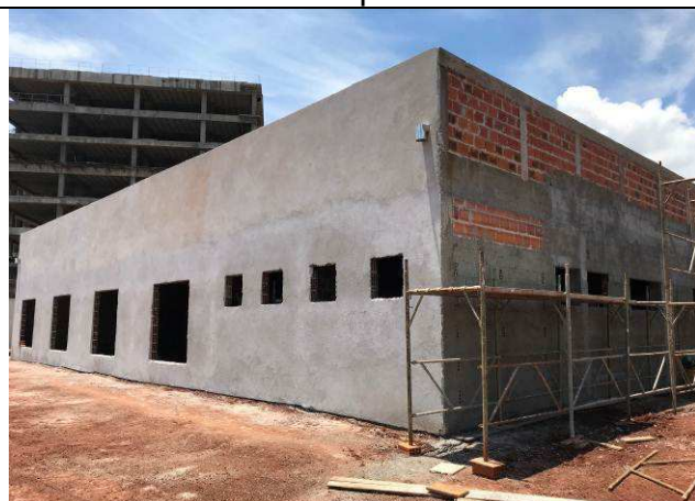
Figura 73C: Alvenaria das paredes externas do arquivo.
