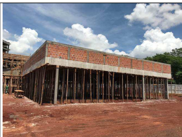
Figura 68C: Alvenaria das paredes de fechamento do arquivo.
