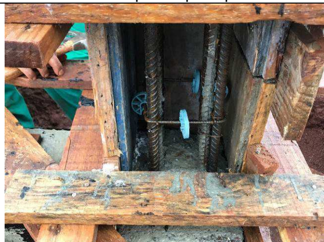
Figura 15C: Formas e armaduras do pilar P66 do prédio principal.
