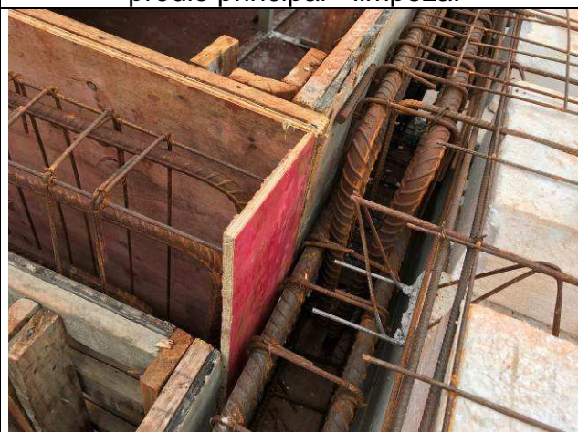
Figura 26C: Lajes e vigas de cobertura do prédio principal - eixos 6-10 e G-I.
