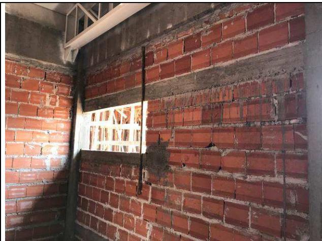
Figura 06C: Vergas e contravergas do arquivo.
