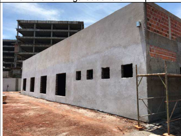
Figura 102C: Revestimento argamassado da face externa - Arquivo.
