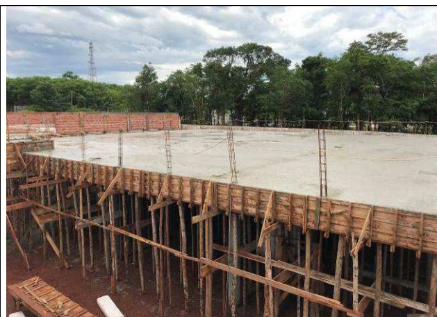
Figura 36C: Lajes e vigas de cobertura concretadas - eixos 6-10 e G-I.
