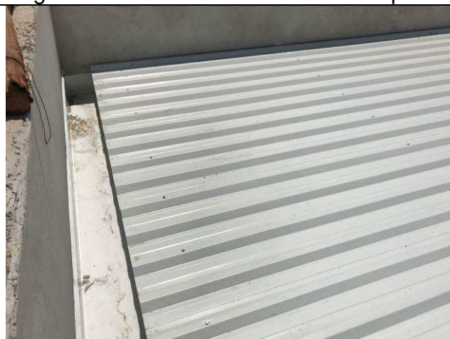
Figura 87C: Telhas de cobertura e calhas - arquivo.
