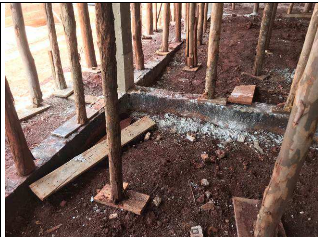
Figura 92C: Impermeabilização das vigas baldrame do prédio principal.
