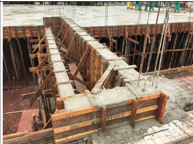
Figura 31C: Concretagem das lajes e vigas de cobertura - eixos 6-10 e G-I.
