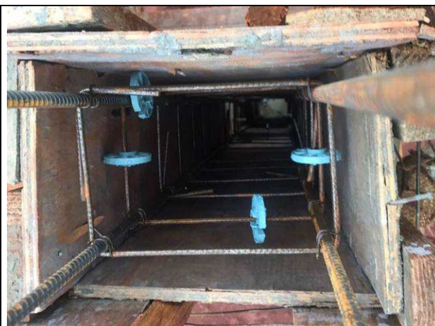
Figura 18C: Formas e armaduras do pilar P68 do prédio principal.
