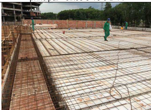
Figura 21C: Lajes e vigas de cobertura do prédio principal - eixos 6-10 e G-I.
