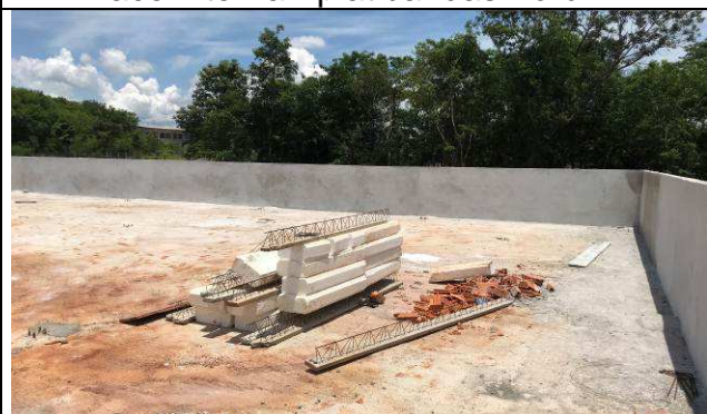
Figura 96C: Revestimento argamassado da face interna - platibandas Fórum.
