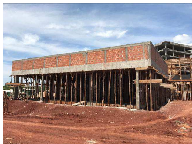
Figura 67C: Alvenaria das platibandas do Fórum.
