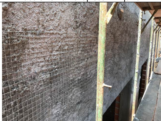
Figura 101C: Instalação da tela na junta alvenaria x viga cobertura - Arquivo.
