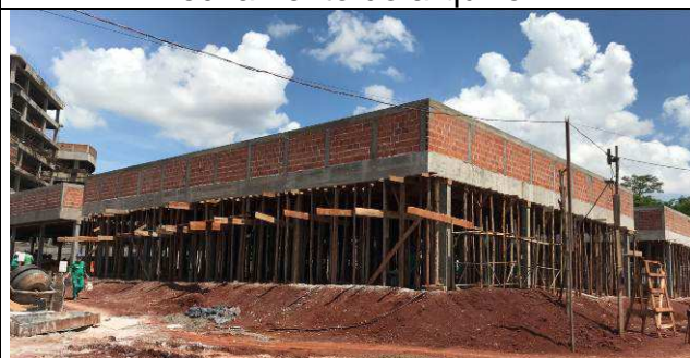
Figura 70C: Alvenaria das paredes de fechamento do arquivo.
