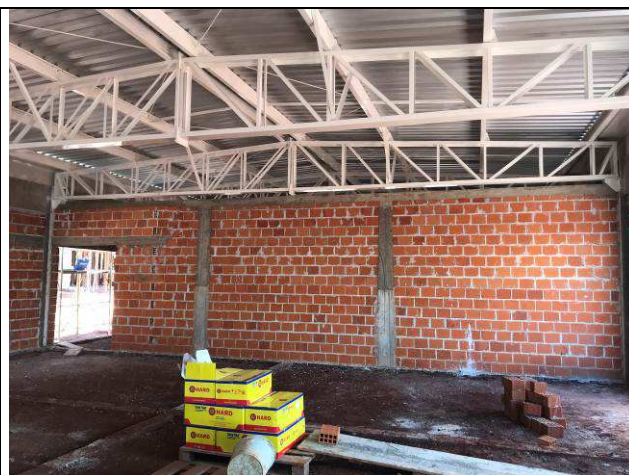
Figura 72C: Alvenaria das paredes internas do arquivo.
