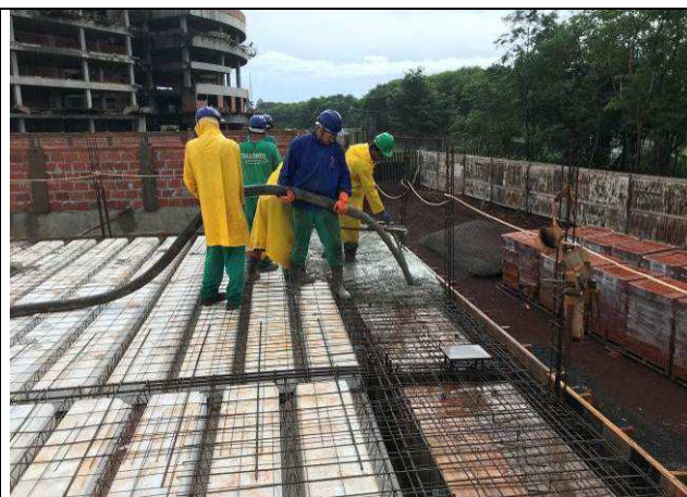
Figura 29C: Concretagem das lajes e vigas de cobertura - eixos 6-10 e G-I.
