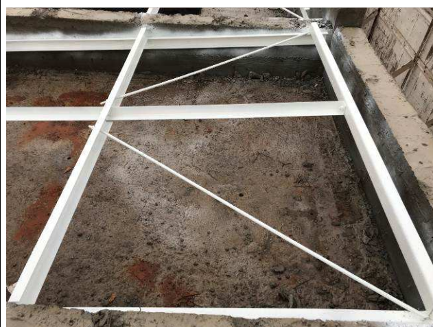
Figura 92C: Estrutura metálica de cobertura - guarita.
