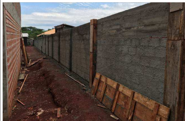
Figura 105C: Muro de fechamento - fundos.
