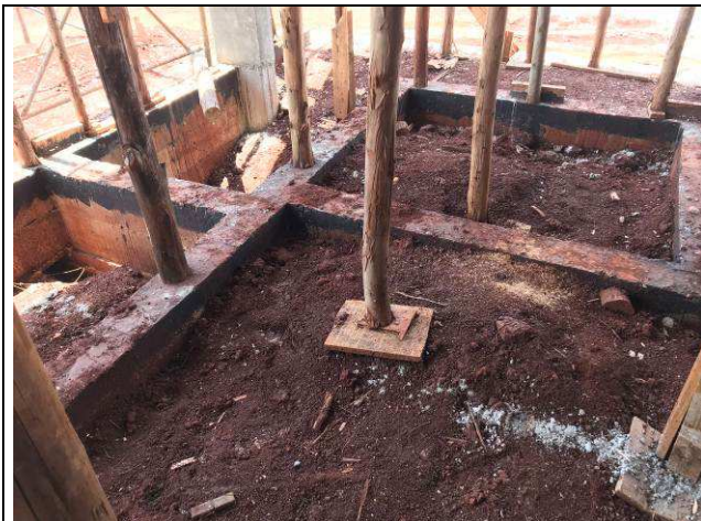
Figura 91C: Impermeabilização das vigas baldrame do prédio principal.
