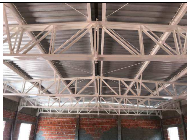
Figura 79C: Estrutura metálica de cobertura - arquivo.
