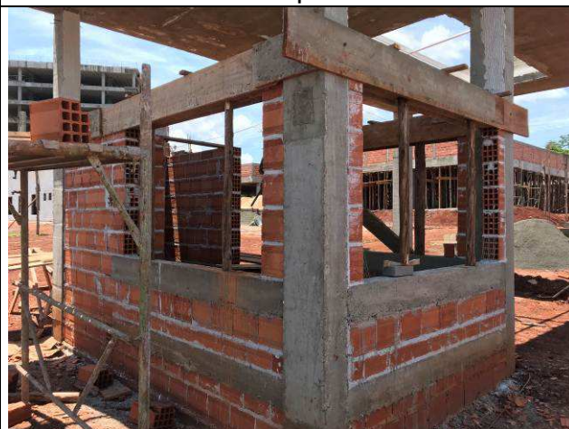
Figura 76C: Alvenaria das paredes da guarita.
