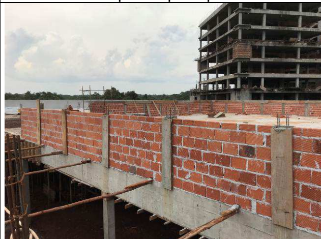
Figura 62C: Pilaretes e cintas da platibanda do prédio principal.
