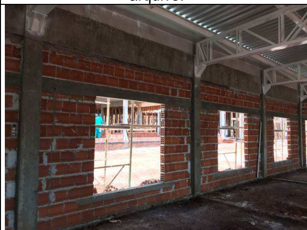
Figura 08C: Vergas e contravergas do arquivo.
