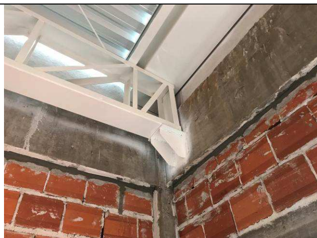
Figura 83C: Estrutura metálica de cobertura - arquivo.
