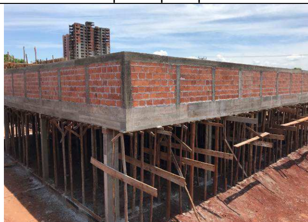
Figura 63C: Pilaretes e cintas da platibanda do prédio principal.
