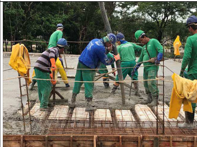
Figura 32C: Concretagem das lajes e vigas de cobertura - eixos 6-10 e G-I.
