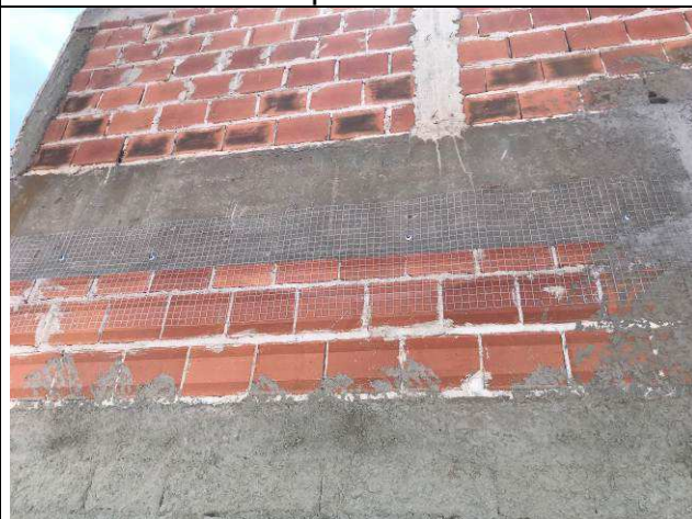
Figura 100C: Instalação da tela na junta alvenaria x viga cobertura - Arquivo.
