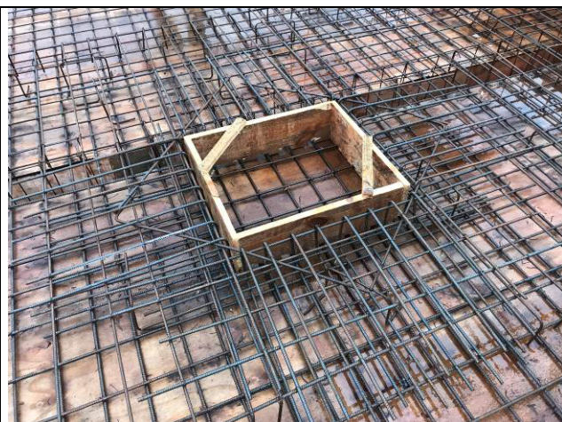
Figura 47C: Lajes e vigas de cobertura do prédio principal - eixos 4-6 e E-H.
