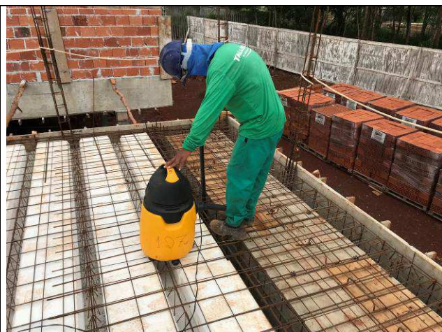
Figura 24C: Lajes e vigas de cobertura do prédio principal - limpeza.
