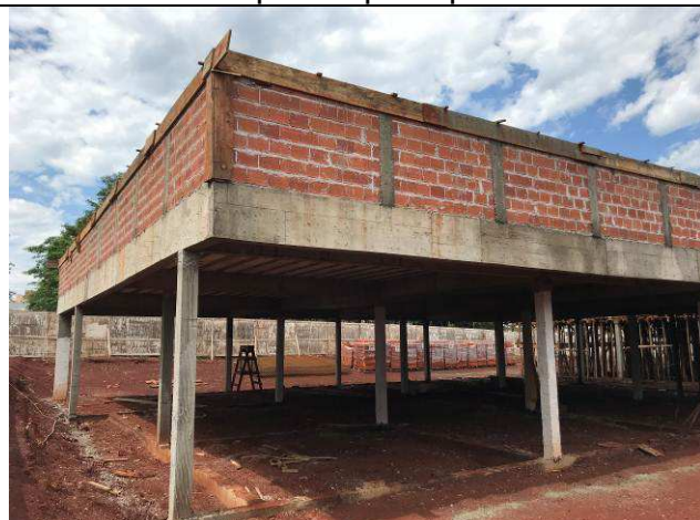
Figura 61C: Pilaretes e cintas da platibanda do prédio principal.
