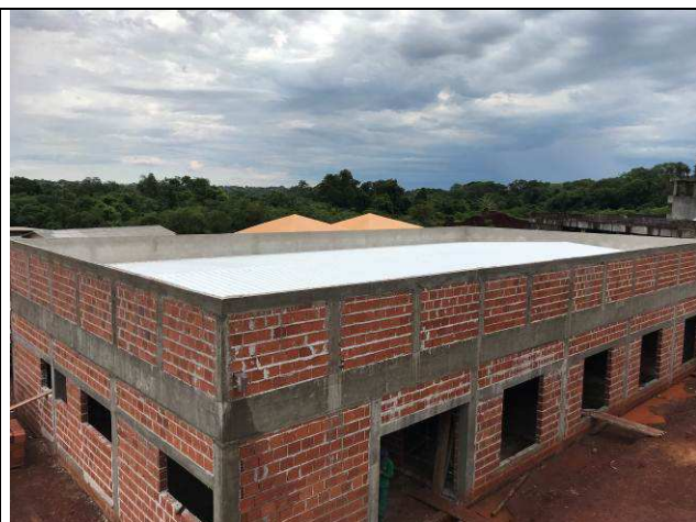
Figura 66C: Pilaretes e cintas da platibanda do arquivo.
