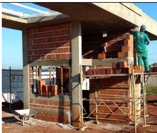
Figura 78C: Alvenaria das paredes da guarita.
