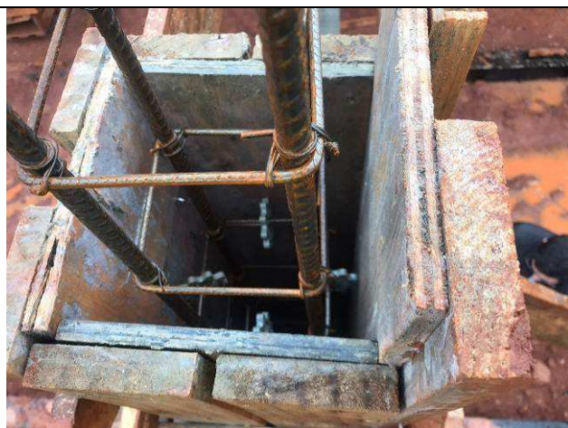
Figura 17C: Formas e armaduras do pilar P42 do prédio principal.
