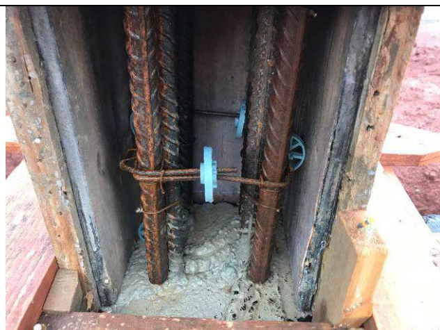
Figura 11C: Formas e armaduras do pilar P43 do prédio principal.
