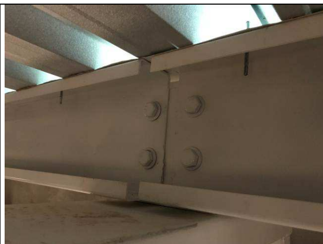
Figura 84C: Estrutura metálica de cobertura - arquivo.
