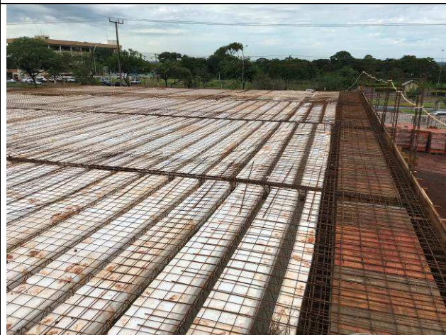
Figura 38C: Lajes e vigas de cobertura do prédio principal - eixos 6-10 e D-F.
