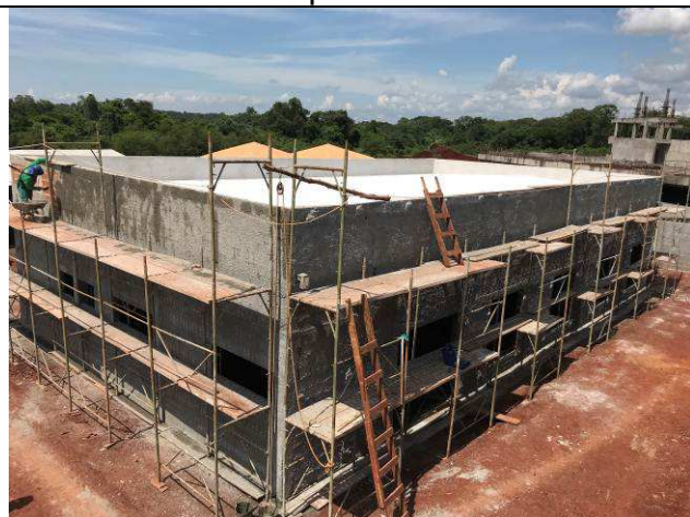
Figura 99C: Revestimento argamassado da face externa - chapisco - Arquivo.
