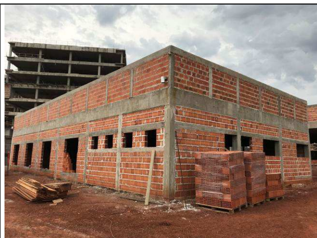
Figura 65C: Pilaretes e cintas da platibanda do arquivo.
