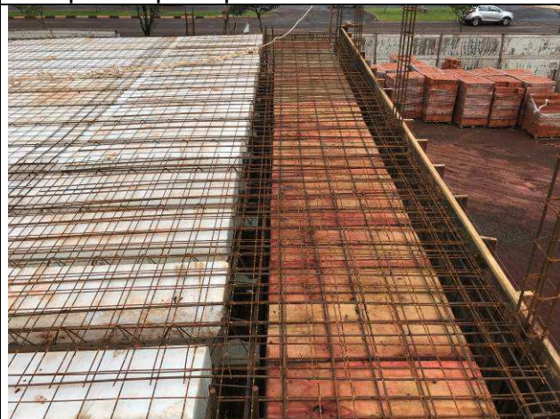
Figura 40C: Lajes e vigas de cobertura do prédio principal - eixos 6-10 e D-F.
