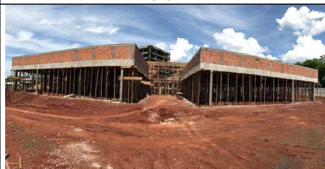
Figura 69C: Alvenaria das paredes de fechamento do arquivo.
