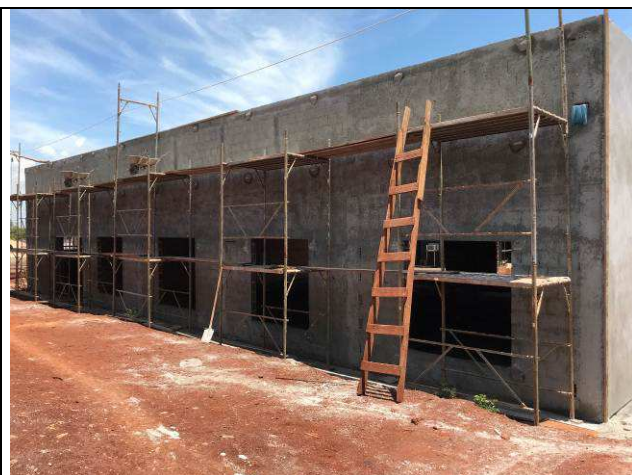
Figura 104C: Revestimento argamassado da face externa - Arquivo.
