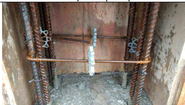
Figura 14C: Formas e armaduras do pilar P55 do prédio principal.
