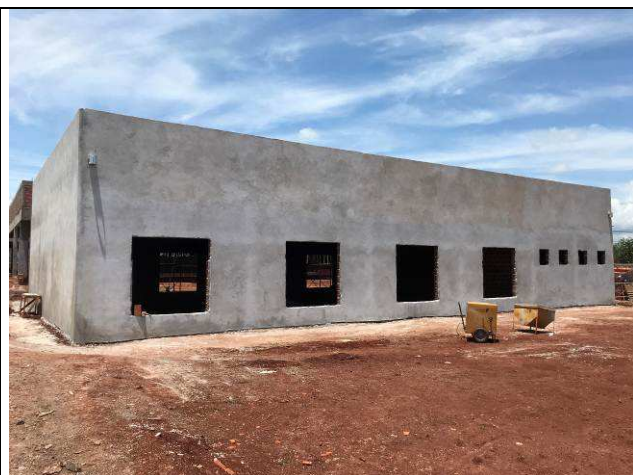
Figura 103C: Revestimento argamassado da face externa - Arquivo.
