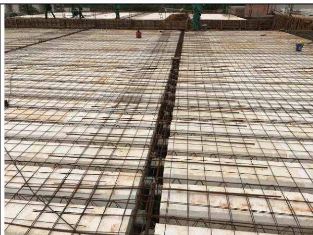
Figura 23C: Lajes e vigas de cobertura do prédio principal - eixos 6-10 e G-I.
