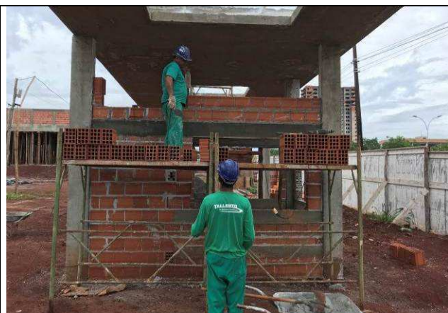
Figura 77C: Alvenaria das paredes da guarita.
