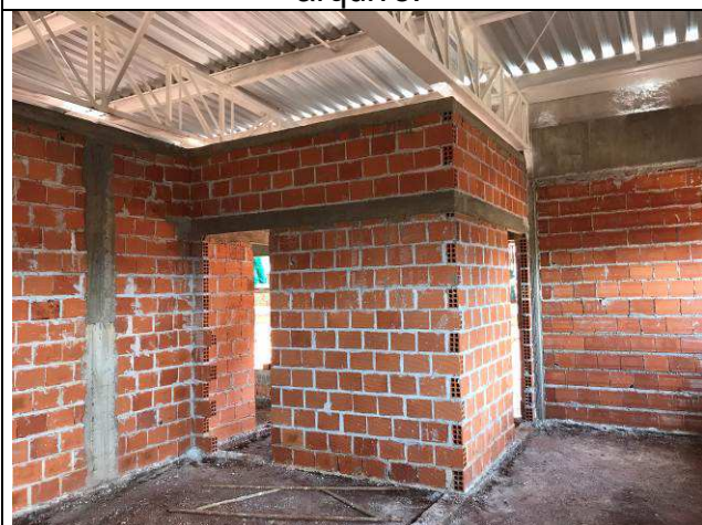
Figura 07C: Vergas e contravergas do arquivo.
