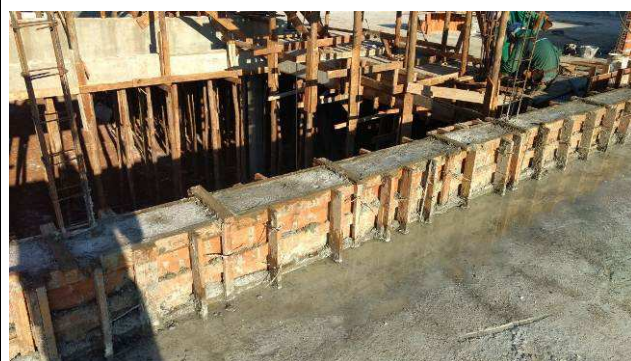
Figura 56C: Concretagem das lajes e vigas de cobertura concretadas - eixos 4-6 e E-H.
