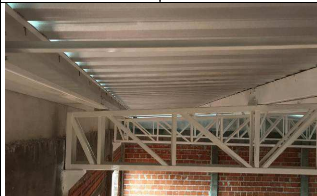
Figura 82C: Estrutura metálica de cobertura - arquivo.
