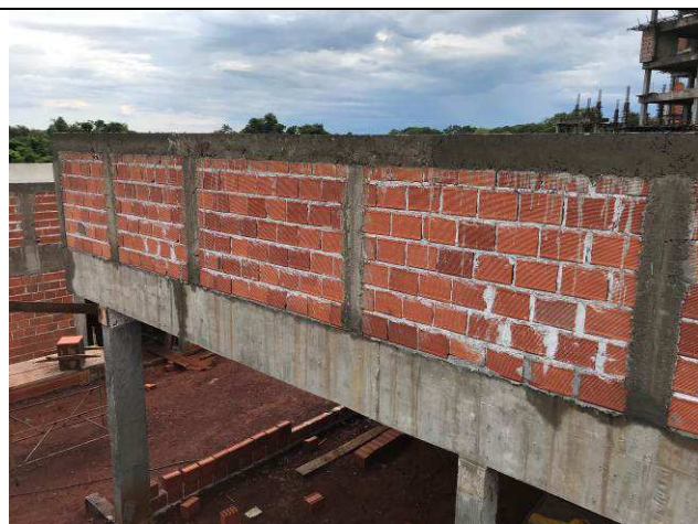
Figura 59C: Pilaretes e cintas da platibanda do prédio principal.
