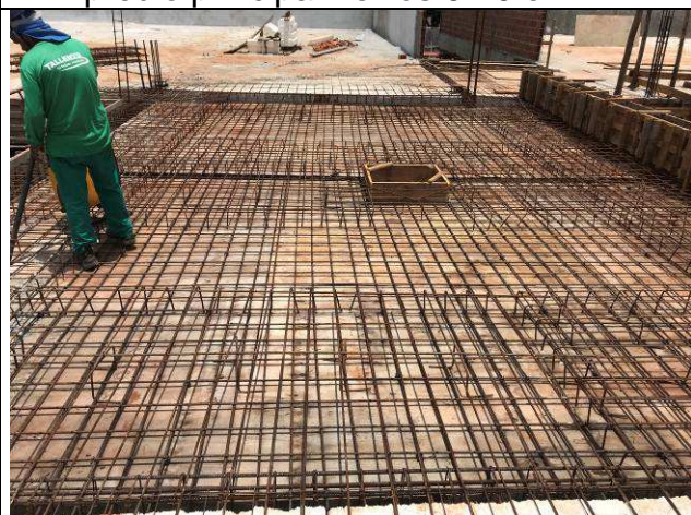
Figura 43C: Lajes e vigas de cobertura do prédio principal - eixos 4-6 e E-H.
