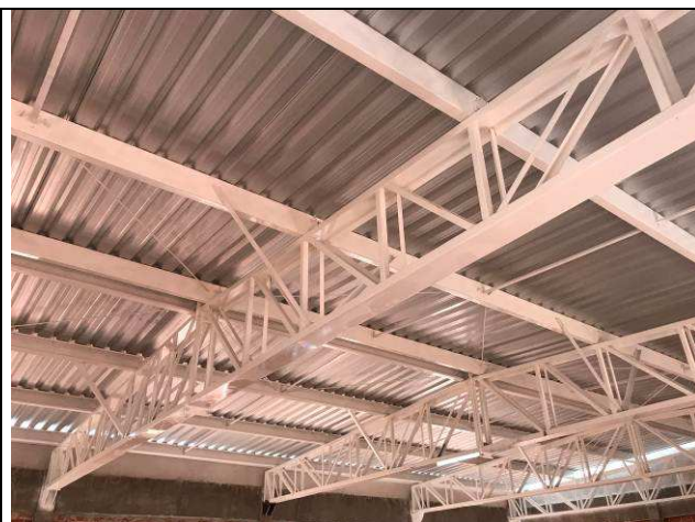
Figura 80C: Estrutura metálica de cobertura - arquivo.
