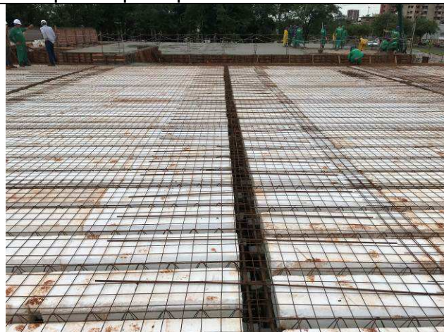
Figura 39C: Lajes e vigas de cobertura do prédio principal - eixos 6-10 e D-F.
