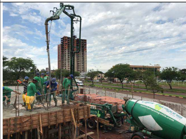
Figura 34C: Concretagem das lajes e vigas de cobertura - eixos 6-10 e G-I.
