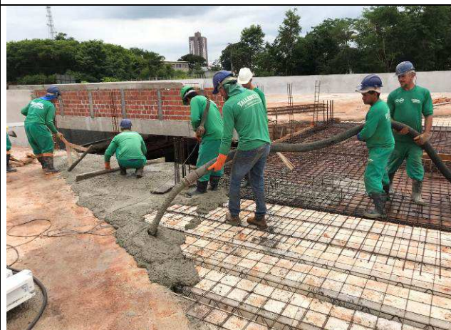
Figura 50C: Concretagem das lajes e vigas de cobertura concretadas - eixos 4-6 e E-H.
