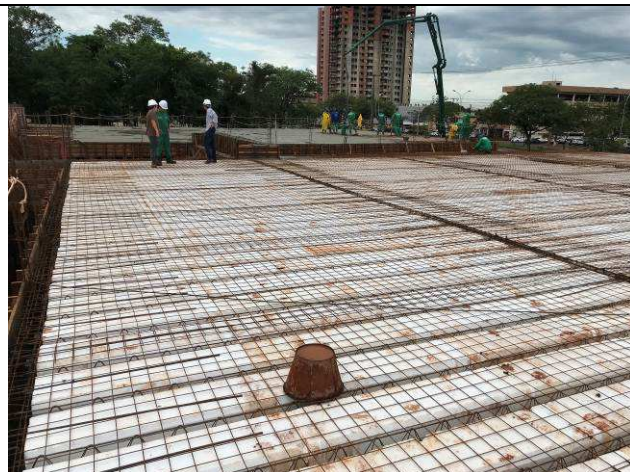
Figura 37C: Lajes e vigas de cobertura do prédio principal - eixos 6-10 e D-F.
