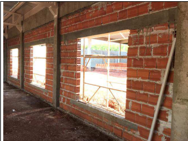
Figura 05C: Vergas e contravergas do arquivo.
