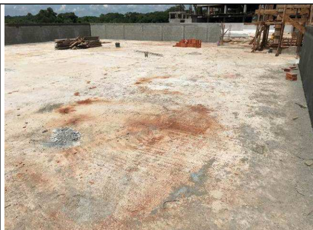
Figura 42C: Lajes e vigas de cobertura concretadas - eixos 6-10 e D-F.
