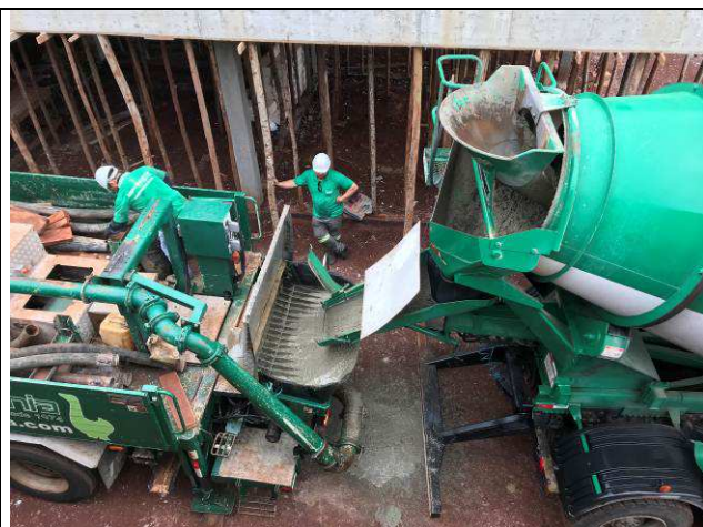
Figura 48C: Concretagem das lajes e vigas de cobertura concretadas - eixos 4-6 e E-H.
