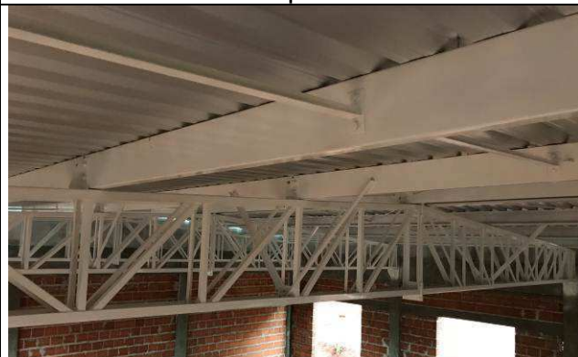
Figura 81C: Estrutura metálica de cobertura - arquivo.
