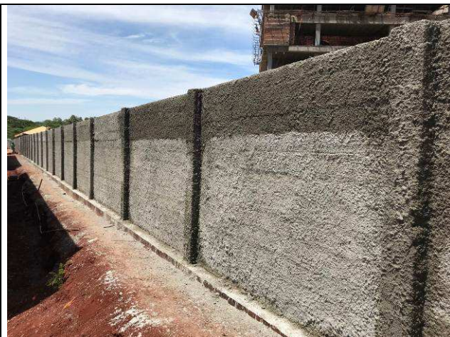
Figura 108C: Muro de fechamento - fundos.
