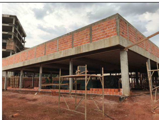
Figura 57C: Pilaretes e cintas da platibanda do prédio principal.
