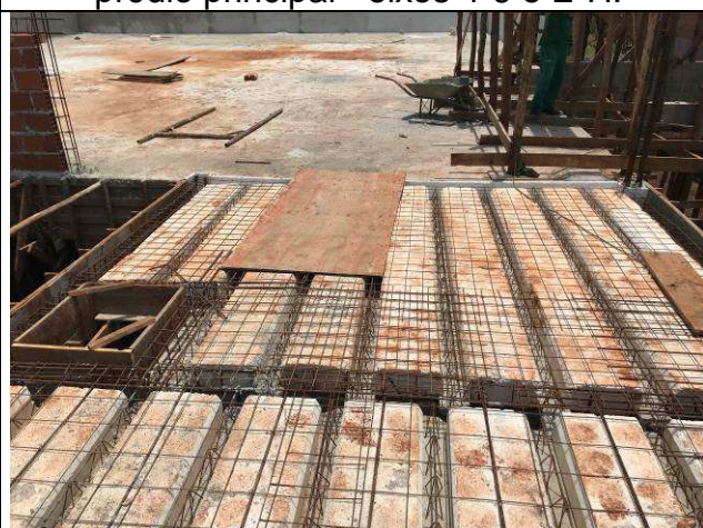
Figura 45C: Lajes e vigas de cobertura do prédio principal - eixos 4-6 e E-H.
