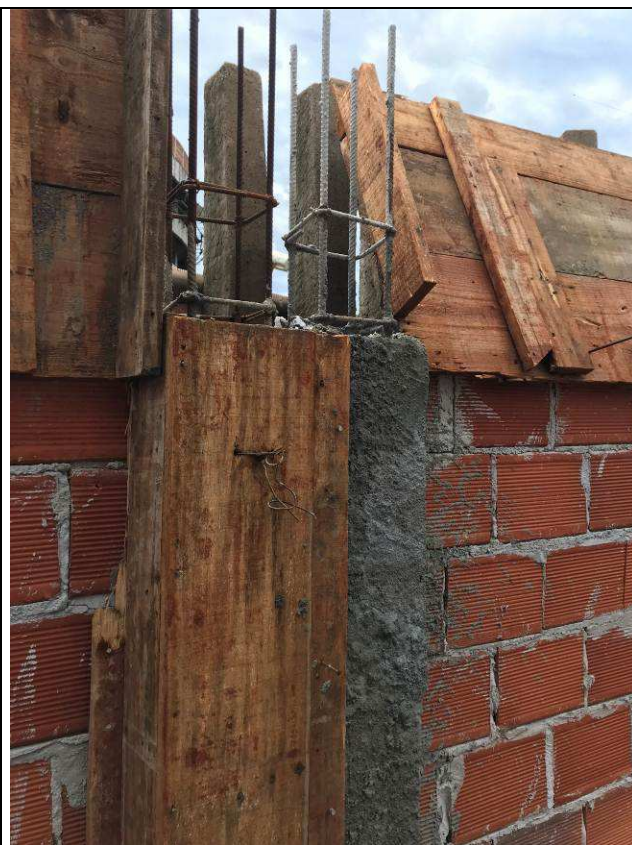
Figura 106C: Muro de fechamento - fundos.
