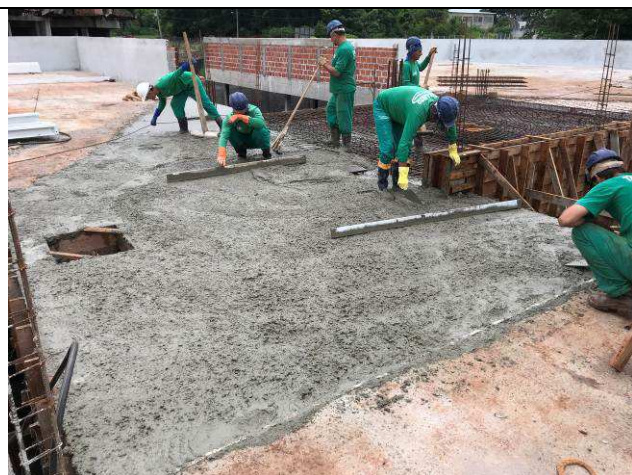
Figura 53C: Concretagem das lajes e vigas de cobertura concretadas - eixos 4-6 e E-H.
