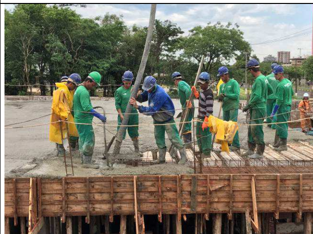
Figura 33C: Concretagem das lajes e vigas de cobertura - eixos 6-10 e G-I.
