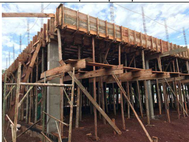
Figura 19C: Pilares concretados do prédio principal - eixos 6-10 e D-F.
