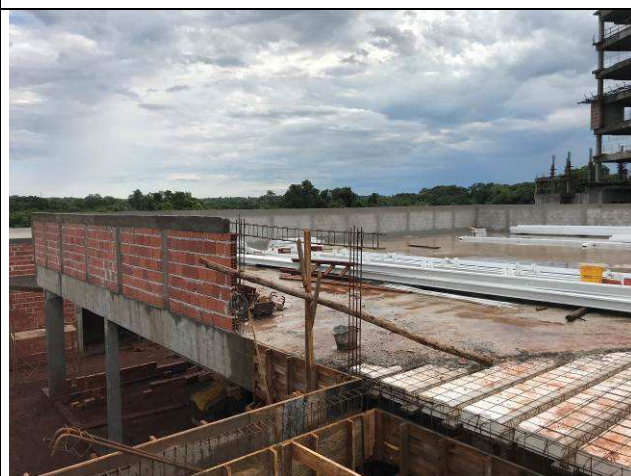
Figura 58C: Pilaretes e cintas da platibanda do prédio principal.
