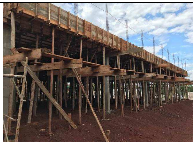
Figura 41C: Lajes e vigas de cobertura do prédio principal - eixos 6-10 e D-F.
