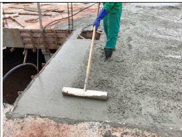
Figura 54C: Concretagem das lajes e vigas de cobertura concretadas - eixos 4-6 e E-H.
