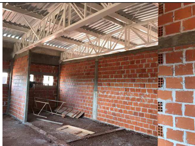
Figura 71C: Alvenaria das paredes internas do arquivo.
