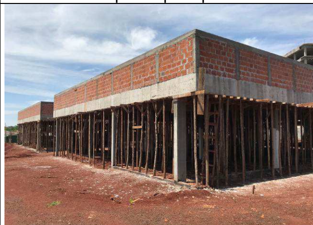
Figura 64C: Pilaretes e cintas da platibanda do prédio principal.
