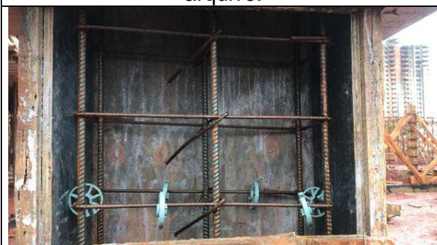
Figura 09C: Formas e armaduras do pilar P41 do prédio principal.
