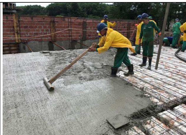
Figura 30C: Concretagem das lajes e vigas de cobertura - eixos 6-10 e G-I.
