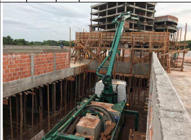
Figura 49C: Concretagem das lajes e vigas de cobertura concretadas - eixos 4-6 e E-H.
