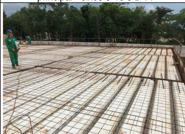
Figura 22C: Lajes e vigas de cobertura do prédio principal - eixos 6-10 e G-I.
