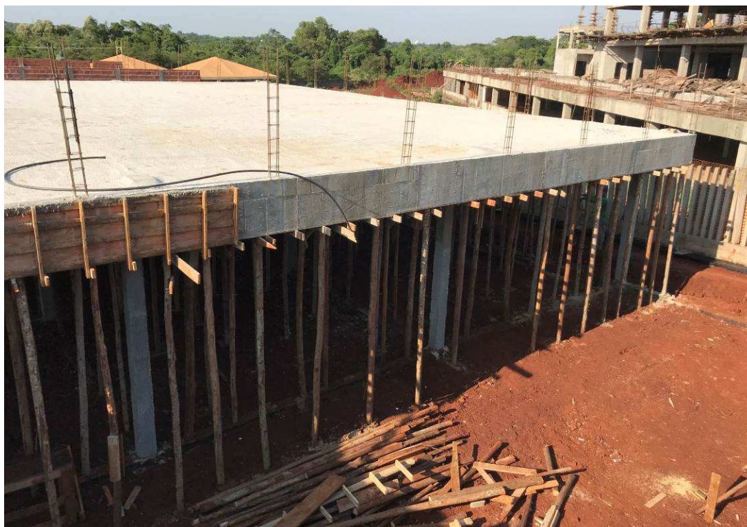
Figura 3 – Laje concretada do prédio principal.
