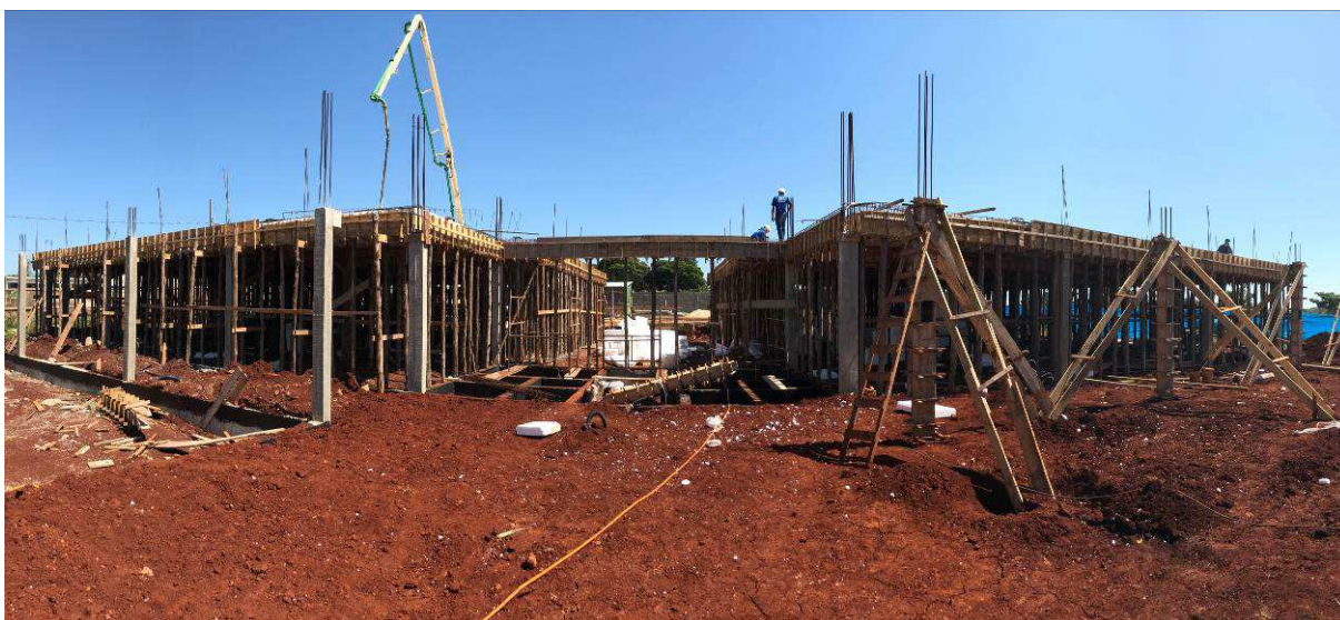
Figura 1 – Vista geral do canteiro de obras.
