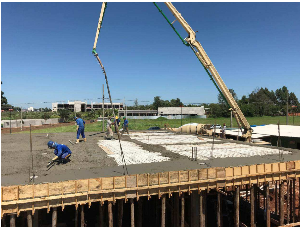
Figura 3 – Vista geral do canteiro de obras - concretagem das lajes.
