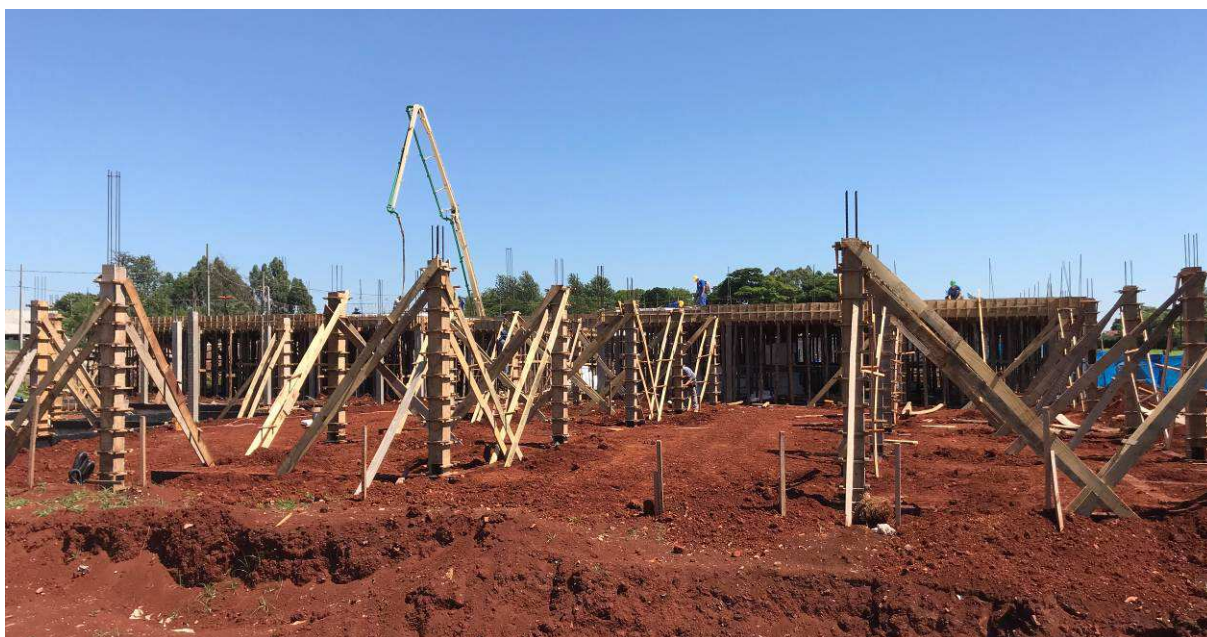
Figura 2 – Vista geral do canteiro de obras.
