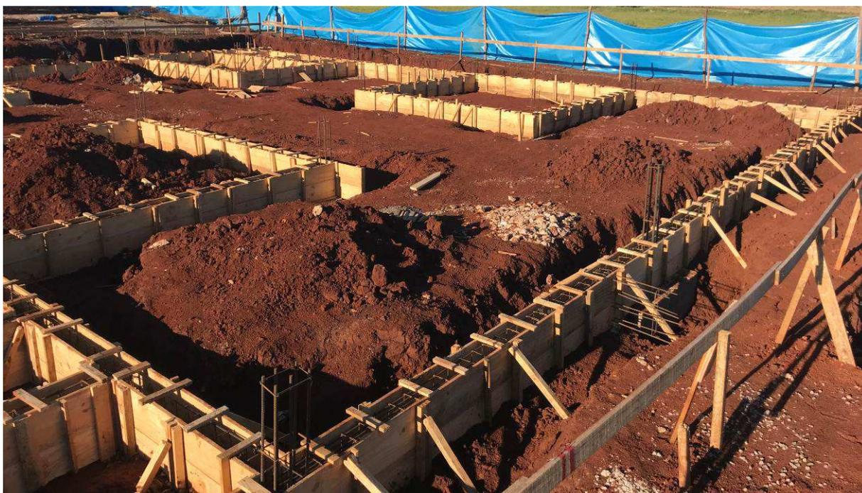
Figura 1 – Vista geral do canteiro de obras - vigas baldrame.
