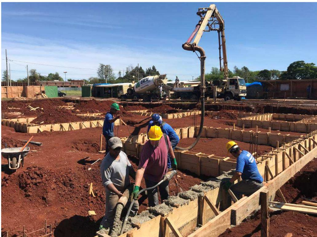
Figura 3 – Vista geral do canteiro de obras - concretagem das vigas baldrames.
