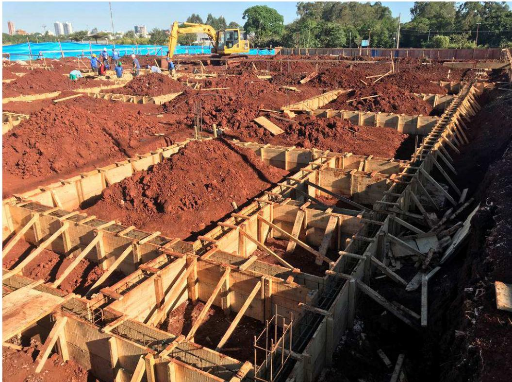
Figura 2 – Vista geral do canteiro de obras - vigas baldrames.
