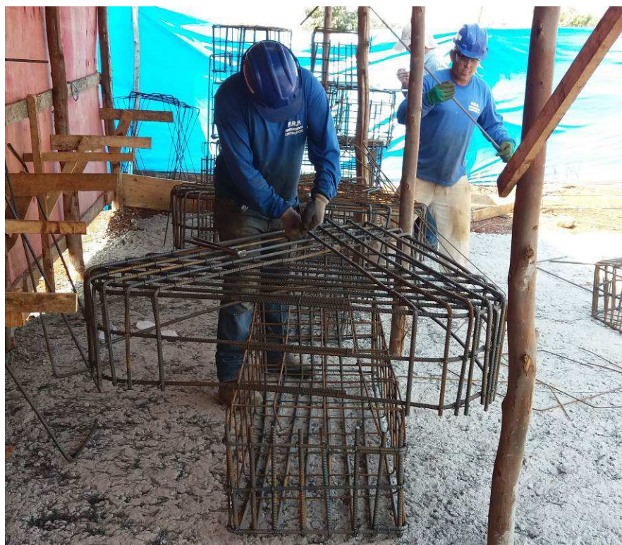
Figura 3 – Montagem de armaduras dos blocos de fundação.
