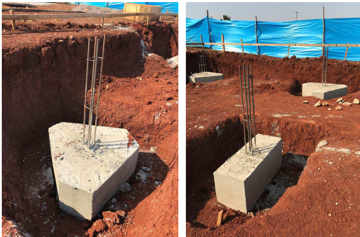
Figura 2 – Blocos de fundação.
