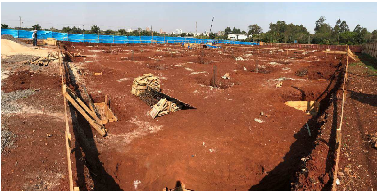
Figura 1 – Vista geral do canteiro de obras.
