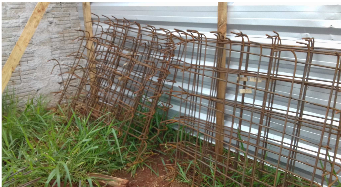
Armaduras das sapatas - Foram cortadas, dobradas e montadas e aguardam a execução das fôrmas para que possam ser posicionadas
