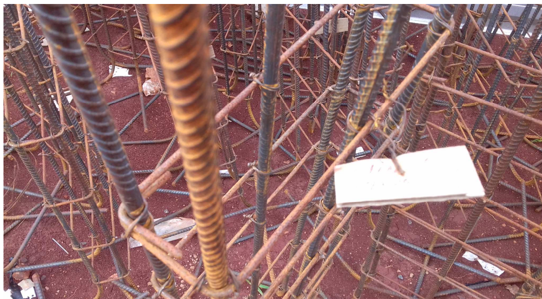
Armaduras dos arranques - encontram-se todas cortadas, dobradas e montadas
