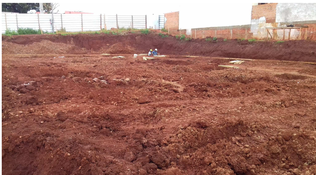
Visão geral do canteiro de obras - Valas abertas para execução das sapatas (constitui serviço relacionado no primeiro termo aditivo)
