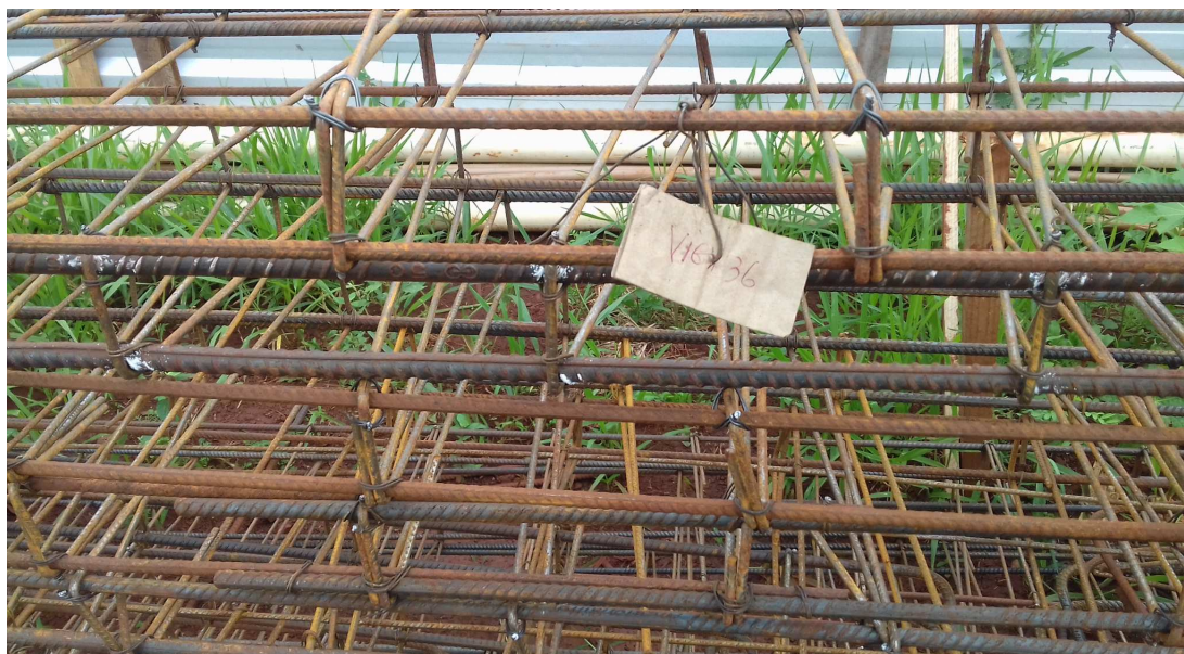
Ferragem de vigas baldrames - realizado corte, dobra e montagem das armaduras - Item também compõe aditivo em trâmite
