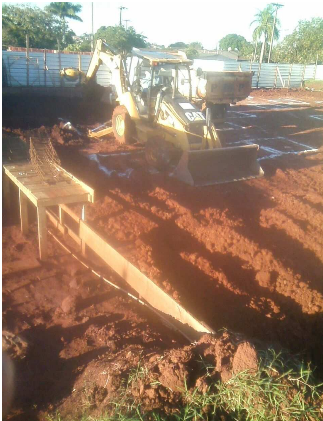
Retroescavadeira durante execução de abertura das valas - serviço está contido no rol de itens do primeiro termo aditivo
