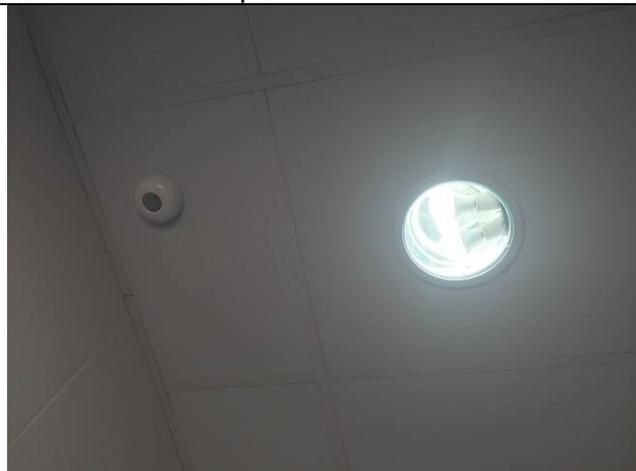
Figura 47E: iluminação interna - sensor de presença
