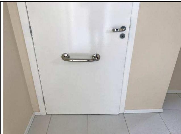
Figura 03C: Barras de apoio - porta banheiro PNE.
