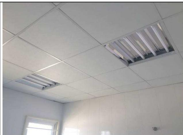
Figura 44E: iluminação interna - luminárias 62x62 sem aletas antireflexivas
