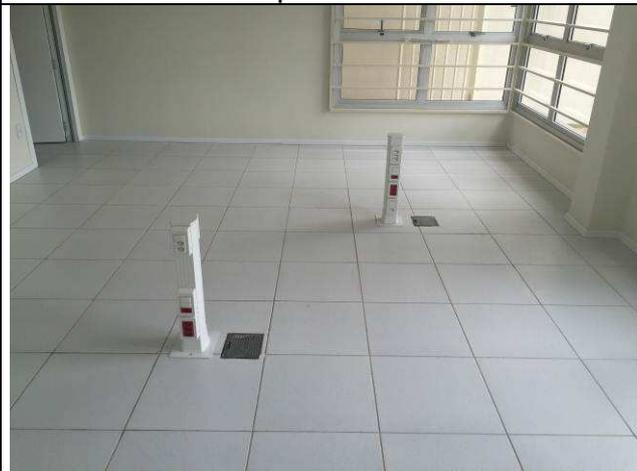
Figura 30E: interruptores e tomadas elétricas padrão Dutotec - totens
