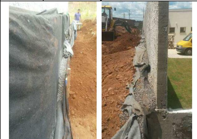
Figura 92C: Muro de arrimo - dreno envolto com brita e manta bidim.
