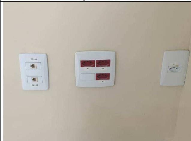
Figura 28E: interruptores e tomadas elétricas padrão modular
