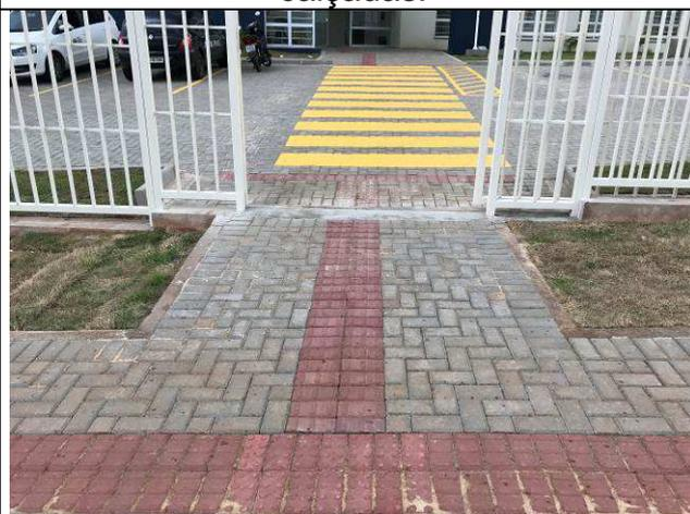
Figura 84C: Pavimentação externa - piso podotátil.
