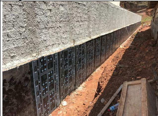
Figura 90C: Muro de arrimo - impermeabilização com manta.
