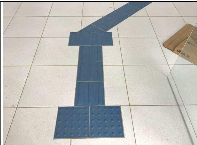
Figura 20C: Piso podotátil interno.
