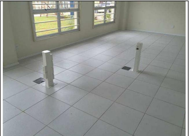
Figura 74E: tomadas lógicas e telefônicas - tomadas RJ45 cat6 Dutotec
