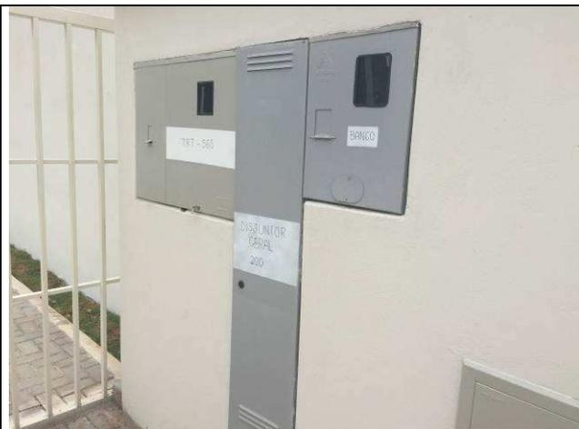
Figura 02E: entrada de energia elétrica - caixas de medição e proteção, mureta
