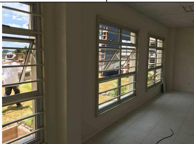
Figura 10C: Grades de proteção - janela J01 - sala de audiências.
