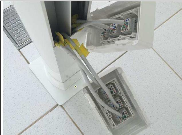
Figura 73E: tomadas lógicas e telefônicas - tomadas RJ45 cat6 Dutotec
