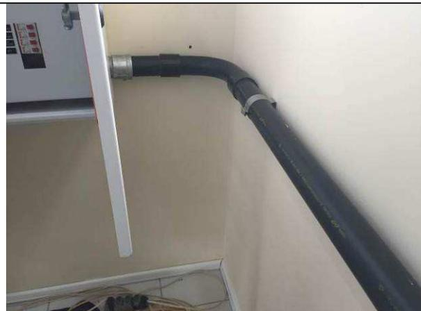
Figura 22E: cabearmento elétrico e quadros elétricos - ramal nobreak
