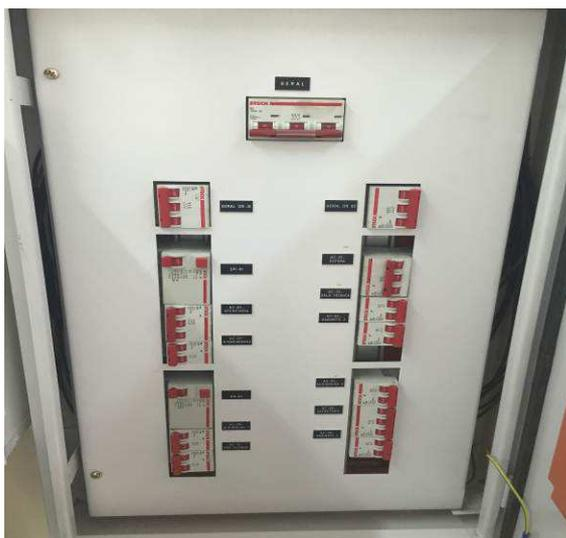
Figura 17E: cabeamento elétrico - circuitos alimentadores condicionadores de ar
