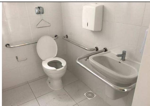
Figura 43C: Barra de apoio para bacia sanitária - banheiro público PNE.
