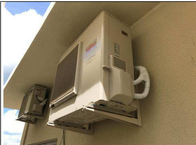
Figura 47C: Condensadora 30.000 BTU's - sala de audiências 1.
