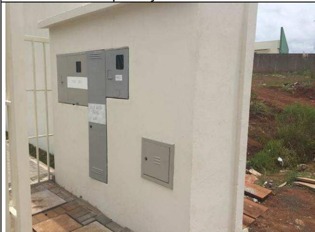
Figura 07E: entrada de energia elétrica -
