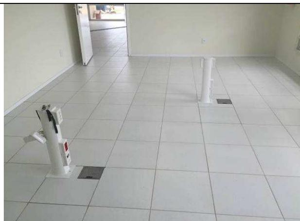
Figura 32E: interruptores e tomadas elétricas padrão Dutotec - totens
