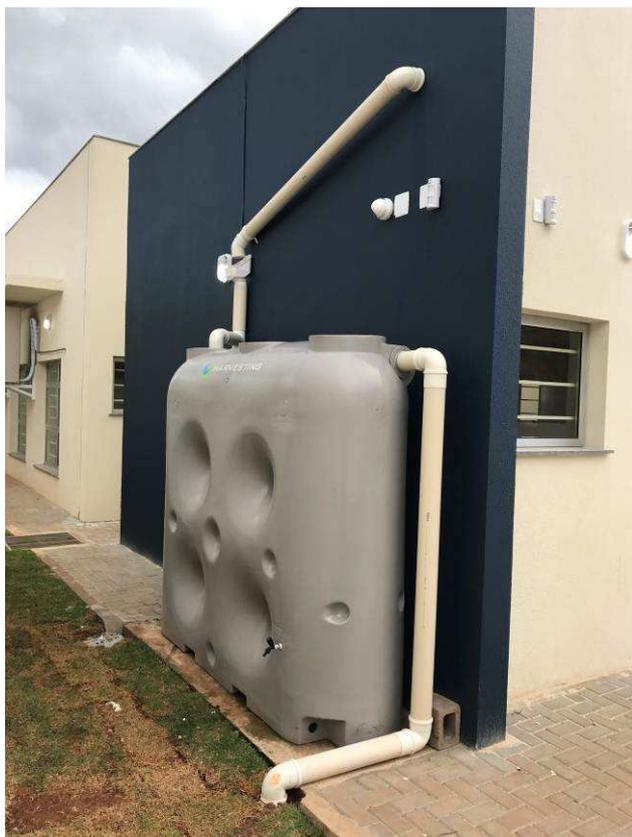
Figura 27C: Sistema de aproveitamento de águas pluviais.
