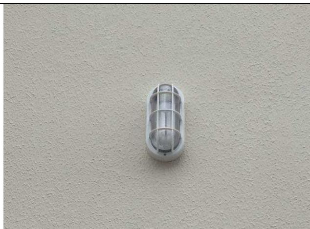
Figura 49E: iluminação externa - arandelas tipo tartaruga
