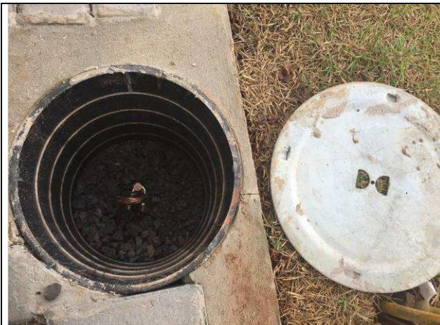
Figura 85E: malha de aterramento - caixas de inspeção e hastes
