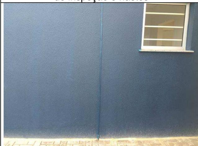
Figura 87E: barras de captação e descida SPDA na cor da parede
