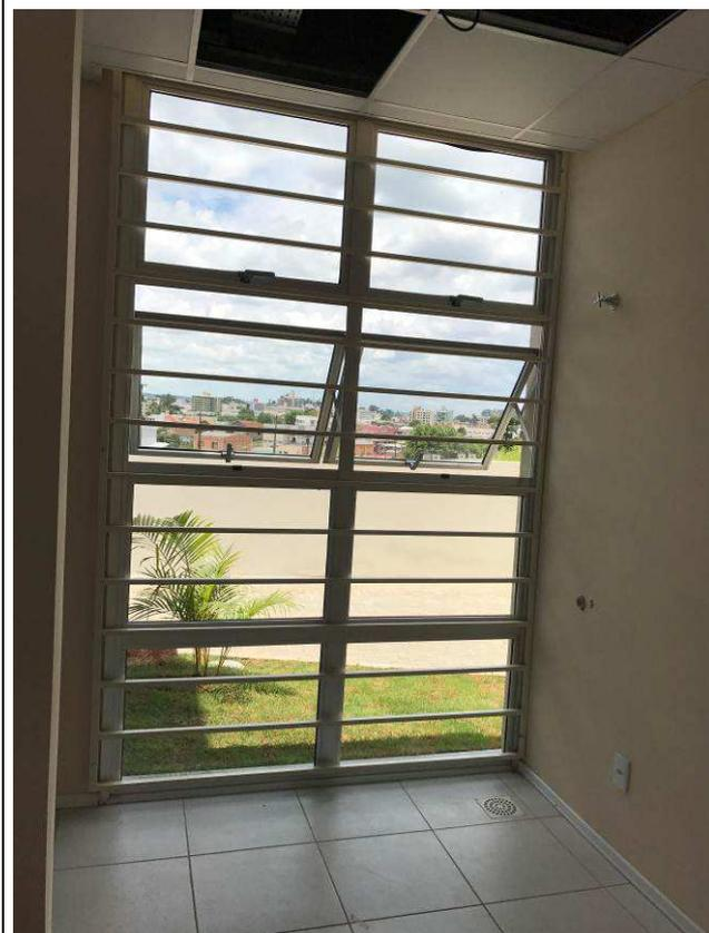
Figura 06C: Grades de proteção - janela J05.
