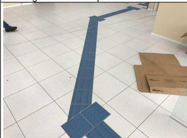
Figura 21C: Piso podotátil interno.
