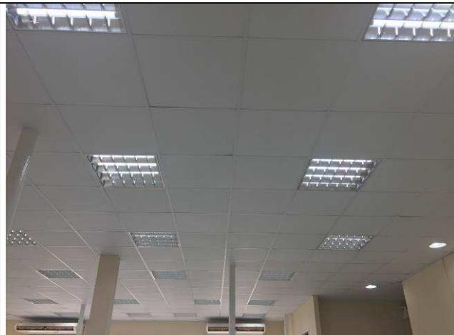
Figura 41E: iluminação interna - luminárias 62x62 com aletas antireflexivas
