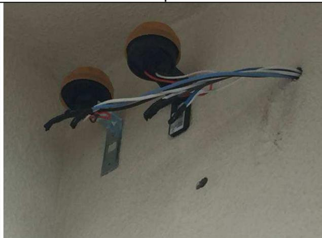
Figura 58E: iluminação externa - células fotoelétricas
