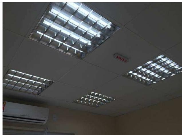
Figura 38E: iluminação interna - luminárias 62x62 com aletas antireflexivas
