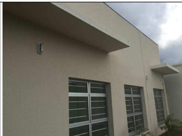
Figura 50E: iluminação externa - arandelas tipo tartaruga
