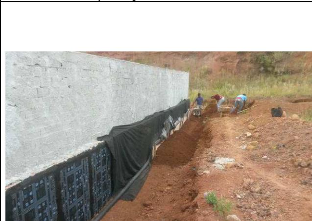
Figura 91C: Muro de arrimo - dreno envolto com brita e manta bidim.
