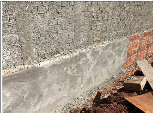
Figura 137C: Revestimento muro de arrimo.
