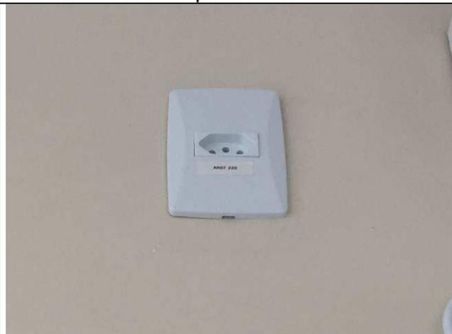
Figura 27E: interruptores e tomadas elétricas padrão modular
