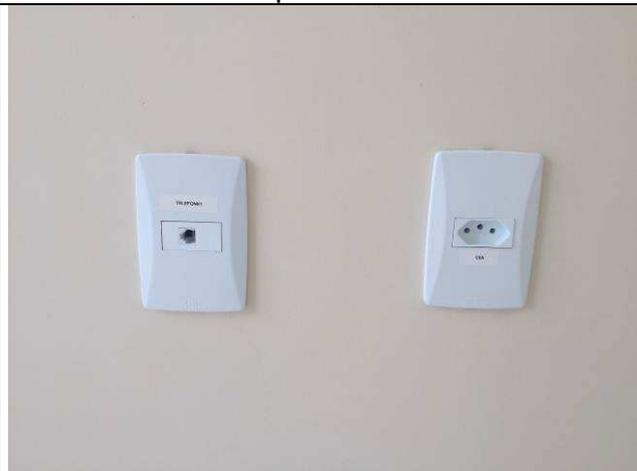
Figura 29E: interruptores e tomadas elétricas padrão modular
