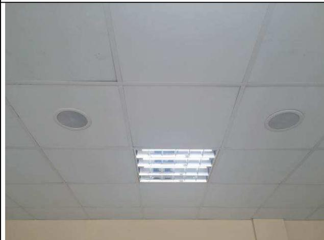
Figura 75E: sonorização - caixas acústicas embutidas
