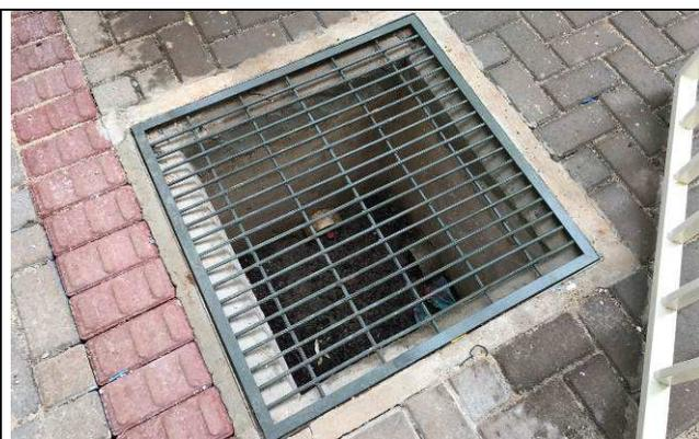
Figura 24C: Grelhas - caixas pluviais.
