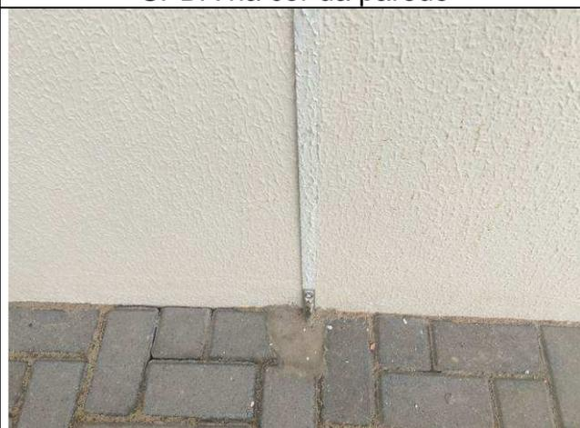
Figura 88E: barras de captação e descida SPDA na cor da parede
