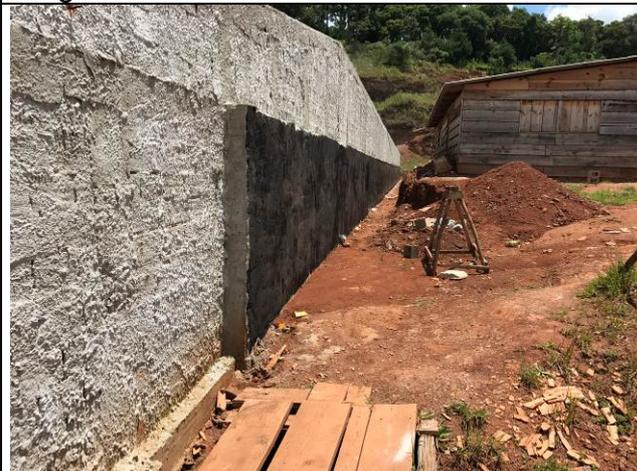
Figura 89C: Muro de arrimo - primer para aplicação da manta.
