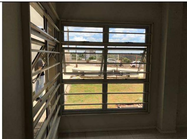
Figura 11C: Grades de proteção - janela J01 - sala de audiências.
