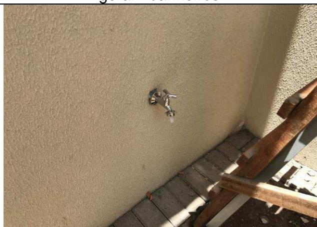
Figura 39C: Torneiras de pressão para uso geral - área externa.
