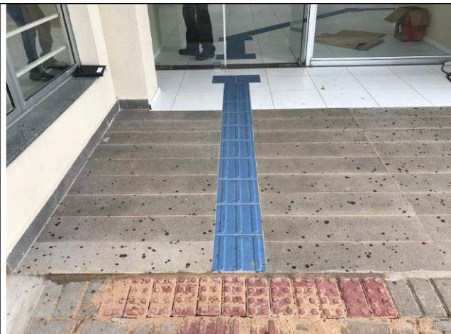
Figura 76C: Pavimentação interna - piso podotátil.
