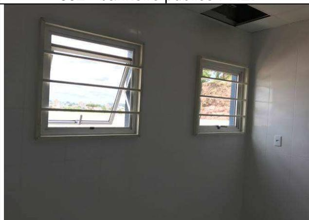
Figura 17C: Grades de proteção - janela J02 - copa.
