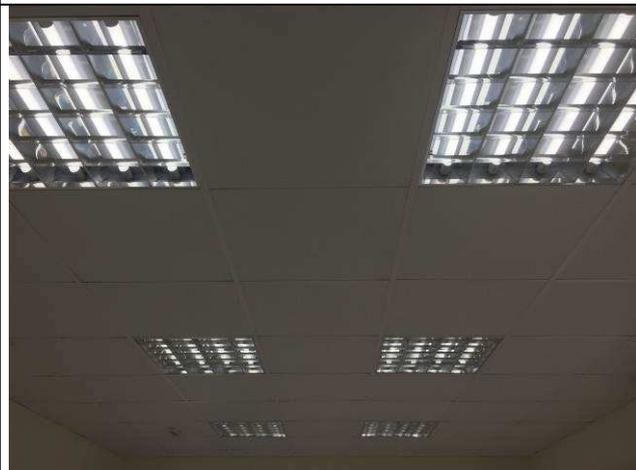
Figura 40E: iluminação interna - luminárias 62x62 com aletas antireflexivas
