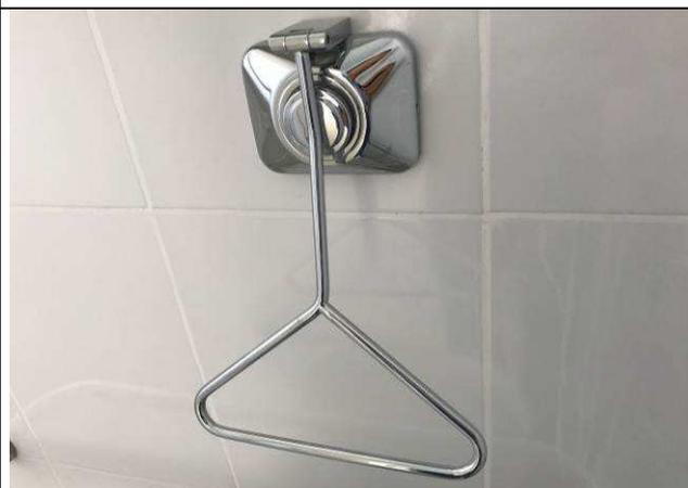
Figura 44C: Acabamento para válvula de descarga - banheiros PNE.
