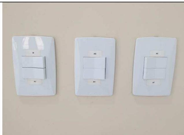
Figura 25E: interruptores e tomadas elétricas padrão modular
