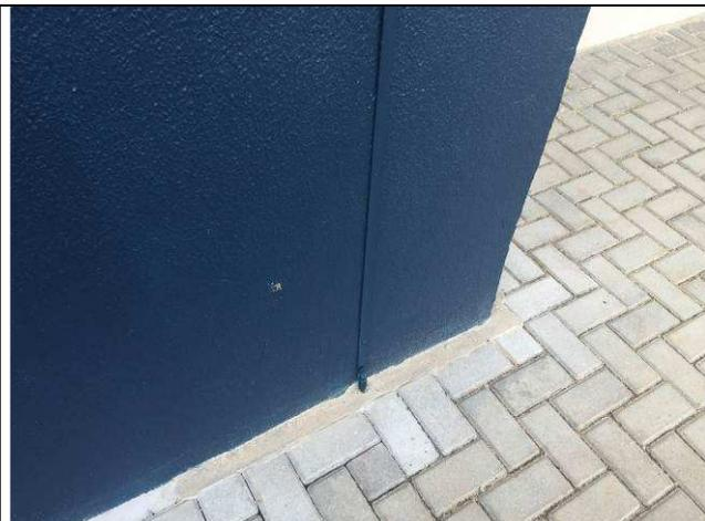
Figura 86E: barras de captação e descida SPDA na cor da parede
