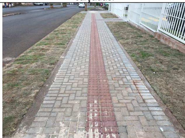
Figura 83C: Pavimentação externa - piso podotátil.
