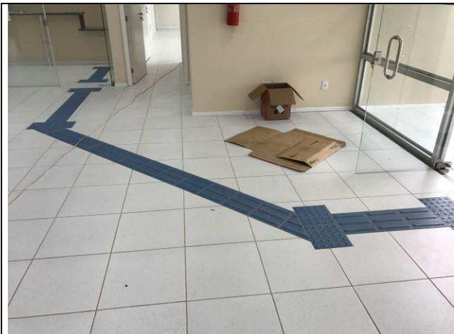
Figura 19C: Piso podotátil interno.
