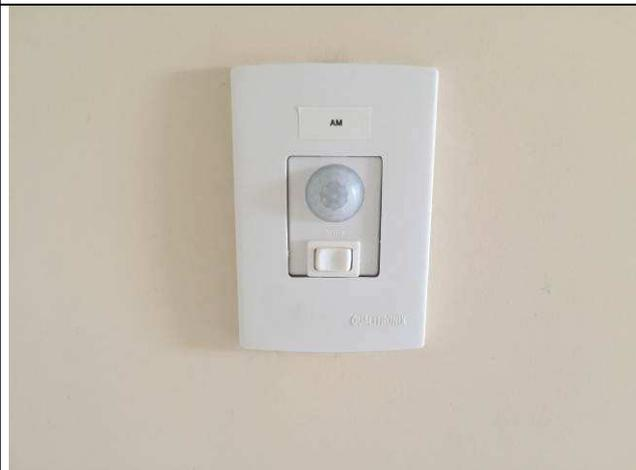
Figura 46E: iluminação interna - sensor de presença
