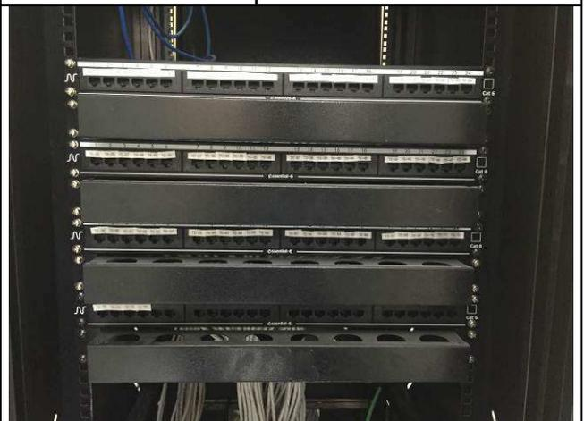
Figura 78E: rack sala técnica - patch panels e organizadores de cabos
