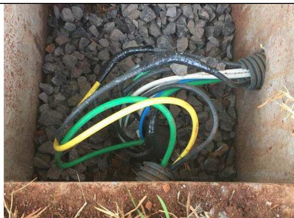
Figura 23E: cabearmento elétrico - circuitos externos portão e iluminação
