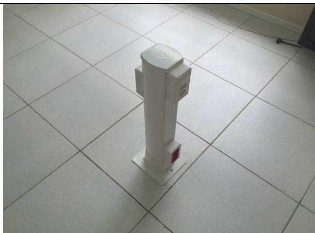
Figura 31E: interruptores e tomadas elétricas padrão Dutotec - totens
