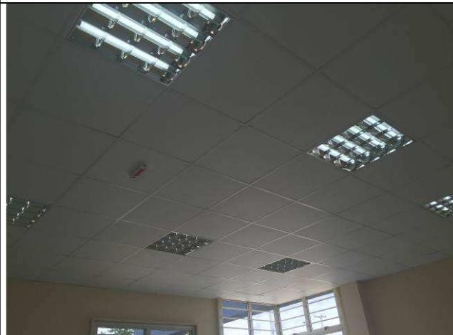
Figura 42E: iluminação interna - luminárias 62x62 com aletas antireflexivas
