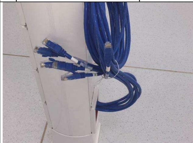
Figura 84E: rack sala técnica - patch cords para conexão dos microcomputadores
