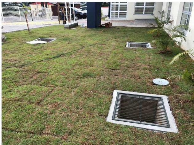
Figura 25C: Grelhas - caixas pluviais.
