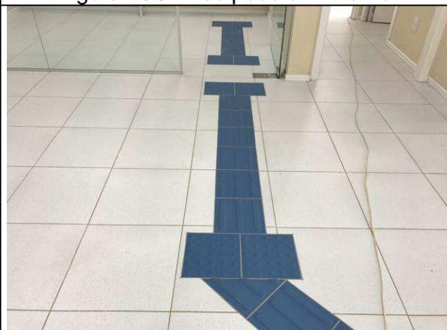
Figura 22C: Piso podotátil interno.
