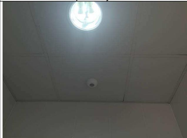
Figura 48E: iluminação interna - sensor de presença
