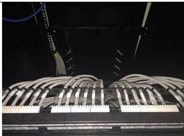
Figura 79E: rack sala técnica - patch pannels e organizadores de cabos
