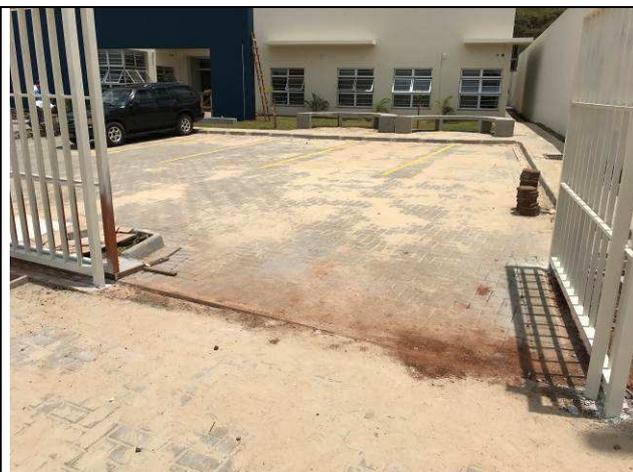
Figura 70C: Pavimentação interna - paver.
