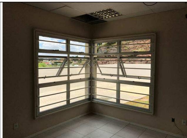
Figura 14C: Grades de proteção - janela J01 - OAB.
