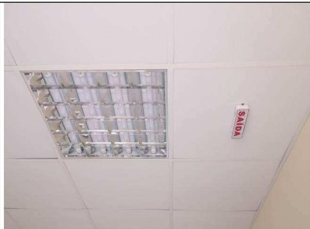
Figura 39E: iluminação interna - luminárias 62x62 com aletas antireflexivas
