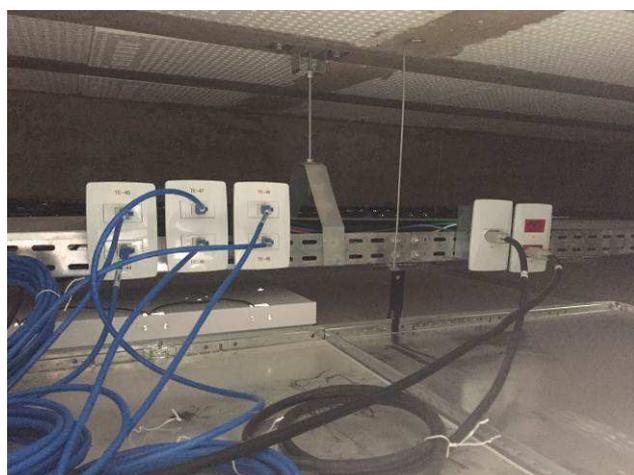
Figura 15E: infraestrutura interna - tomadas condutes padrão genérico
