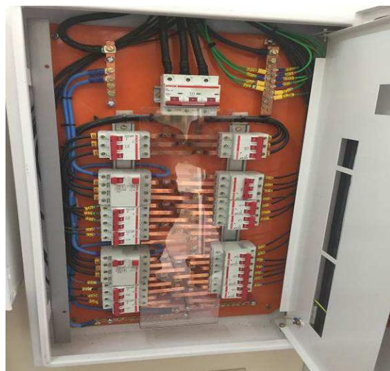
Figura 18E: cabeamento elétrico - circuitos alimentadores condicionadores de ar
