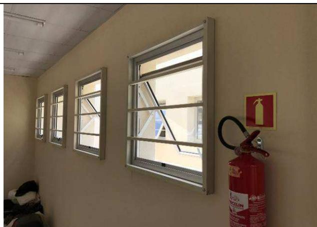
Figura 07C: Grades de proteção - janela J02 - arquivo.
