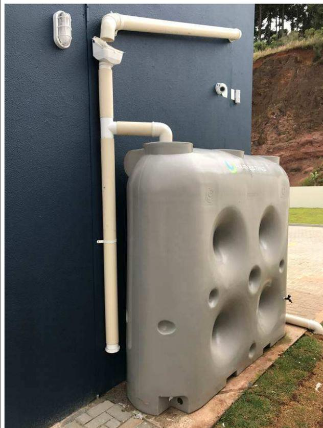
Figura 28C: Sistema de aproveitamento de águas pluviais.
