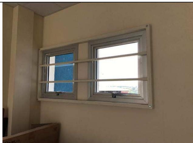
Figura 13C: Grades de proteção - janela J03 - PAB.
