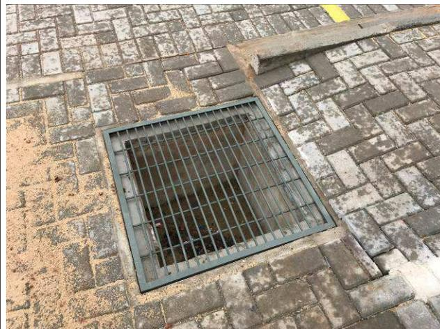
Figura 26C: Grelhas - caixas pluviais.
