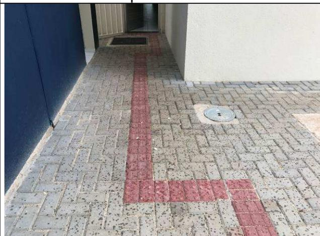
Figura 78C: Pavimentação interna - piso podotátil.
