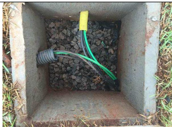
Figura 24E: cabearmento elétrico - circuitos externos portão e iluminação
