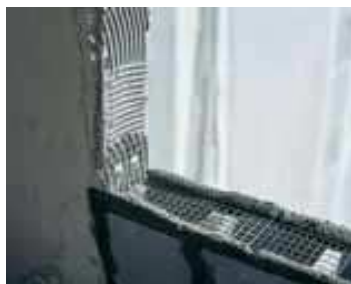
Ligação da Estrutura com a Alvenaria
