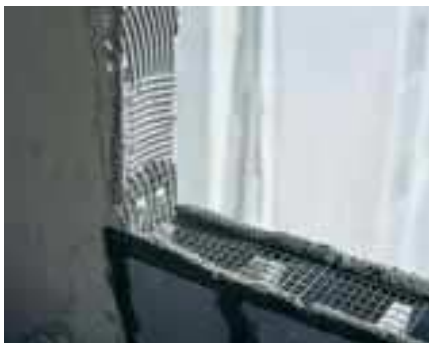
Ligação da Estrutura com a Alvenaria
