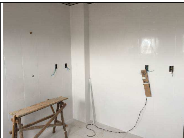
Figura 60C: Azulejos instalados - copa.
