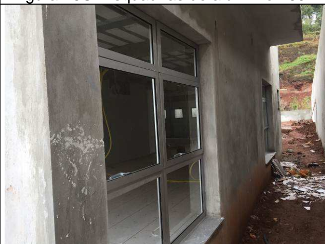
Figura 28C: Esquadrias de alumínio - J01.
