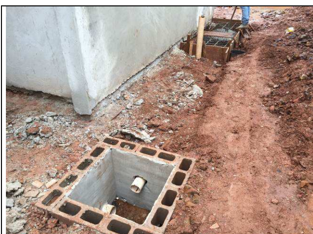
Figura 01C: Reaterro de valas - redes de esgoto e águas pluviais.
