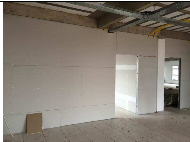
Figura 03C: Divisórias em gesso acartonado.
