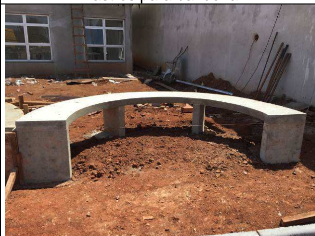
Figura 142C: Banco de concreto.
