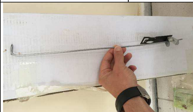
Figura 42C: Montagem dos perfis metálicos - detalhe do suporte regulável fixado na laje.
