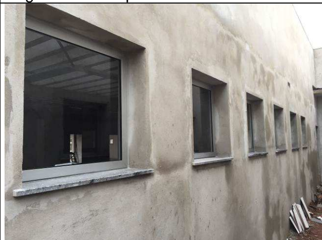
Figura 25C: Esquadrias de alumínio - J02.
