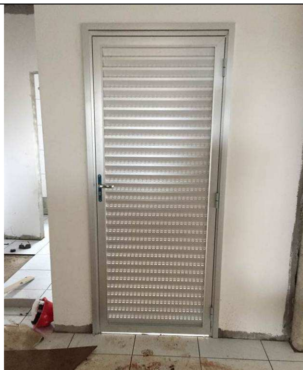
Figura 20C: Esquadrias de alumínio - porta de alumínio - fundos da secretaria.
