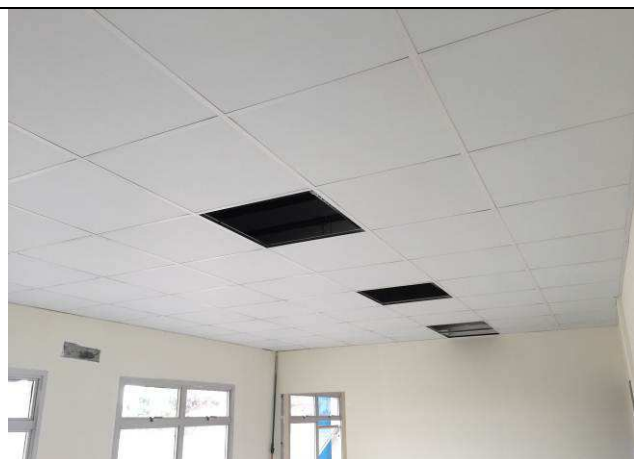
Figura 45C: Forro modular instalado - sala de audiências 2.
