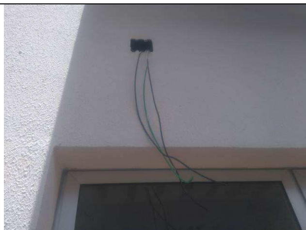
Figura 12E: infraestrutura interna, cabeamento elétrico
