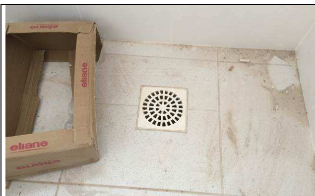
Figura 84C: Caixas sifonadas com grelha.
