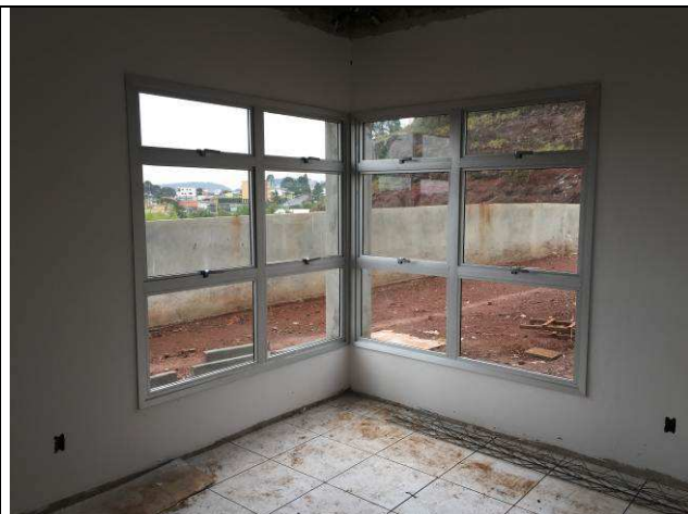
Figura 30C: Esquadrias de alumínio - J04.
