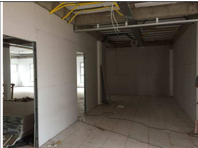
Figura 04C: Divisórias em gesso acartonado.
