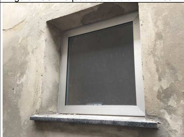
Figura 27C: Esquadrias de alumínio - J03.
