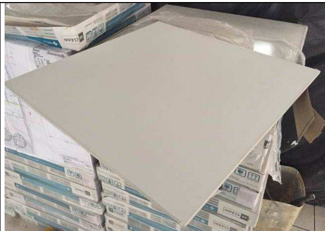
Figura 39C: Placas de forro com película vinílica branca na face inferior.
