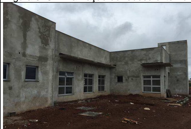
Figura 64C: Finalização do reboco externo.
