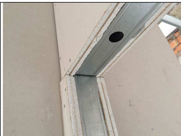
Figura 10C: Detalhe da parede dupla em sala de audiência.
