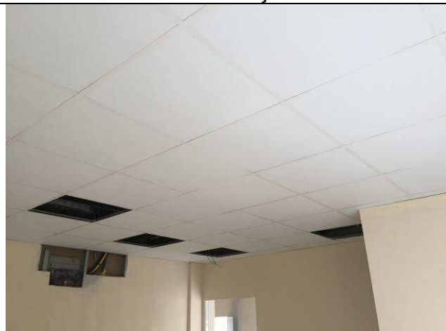
Figura 49C: Forro modular instalado - gabinete de juiz titular.
