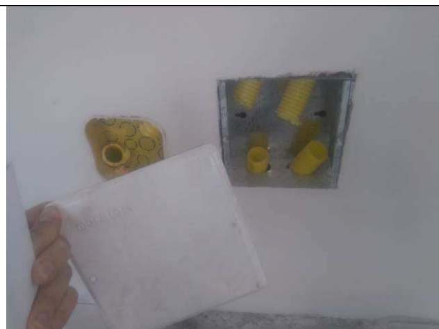
Figura 29E: infraestrutura interna
