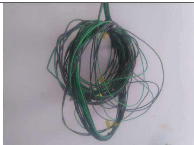
Figura 23E: infraestrutura interna, cabeamento elétrico
