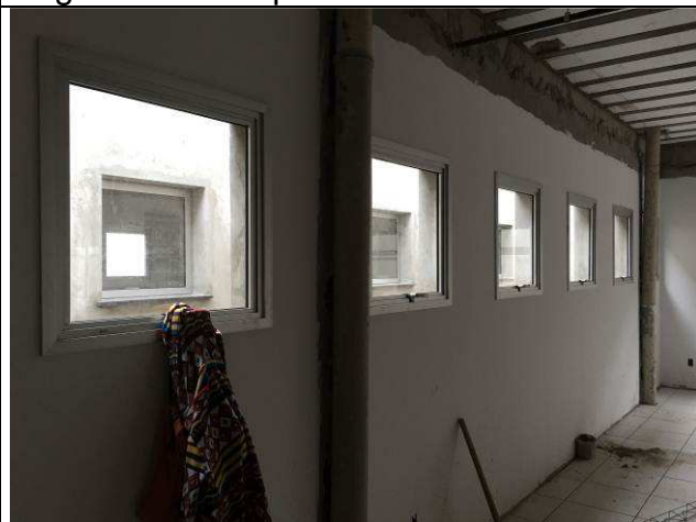
Figura 26C: Esquadrias de alumínio - J02.
