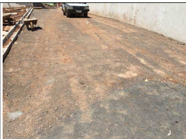
Figura 103C: Base de brita graduada para pavimentação com blocos.
