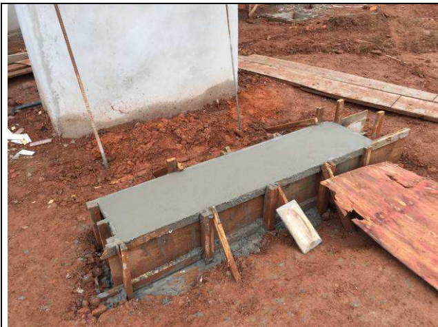
Figura 139C: Concretagem da base dos mastros para bandeira.
