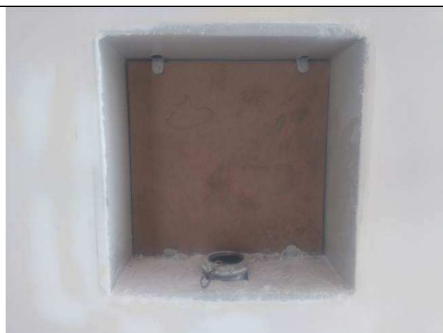
Figura 28E: infraestrutura externa (chegada PAB)
