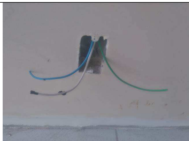
Figura 15E: infraestrutura interna, cabeamento elétrico
