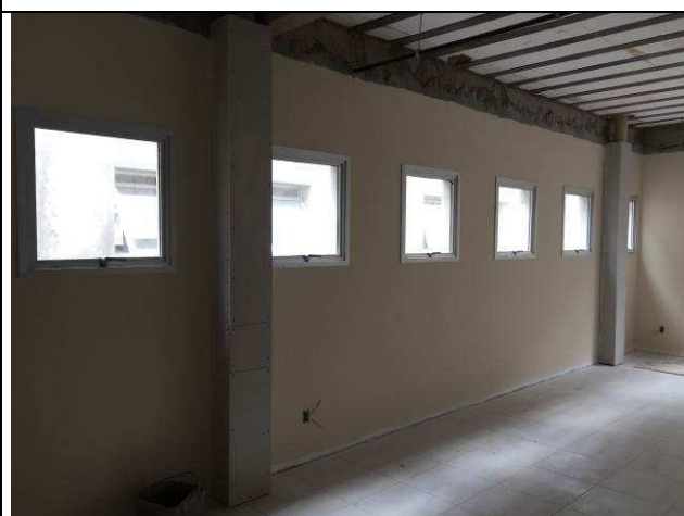
Figura 14C: Divisórias em gesso acartonado - embonecamento das tubulações de águas pluviais.
