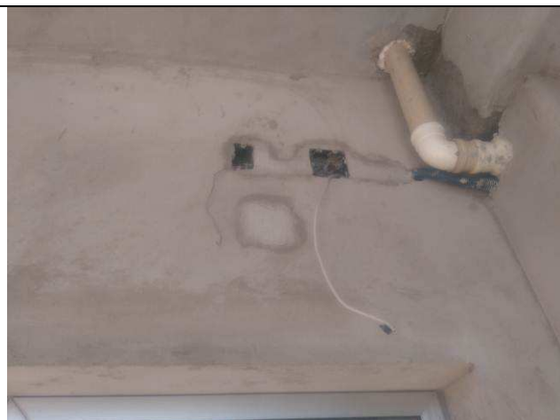
Figura 32E: infraestrutura interna
