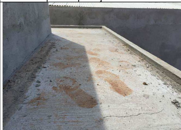
Figura 151C: Impermeabilização das marquises - proteção mecânica.
