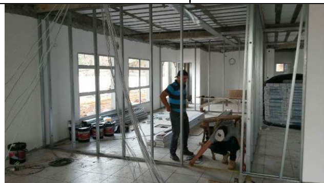
Figura 11C: Montagem dos perfis de sustentação das paredes.
