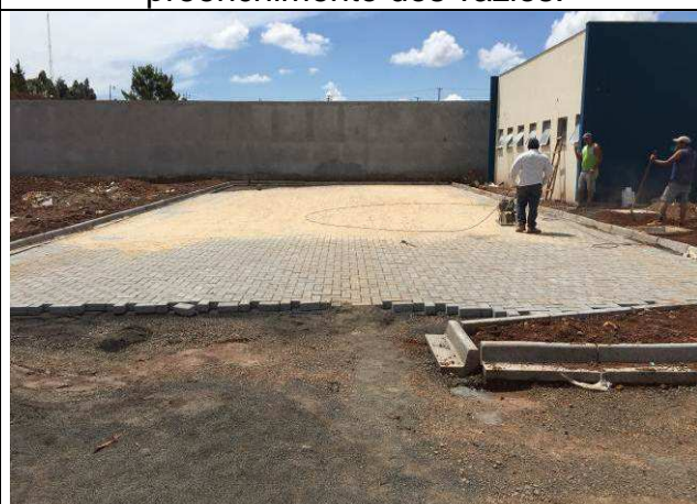
Figura 108C: Pavimentação com blocos de concreto intertravados.
