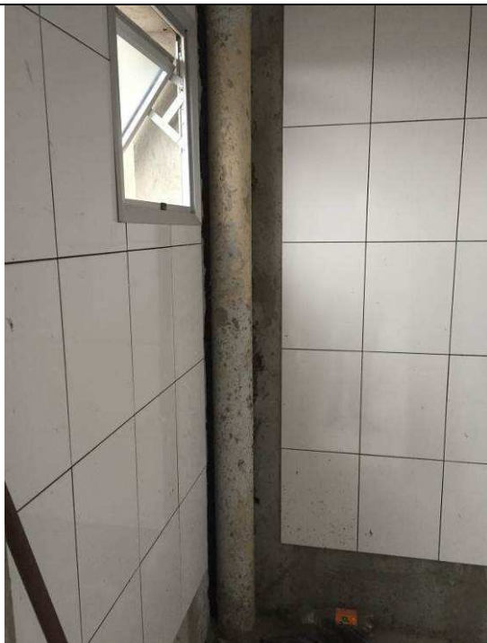
Figura 51C: Azulejos instalados - bwc juiz auxiliar.
