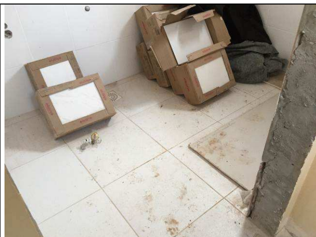
Figura 72C: Piso cerâmico - banheiro da secretaria.
