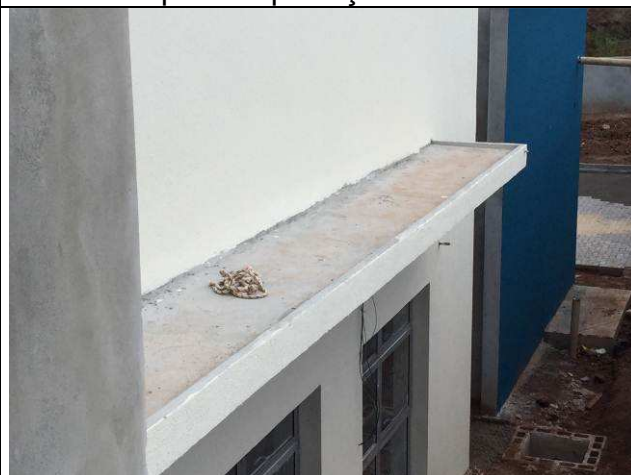
Figura 149C: Impermeabilização das marquises - proteção mecânica.
