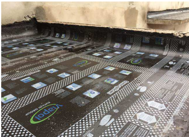
Figura 144C: Impermeabilização das marquises - manta asfáltica.
