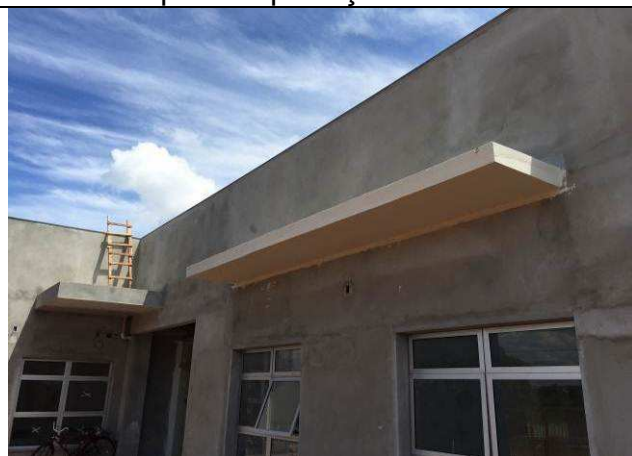
Figura 154C: Impermeabilização das marquises - acabamento final.
