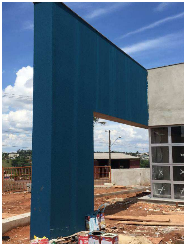
Figura 135C: Pintura das paredes externas.
