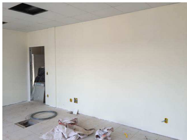
Figura 131C: Pintura das paredes internas.
