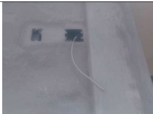
Figura 31E: infraestrutura interna
