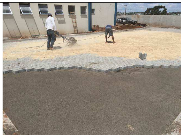
Figura 105C: Pó de pedra utilizado para assentamento dos blocos de concreto.
