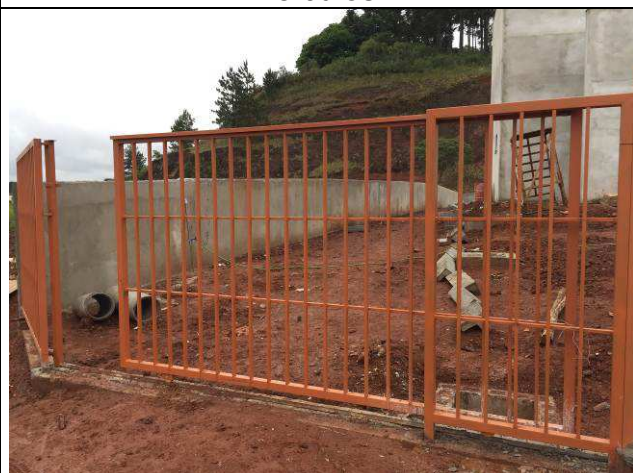
Figura 121C: Portão de acesso para veículos.
