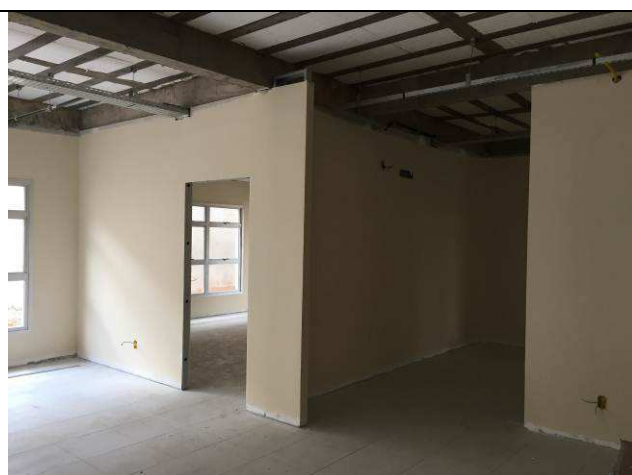
Figura 13C: Divisórias em gesso acartonado.
