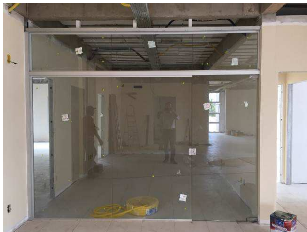
Figura 16C: Esquadria de vidro temperado - entrada do balcão de atendimento.
