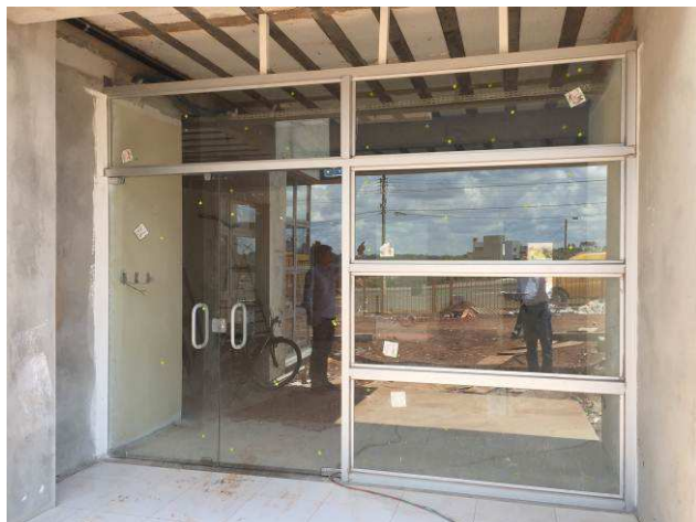
Figura 15C: Esquadria de vidro temperado - entrada do edifício.
