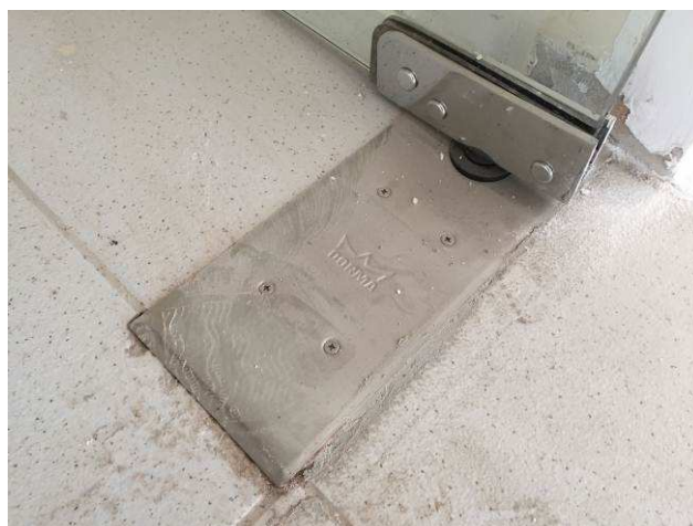
Figura 18C: Esquadria de vidro temperado - mola de piso.
