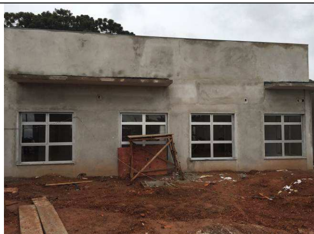
Figura 29C: Esquadrias de alumínio - J01.
