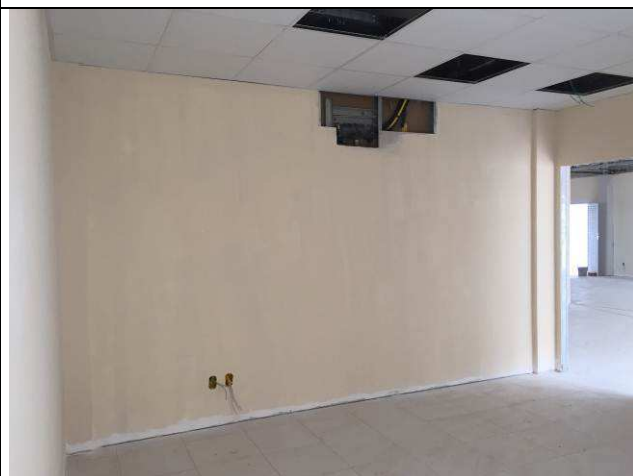
Figura 134C: Pintura das paredes internas.
