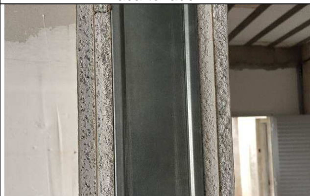
Figura 05C: Detalhe da parede dupla em sala de audiência.
