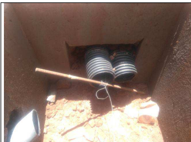
Figura 27E: infraestrutura externa
