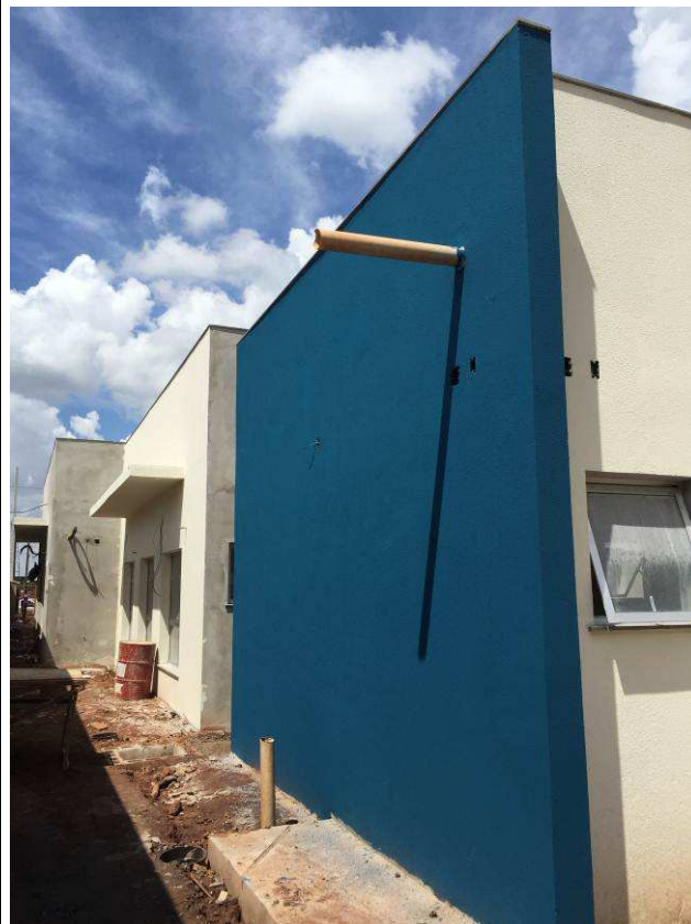
Figura 136C: Pintura das paredes externas.
