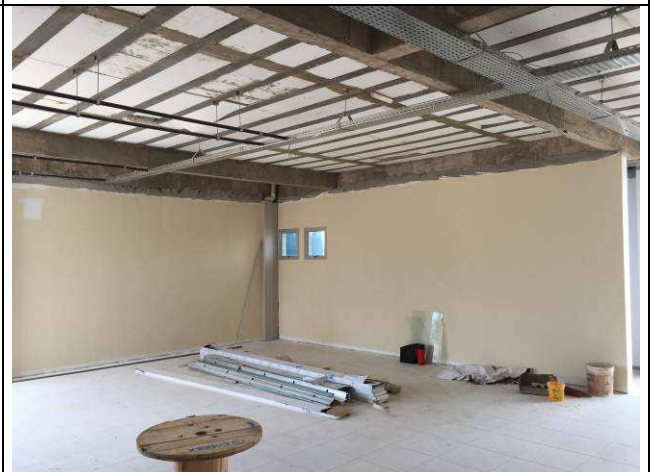
Figura 126C: Pintura das paredes internas.
