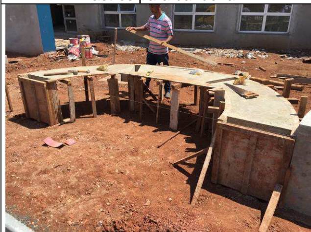
Figura 141C: Forma de madeira do banco.
