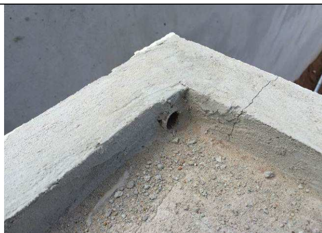
Figura 152C: Impermeabilização das marquises - proteção mecânica.
