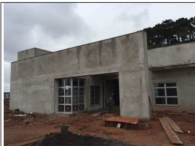
Figura 61C: Finalização do reboco externo.
