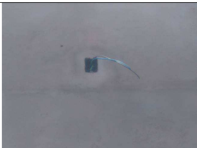
Figura 14E: infraestrutura interna, cabeamento elétrico
