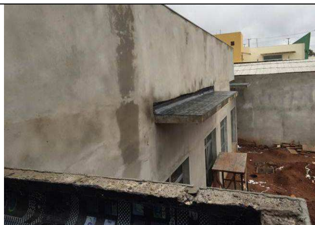
Figura 146C: Impermeabilização das marquises - manta asfáltica.
