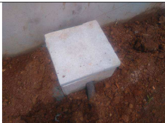
Figura 08E: infraestrutura externa
