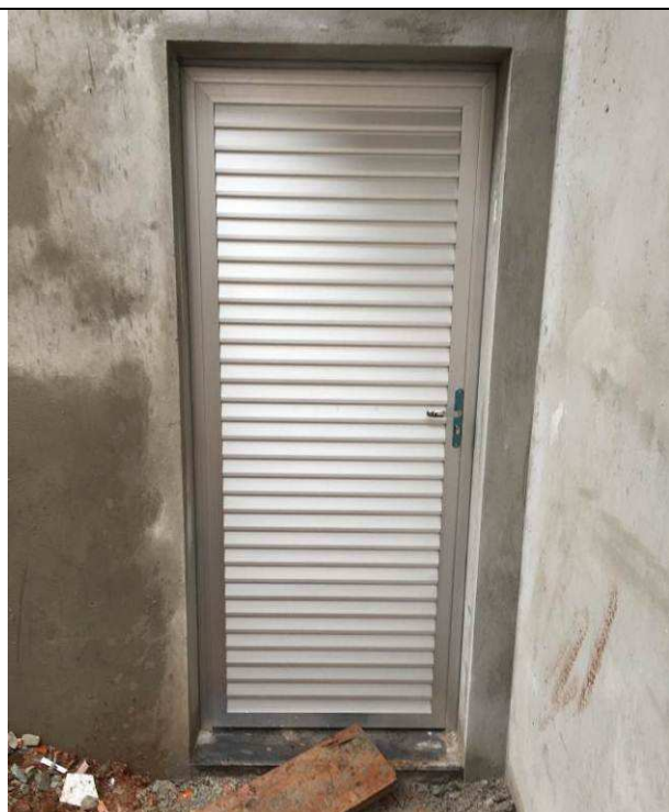
Figura 19C: Esquadrias de alumínio - porta de alumínio - fundos da secretaria.
