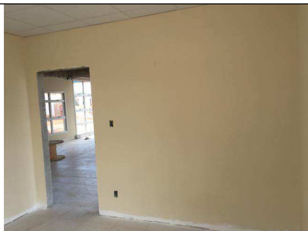
Figura 129C: Pintura das paredes internas.
