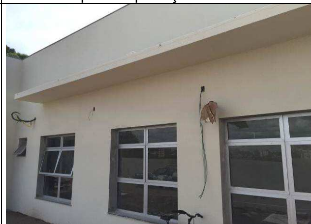
Figura 155C: Impermeabilização das marquises - acabamento final.
