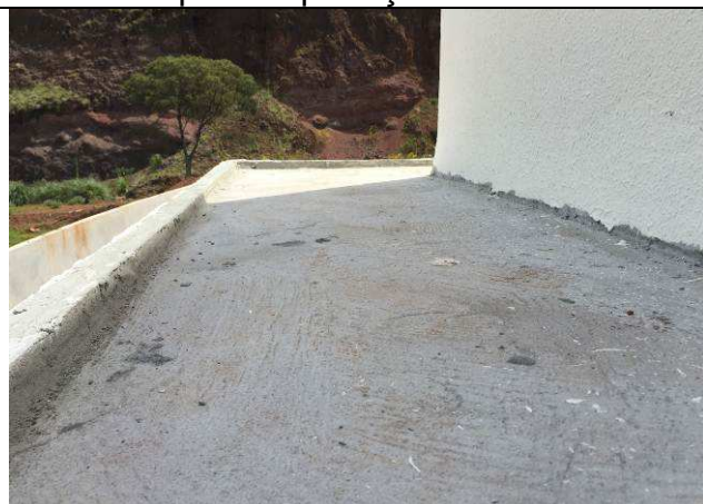
Figura 150C: Impermeabilização das marquises - proteção mecânica.
