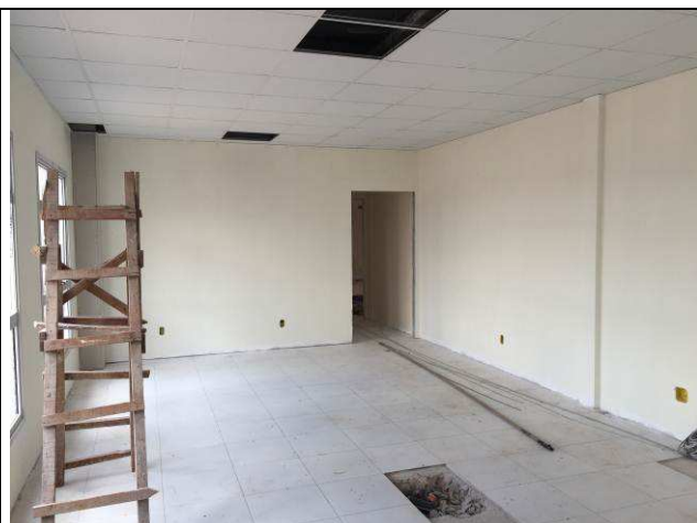
Figura 130C: Pintura das paredes internas.
