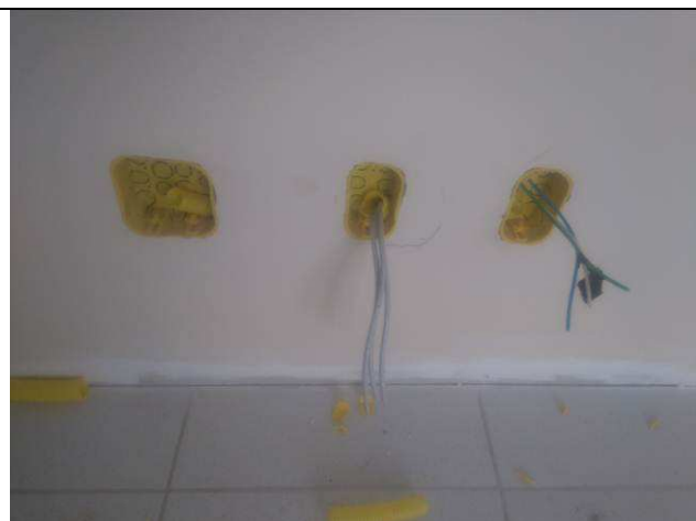
Figura 33E: infraestrutura interna
