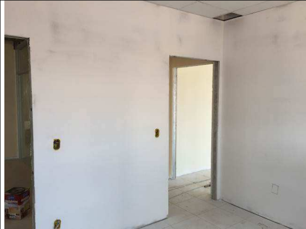
Figura 123C: Emassamento das paredes internas.
