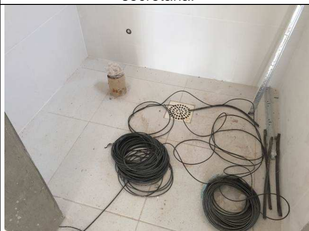
Figura 74C: Piso cerâmico - banheiro do gabinete de juiz titular.
