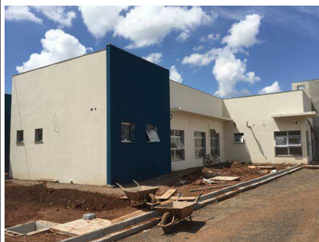
Figura 138C: Pintura das paredes externas.
