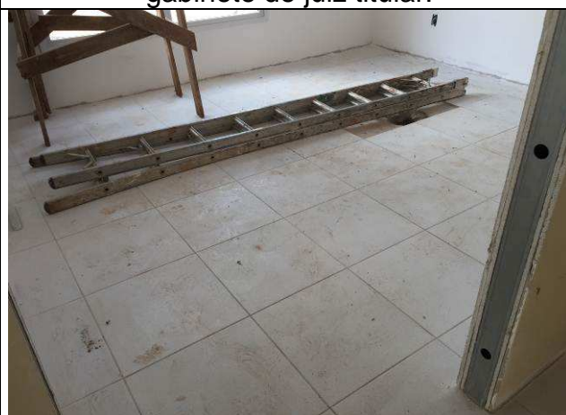
Figura 76C: Piso cerâmico - sala de conciliação.
