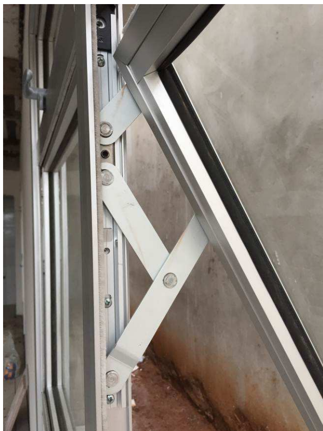
Figura 37C: Esquadrias de alumínio - sistema progressivo de abertura.
