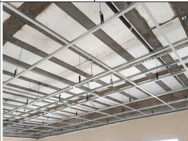
Figura 43C: Montagem dos perfis metálicos - arquivo.
