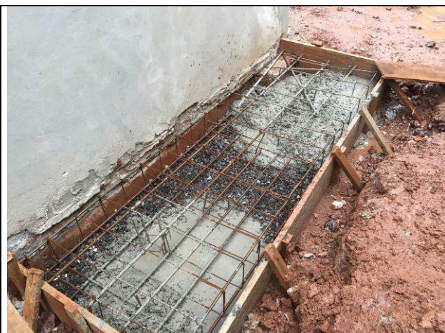
Figura 95C: Concretagem da base do tanque de águas pluviais.
