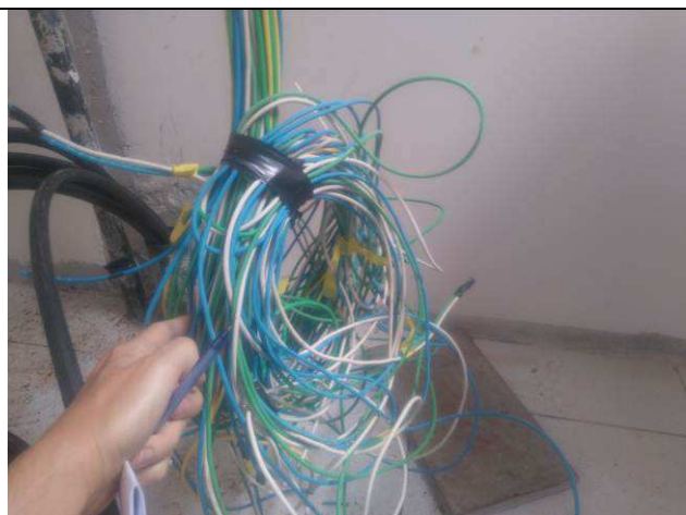
Figura 25E: infraestrutura interna, cabeamento elétrico
