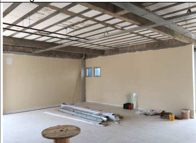
Figura 127C: Pintura das paredes internas.
