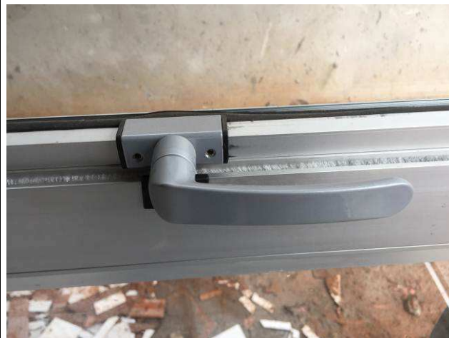
Figura 36C: Esquadrias de alumínio - detalhe do puxador.
