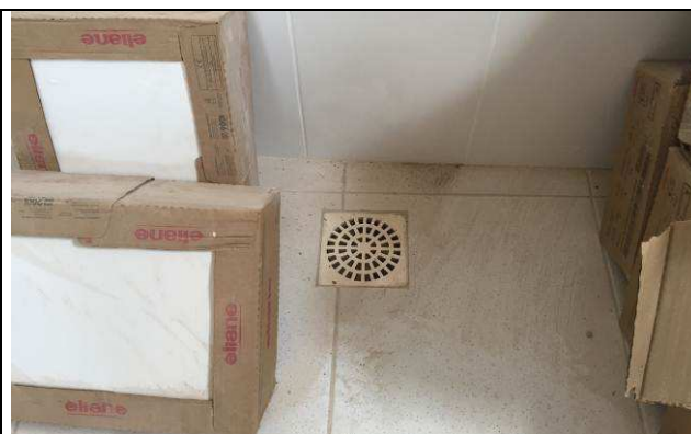
Figura 85C: Caixas sifonadas com grelha.
