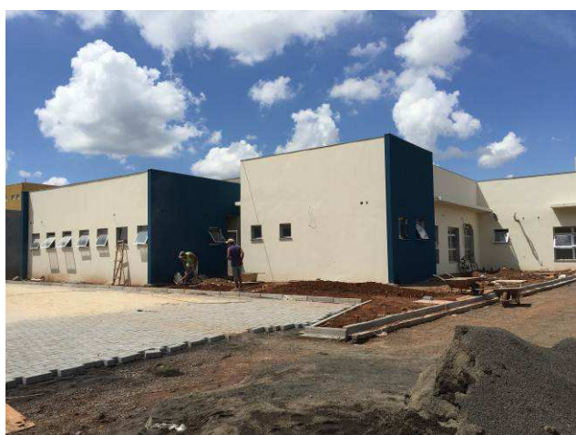
Figura 137C: Pintura das paredes externas.
