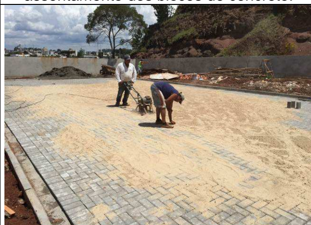
Figura 107C: Pavimentação com blocos de concreto intertravados.
