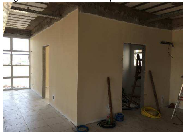
Figura 128C: Pintura das paredes internas.
