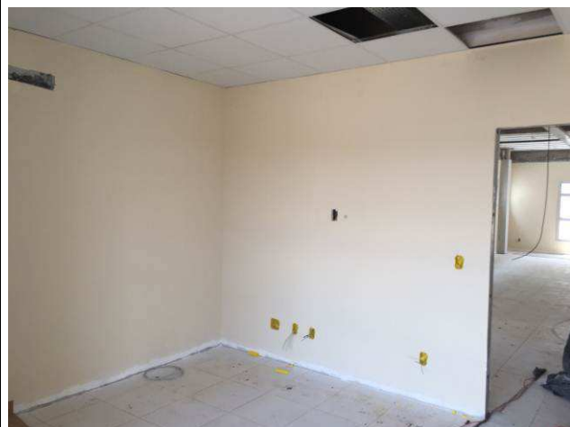
Figura 132C: Pintura das paredes internas.
