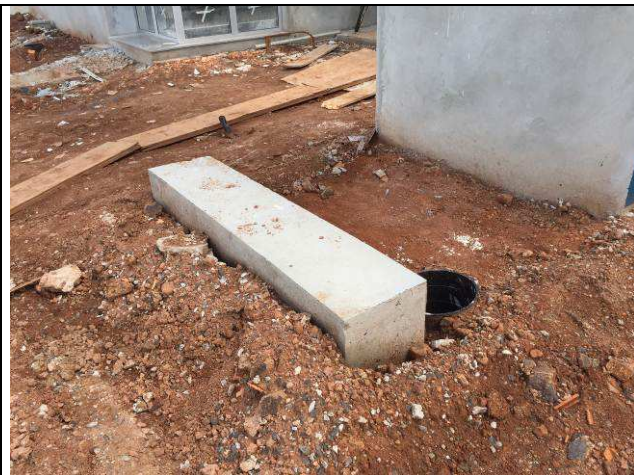
Figura 140C: Base de concreto armado dos mastros para bandeira.
