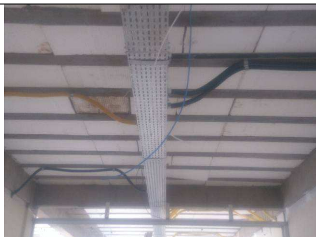
Figura 20E: infraestrutura interna, cabeamento elétrico
