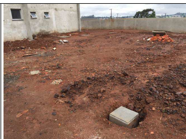
Figura 02C: Reaterro de valas - redes de esgoto e águas pluviais.
