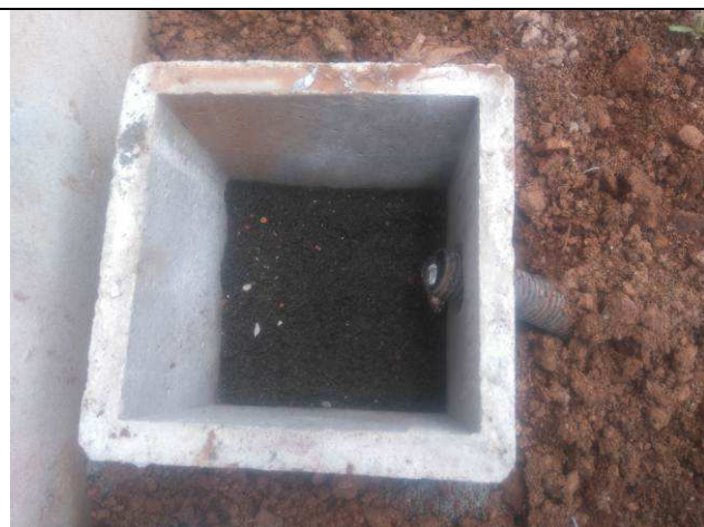
Figura 09E: infraestrutura externa
