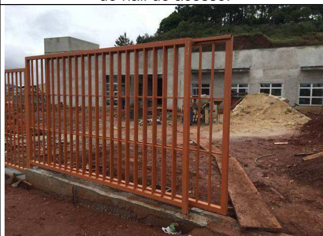
Figura 119C: Portão de acesso para veículos.
