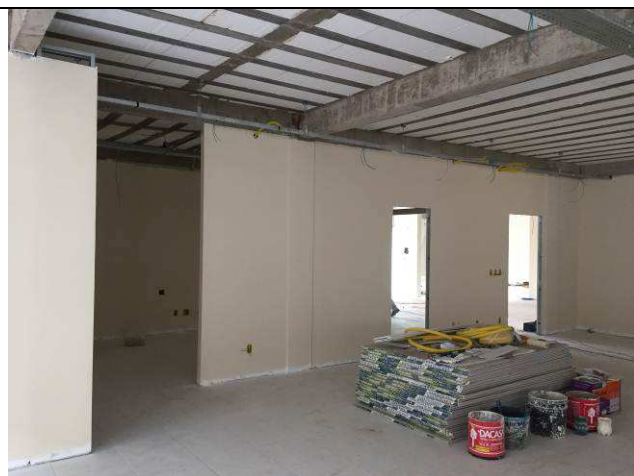
Figura 133C: Pintura das paredes internas.
