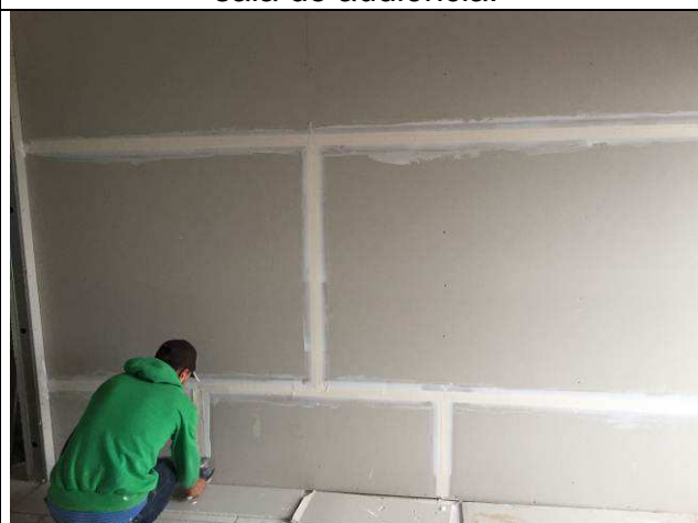
Figura 07C: Aplicação de fita nas emendas.
