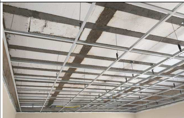
Figura 41C: Montagem dos perfis metálicos - arquivo.
