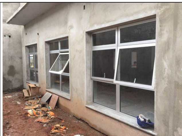
Figura 23C: Esquadrias de alumínio - J01.
