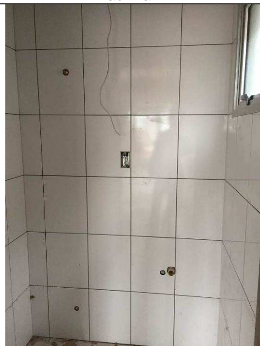
Figura 54C: Azulejos instalados - bwc juiz titular.
