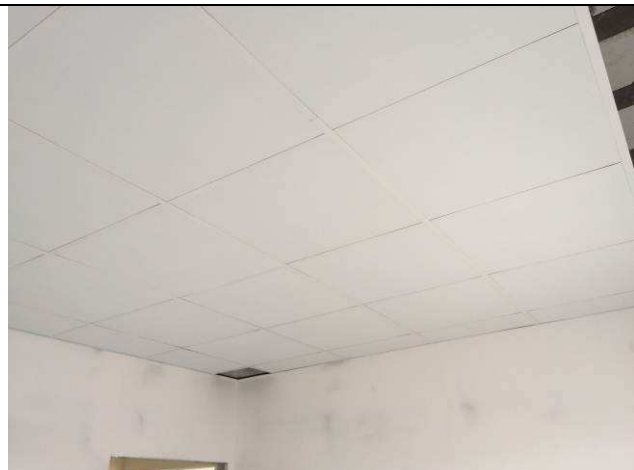
Figura 47C: Forro modular instalado - sala de conciliação.
