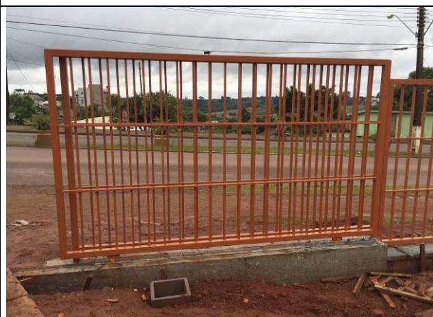
Figura 120C: Portão de acesso para veículos.
