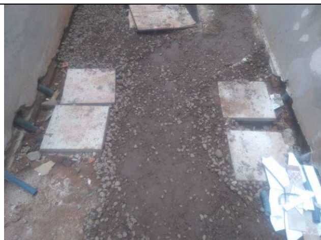
Figura 10E: infraestrutura externa
