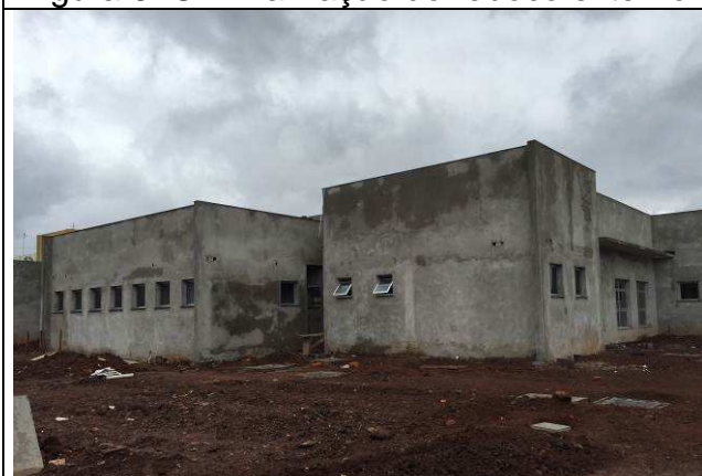
Figura 63C: Finalização do reboco externo.
