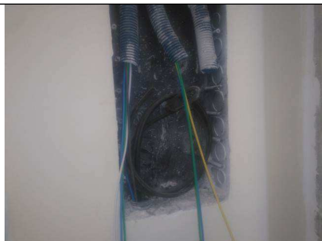
Figura 19E: infraestrutura interna, cabeamento elétrico
