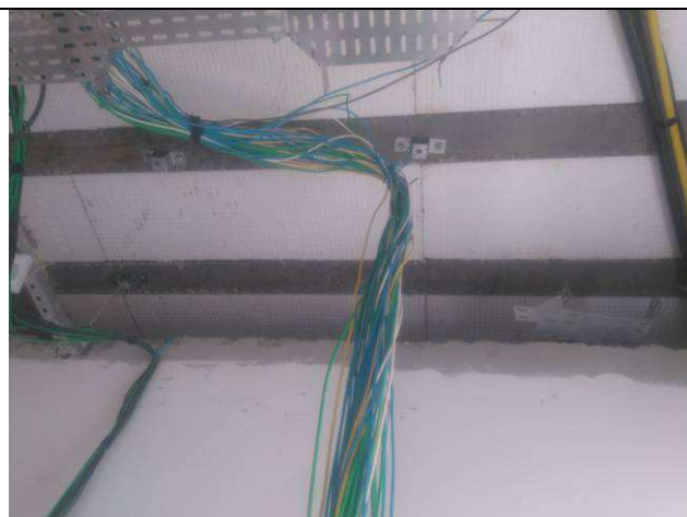
Figura 26E: infraestrutura interna, cabeamento elétrico
