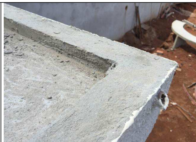
Figura 153C: Impermeabilização das marquises - proteção mecânica.
