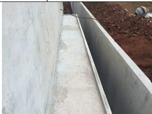
Figura 148C: Impermeabilização das marquises - proteção mecânica.
