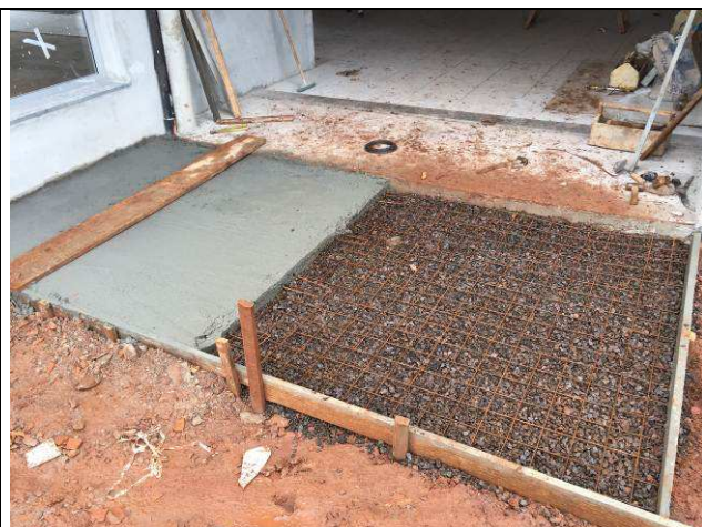
Figura 117C: Concretagem do contrapiso do hall de acesso.
