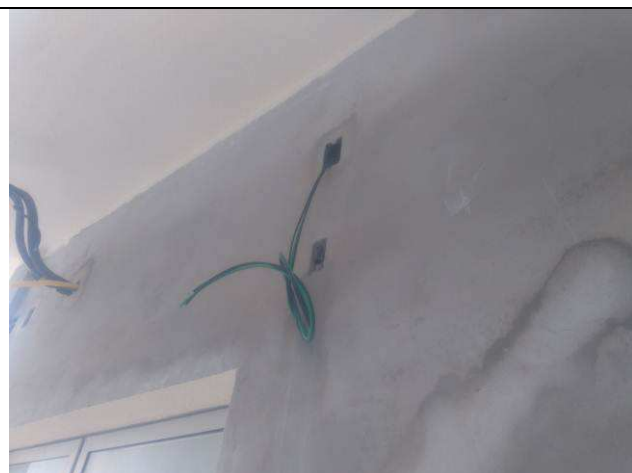
Figura 13E: infraestrutura interna, cabeamento elétrico
