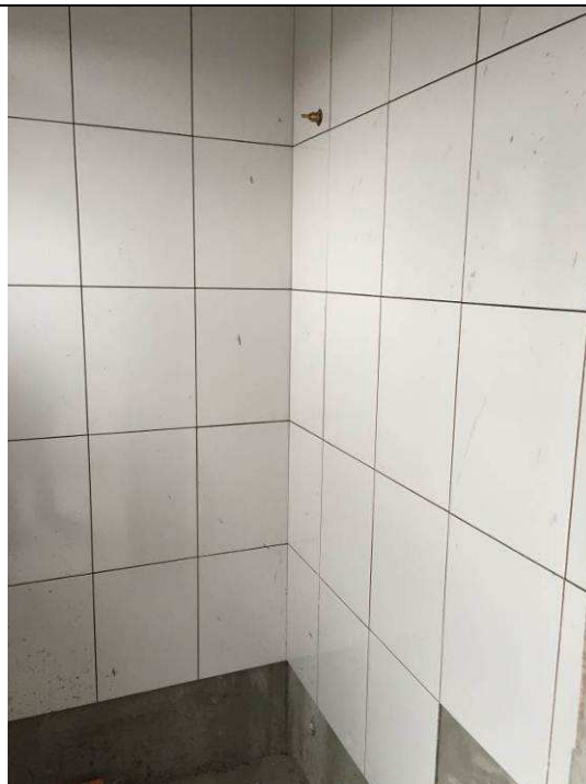
Figura 52C: Azulejos instalados - bwc juiz auxiliar.
