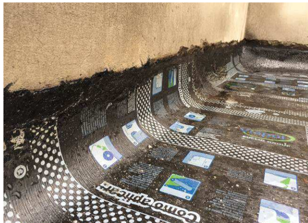
Figura 145C: Impermeabilização das marquises - manta asfáltica.
