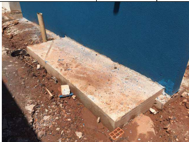
Figura 96C: Base do tanque de águas pluviais.
