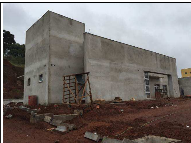
Figura 62C: Finalização do reboco externo.
