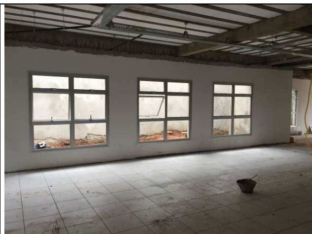
Figura 24C: Esquadrias de alumínio - J01.
