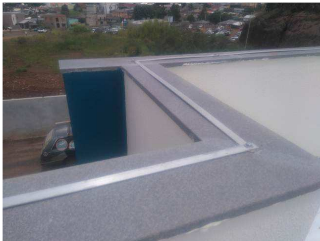
Figura 47E: sistema de captação SPDA
