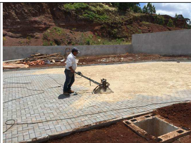
Figura 106C: Compactação com areia para preenchimento dos vazios.
