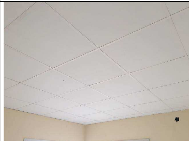
Figura 50C: Forro modular instalado - sala da OAB.
