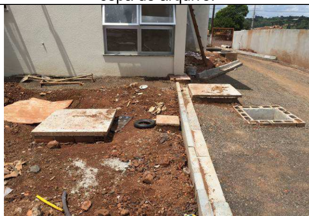
Figura 90C: Caixas de inspeção de esgoto com tampa.
