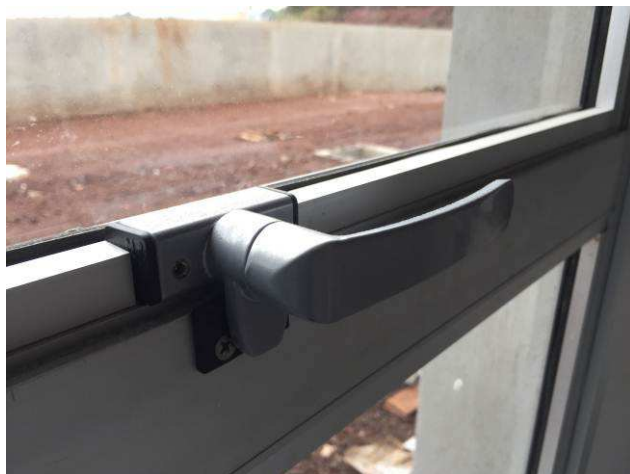
Figura 35C: Esquadrias de alumínio - detalhe do puxador.
