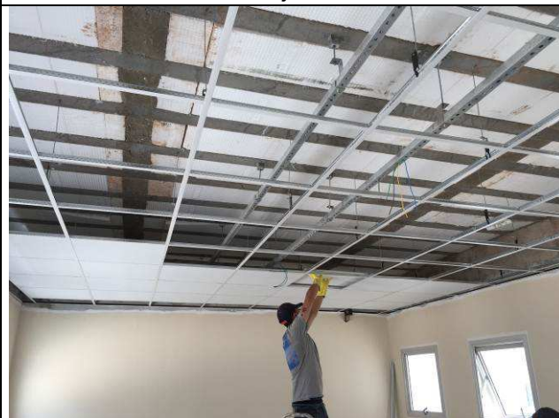
Figura 44C: Montagem das placas de gesso acartonado - arquivo.
