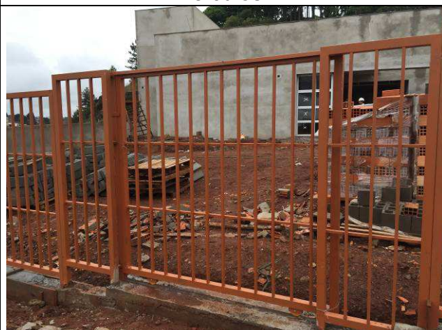
Figura 122C: Portão de acesso para pedestres.
