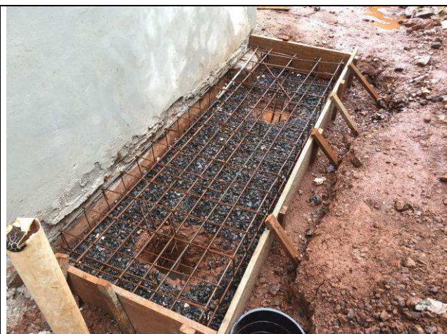
Figura 94C: Armação da base do tanque de águas pluviais.
