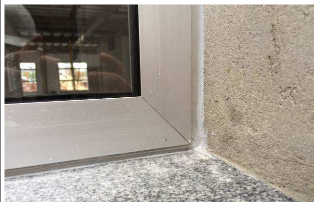
Figura 38C: Vedações com selante elástico a base de poliuretano.
