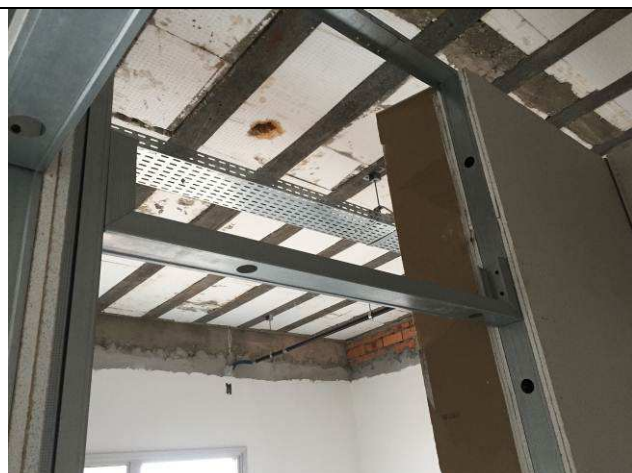
Figura 09C: Reforço instalado sobre as aberturas de portas.
