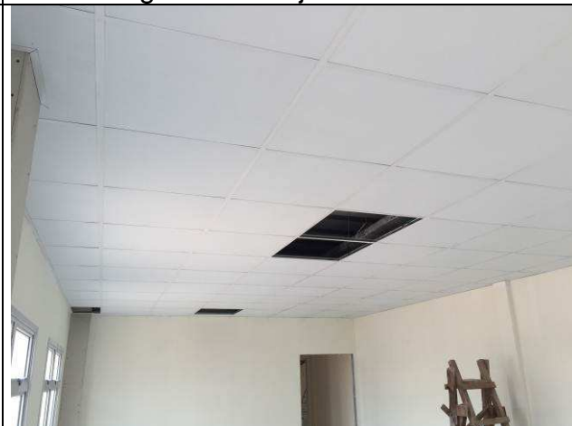
Figura 48C: Forro modular instalado - sala de audiências 1.
