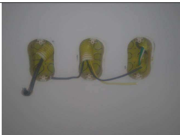
Figura 18E: infraestrutura interna, cabeamento elétrico
