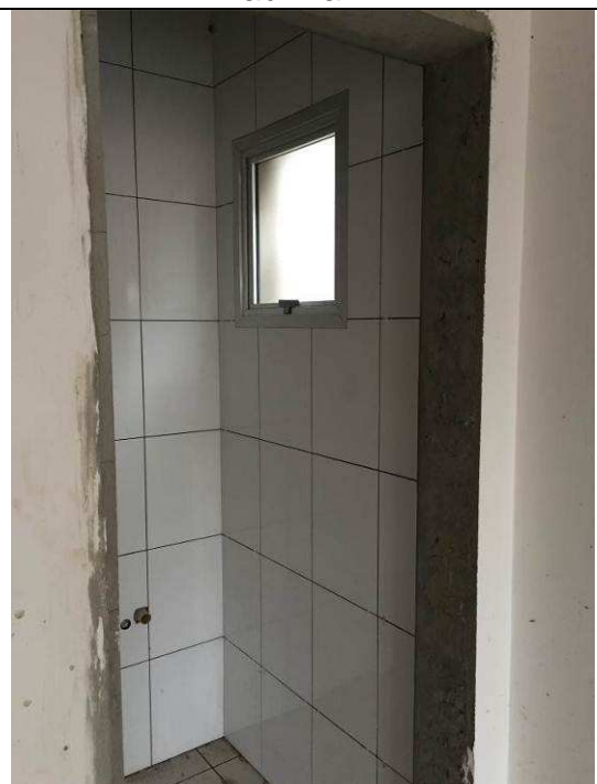
Figura 53C: Azulejos instalados - bwc juiz titular.
