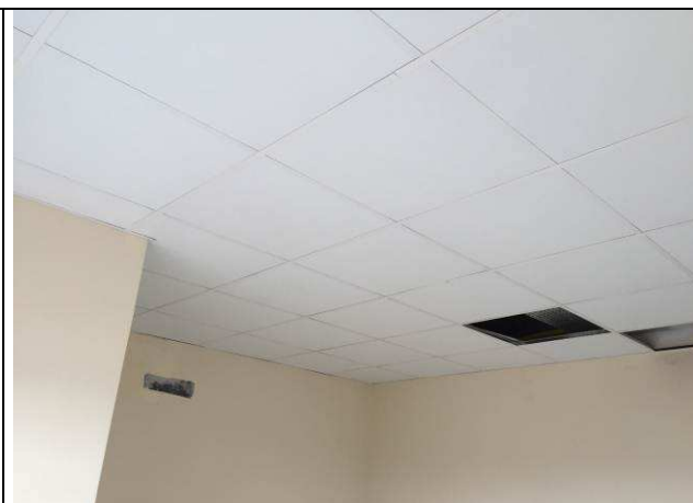
Figura 46C: Forro modular instalado - gabinete de juiz auxiliar.
