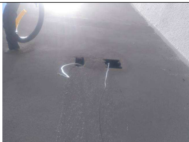
Figura 30E: infraestrutura interna
