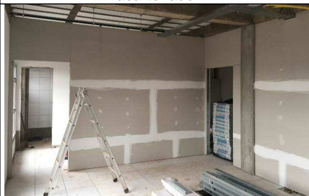
Figura 06C: Divisórias em gesso acartonado.
