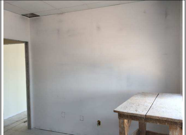
Figura 124C: Emassamento das paredes internas.
