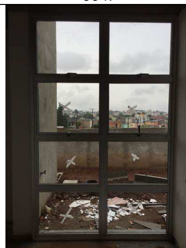
Figura 34C: Esquadrias de alumínio - J05.
