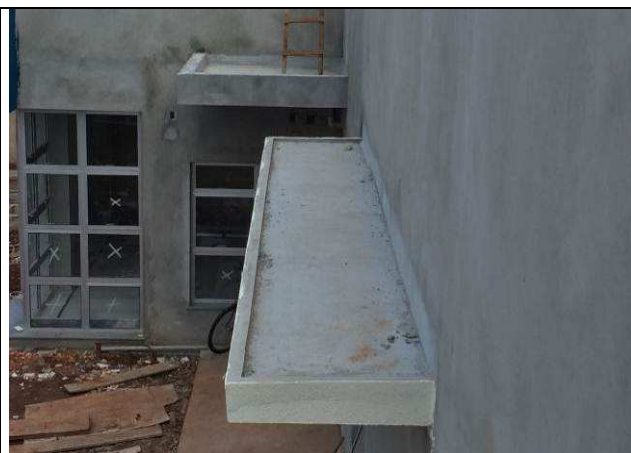
Figura 147C: Impermeabilização das marquises - proteção mecânica.
