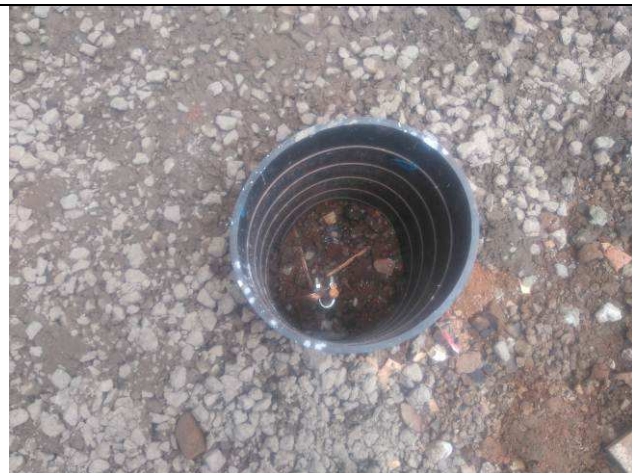
Figura 41E: malha de aterramento
