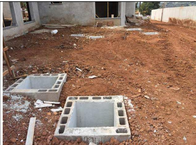
Figura 04C: Reaterro de valas - redes de esgoto e águas pluviais.
