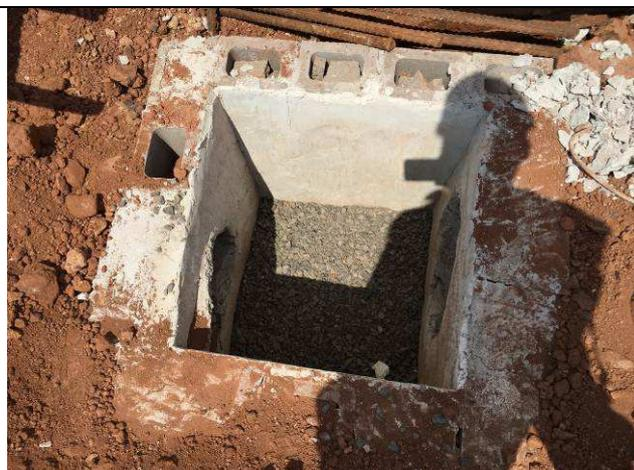
Figura 61C: Caixa de inspeção - rede coletora de águas pluviais.
