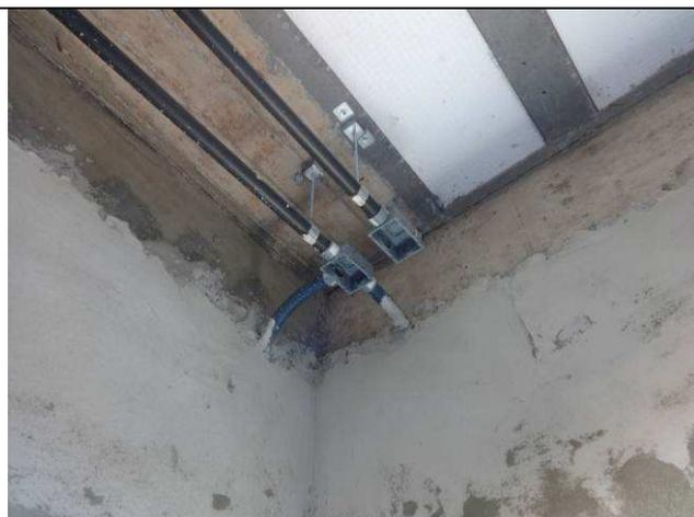
Figura 11E: condutores para infraestrutura de CFTV
