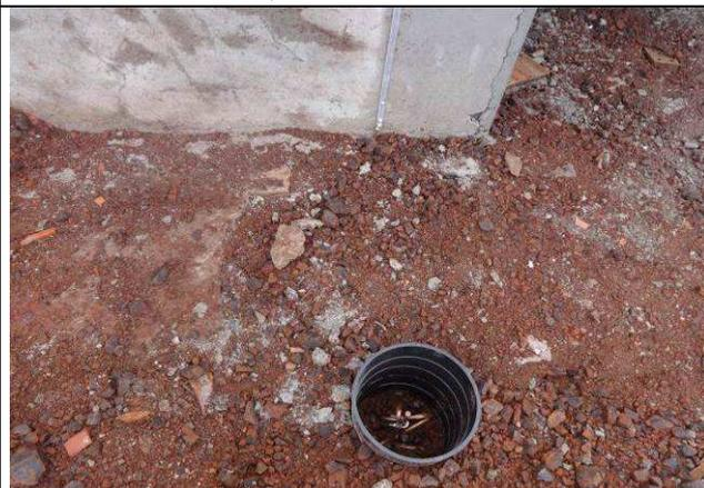
Figura 20E: caixas de inspeção, hastes de aterramento, cabo cobre nu 50mm<sup>2</sup>.
