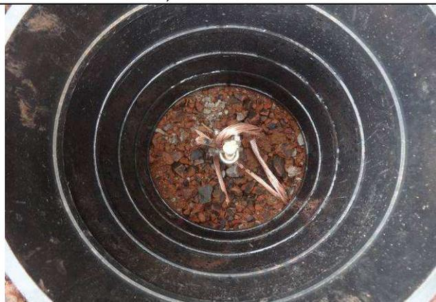
Figura 19E: caixas de inspeção, hastes de aterramento, cabo cobre nu 50mm<sup>2</sup>.
