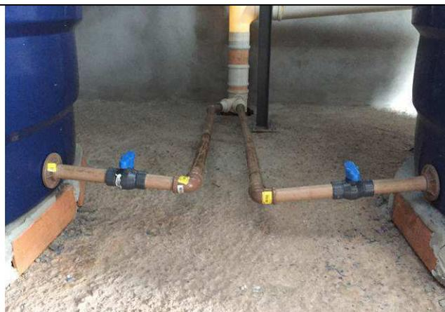
Figura 55C: Registros e tubulações - reservatórios superiores.
