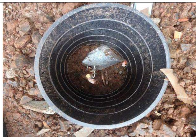
Figura 18E: caixas de inspeção, hastes de aterramento, cabo cobre nu 50mm<sup>2</sup>.
