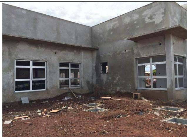
Figura 097C: Janelas instaladas - J01.
