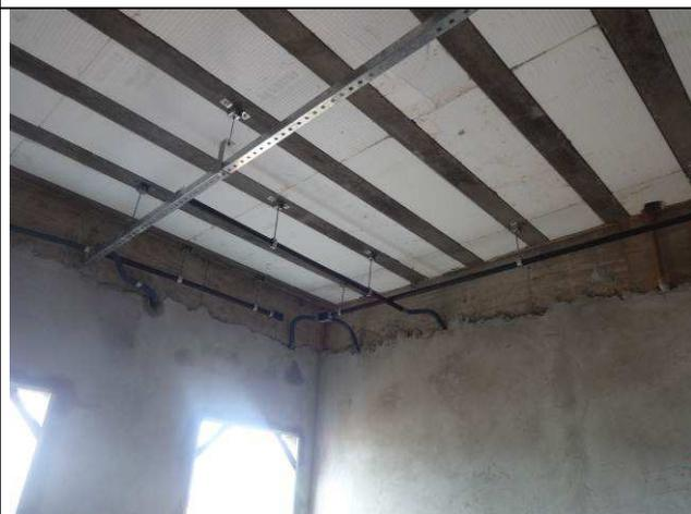
Figura 12E: condutores para infraestrutura de CFTV
