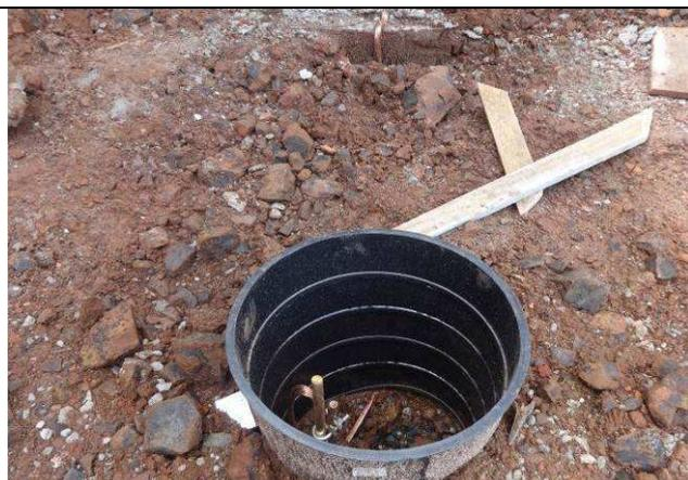
Figura 17E: caixas de inspeção, hastes de aterramento, cabo cobre nu 50mm<sup>2</sup>.
