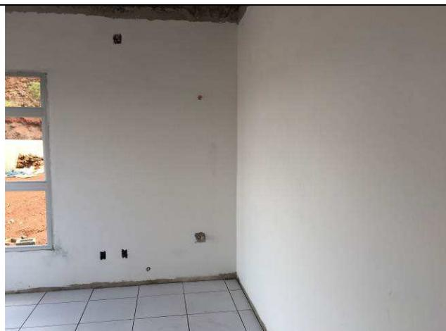
Figura 09E: caixas 2x4" e 4x4" embutidas em alvenaria
