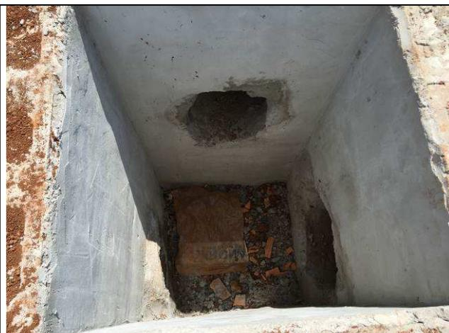
Figura 62C: Caixa de inspeção - rede coletora de águas pluviais.
