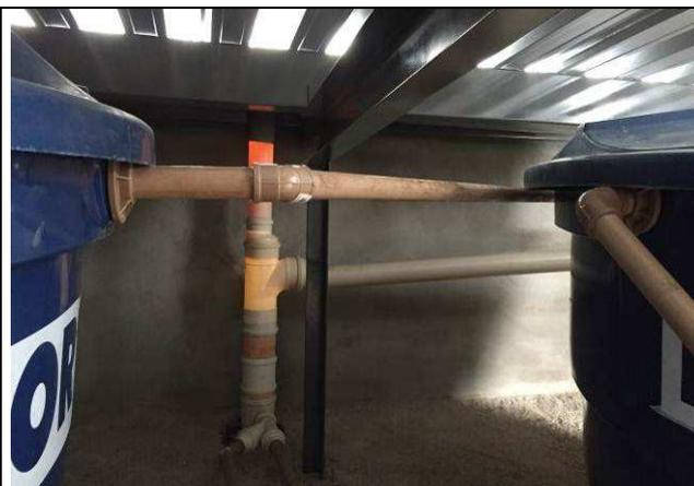
Figura 56C: Registros e tubulações - reservatórios superiores.
