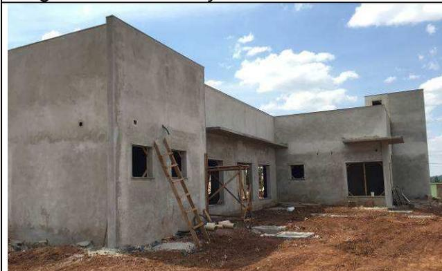
Figura 33C: Reboco externo - lateral.
