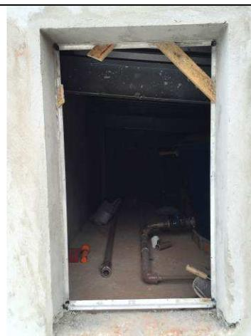
Figura 08C: Contramarcos instalados - reservatórios superiores.
