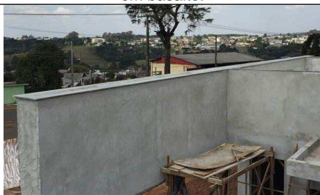
Figura 19C: Capeamento das platibandas em basalto.
