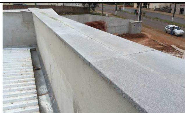
Figura 20C: Capeamento das platibandas em basalto.
