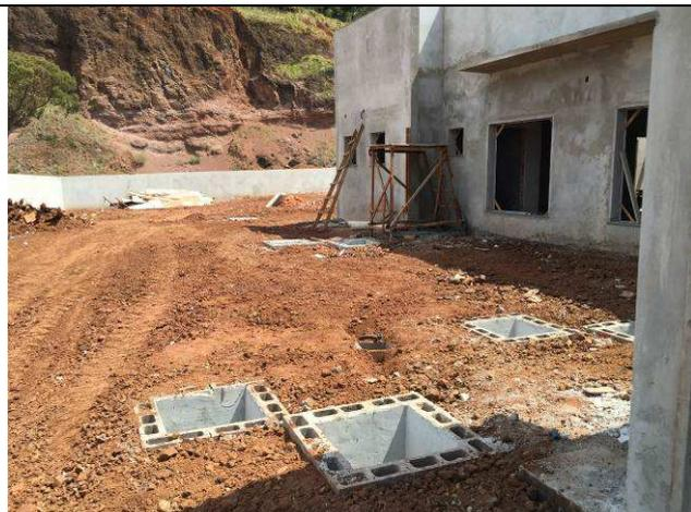
Figura 03C: Reaterro de valas - redes de esgoto e águas pluviais.
