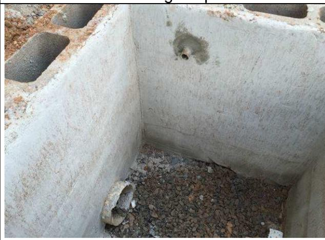
Figura 66C: Pontos de dreno - caixa de águas pluviais.
