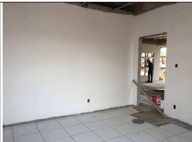
Figura 10E: caixas 2x4" e 4x4" embutidas em alvenaria
