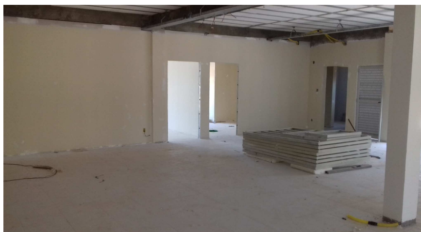
Figura 2 – Vista interna do imóvel
