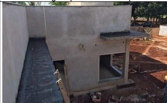
Figura 50C: Impermeabilização das marquises - manta asfáltica.
