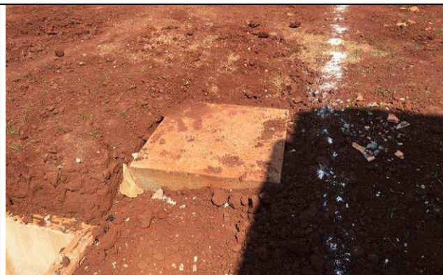
Figura 47C: Caixa de inspeção da drenagem pluvial com tampa.
