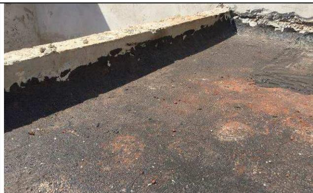
Figura 49C: Impermeabilização das marquises - aplicação de primer.
