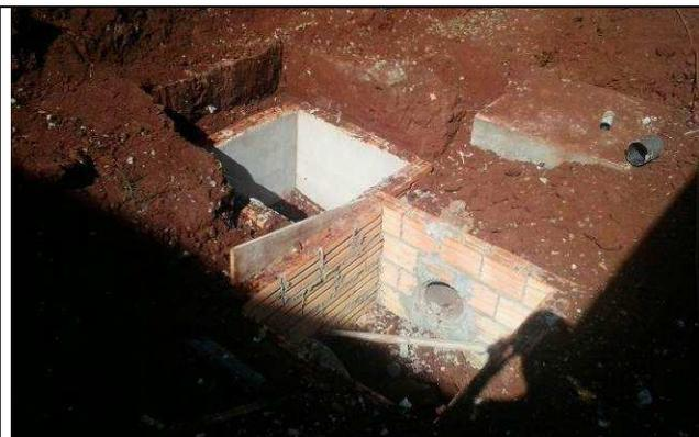
Figura 48C: Caixa de inspeção da drenagem pluvial com tampa.
