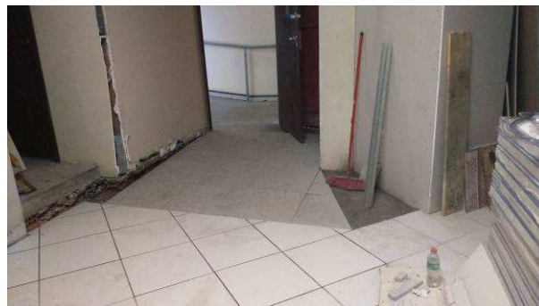
Figura 16c: substituição do piso cerâmico e execução da rampa acessibilidade - piso granito
