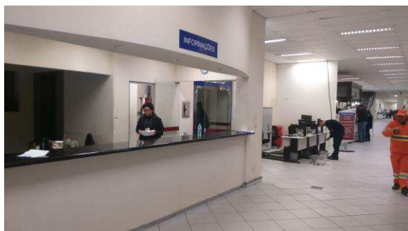
Figura 01c: vista geral portaria antiga - demolida
