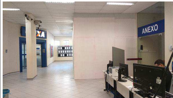
Figura 04c: vista tapume pintado e portaria provisória.
