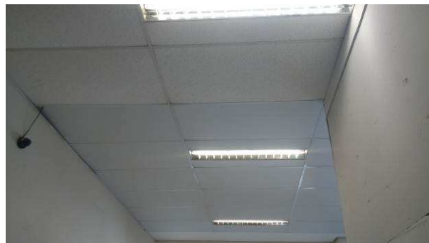
Figura 14c: Vista geral - substituição do forro em gesso acartonado
