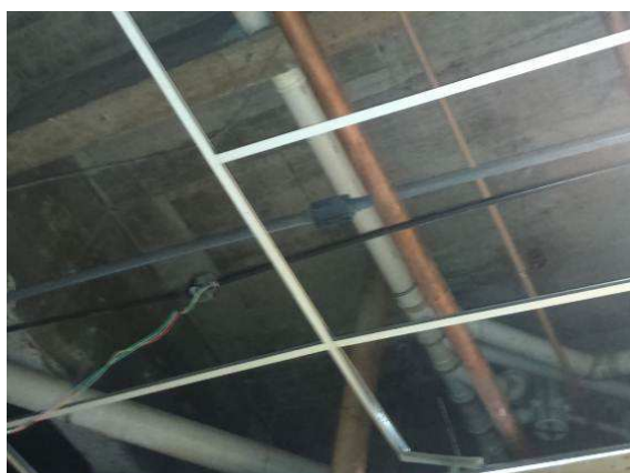
Figura 04E: Eletrodutos e condutores de PVC rígido 32mm (1")
