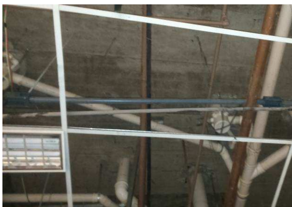
Figura 03E: Eletrodutos e condutores de PVC rígido 32mm (1")
