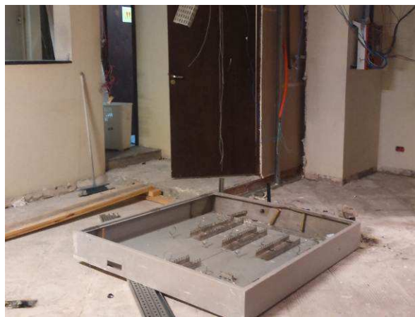
Figura 08E: Retirada do distribuidor geral de telefonia
