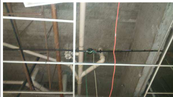
Figura 06c: remoção do forro
