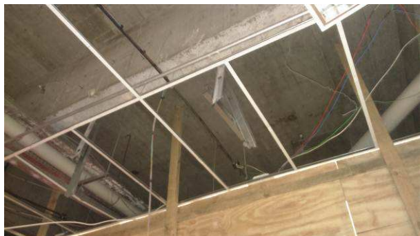
Figura 07c: remoção do forro
