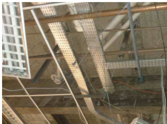
Figura 02E: Remoção parcial de instalações elétricas existentes
