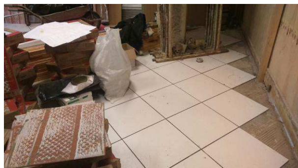
Figura 10c: instalação de piso cerâmico
