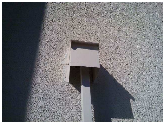
Figura 16C: acabamento tipo calha para proteção dos perfilados.
