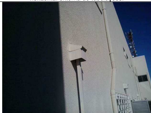
Figura 17C: acabamento tipo calha para proteção dos perfilados.
