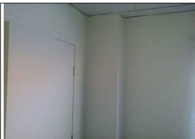
Figura 13C: Acabamento tipo calha para a prumada vertical de tubulações.
