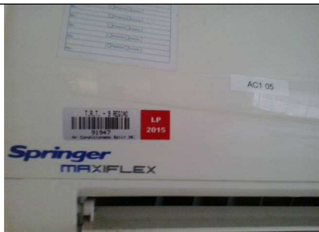
Figura 10C: aparelhos condicionadores de ar - finalização da instalação.
