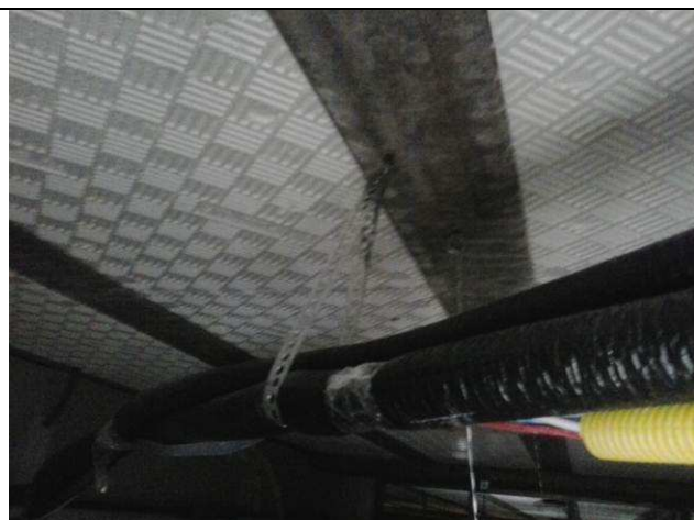
Figura 04C: Rede frigorígena - fixação à laje.
