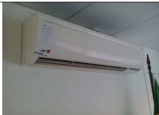
Figura 09C: aparelhos condicionadores de ar - finalização da instalação.
