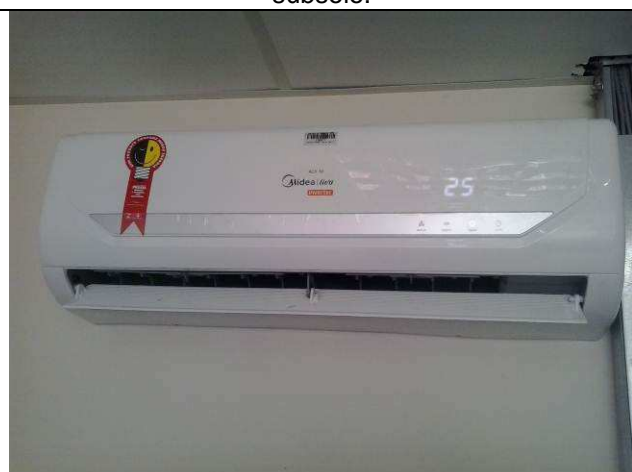
Figura 07C: aparelhos condicionadores de ar - finalização da instalação.
