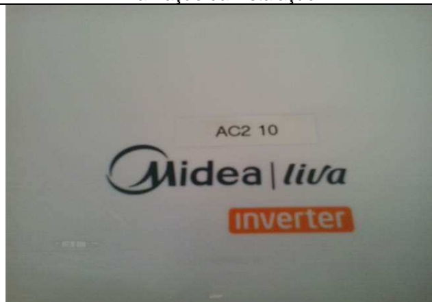
Figura 12C: aparelhos condicionadores de ar - finalização da instalação.
