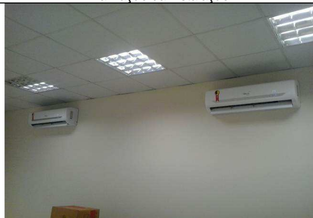
Figura 11C: aparelhos condicionadores de ar - finalização da instalação.
