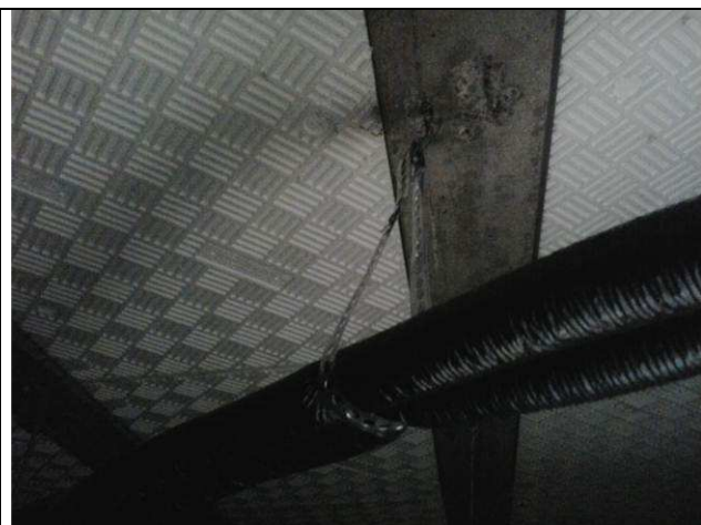
Figura 01C: Rede frigorígena - fixação à laje.
