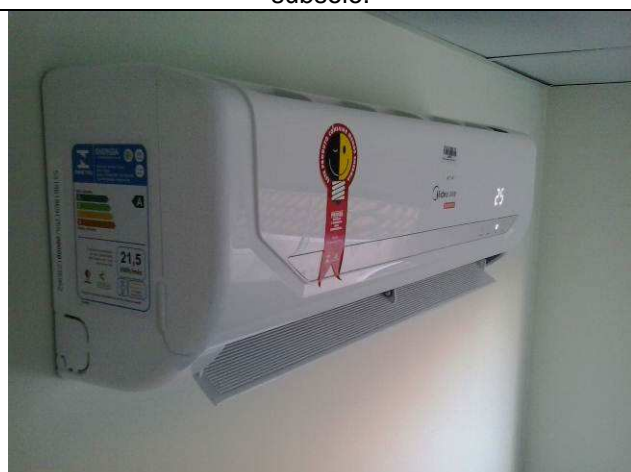
Figura 08C: aparelhos condicionadores de ar - finalização da instalação.
