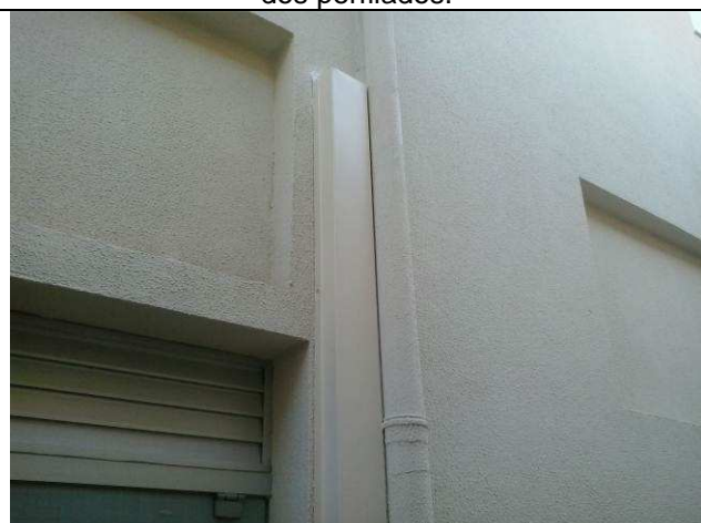
Figura 19C: Acabamento tipo calha para a prumada externa de tubulações.
