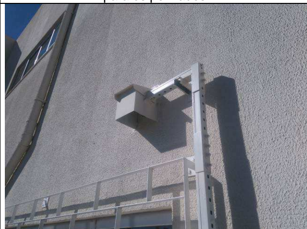
Figura 05E: Acabamento tipo calha na saída externa para os perfilados.
