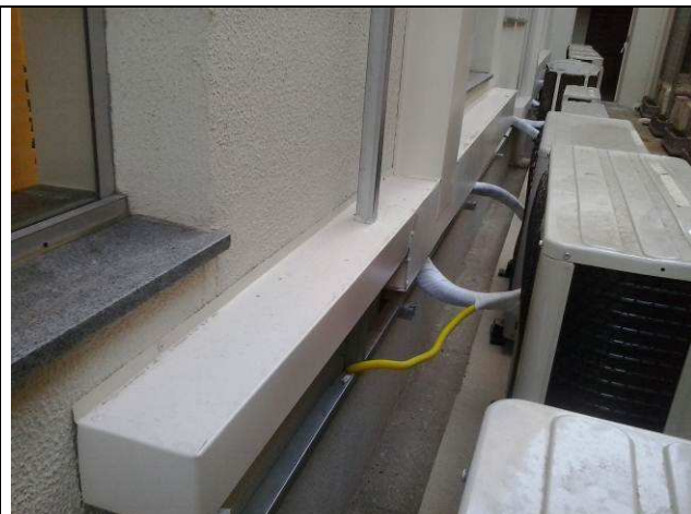
Figura 21C: Acabamento tipo calha para a prumada externa de tubulações.
