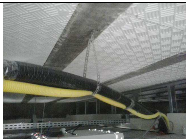
Figura 03C: Rede frigorígena - fixação à laje.
