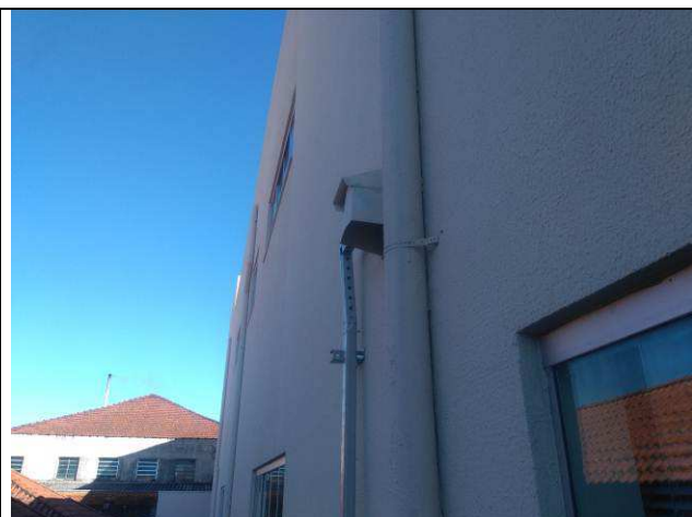
Figura 03E: Acabamento tipo calha na saída externa para os perfilados.
