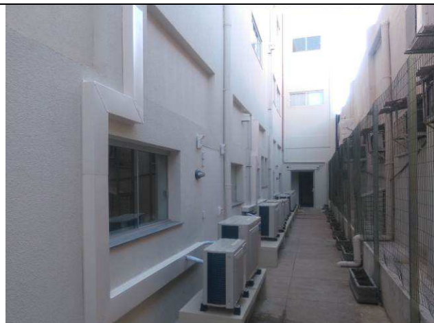
Figura 22C: Acabamento tipo calha para a prumada externa de tubulações.
