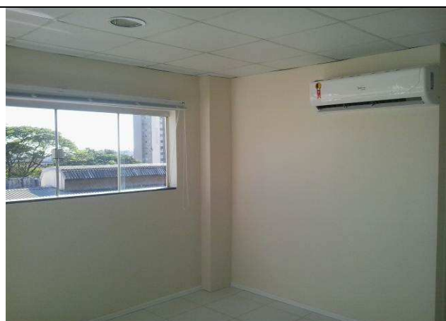
Figura 14C: Acabamento tipo calha para a prumada vertical de tubulações.
