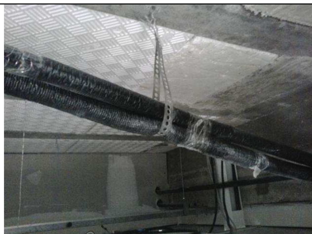
Figura 02C: Rede frigorígena - fixação à laje.
