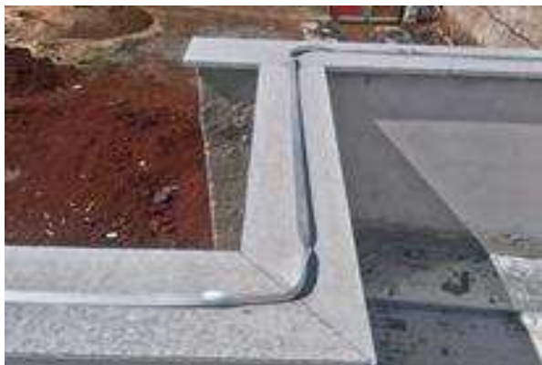
Figura 8 . 7 Capeamento da platibanda e rufo longitudinal, aplicados no prédio principal.
