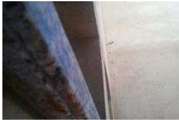
Figura 14 . 4 Detalhe da pingadeira, na face inferior da pedra.
