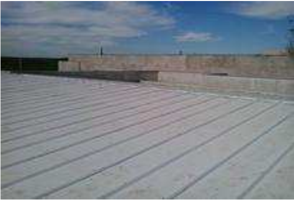
Figura 8 . 1 Detalhe da cobertura em telha sanduíche, instalada no prédio principal.
