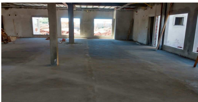
Figura 13 . 5 Imagem panorâmica do contrapiso executado no prédio principal, já com camada de regularização concluída.
