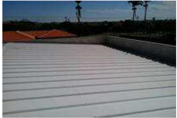
Figura 8 . 2 Detalhe da cobertura em telha sanduíche, instalada no prédio principal.
