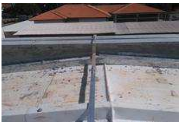
Figura 8 . 9 Rufo longitudinal, aplicado junto ao oitão, no prédio principal.
