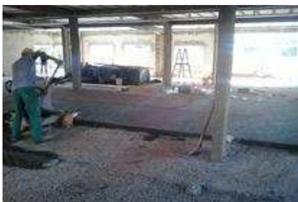
Figura 13 . 1 Operário executando camada de regularização do contrapiso.
