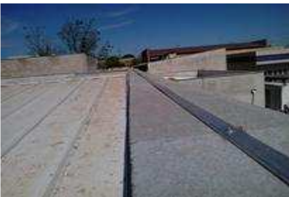
Figura 8 . 5 Capeamento da platibanda do prédio principal.
