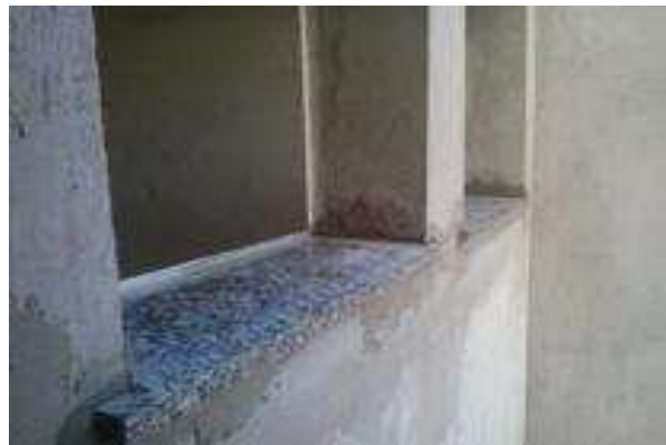
Figura 14 . 6 Detalhe de peitoris instalados nas janelas dos sanitários da secretaria.
