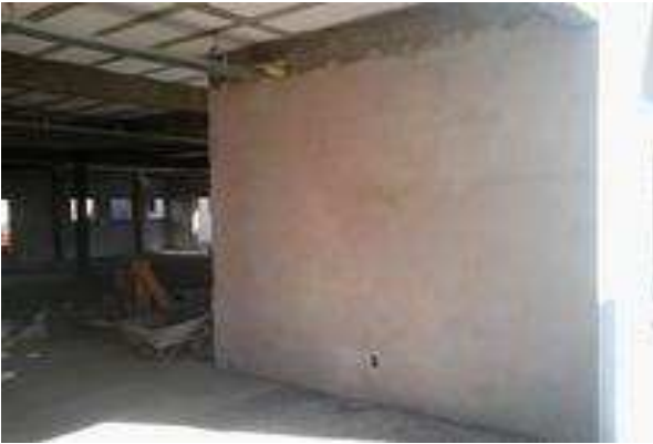
Figura 6 . 1 Parede da sala de pré-acordo, executada nesta etapa.
