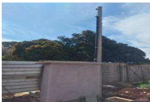
Figura 23 . 4 Entrada de energia elétrica - mureta concluída, caixas de piso, poste, eletrodutos.
