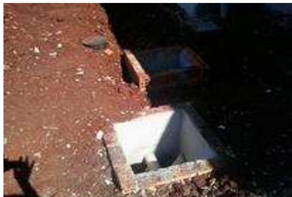
Figura 15 . 4 Caixas de inspeção de esgoto, tamanho 80x80cm.
