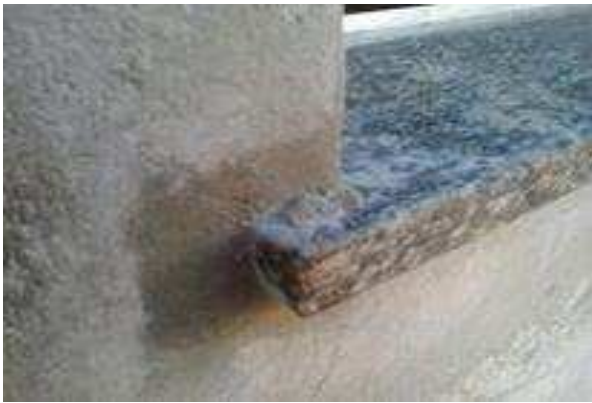
Figura 14 . 3 Detalhe da borda do peitoril, ultrapassando a extensão do vão, aumentando a estanqueidade do conjunto.
