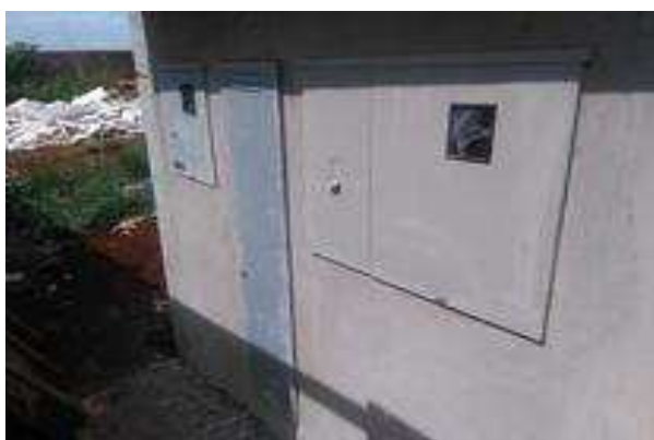
Figura 23 . 1 Entrada de energia elétrica - mureta concluída, caixas e base.
