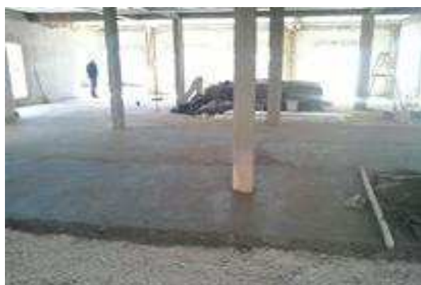
Figura 13 . 2 Camada de regularização do contrapiso sendo executada sobre o contrapiso pronto.
