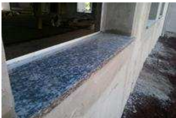
Figura 14 . 1 Peitoril em granito instalado em janelas de 80cm x 80cm.
