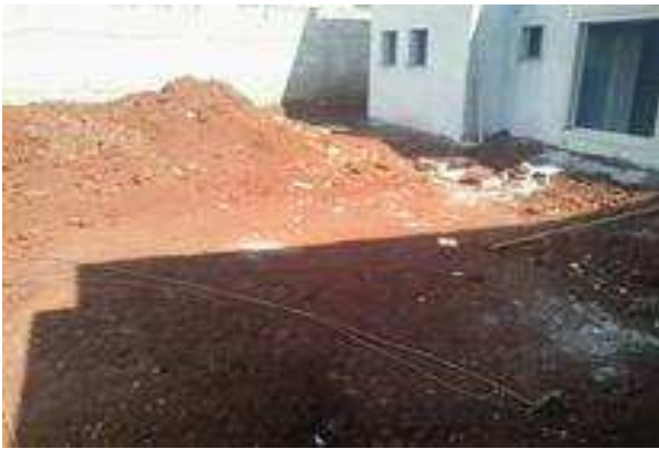
Figura 26 . 1 Valas já reaterradas na lateral esquerda do prédio principal.
