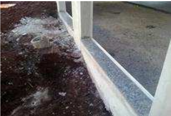
Figura 7 . 1 Contramarco instalado em janela J1 - 180 x 180cm, no prédio principal.
