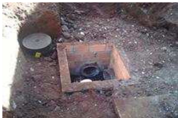
Figura 15 . 2 Caixa de inspeção 60x60cm, pluvial, ainda sem acabamento interno
