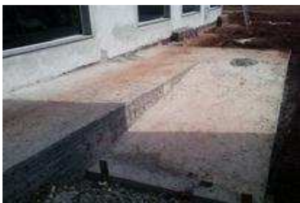
Figura 18 . 1 Rampa de acesso PNE, já com contrapiso executado.
