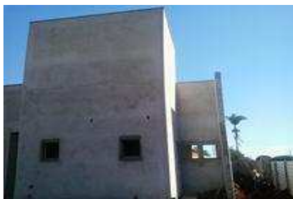
Figura 12 . 2 Rebôco das paredes externas dos sanitários públicos.
