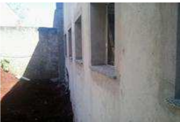
Figura 7 . 3 Contramarcos instalados em janelas de 60 x 60cm.
