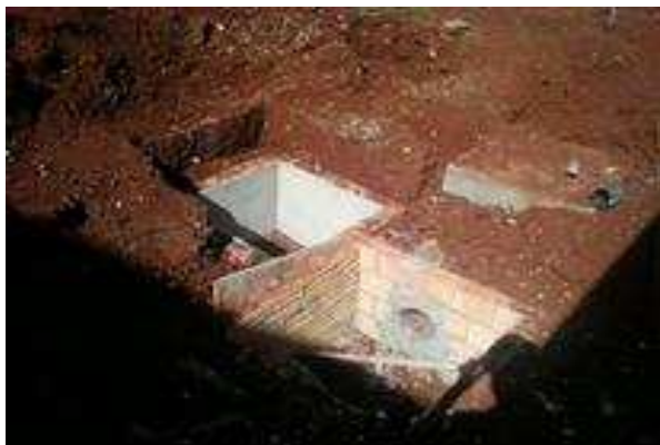
Figura 15 . 3 Caixas de inspeção 80x80cm e 60x60cm, sem acabamento de fundo.
