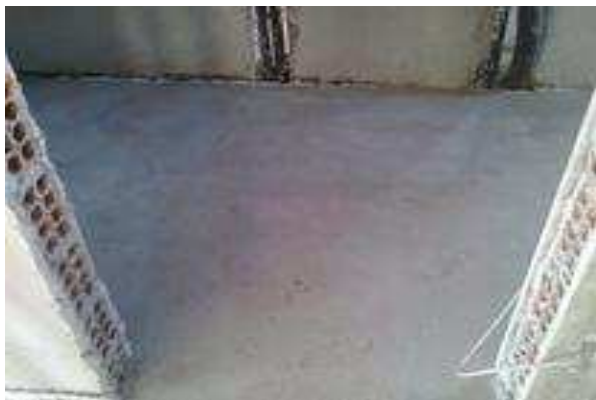
Figura 13 . 3 Contrapiso já regularizado nos sanitários públicos.
