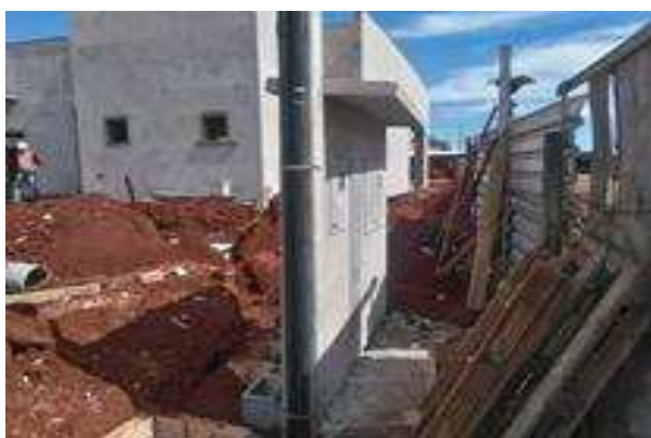
Figura 23 . 3 Entrada de energia elétrica - mureta concluída, caixas, base, poste, eletrodutos de descida.
