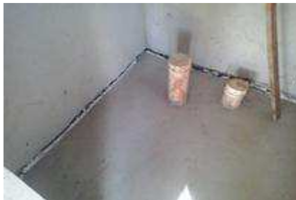
Figura 13 . 4 Contrapiso finalizado (e já regularizado) em sanitário de juiz.
