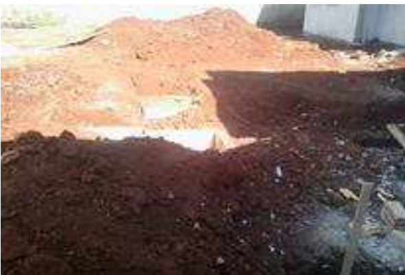
Figura 26 . 3 Valas já reaterradas na lateral esquerda do prédio principal.
