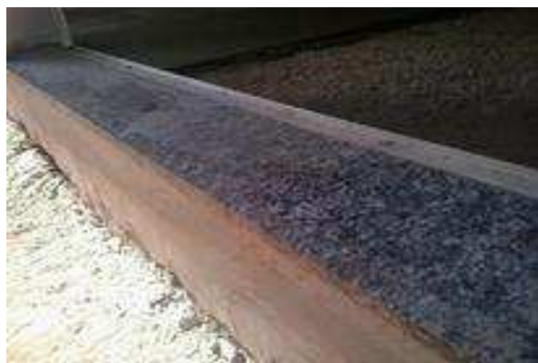
Figura 14 . 2 Peitoril em granito, instalado em janelas de 180cm x 180cm.
