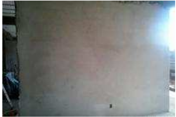
Figura 6 . 2 Parede da sala de pré-acordo, executada nesta etapa.
