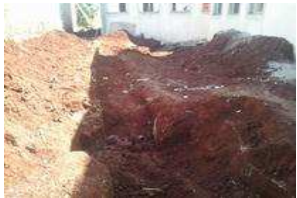
Figura 26 . 4 Valas já reaterradas na parte dos fundos do prédio principal.
