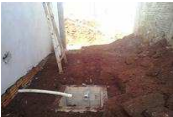
Figura 15 . 1 Caixa de gordura, executada nos fundos da copa.
