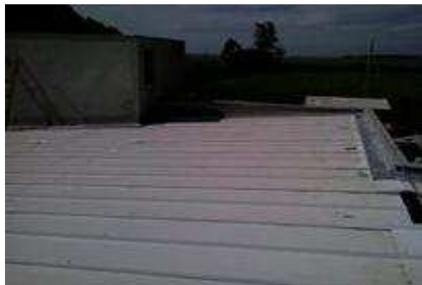
Figura 8 . 8 Telha sanduíche e rufo transversa, aplicados no prédio principal.
