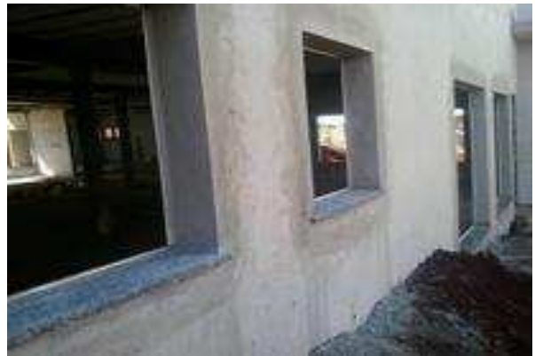
Figura 7 . 2 Contramarcos instalados em janelas 80 x 80cm, nos fundos do prédio principal.
