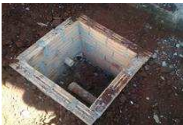
Figura 15 . 5 Caixa de inspeção 60x60cm, de esgoto, ainda sem acabamento interno.
