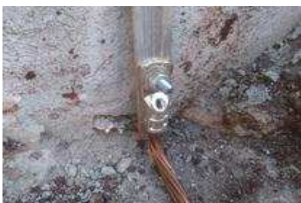
Figura 25 . 3 Malha de aterramento, hastes e caixas de inspeção nos pontos de descida SPDA.
