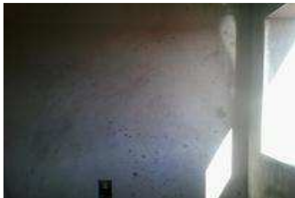
Figura 11 . 4 Rebôco de parede no prédio principal - secretaria.
