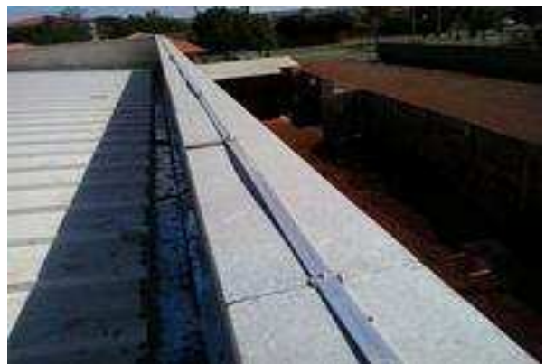
Figura 8 . 6 Capeamento da platibanda do prédio principal.
