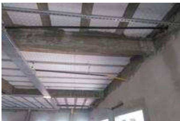
Figura 23 . 11 Eletrodutos rígidos para derivação entre eletrocalhas e parede em alvenaria.
