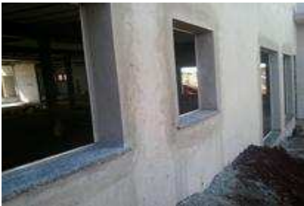
Figura 14 . 5 Peitoris em granito, instalados em esquadrias do prédio principal.
