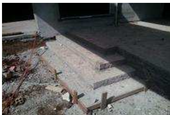
Figura 18 . 2 Detalhe da escada de acesso ao hall, na entrada principal.
