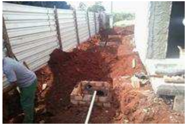
Figura 26 . 2 Valas já reaterradas na porção esquerda da parte frontal do imóvel.
