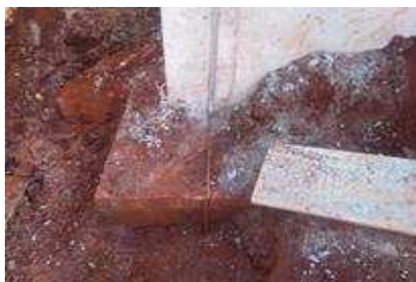
Figura 25 . 2 Malha de aterramento, hastes e caixas de inspeção nos pontos de descida SPDA.
