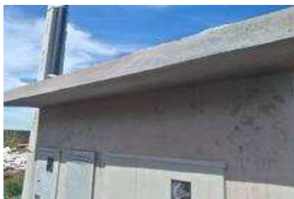
Figura 23 . 2 Entrada de energia elétrica - mureta concluída, caixas e cobertura.
