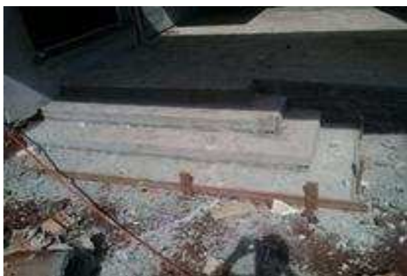
Figura 18 . 3 Escada de acesso principal, com degraus já concretados.
