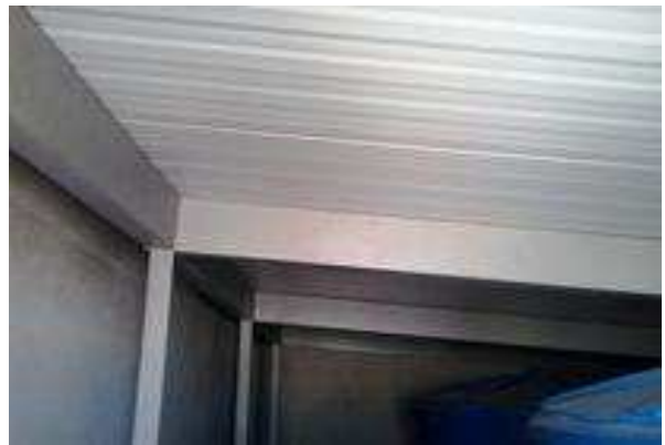
Figura 8 . 4 Detalhe da cobertura do reservatório, vista por baixo.
