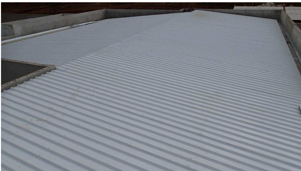
Figura 4 – Vista externa - cobertura.
