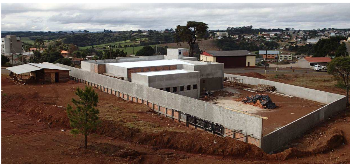
Figura 1 – Vista externa geral.
