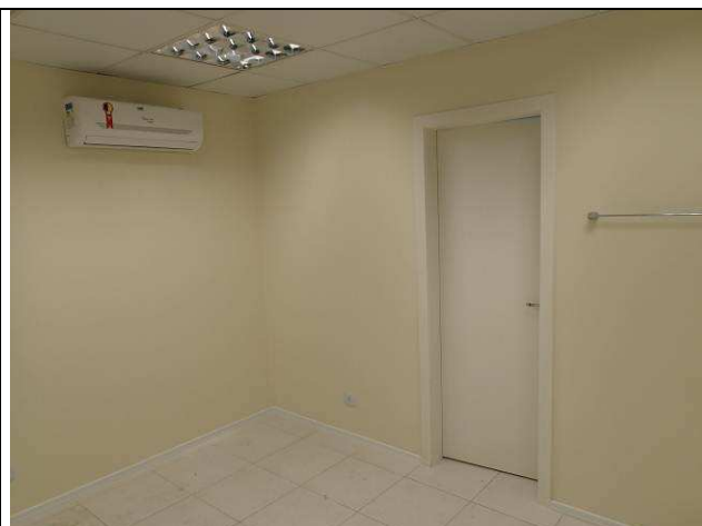
Figura 14C: Evaporadora 12.000 BTU's - sala de perícia - térreo.
