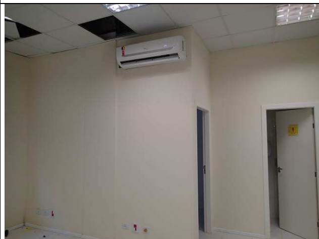
Figura 10C: Evaporadora 22.000 BTU's - distribuição - térreo.
