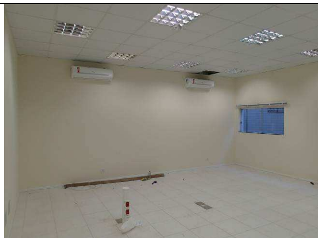
Figura 11C: Evaporadoras 22.000 BTU's - sala múltiplo uso - térreo.
