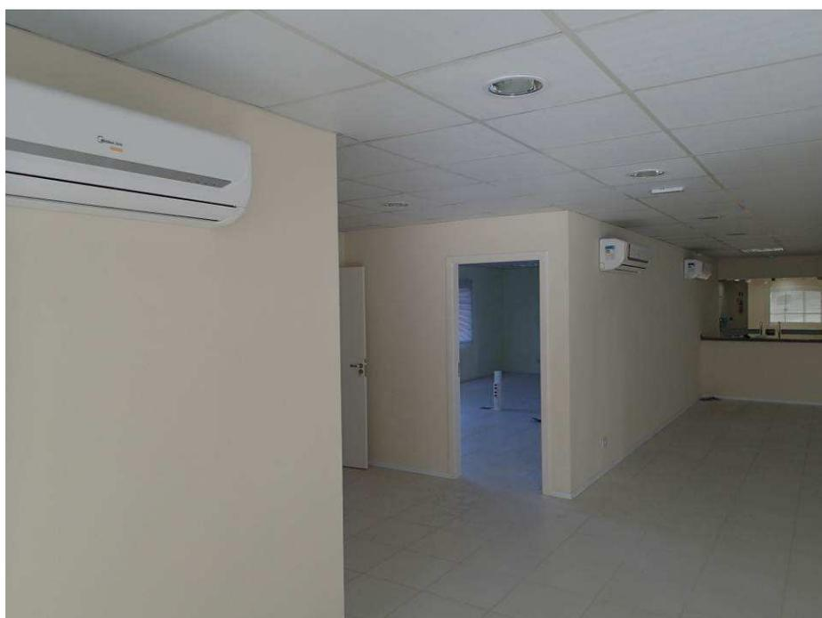
Figura 2 – Vista interna - evaporadoras.
