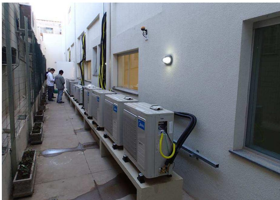
Figura 1 – Vista externa - condensadoras e redes frigoríferas.
