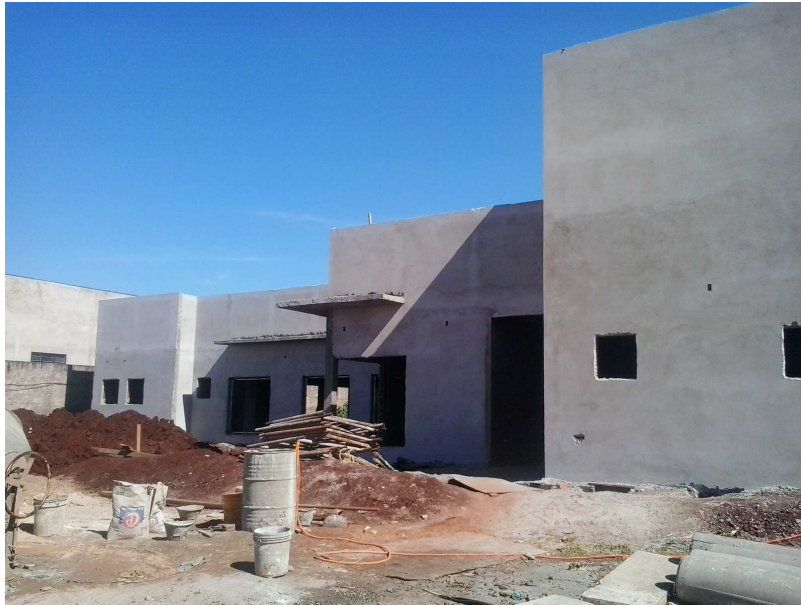
Figura 1 – Vista do canteiro de obras
