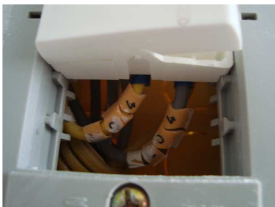
Figura 4 - Identificação de condutores, tomadas e interruptores
