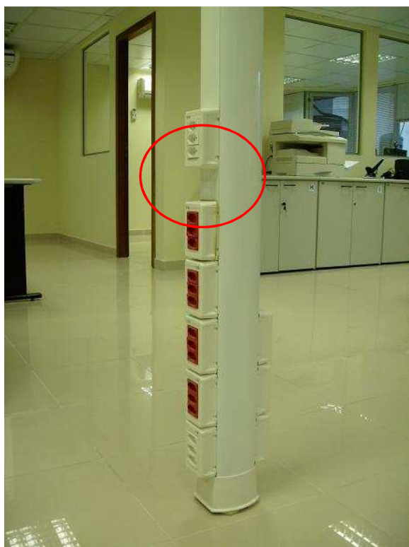
Figura 5 – Poste técnico (Observar interrupção dos porta equipamentos para encaixe da mesa)
