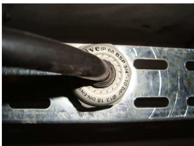
Figura 8 – Derivação para luminárias (prensa-cabo e plug)
