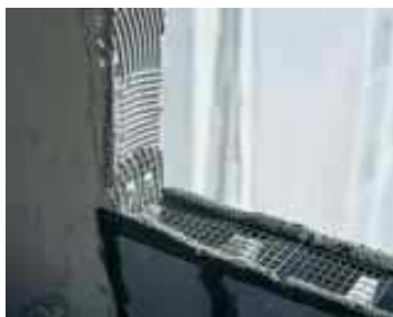
Ligação da Estrutura com a Alvenaria
