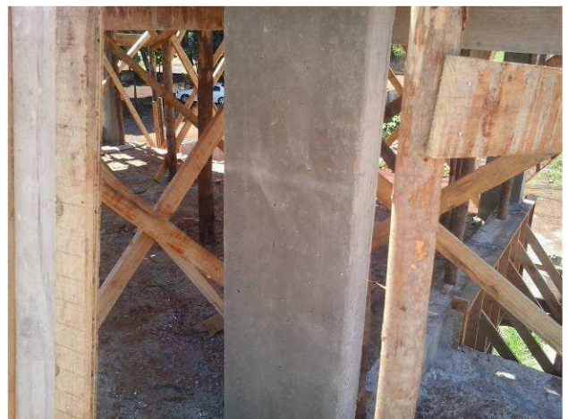
Figura 08C: Pilar do barrilete, já concretado
