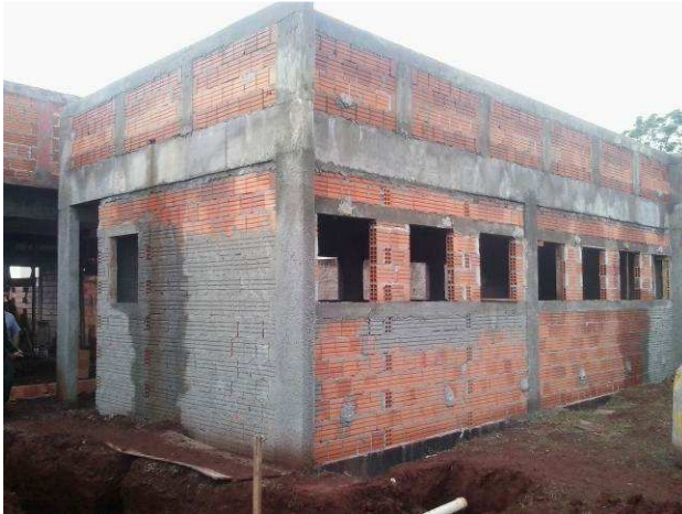
Figura 21C: Alvenaria de tijolos, aplicada nas paredes externas do arquivo
