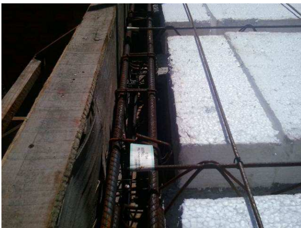
Figura 07C: Preparo das vigas do reservatório
