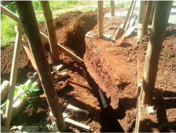
Figura 03C: Abertura de vala para execução da rede de esgoto externa
