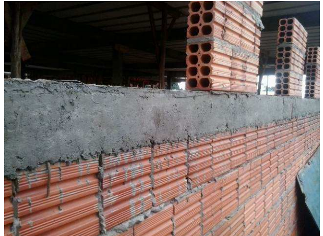
Figura 16C: Contravergas aplicadas em janelas do prédio principal - fundos
