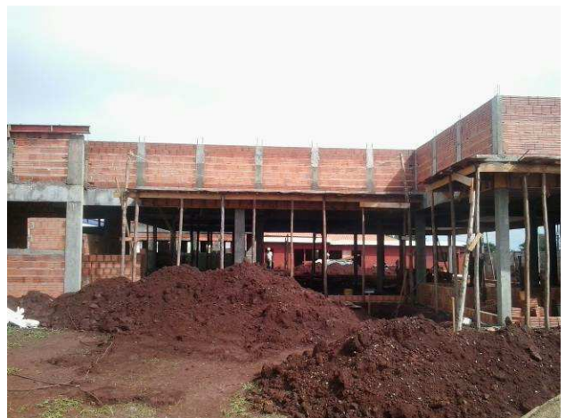
Figura 14C: Pilaretes de travamento da platibanda do prédio principal - lateral esquerda
