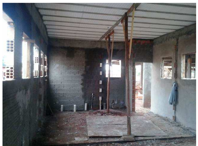
Figura 32C: Aplicação de chapisco na face interna das paredes externas do arquivo
