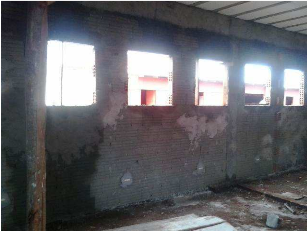
Figura 33C: Aplicação de chapisco na face interna das paredes externas do arquivo
