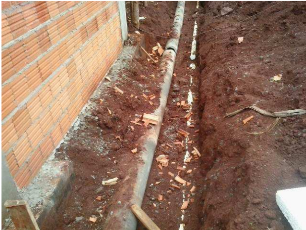
Figura 42C: Tubo de concreto para drenagem pluvial (ligação das caixas - 200mm)
