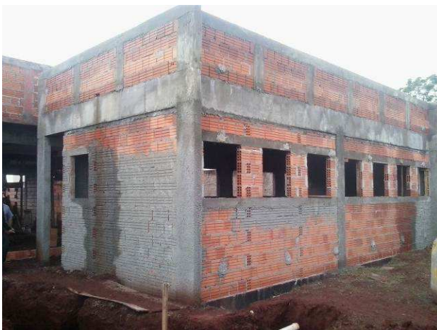
Figura 25C: Alvenaria de tijolos, aplicada na platibanda do prédio do arquivo
