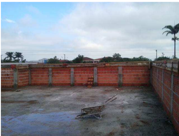
Figura 13C: Pilaretes e cintas de travamento da platibanda do prédio principal- lateral direita e frontal
