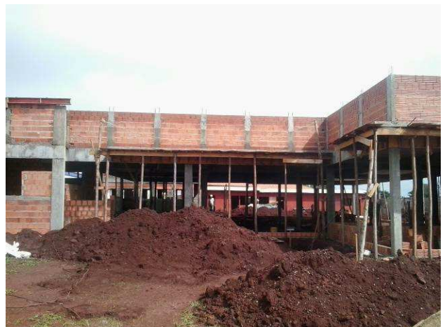
Figura 24C: Alvenaria de tijolos, aplicada na platibanda do prédio principal
