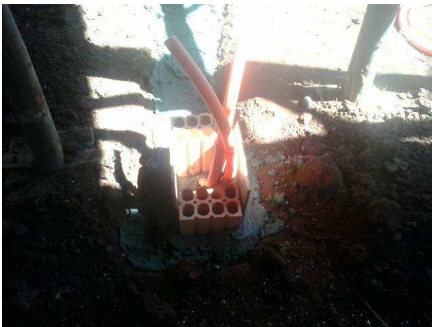
Figura 05E: Eletrodutos corrugados de 1", instalados no piso de sala de audiência
