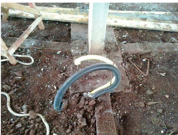
Figura 01E: Eletrodutos corrugados instalados no piso
