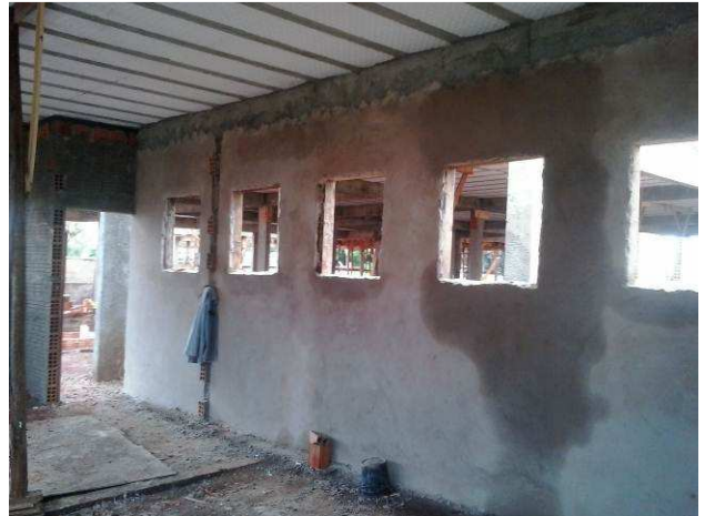
Figura 34C: Aplicação de reboco na face interna de um pano de parede externa do arquivo
