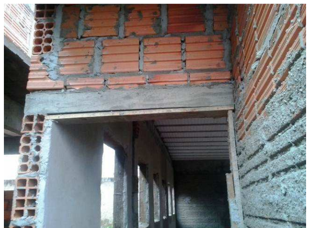
Figura 20C: Verga aplicada em porta do arquivo
