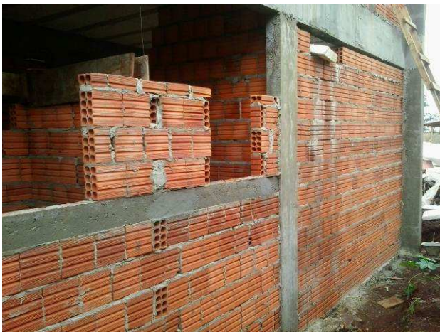
Figura 17C: contraverga aplicada em janela do prédio principal - banheiros da secretaria
