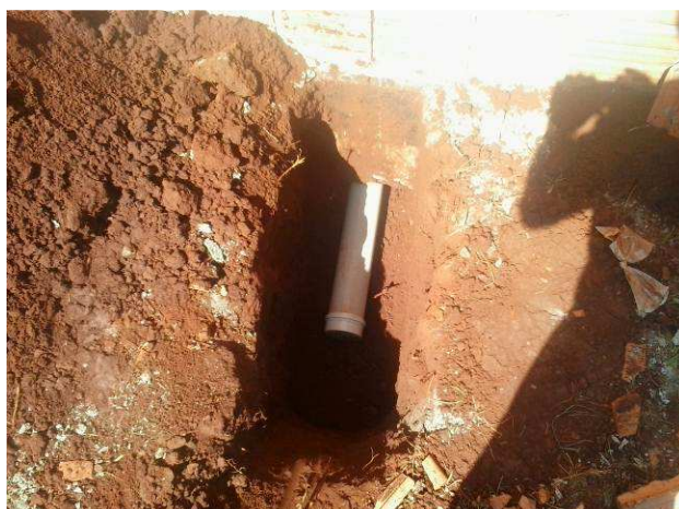
Figura 02C: Abertura de vala para execução de esgoto predial, no imóvel do arquivo
