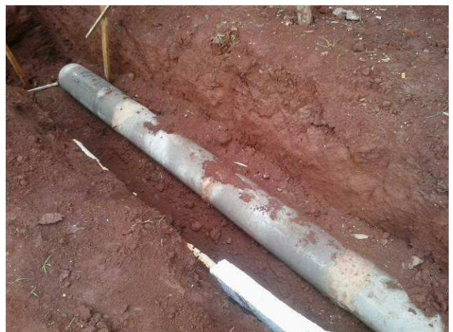
Figura 41C: Tubo de concreto para drenagem pluvial (ligação das caixas - 200mm)
