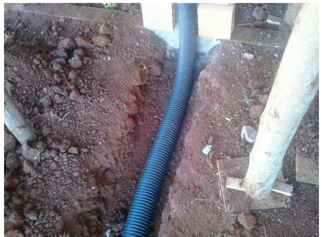
Figura 06E: Eletroduto corrugado de 3", instalado na ligação do QDG a primeira caixa de passagem (entrada de energia)
