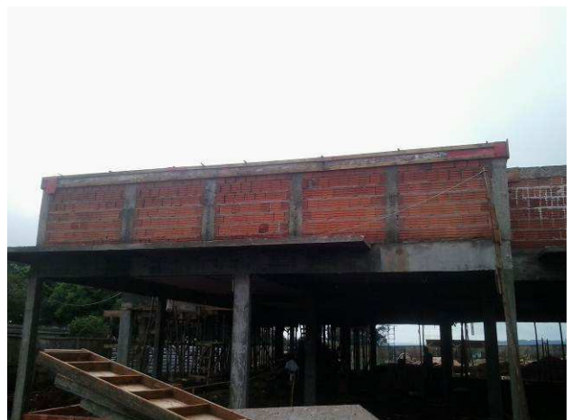
Figura 26C: Alvenaria de tijolos, aplicada na platibanda do prédio principal - lateral direita
