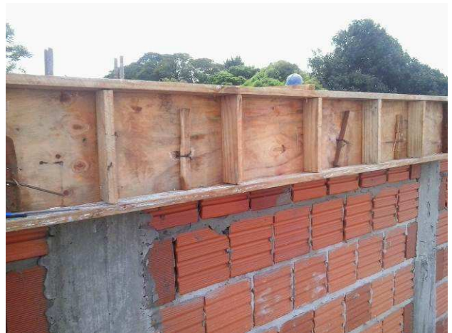
Figura 12C: Fôrma de cinta de amarração da platibanda no prédio principal
