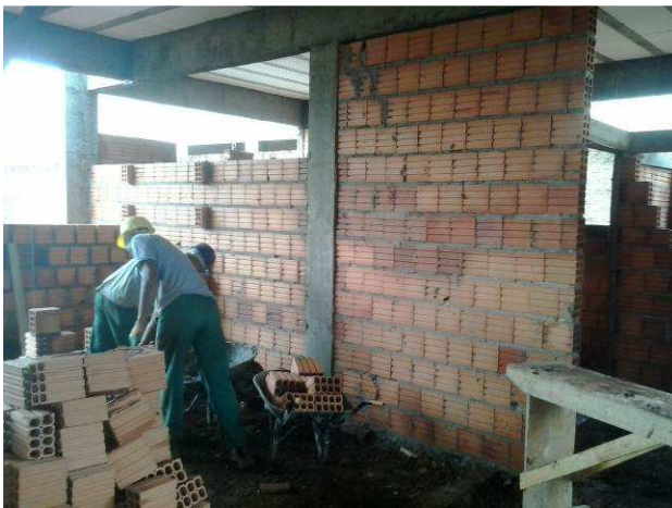
Figura 29C: Trabalhadores assentando parede interna da copa - prédio principal
