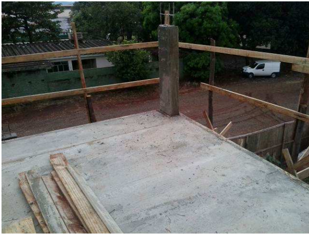
Figura 09C: Pilar, vigas e laje do reservatório, após concretagem
