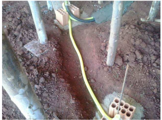
Figura 04E: Eletroduto corrugado de 1", instalado no piso de sala de audiência
