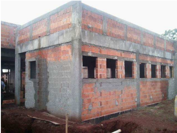
Figura 15C: Prédio do arquivo, com todas as cintas e pilaretes de travamento da platibanda executados
