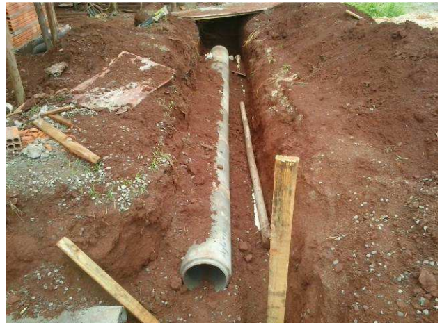
Figura 45C: Tubo de concreto para drenagem pluvial (ligação das caixas - 300mm)
