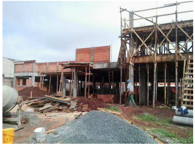
Figura 10C: Detalhe de fôrmas e escoramento da laje e vigas do reservatório
