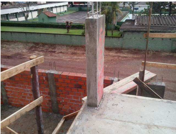
Figura 05C: Pilar executado no reservatório
