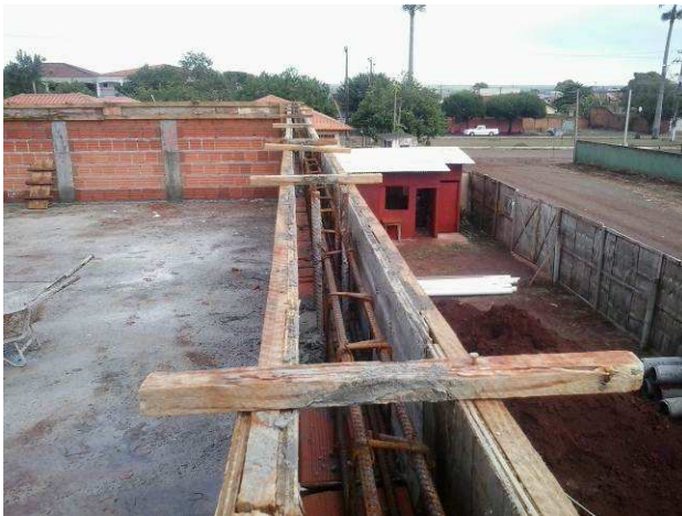
Figura 11C: Fôrma de cinta de amarração da platibanda no prédio principal
