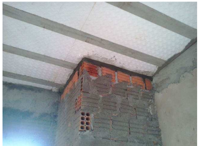
Figura 30C: Detalhe do encunhamento de parede interna
