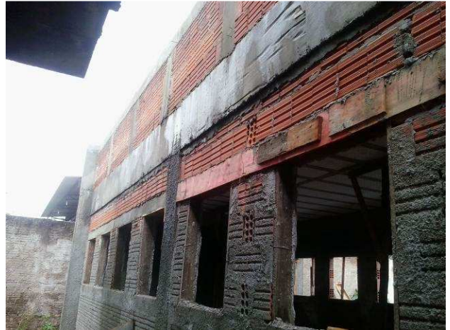
Figura 22C: Alvenaria de tijolos, aplicada nas paredes externas do arquivo
