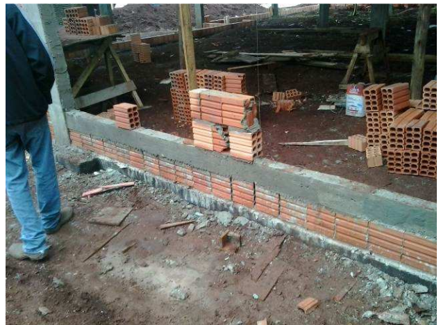
Figura 18C: Contraverga aplicada em janela do prédio principal - fundos
