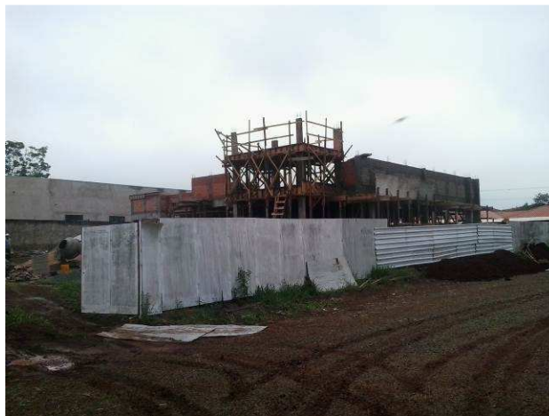
Figura 35C: Aplicação de chapisco na platibanda frontal do imóvel
