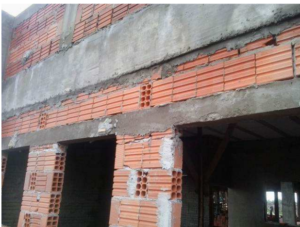
Figura 19C: Vergas aplicadas sobre janelas do arquivo
