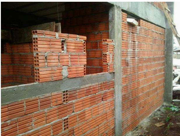
Figura 23C: Alvenaria de tijolos, aplicada em parede externa do prédio principal - banheiros da secretaria e copa
