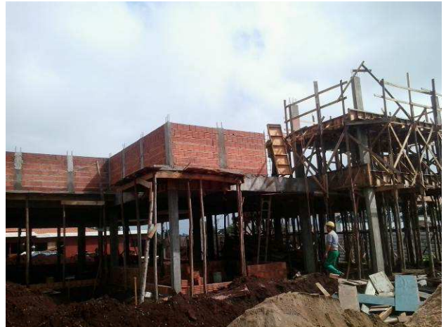
Figura 28C: Alvenaria de tijolos, aplicada na platibanda do prédio principal - lateral esquerda
