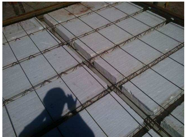
Figura 06C: Preparo da laje do fundo do reservatório
