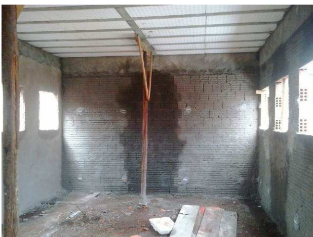
Figura 31C: Aplicação de chapisco na face interna das paredes externas do arquivo
