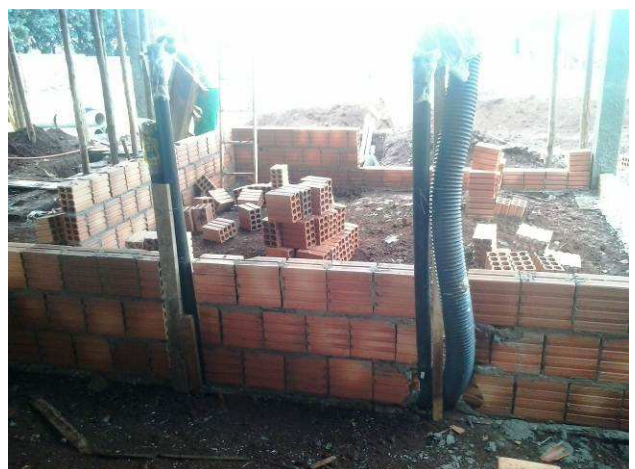
Figura 02E: Eletroduto de 3" chegando ao local em que será instalado o QDG, após reaterro de vala
