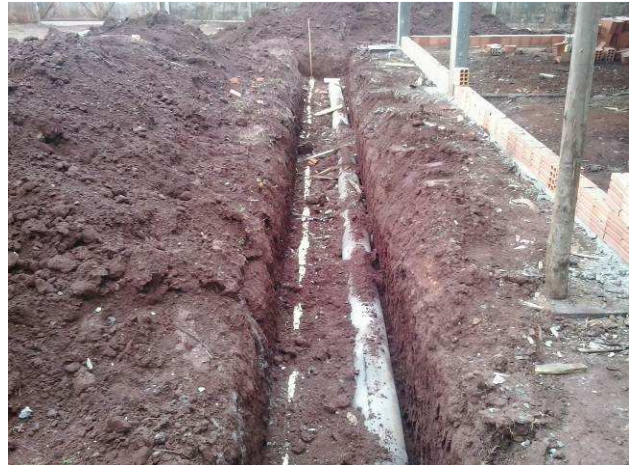
Figura 43C: Tubo de concreto para drenagem pluvial (ligação das caixas - 300mm)
