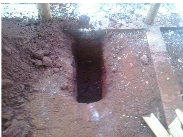
Figura 01C: Abertura de vala para execução de esgoto predial, no imóvel principal
