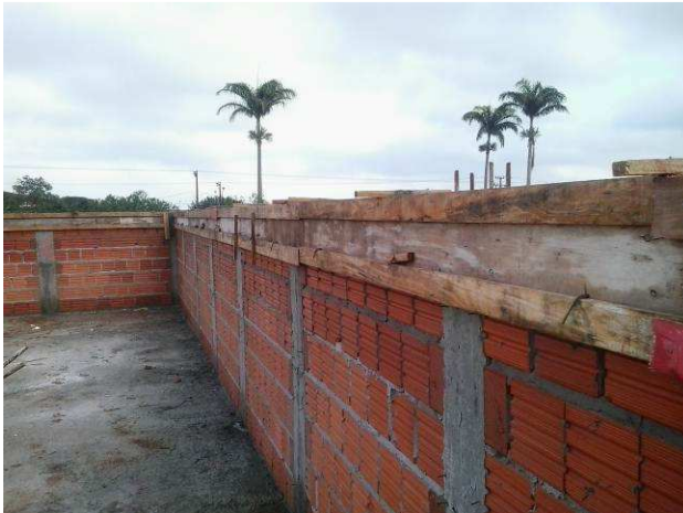
Figura 27C: Alvenaria de tijolos, aplicada na platibanda do prédio principal - fachada frontal
