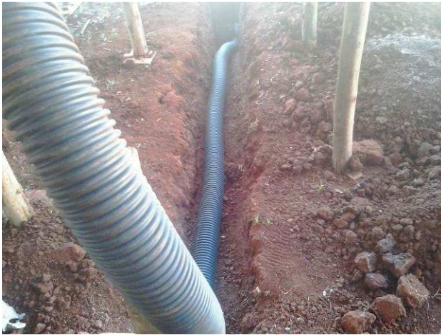
Figura 03E: Eletroduto corrugado de 3", instalado na ligação do QDG a primeira caixa de passagem (entrada de energia)
