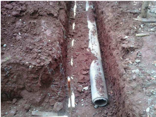
Figura 44C: Tubo de concreto para drenagem pluvial (ligação das caixas - 200mm)
