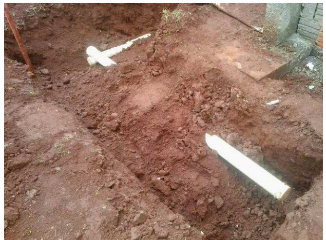
Figura 39C: Tubulação de PVC 100mm, instalada na ligação as caixas de inspeção
