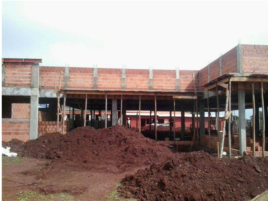
Figura 1 – Vista do canteiro de obras
