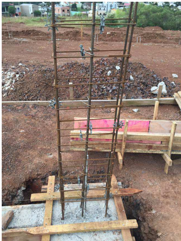
Figura 39C: Armaduras com espaçadores de 3 cm - pilares.
