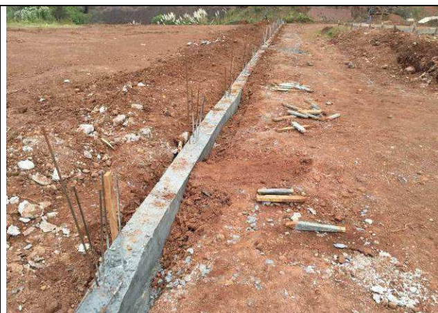
Figura 54C: Viga baldrame concretada - muro de fechamento lado esquerdo.
