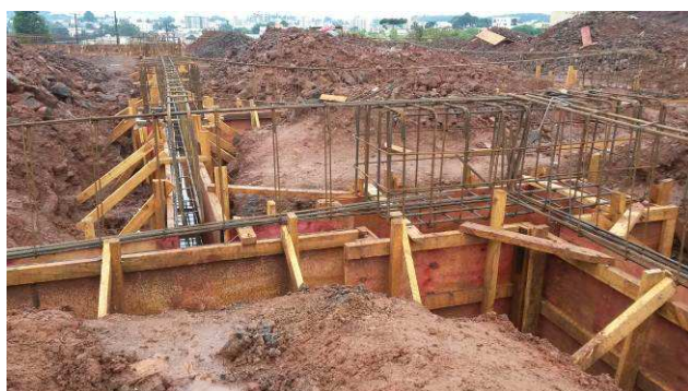
Figura 19C: Formas e armaduras - blocos e vigas baldrames.
