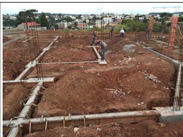
Figura 28C: Infra-estrutura concretada - blocos e vigas baldrames.
