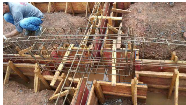
Figura 12C: Formas e armaduras - blocos e vigas baldrames.
