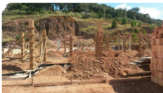
Figura 41C: Formas montadas.
