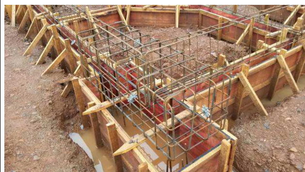
Figura 14C: Formas e armaduras - blocos e vigas baldrames.
