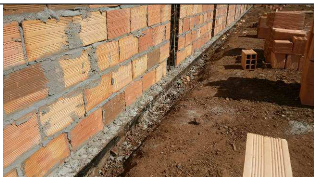
Figura 48C: Impermeabilização dos baldrames do muro com tinta betuminosa.
