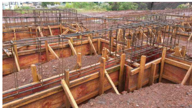
Figura 21C: Formas e armaduras - blocos e vigas baldrames.
