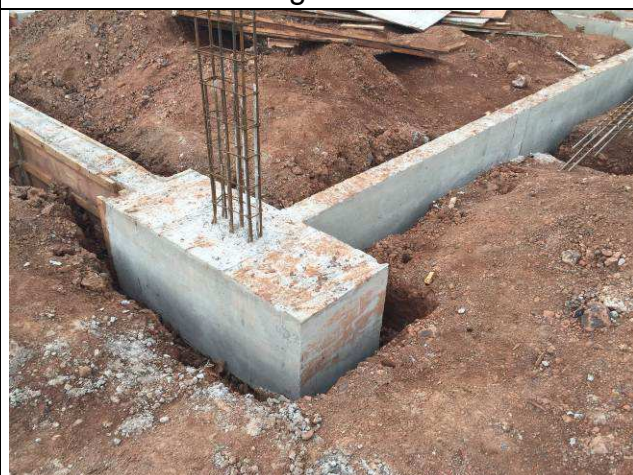
Figura 31C: Infra-estrutura concretada - blocos e vigas baldrames.
