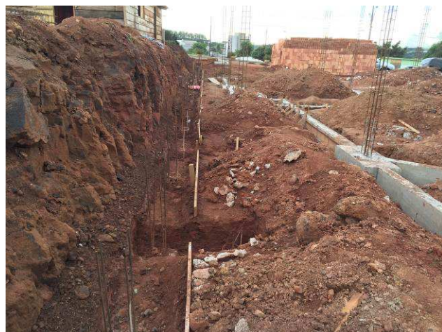
Figura 65C: Estacas concretadas e escavação da viga baldrame e blocos - muro de arrimo.
