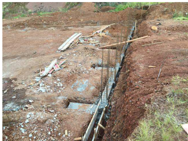
Figura 67C: Viga baldrame e blocos concretados - muro de arrimo.
