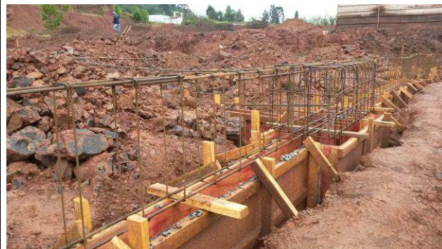
Figura 22C: Formas e armaduras - blocos e vigas baldrames.
