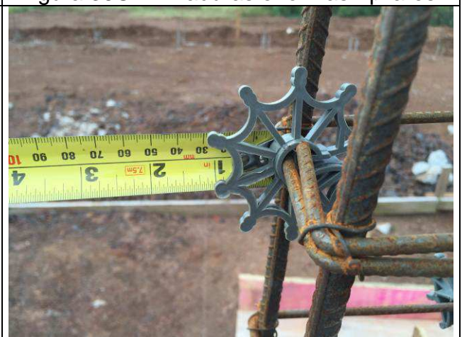
Figura 38C: Armaduras com espaçadores de 3 cm - pilares.
