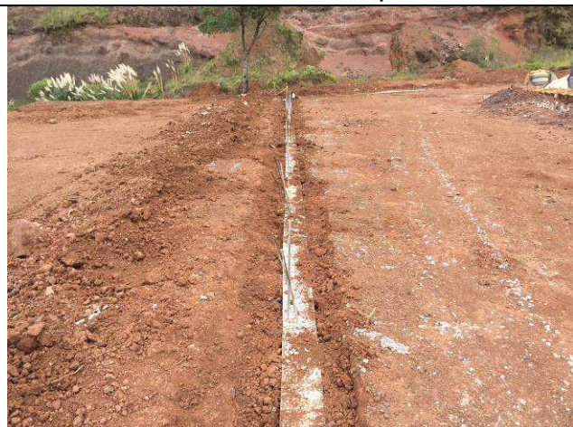
Figura 55C: Viga baldrame concretada - muro de fechamento lado esquerdo.
