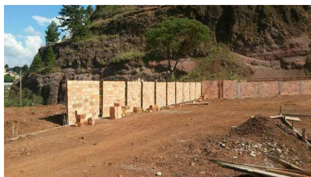
Figura 62C: Alvenaria executada - muro de fechamento lateral e fundos.
