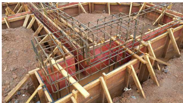
Figura 11C: Formas e armaduras - blocos e vigas baldrames.
