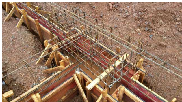
Figura 15C: Formas e armaduras - blocos e vigas baldrames.
