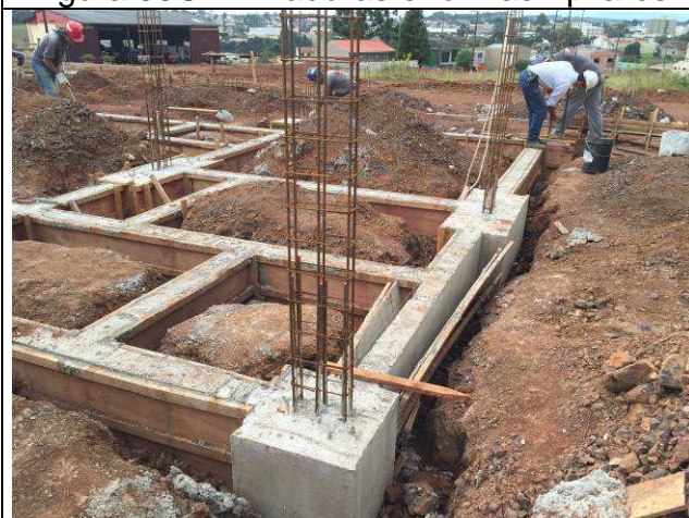
Figura 37C: Armaduras - pilares.
