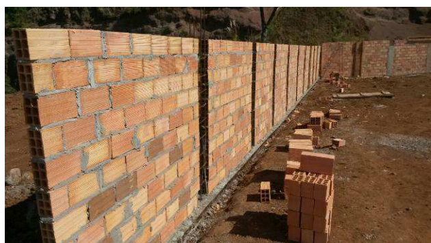
Figura 63C: Alvenaria executada - muro de fechamento lateral.
