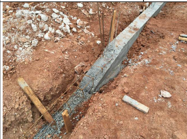
Figura 56C: Viga baldrame concretada - muro de fechamento lado esquerdo.
