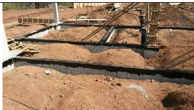
Figura 46C: Impermeabilização da infraestrutura com tinta betuminosa.
