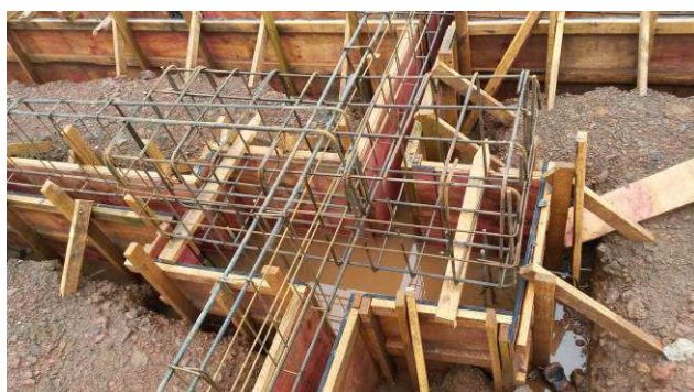
Figura 13C: Formas e armaduras - blocos e vigas baldrames.
