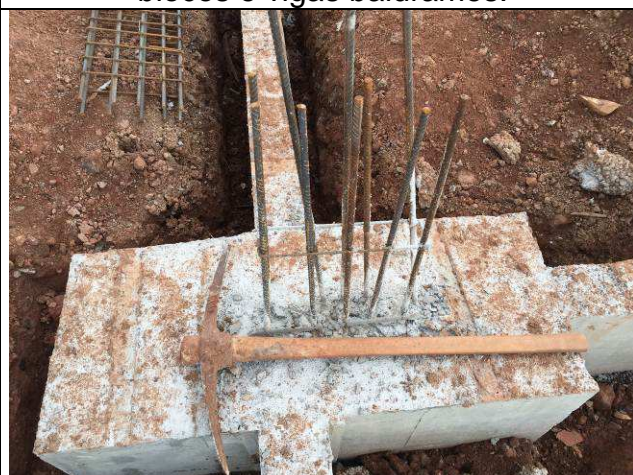
Figura 32C: Infra-estrutura concretada - blocos e vigas baldrames.
