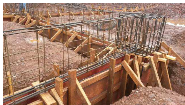
Figura 20C: Formas e armaduras - blocos e vigas baldrames.
