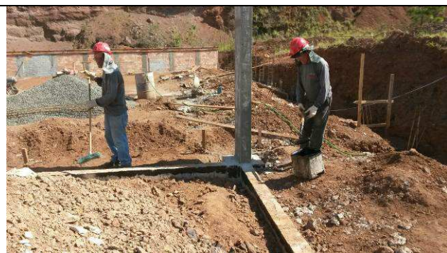
Figura 45C: Impermeabilização da infraestrutura com tinta betuminosa.
