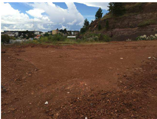
Figura 01C: Movimento de terra no lado esquerdo do terreno.
