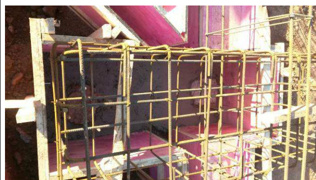
Figura 08C: Formas e armaduras - blocos e vigas baldrames.
