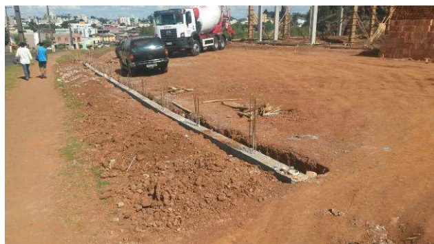
Figura 51C: Viga baldrame concretada - gradil frontal.
