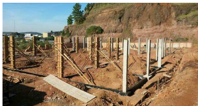
Figura 44C: Pilares concretados.
