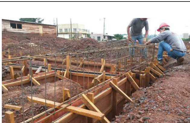
Figura 17C: Formas e armaduras - blocos e vigas baldrames.
