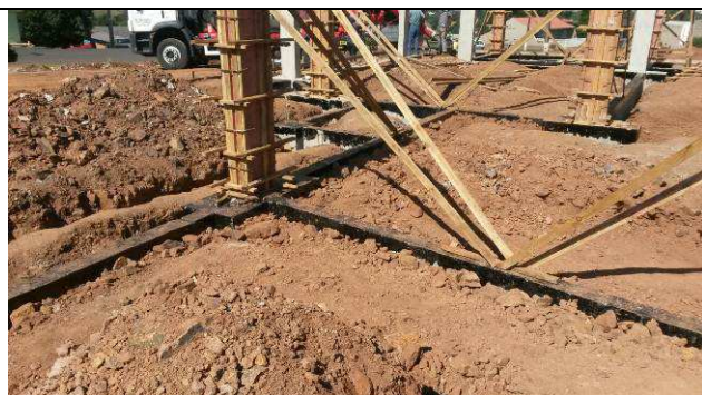
Figura 47C: Impermeabilização da infraestrutura com tinta betuminosa.
