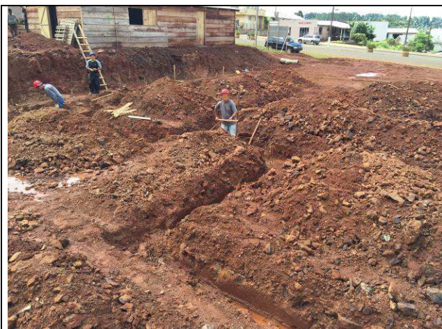
Figura 03C: Escavação de valas para blocos e vigas baldrames.
