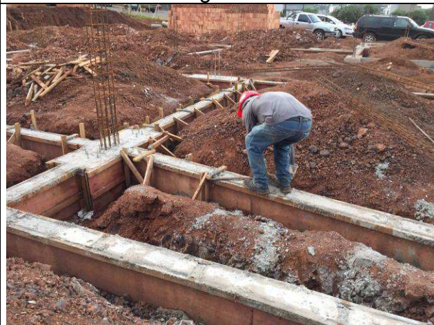
Figura 26C: Infra-estrutura concretada - blocos e vigas baldrames.
