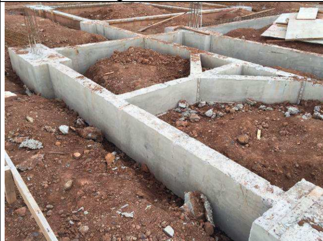
Figura 24C: Infra-estrutura concretada - blocos e vigas baldrames.
