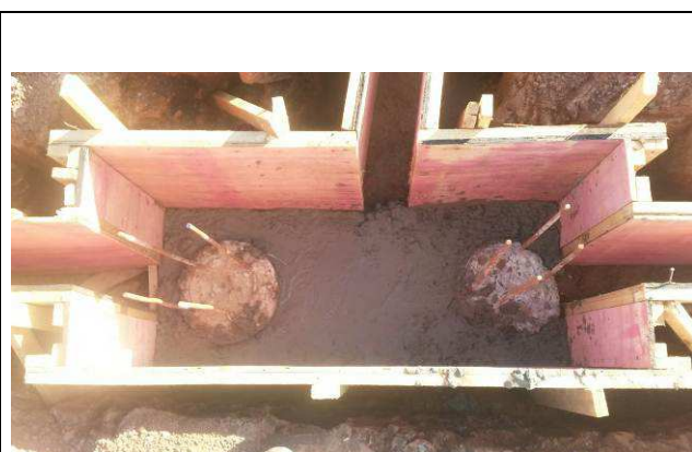
Figura 06C: Lastro de concreto e formas - blocos.
