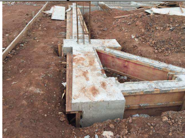
Figura 23C: Infra-estrutura concretada - blocos e vigas baldrames.
