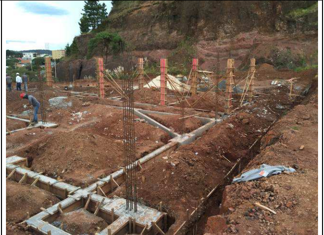
Figura 34C: Armaduras - pilares.
