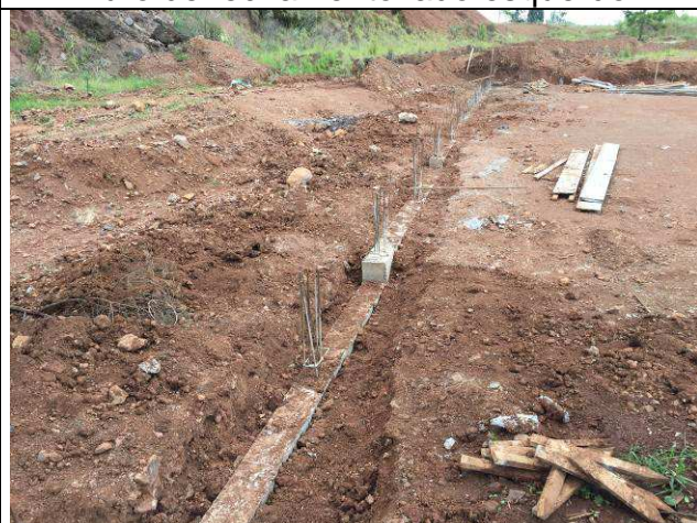
Figura 58C: Viga baldrame concretada - muro de fechamento fundos.
