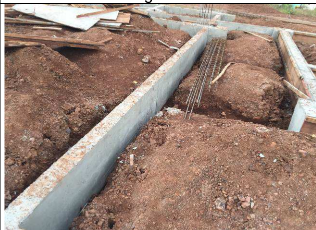
Figura 29C: Infra-estrutura concretada - blocos e vigas baldrames.
