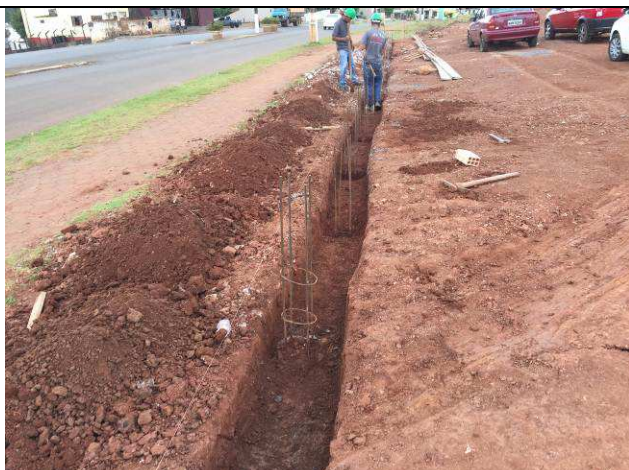
Figura 50C: Estacas concretadas e escavação da viga baldrame - gradil frontal.
