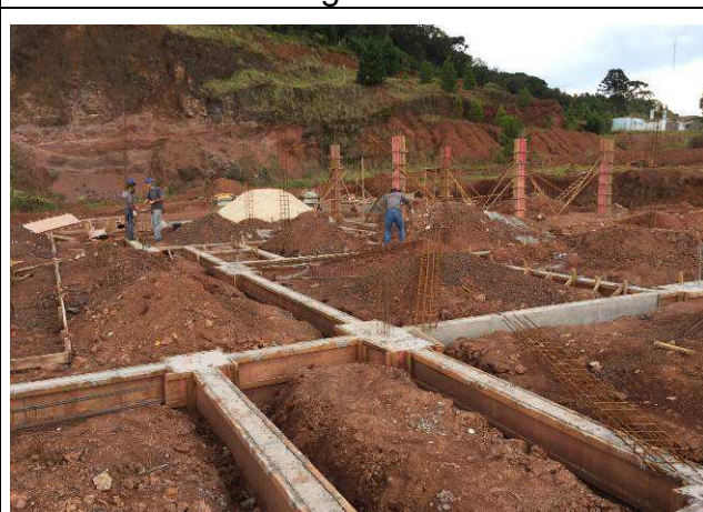
Figura 30C: Infra-estrutura concretada - blocos e vigas baldrames.
