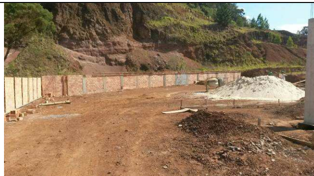
Figura 60C: Alvenaria executada - muro de fechamento fundos.
