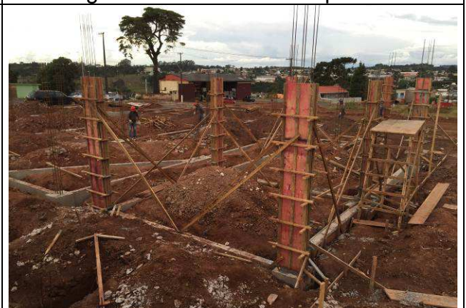
Figura 36C: Armaduras e formas - pilares.
