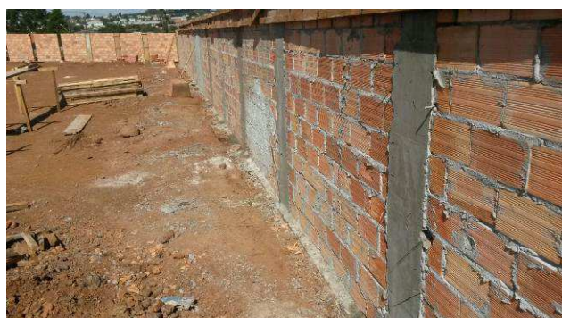
Figura 61C: Alvenaria executada - muro de fechamento fundos.
