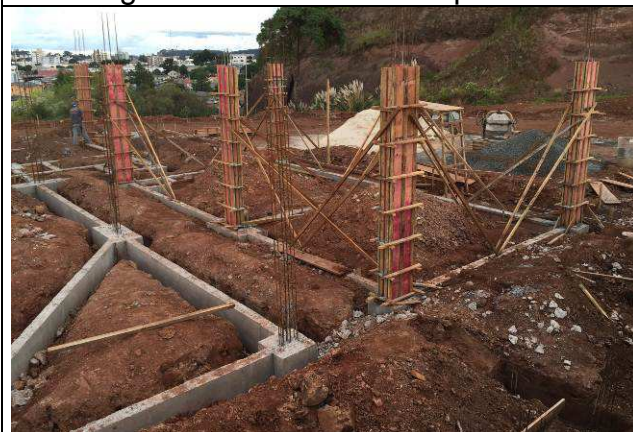
Figura 35C: Armaduras e formas - pilares.
