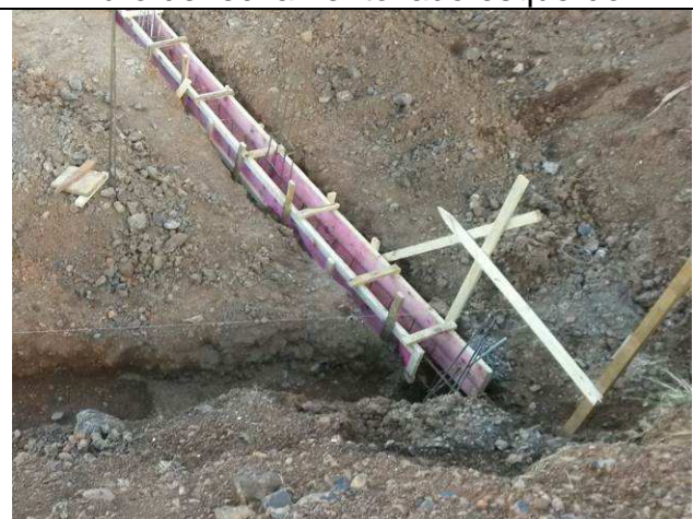
Figura 57C: Formas da viga baldrame - muro de fechamento fundos.
