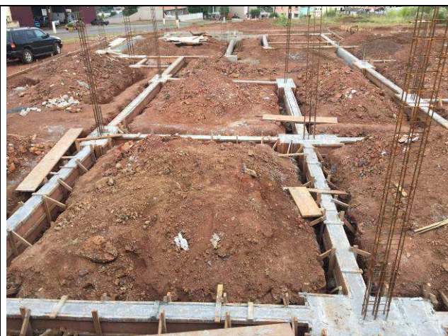
Figura 27C: Infra-estrutura concretada - blocos e vigas baldrames.
