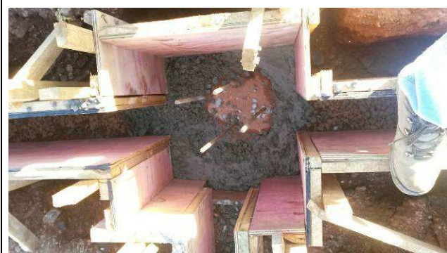
Figura 07C: Lastro de concreto e formas - blocos.
