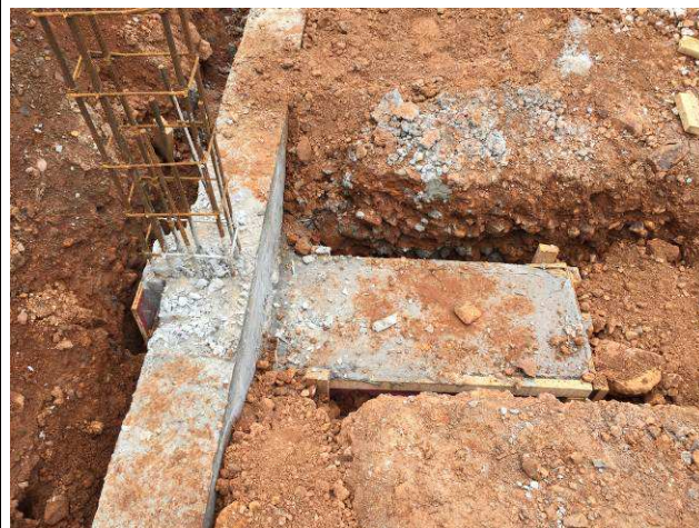
Figura 68C: Viga baldrame e blocos concretados - muro de arrimo.
