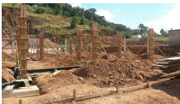
Figura 42C: Montagem das formas - pilares.
