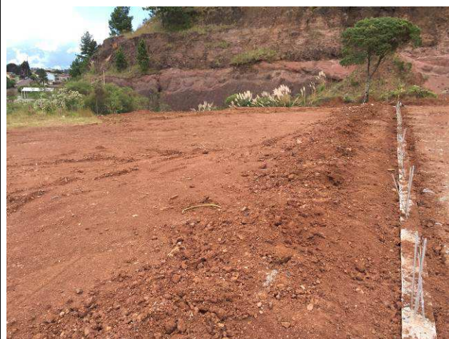
Figura 02C: Movimento de terra no lado esquerdo do terreno.
