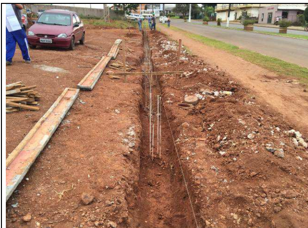
Figura 49C: Estacas concretadas e escavação da viga baldrame - gradil frontal.
