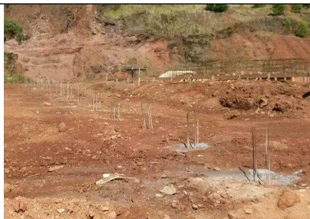
Figura 53C: Estacas concretadas - muro de fechamento lado esquerdo.
