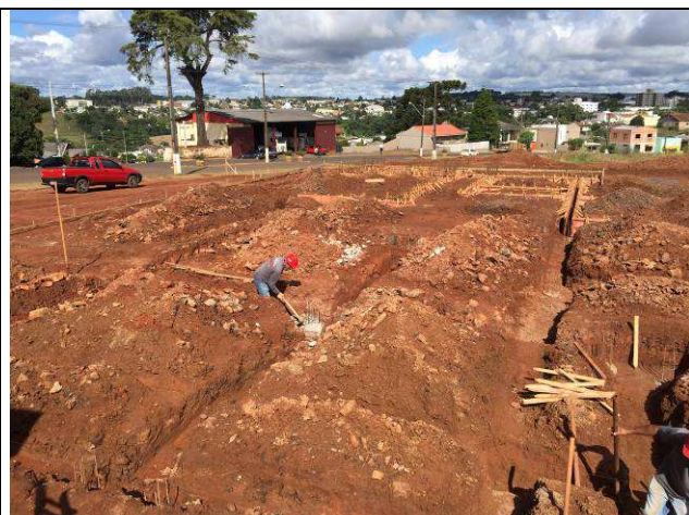
Figura 04C: Escavação de valas para blocos e vigas baldrames.
