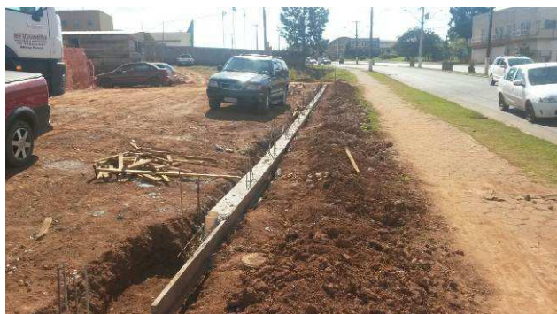
Figura 52C: Viga baldrame concretada - gradil frontal.
