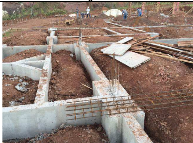
Figura 25C: Infra-estrutura concretada - blocos e vigas baldrames.
