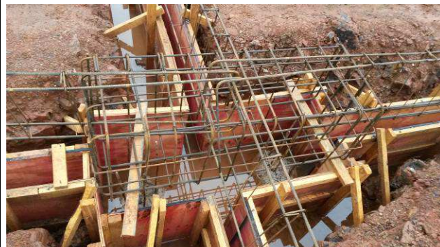
Figura 10C: Formas e armaduras - blocos e vigas baldrames.
