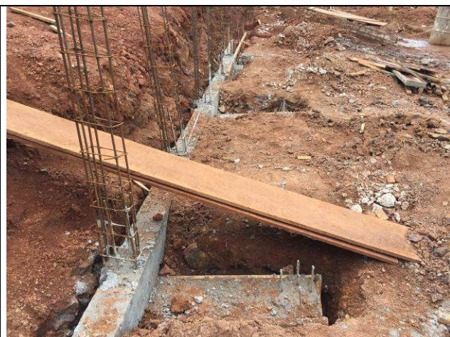
Figura 69C: Viga baldrame e blocos concretados - muro de arrimo.
