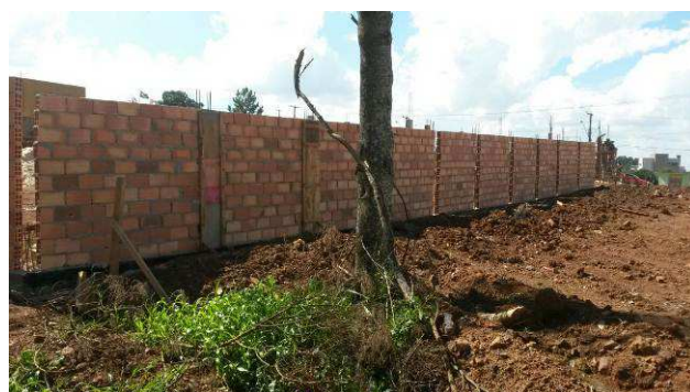
Figura 64C: Alvenaria executada - muro de fechamento lateral.
