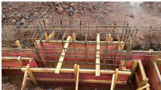
Figura 09C: Formas e armaduras - blocos e vigas baldrames.
