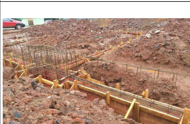
Figura 18C: Formas e armaduras - blocos e vigas baldrames.
