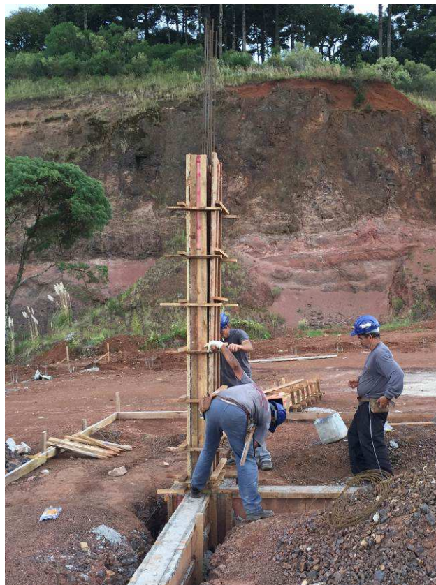
Figura 40C: Montagem das formas - pilares.
