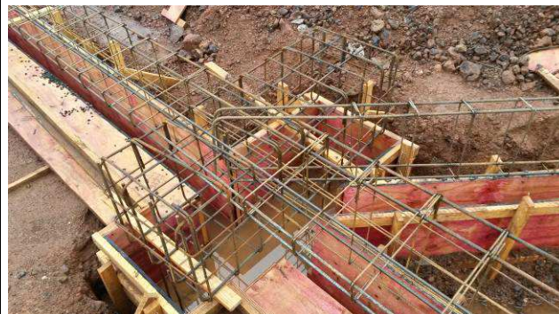
Figura 16C: Formas e armaduras - blocos e vigas baldrames.
