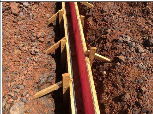
Figura 44C: Formas - blocos e vigas baldrame.
