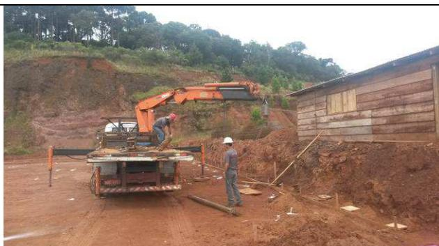
Figura 55C: Muro de arrimo - Escavação das estacas - perfuratriz.
