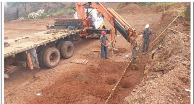
Figura 56C: Muro de arrimo - Escavação das estacas - perfuratriz.
