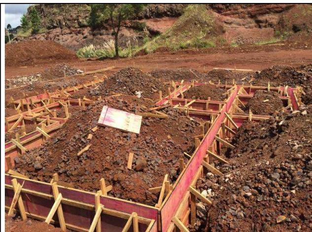
Figura 46C: Formas - blocos e vigas baldrame.
