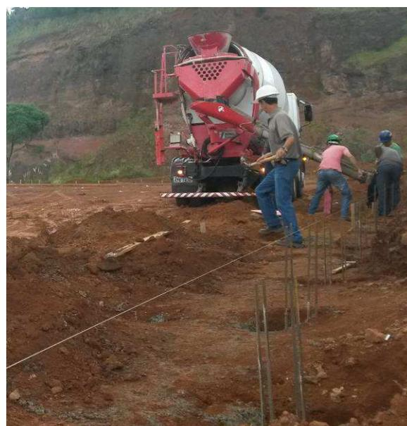
Figura 58C: Muro de arrimo - Concretagem das estacas.
