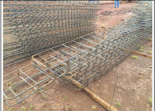
Figura 52C: Armaduras - vigas baldrames.
