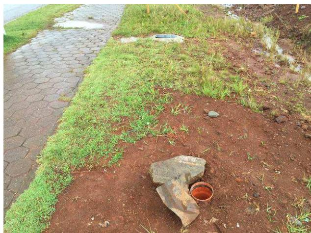
**Figura 01C: Ligação de esgoto.**
