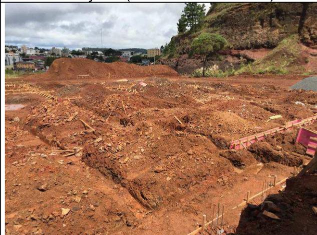
Figura 22C: Abertura de valas para fundações (blocos e baldrames).
