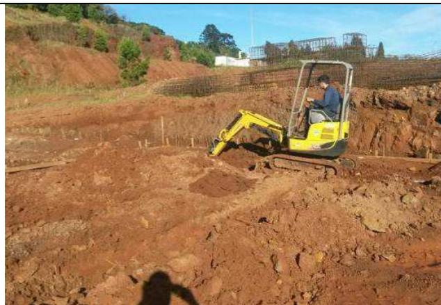
Figura 19C: Abertura de valas para fundações (blocos e baldrames).
