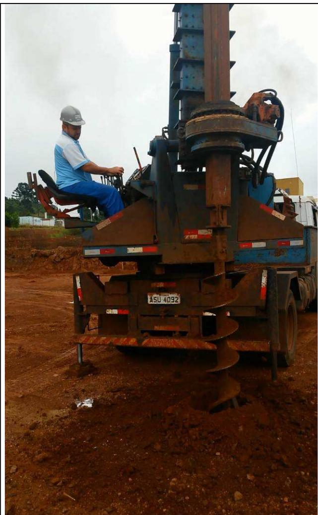
Figura 30C: Escavação das estacas.
