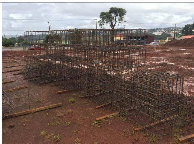
Figura 49C: Armaduras - blocos.
