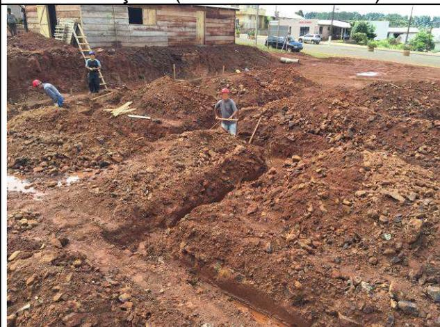
Figura 24C: Abertura de valas para fundações (blocos e baldrames).
