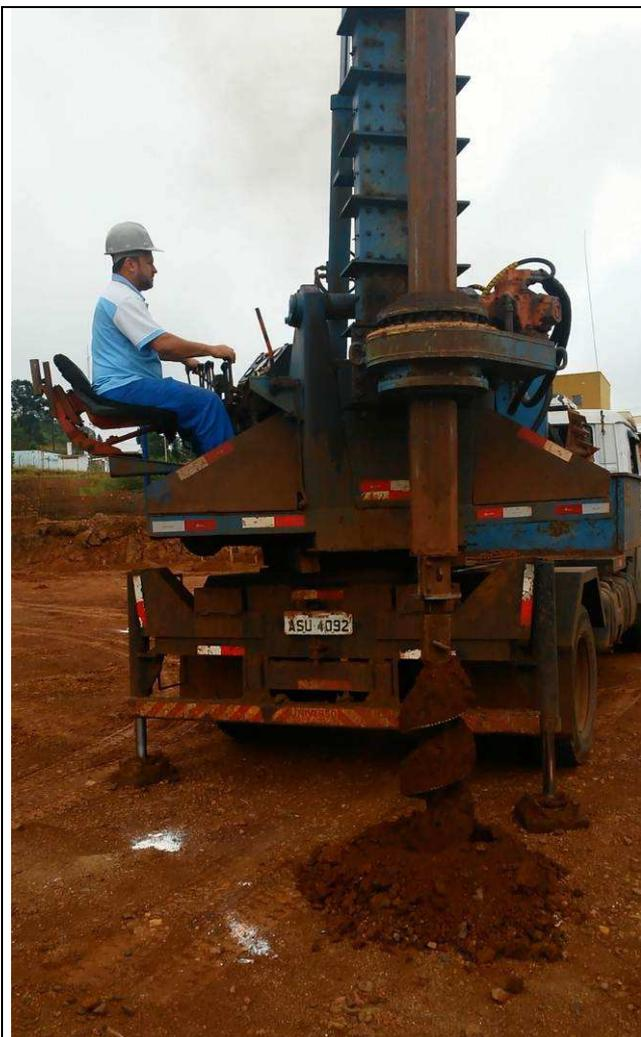
Figura 29C: Escavação das estacas.
