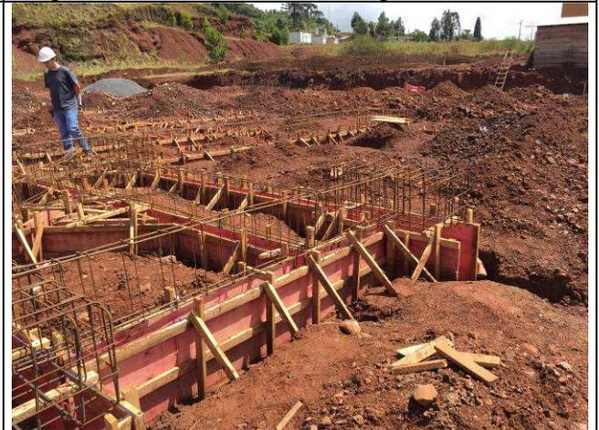
Figura 54C: Armaduras - blocos e vigas baldrames.
