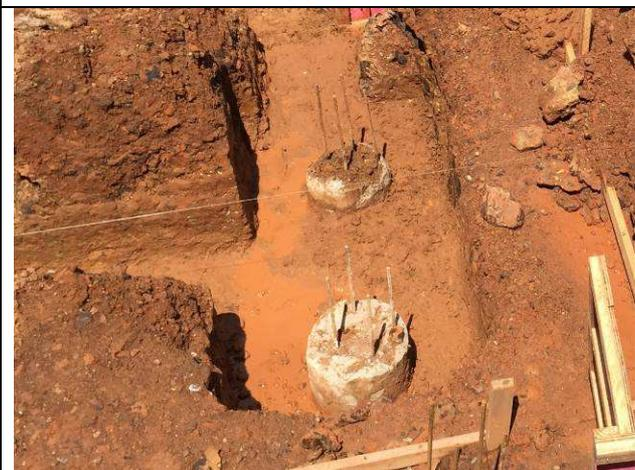
Figura 38C: Estacas concretadas.
