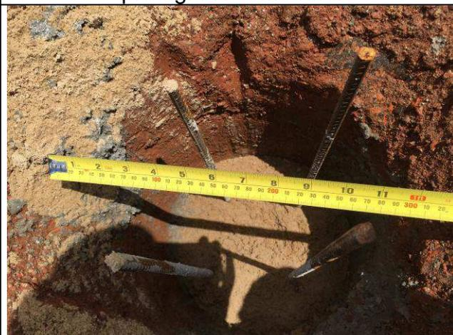
Figura 36C: Estacas concretadas - diâmetro 30cm.
