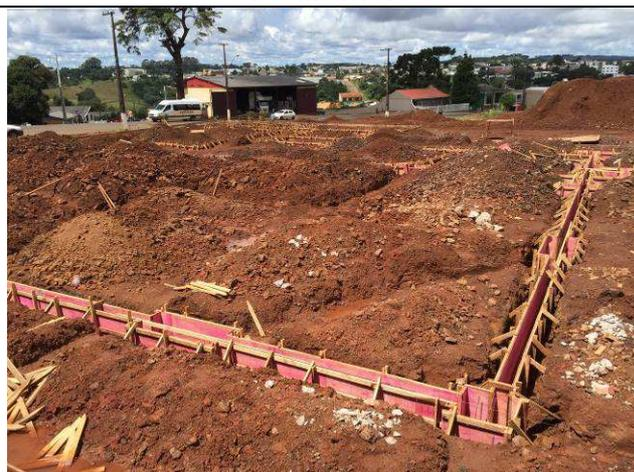
Figura 47C: Formas - blocos e vigas baldrame.
