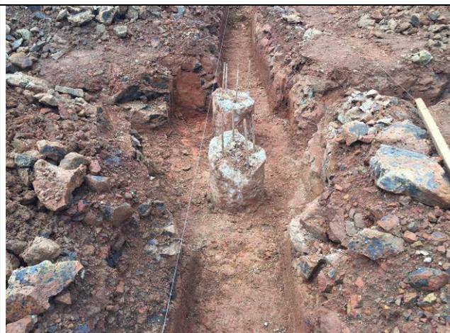
Figura 37C: Estacas concretadas.
