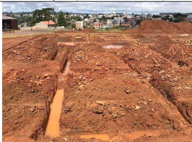
Figura 21C: Abertura de valas para fundações (blocos e baldrames).
