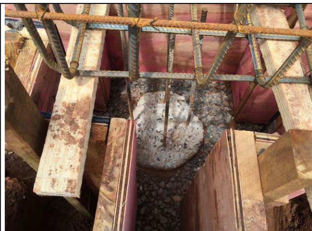
Figura 40C: Estacas - arrasamento das cabeças.
