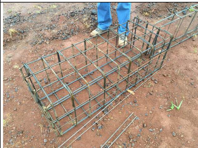
Figura 50C: Armaduras - blocos.
