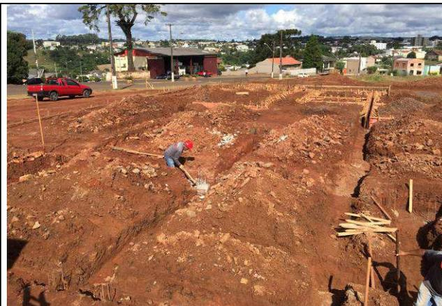
Figura 20C: Abertura de valas para fundações (blocos e baldrames).
