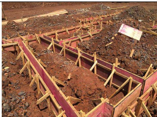
Figura 45C: Formas - blocos e vigas baldrame.
