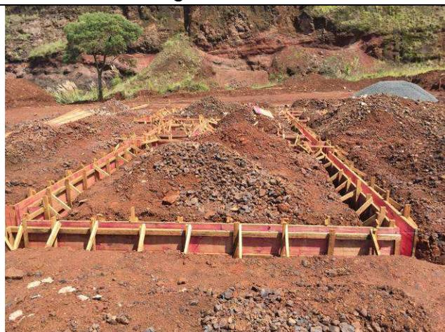
Figura 43C: Formas - blocos e vigas baldrame.
