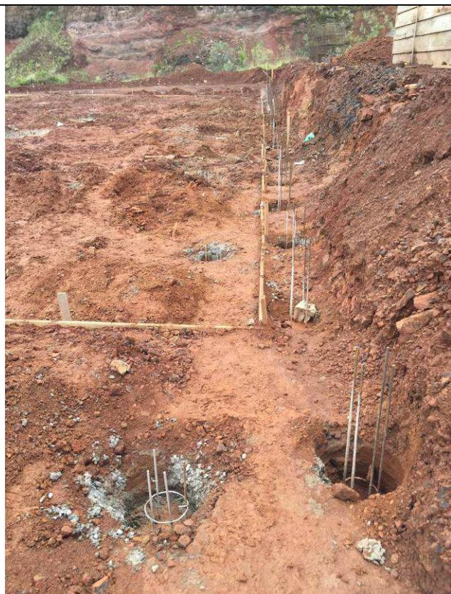
Figura 61C: Muro de arrimo - Estacas concretadas.
