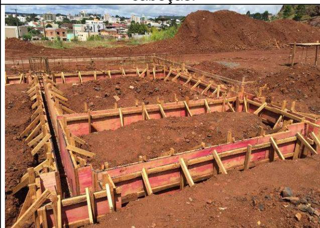
Figura 42C: Formas - blocos e vigas baldrame.
