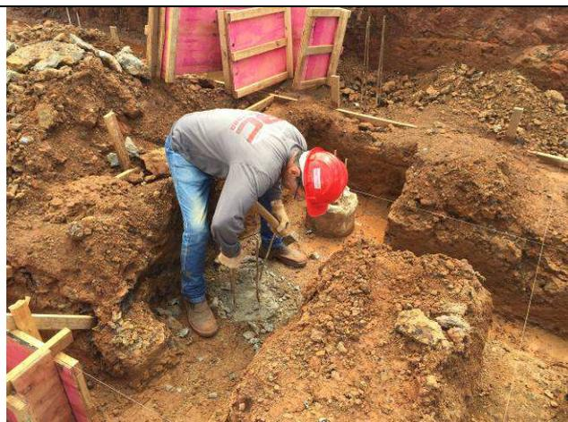
Figura 39C: Estacas - arrasamento das cabeças.
