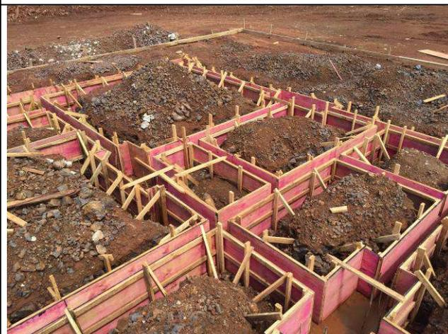
Figura 48C: Formas - blocos e vigas baldrame.
