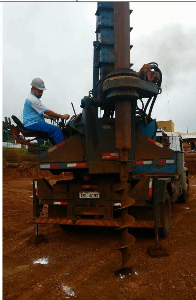
Figura 27C: Escavação das estacas.
