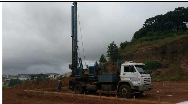
Figura 25C: Escavação das estacas -
