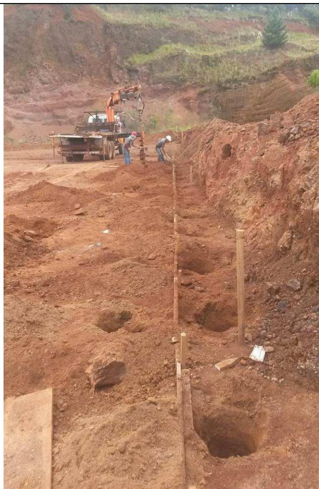
Figura 57C: Muro de arrimo - Escavação das estacas.
