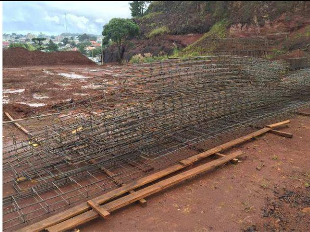
Figura 51C: Armaduras - vigas baldrames.
