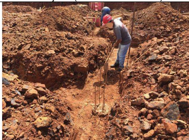
Figura 23C: Abertura de valas para fundações (blocos e baldrames).
