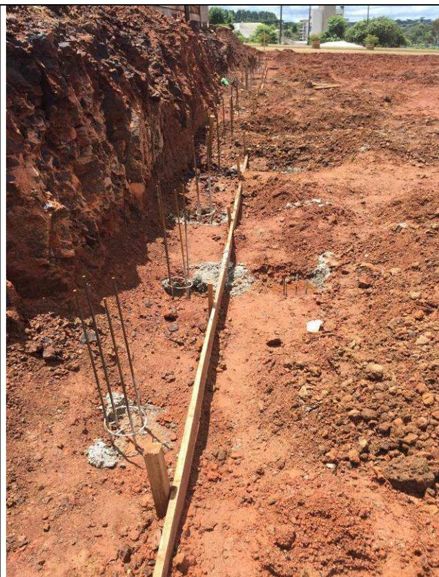
Figura 62C: Muro de arrimo - Estacas concretadas.
