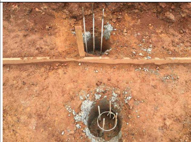
Figura 60C: Muro de arrimo - Estacas concretadas.
