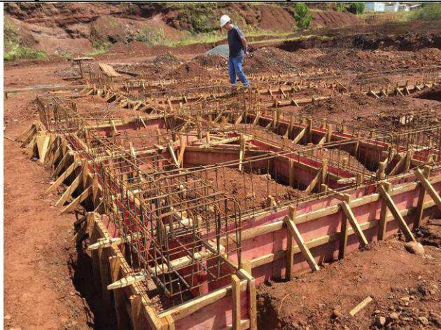
Figura 53C: Armaduras - blocos e vigas baldrames.
