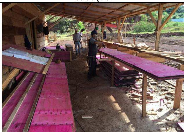
Figura 41C: Fabricação das formas - blocos e vigas baldrame.
