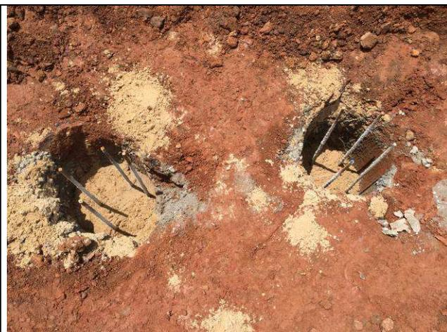
Figura 34C: Estacas concretadas - cabeças protegidas com areia.
