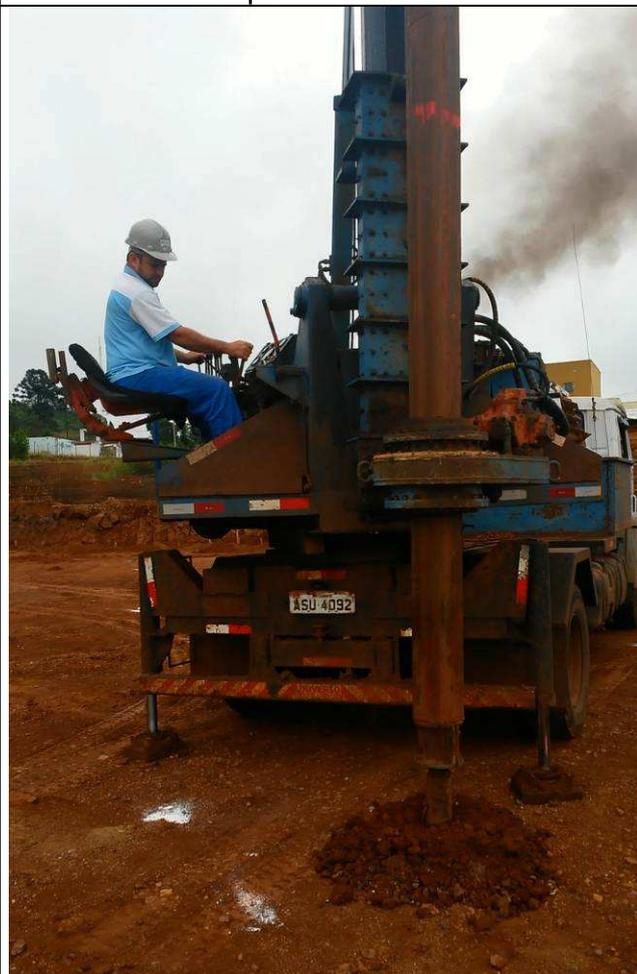
Figura 28C: Escavação das estacas.
