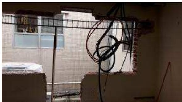
Figura 01c: remoção da esquadria e demolição do vão em alvenaria
