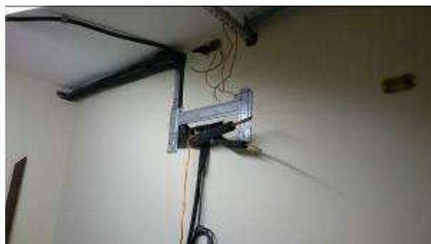
Figura 12c: Suporte e caixa de espera - ar condicionado
