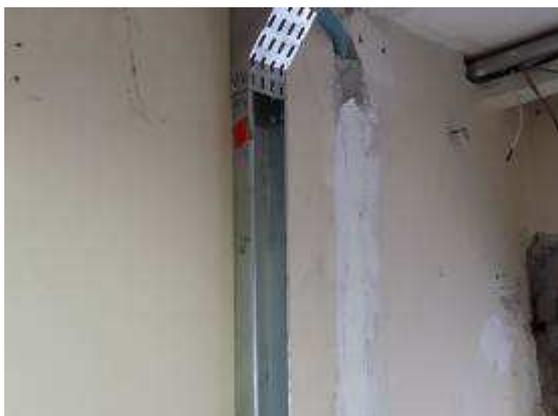
Figura 03E: Eletrocalha #100x50 mm
