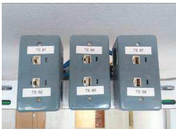
Figura 17E: Conduletes instalados em eletrocalha
