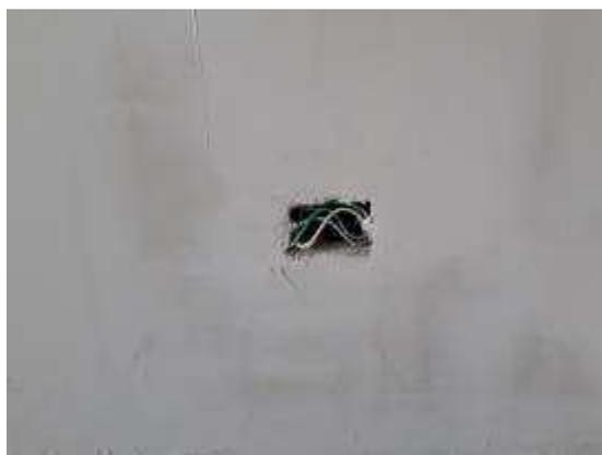
Figura 10E: Caixa de ligação de ferro
