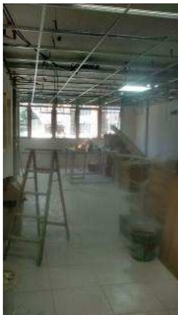
Figura 05c: Perfis do forro instalado
