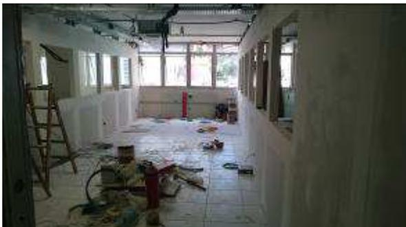
Figura 03c: divisórias em gesso acartonado executadas
