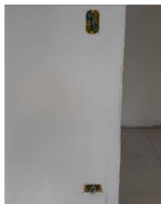
Figura 06E: Caixa de ligação para drywall
