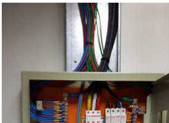
Figura 12E: Cabeamento elétrico instalado
