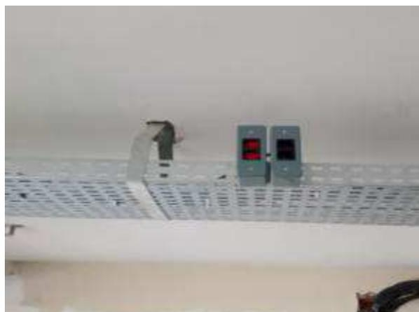
Figura 08E: Conduletes de PVC e tomadas
