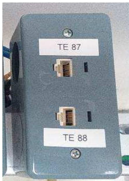
Figura 20E: Conectores RJ 45 e espelho para condulete
