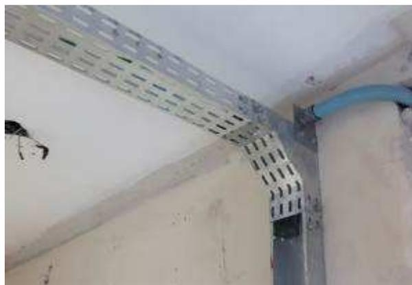
Figura 04E: Eletrocalha #100x50 mm
