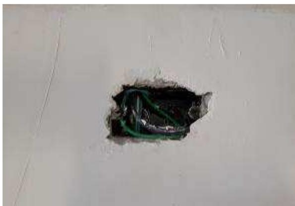
Figura 09E: Caixa de ligação de ferro
