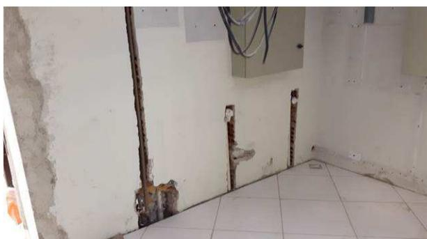
Figura 15c: Pontos hidráulicos
