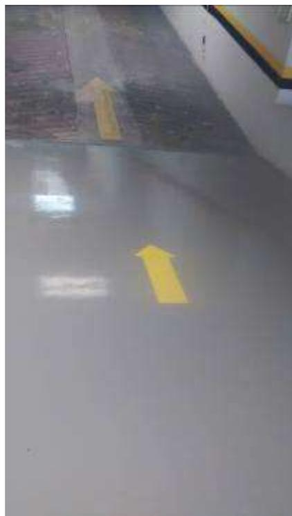
Figura 8c: Piso multilayer garagem
