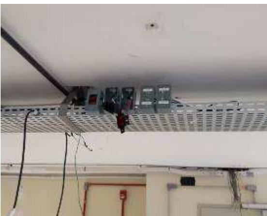
Figura 07E: Conduletes de PVC
