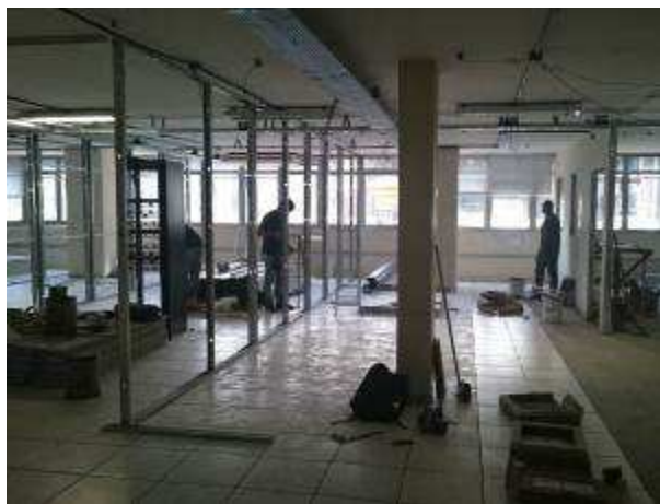
Figura 01E: Remoção parcial de materiais existentes
