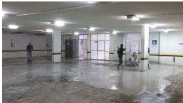
Figura 06c preparo de base - piso da garagem
