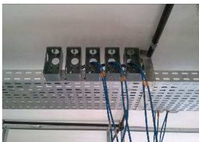
Figura 09E: Conduletes de PVC fixados na eletrocalha
