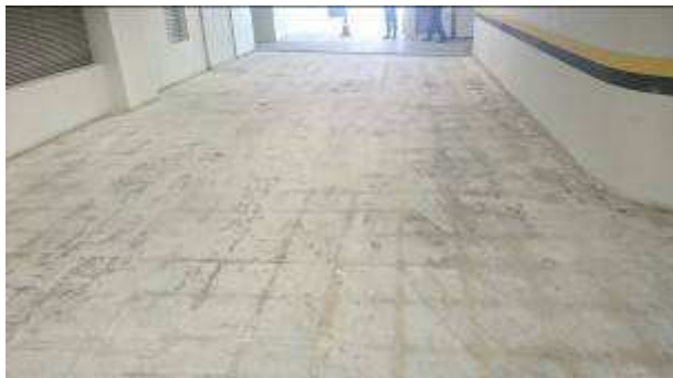
Figura 05c: revestimento cerâmico garagem removida
