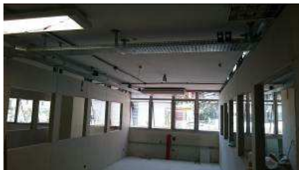
Figura 12c: Vista geral - sobreloja divisórias em gesso acartonado
