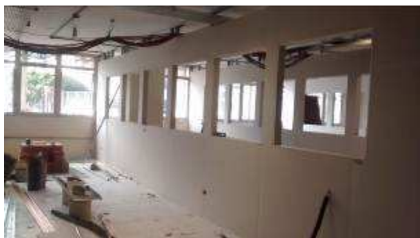
Figura 11c: Vista geral - sobreloja divisórias em gesso acartonado
