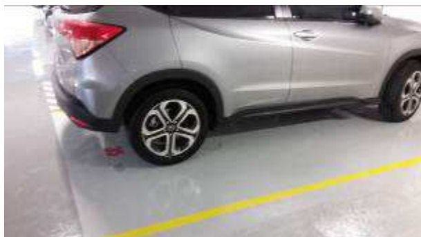
Figura 15c: piso da garagem sobreloja - pintura epóxi e demarcação
