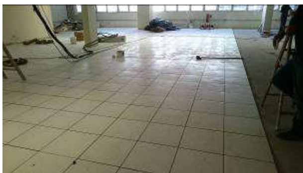
Figura 09c: Vista geral - sobreloja divisórias em gesso acartonado - início execução
