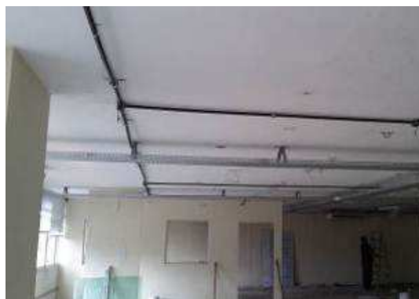
Figura 04E: Infraestrutura parcialmente implantada
