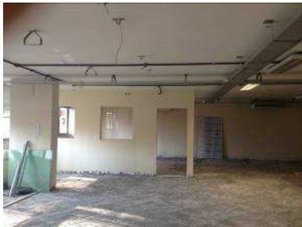
Figura 03c: vista geral sobreloja - piso e divisórias removidas.
