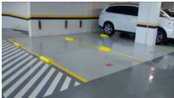
Figura 13c: piso da garagem sobreloja - pintura epóxi e demarcação
