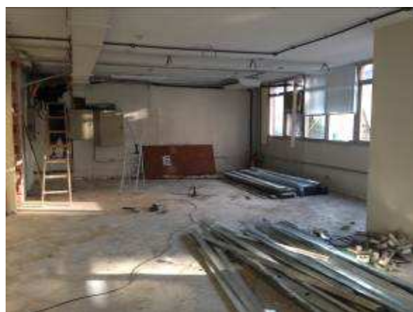
Figura 02c: vista geral sobreloja - piso e divisórias removidas.
