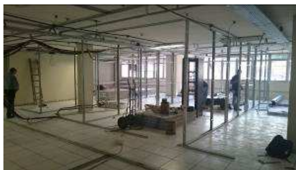
Figura 10c: Vista geral - sobreloja divisórias em gesso acartonado - início execução
