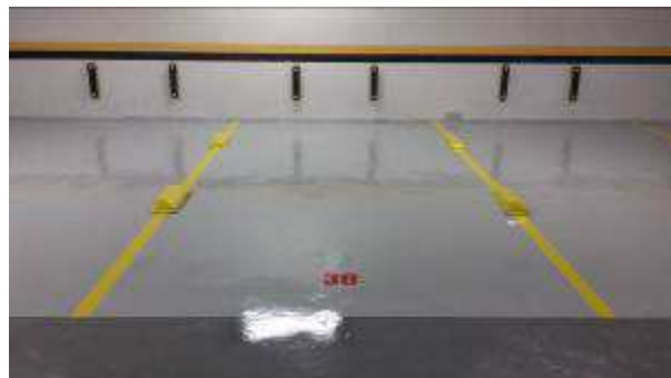
Figura 14c: piso da garagem sobreloja - pintura epóxi e demarcação
