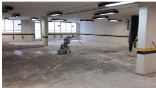
Figura 8c: preparo de base piso da garagem sobreloja
