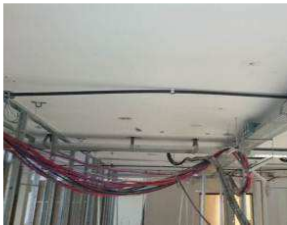
Figura 02E: Remanejamento parcial de alimentadores
