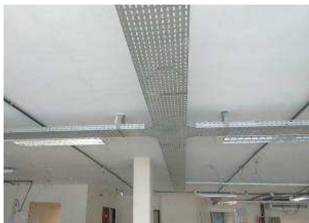
Figura 03E: Infraestrutura parcialmente implantada
