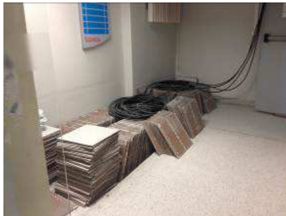
Figura 04c: pisos cerâmicos removidos
