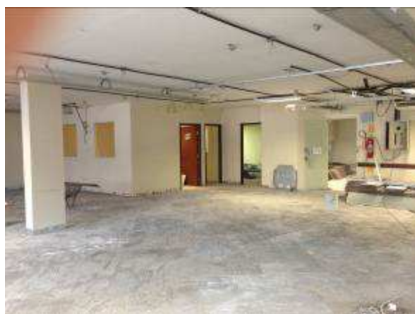
Figura 01c: vista geral sobreloja - piso e divisórias removidas
