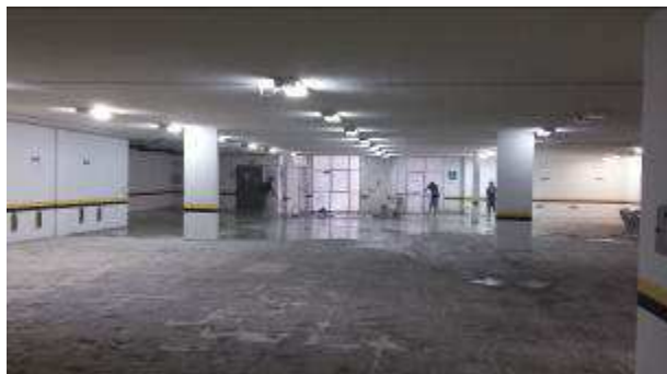
Figura 07c: preparo de base piso da garagem térreo
