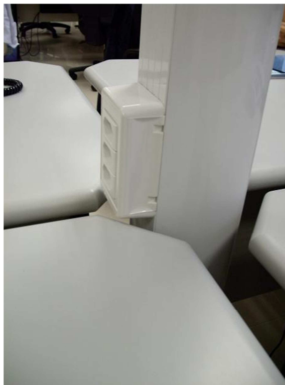
Figura 2 – Poste técnico (Observar interrupção dos porta equipamentos para encaixe da mesa)
