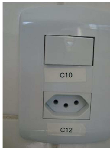
Figura 1 - Identificação de condutores, tomadas e interruptores
