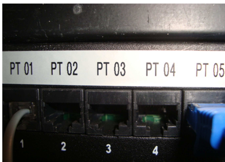
Figura 8 – Patch panel com identificação de pontos
