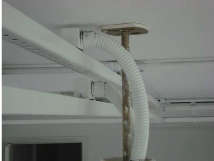
Figura 11 – Derivação para circuitos
