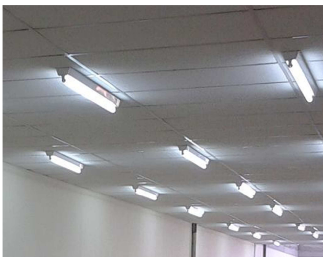
Figura 7 – Luminárias comercial LED 1x18 W
