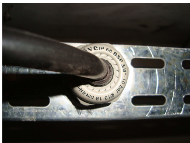
Figura 4 – Derivação para luminárias (prensa-cabo e plug)
