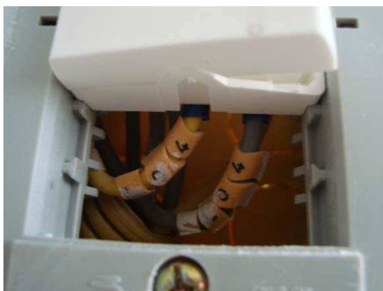
Figura 1 - Identificação de condutores, tomadas e interruptores
