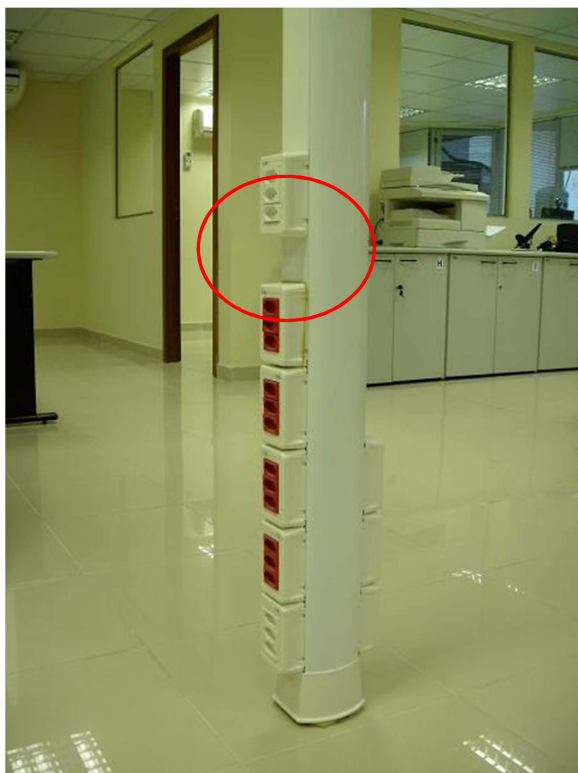
Figura 2 – Poste técnico (Observar interrupção dos porta equipamentos para encaixe da mesa)
