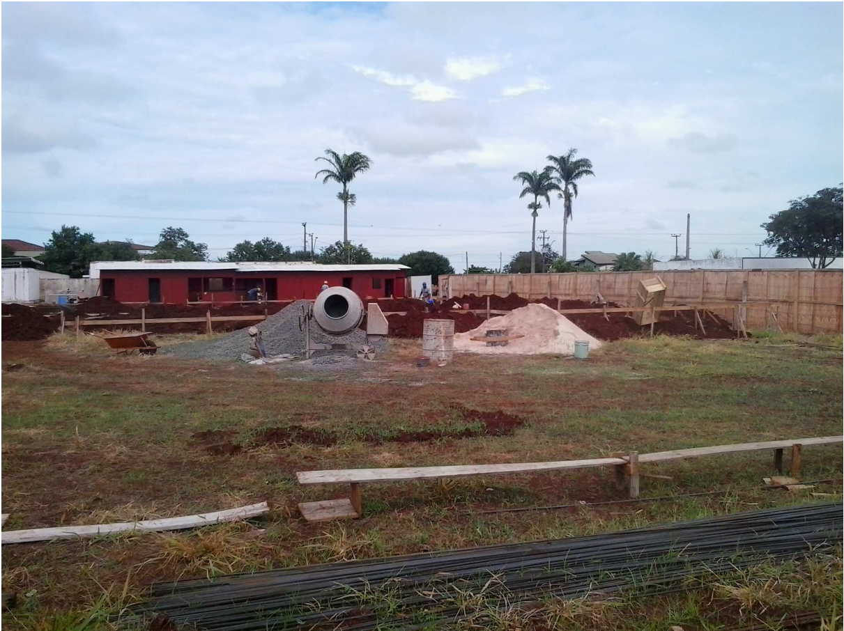
Figura 1 – Vista do canteiro de obras
