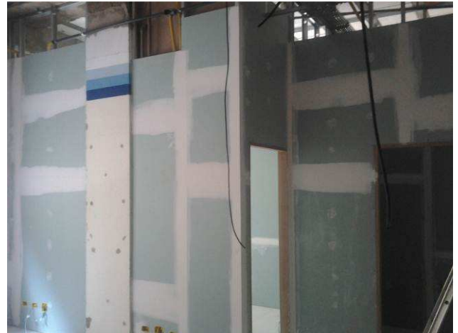
Figura 04C: Parede de gesso acartonado verde - térreo
