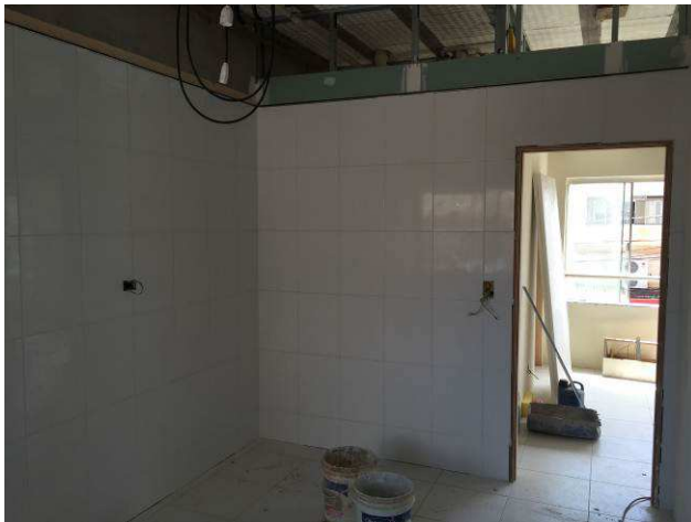
Figura 35C: Azulejos aplicados no primeiro pavimento
