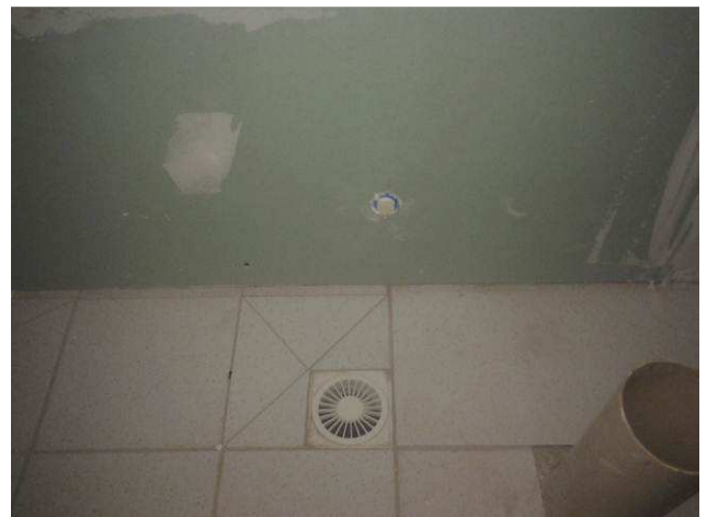
Figura 48C: Ponto de esgoto primário instalado no térreo
