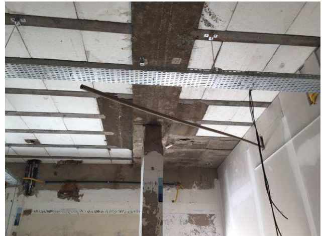
Figura 54C: Dreno para ar condicionado cassete, instalado no térreo
