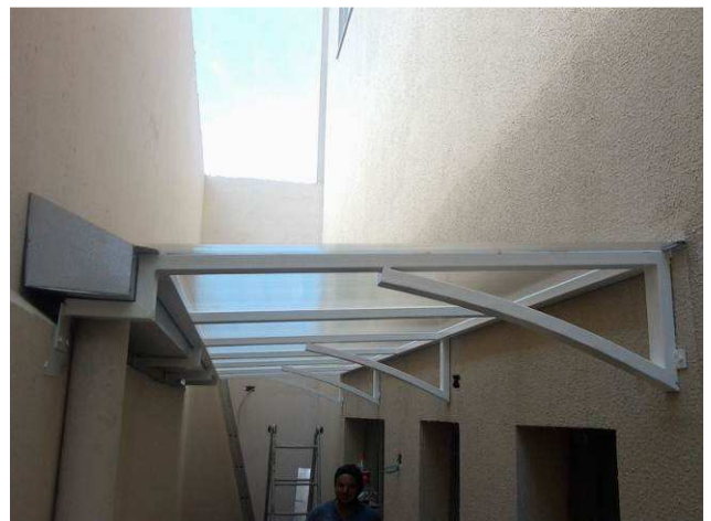
Figura 14C: Cobertura em policarbonato, dos fundos do imóvel, concluída
