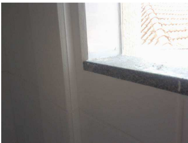
Figura 31C: Azulejos aplicados no primeiro pavimento
