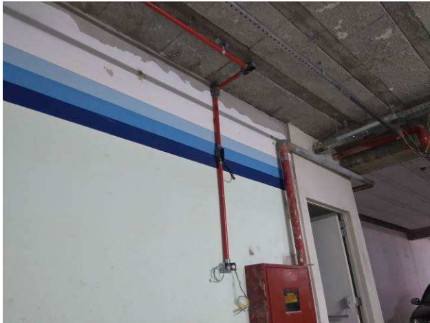
Figura 57E: infraestrutura SDAI concluída
