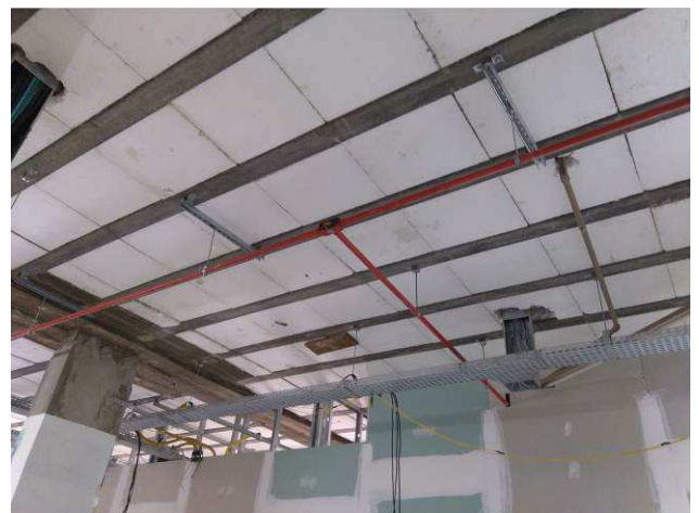
Figura 56E: infraestrutura SDAI concluída
