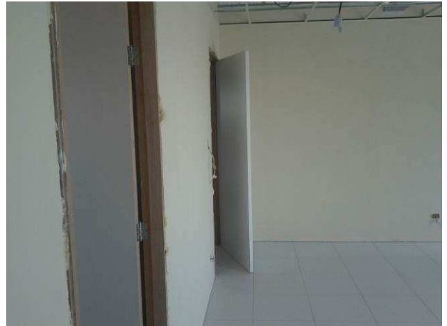
Figura 64C: Pinturas realizadas no segundo pavimento
