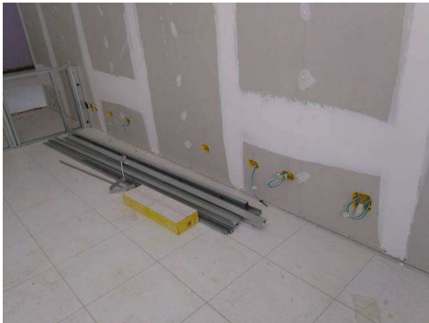
Figura 7E: infraestrutura elétrica para paredes drywall térreo
