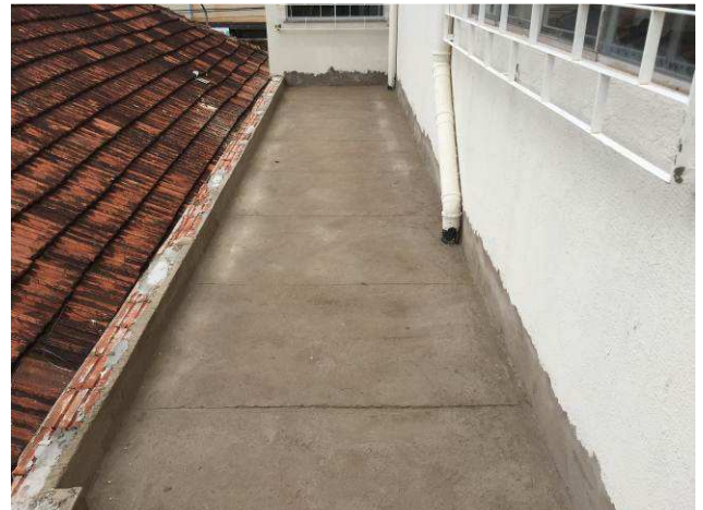
Figuras 24C: Detalhe da aplicação da camada de proteção mecânica no corredor lateral direito do primeiro pavimento
