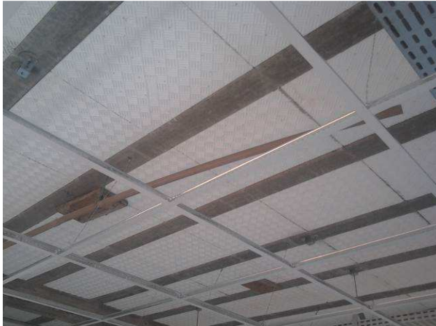
Figura 51C: Dreno para ar condicionado cassete, instalado no primeiro pavimento
