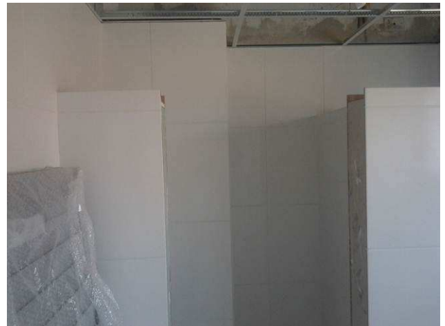
Figura 36C: Azulejos aplicados no primeiro pavimento
