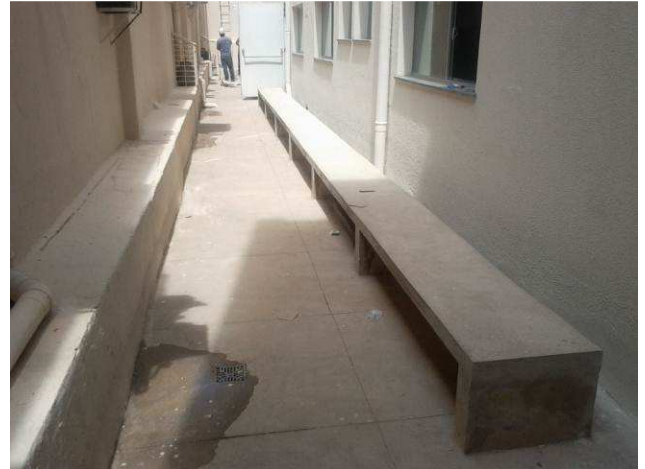
Figura 22C: Detalhe da aplicação da camada de proteção mecânica no corredor lateral esquerdo do térreo
