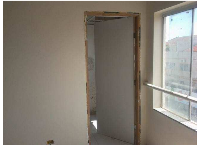
Figura 10C: Portas de 70x210 instaladas no segundo pavimento
