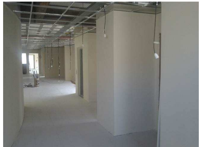
Figura 60C: Pinturas realizadas no primeiro pavimento
