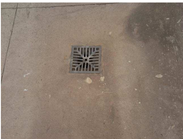
Figura 43C: Grelhas instaladas nas lajes impermeabilizadas
