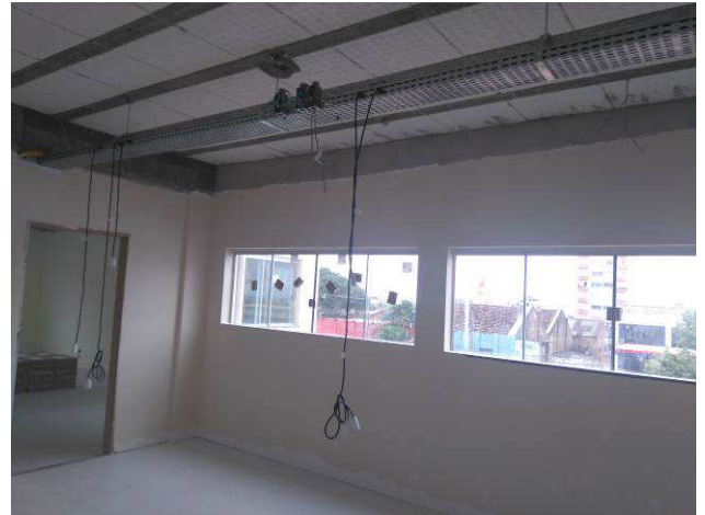
Figura 24E: cabos PP luminárias
