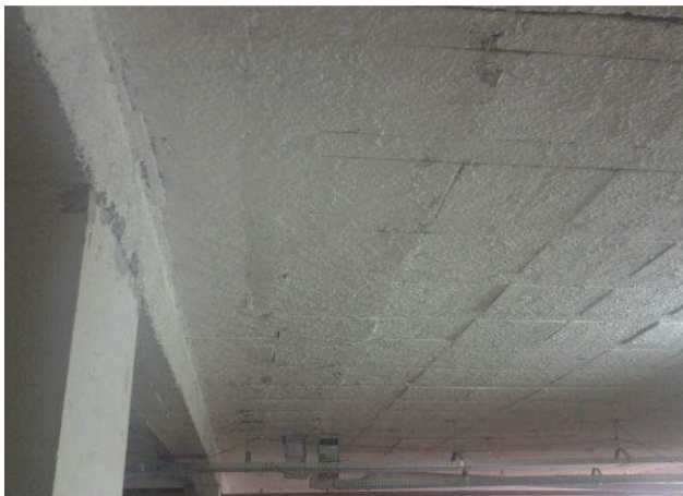
Figura 59C: Primeira demão de pintura no teto da laje do subsolo
