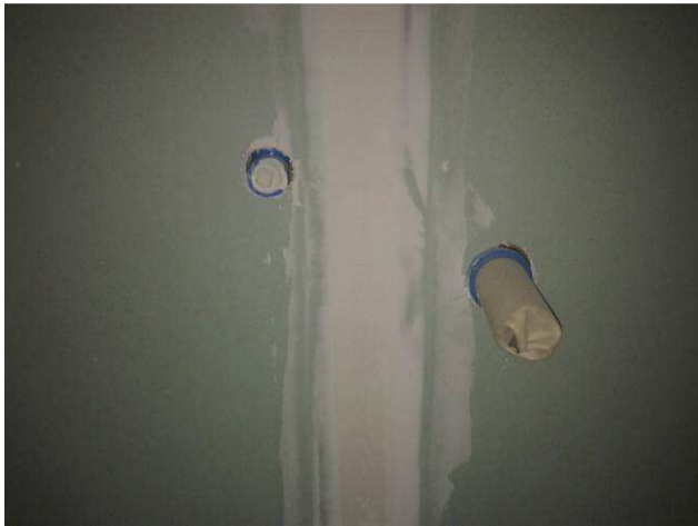
Figura 45C: Ponto da água fria 25mm instalado em parede de gesso acartonado verde. Ao lado, ponto de esgoto secundário.
