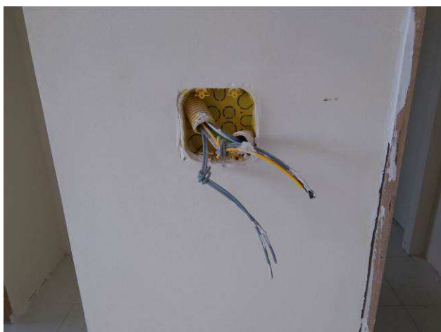
Figura 3E: infraestrutura elétrica para paredes drywall térreo
