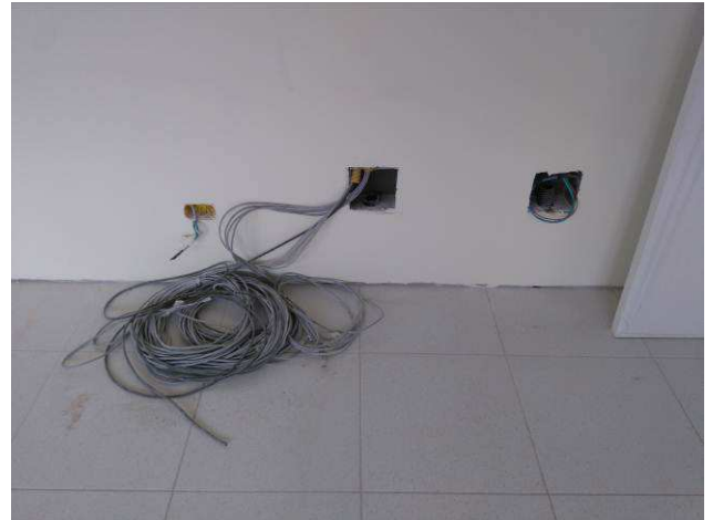
Figura 70E: caixas 15x15 para cabeamento aos totens de piso.
