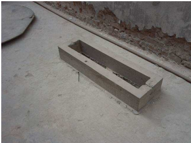
Figura 73C: bordas executadas dos furos na laje
