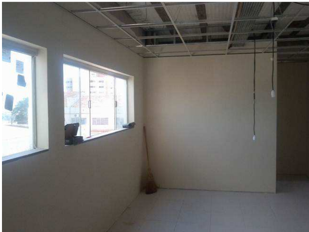
Figura 65C: Pinturas realizadas no segundo pavimento
