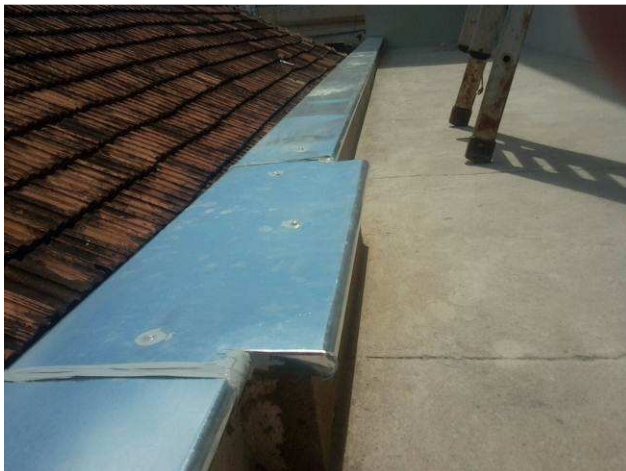
Figura 11C: Rufo instalado na mureta do corredor lateral direito do primeiro pavimento
