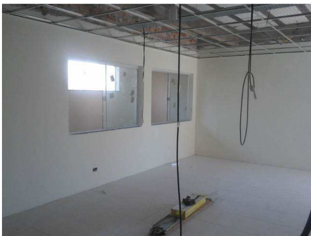
Figura 61C: Pinturas realizadas no primeiro pavimento
