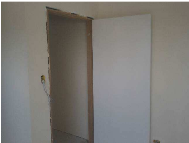
Figura 05C: Portas de 80x210 instaladas no segundo pavimento
