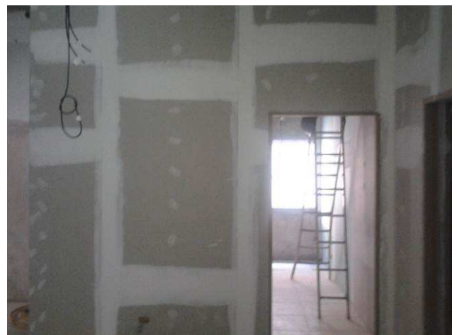
Figura 76C: Paredes de gesso acartonado simples, executadas no térreo
