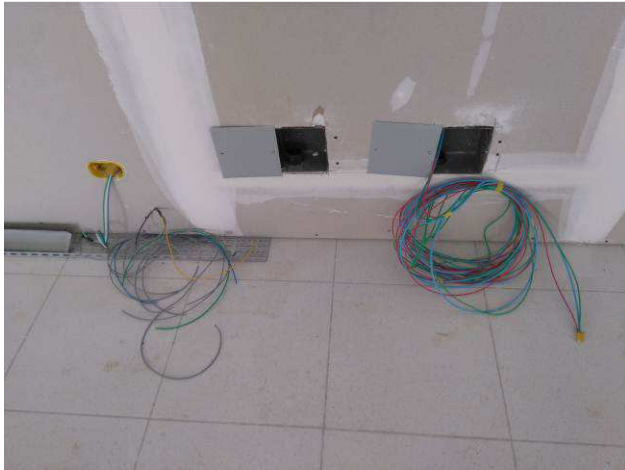
Figura 71E: caixas 15x15 para cabeamento aos totens de piso.
