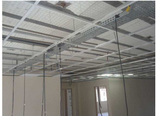
Figuras 28C: forro instalado no segundo pavimento - foram instalados todos os perfis de sustentação
