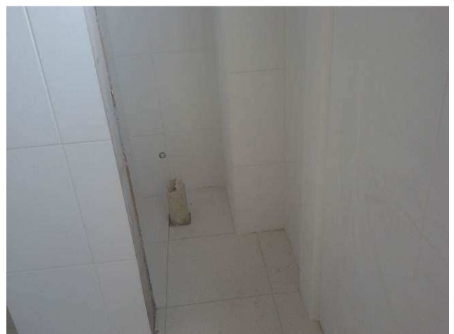
Figura 32C: Azulejos aplicados no primeiro pavimento
