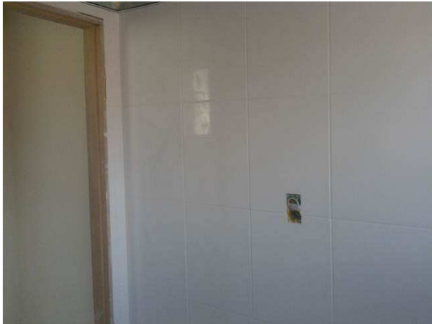
Figura 33C: Azulejos aplicados no primeiro pavimento
