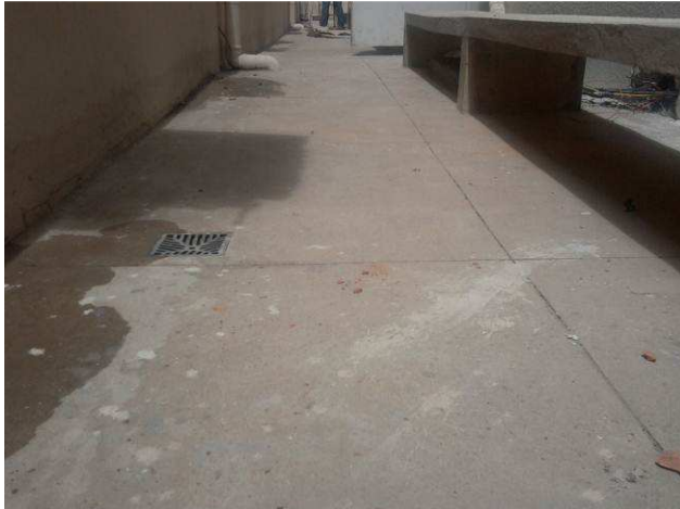
Figura 21C: Detalhe da aplicação da camada de proteção mecânica no corredor lateral esquerdo do térreo
