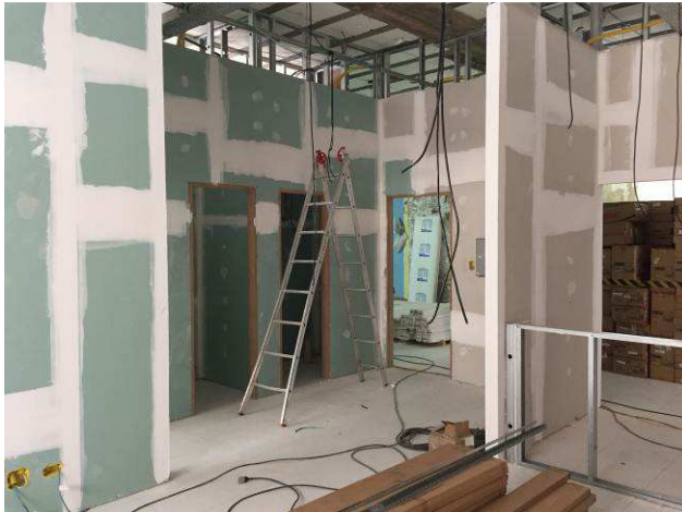
Figura 03C: Parede de gesso acartonado verde - térreo
