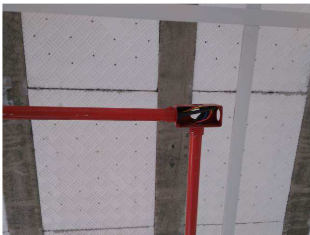
Figura 55E: infraestrutura SDAI concluída
