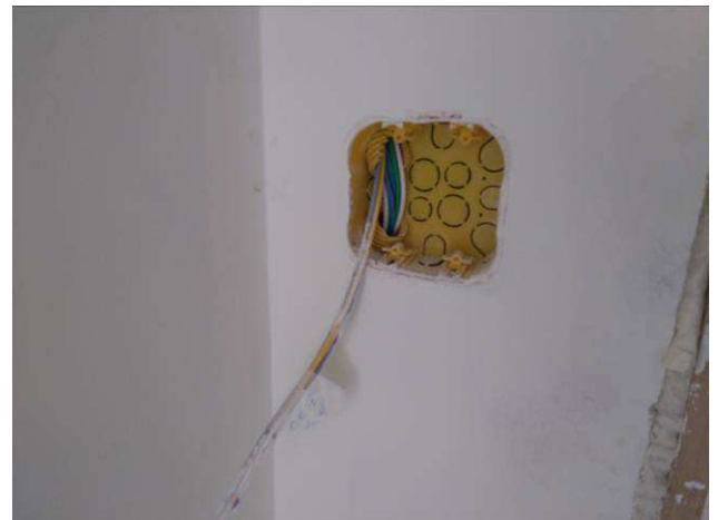
Figura 2E: infraestrutura elétrica para paredes drywall térreo
