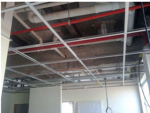
Figura 25C: forro instalado no primeiro pavimento - foram instalados todos os perfis de sustentação
