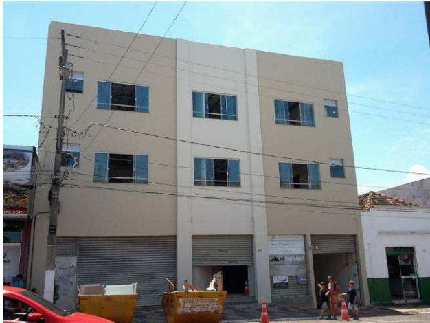
Figura 69C: Segunda demão de textura na lateral esquerda do imóvel
