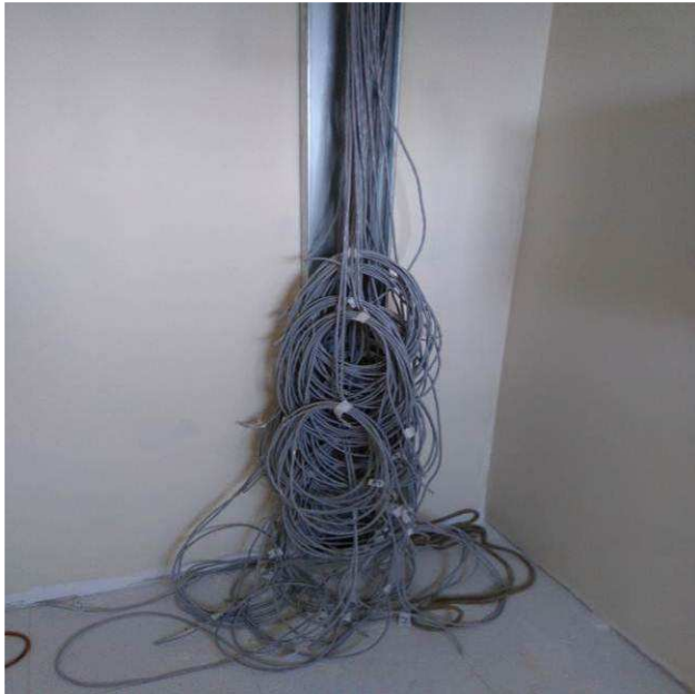
Figura 75E: cabearmento UTP cat 6 2º pavimento
