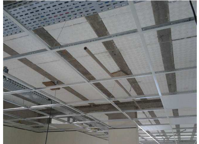
Figura 52C: Dreno para ar condicionado cassete, instalado no segundo pavimento
