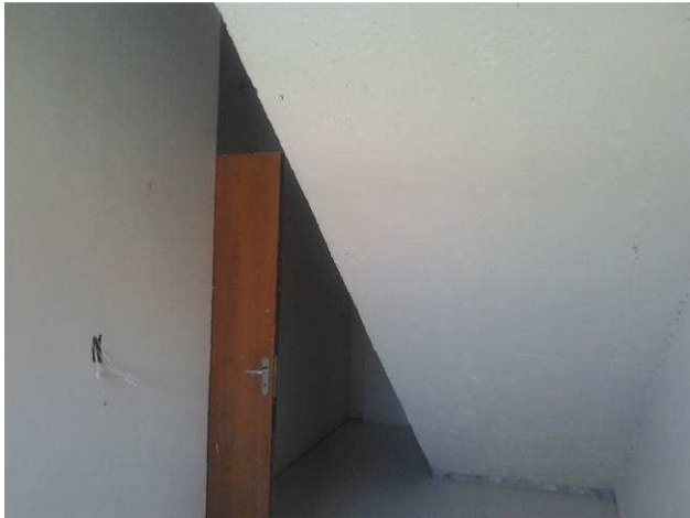
Figura 63C: Pinturas realizadas no segundo pavimento
