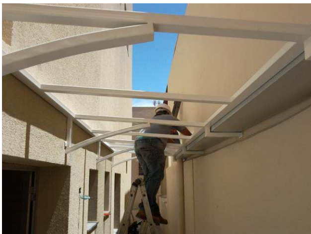
Figura 13C: Cobertura em policarbonato, dos fundos do imóvel, sendo instalada
