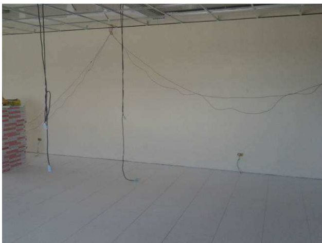
Figura 67C: Pinturas realizadas no segundo pavimento
