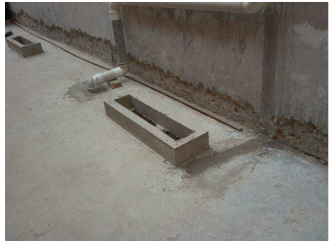
Figura 74C: bordas executadas dos furos na laje
