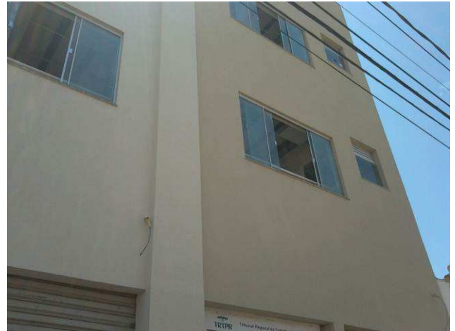
Figura 70C: Segunda demão de textura na parede posterior do imóvel
