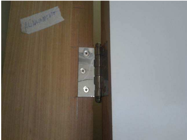
Figura 09C: detalhe da fixação das dobradiças
