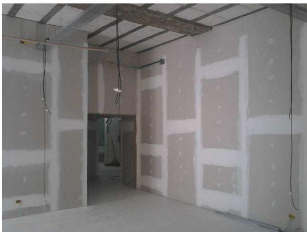
Figura 75C: Paredes de gesso acartonado duplas, executadas no térreo
