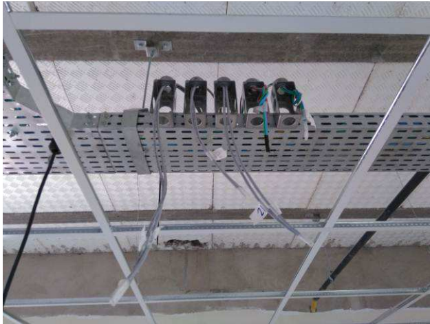
Figura 69E: conduletes para padrão genérico de layouts das colunas técnicas.
