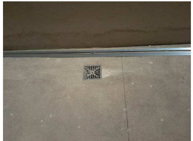
Figura 42C: Grelhas instaladas nas lajes impermeabilizadas
