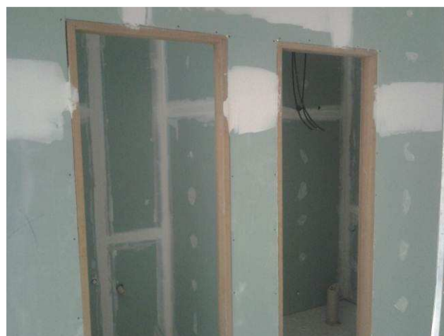
Figura 02C: Parede de gesso acartonado verde - térreo
