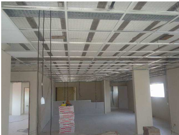
Figuras 29C: forro instalado no segundo pavimento - foram instalados todos os perfis de sustentação
