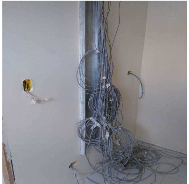
Figura 76E: cabearmento UTP cat 6 CFTV (1º pavimento)
