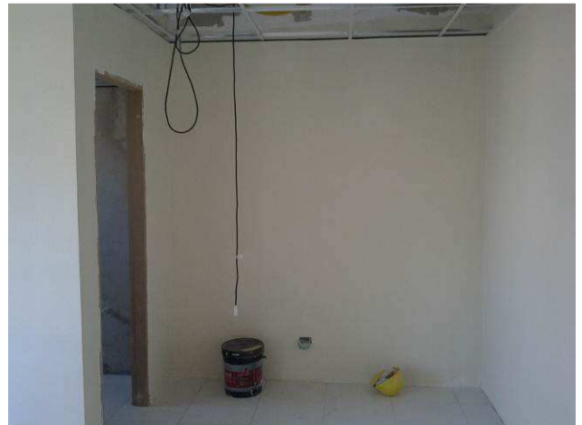
Figura 66C: Pinturas realizadas no segundo pavimento
