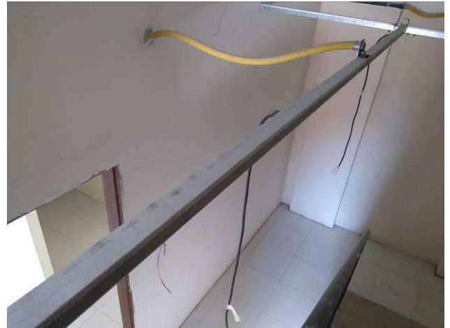
Figura 18E: perfilados tampados 1º e 2º pavimentos
