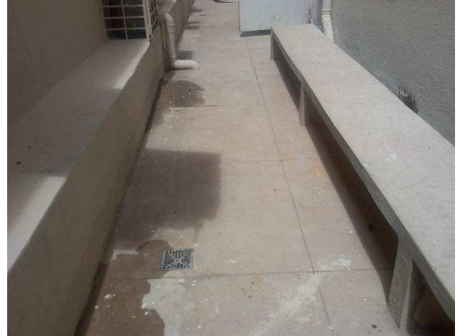
Figura 72C: estrutura dos bancos de concreto
