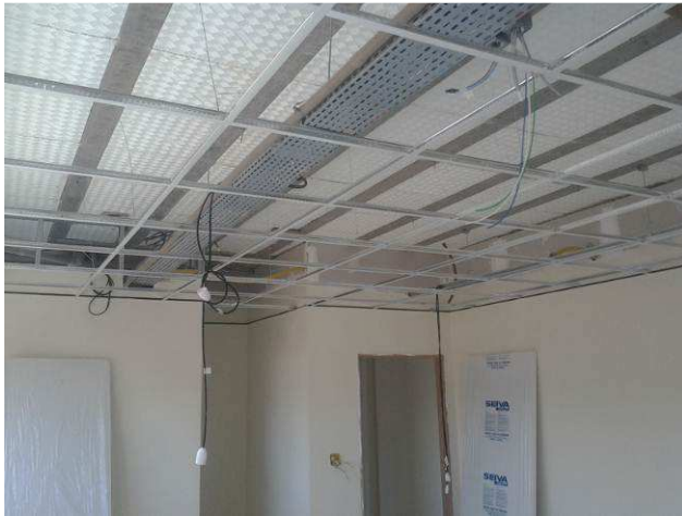
Figuras 27C: forro instalado no primeiro pavimento - foram instalados todos os perfis de sustentação
