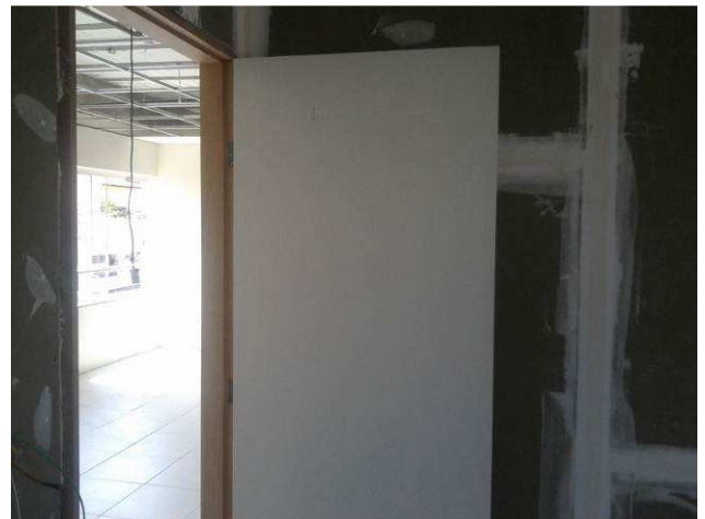
Figura 06C: Portas de 80x210 instaladas no segundo pavimento
