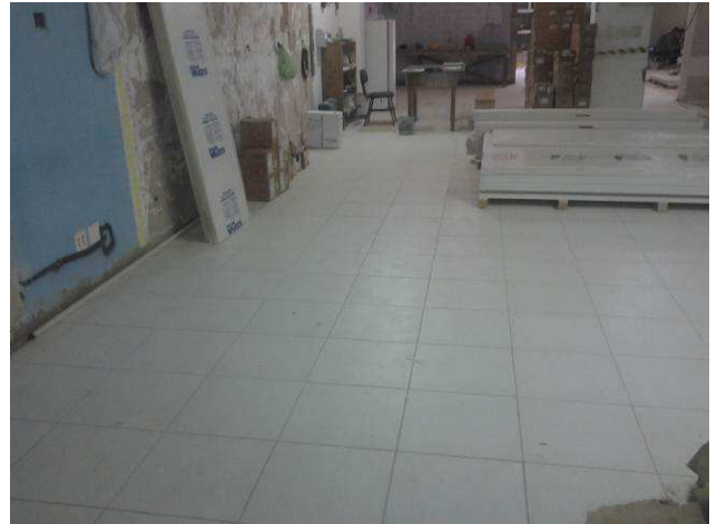
Figura 78C: Complemento de piso, assentado no PAB
