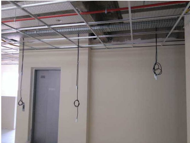
Figura 23E: cabos PP luminárias
