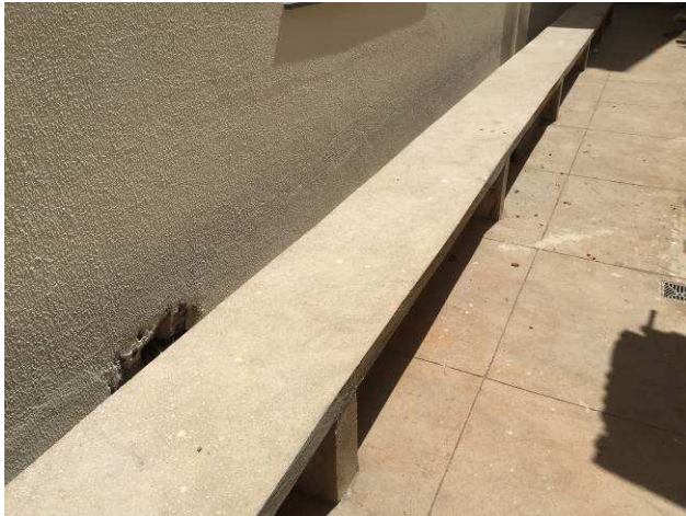
Figura 77C: Bancos em concreto, com emboço aplicado
