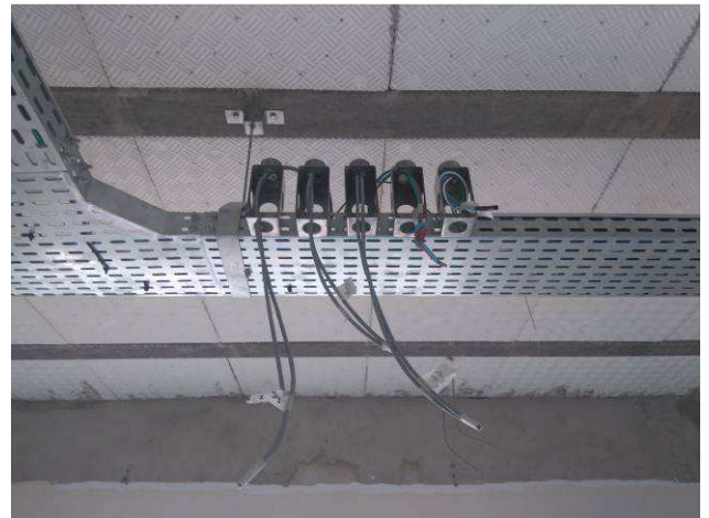
Figura 8E: condutores sistema genérico layout colunas técnicas
