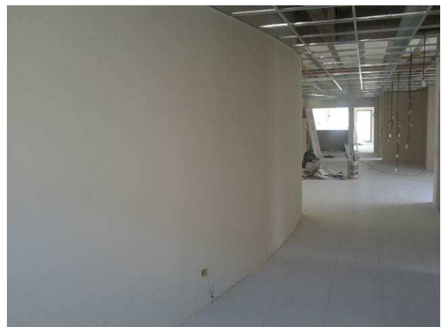
Figura 62C: Pinturas realizadas no primeiro pavimento
