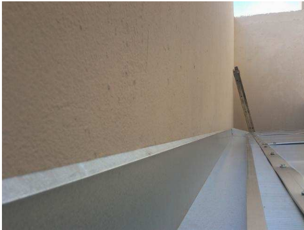
Figura 15C: Detalhe da calha de coleta pluvial, na cobertura dos fundos
