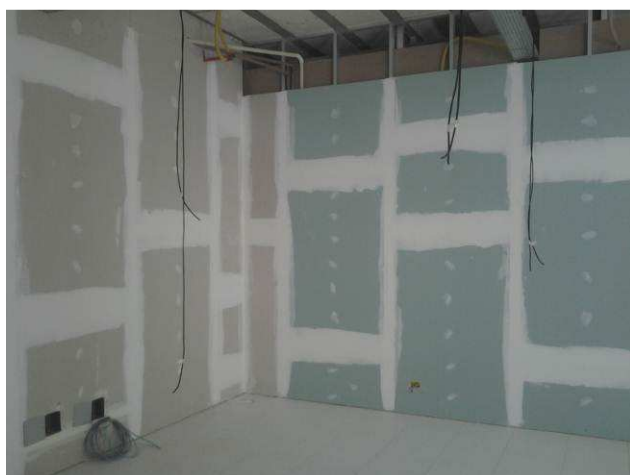
Figura 01C: Parede de gesso acartonado verde - térreo
