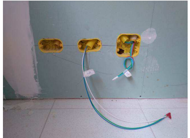
Figura 6E: infraestrutura elétrica para paredes drywall térreo
