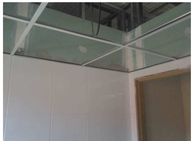
Figura 26C: forro instalado no primeiro pavimento - foram instalados todos os perfis de sustentação
