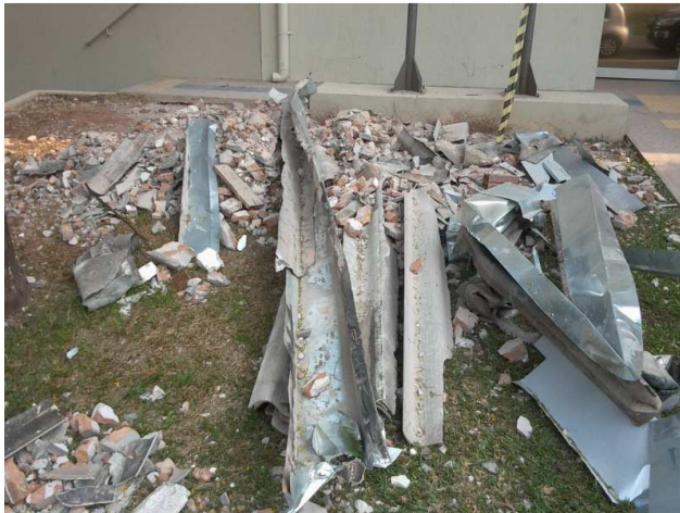
Figura 11C: rufos e calhas removidas
