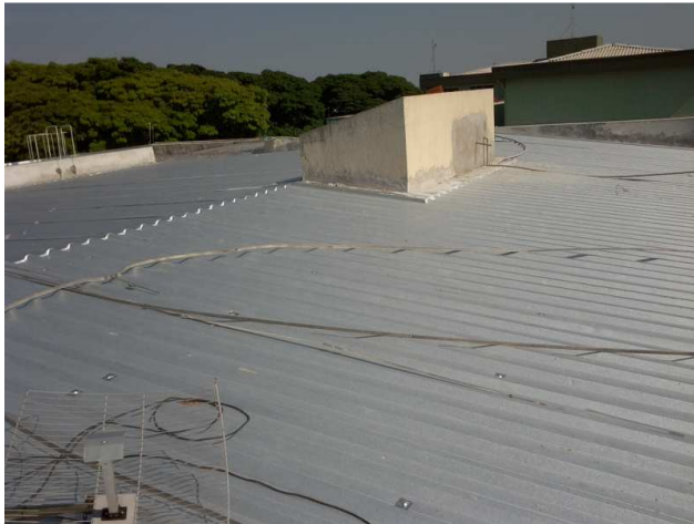
Figura 31C: Telha metálica trapezoidal tipo sanduíche, com injeção de poliuretano
