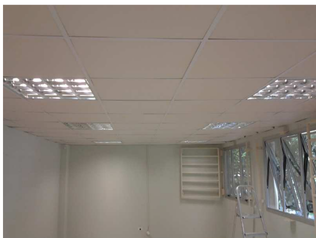
Figura 23C: reconstituição do forro de gesso acartonado, com substituição de placas danificadas
