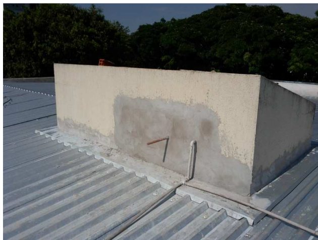
Figura 15C: reconstituição da alvenaria de fechamento do compartimento dos reservatórios
