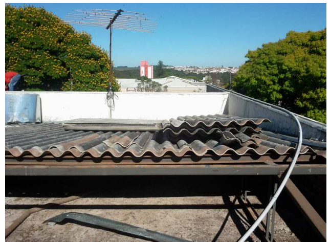
Figura 06C: demolição de telhas onduladas de fibrocimento
