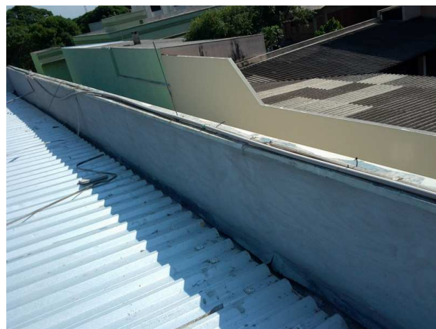
Figura 22C: emboço das platibandas existentes
