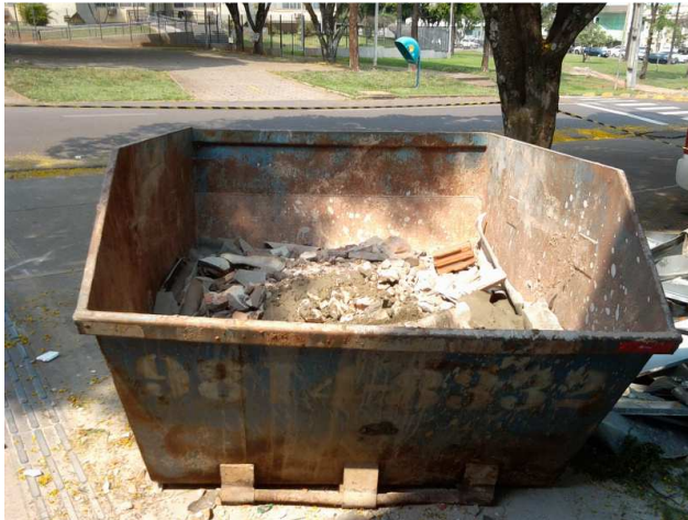
Figura 09C: Caçambas utilizadas para remoção de entulho
