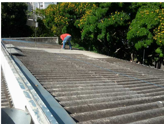
Figura 07C: platibanda e telhas de fibrocimento, antes da demolição
