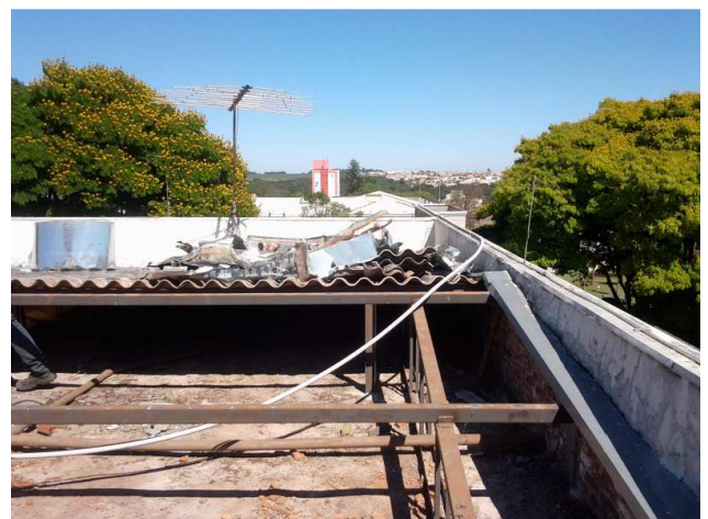
Figura 08C: demolição de telhas onduladas de fibrocimento
