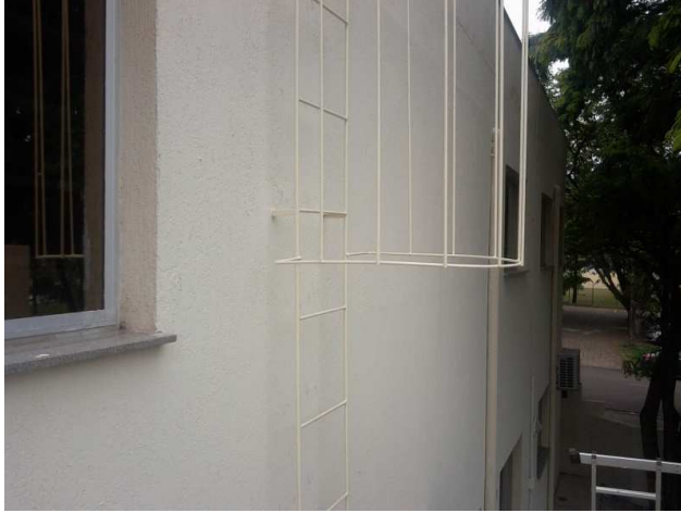
Figura 49C: parede lateral esquerda e escada marinho, após pintura
