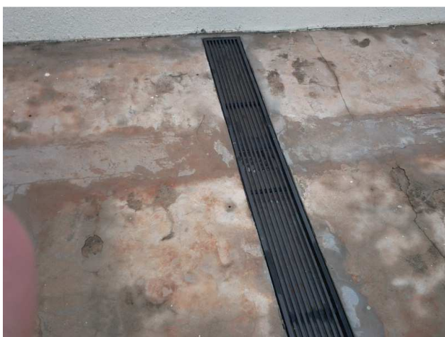
Figura 47C: canaletas com grelha para captação pluvial da calçada dos fundos do imóvel
