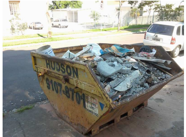
Figura 10C: Caçambas utilizadas para remoção de entulho
