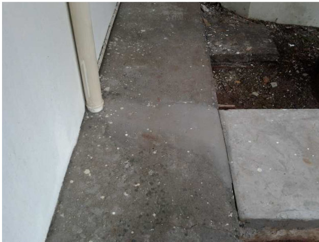
Figura 51C: Piso cimentado sobre lastro de concreto, no refazimento da calçada onde foram executadas valas de assentamento da tubulação de drenagem pluvial
