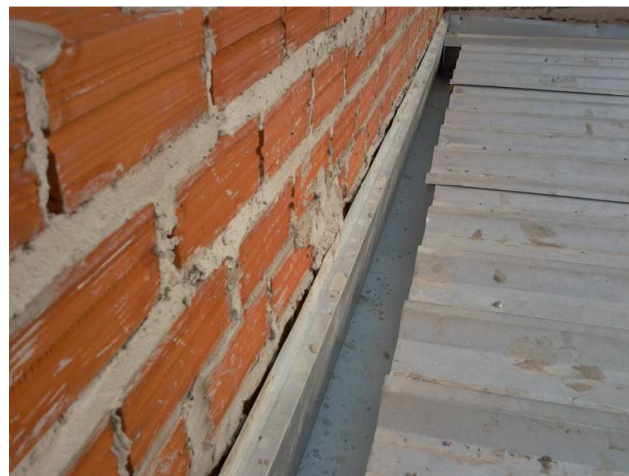
Figura 16C: alvenaria da platibanda nova
