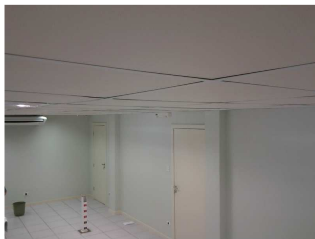
Figura 24C: reconstituição do forro de gesso acartonado, com substituição de placas danificadas
