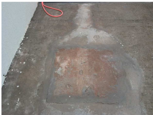
Figura 53C: Piso cimentado sobre lastro de concreto, no refazimento da calçada onde foram executadas valas de assentamento da tubulação de drenagem pluvial
