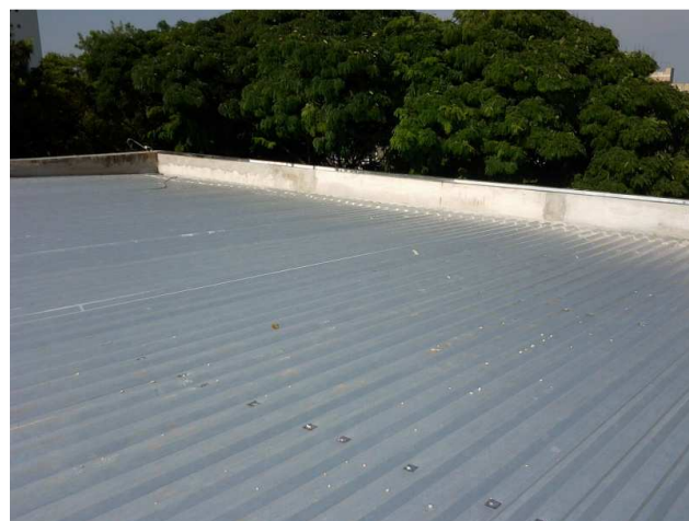
Figura 30C: Telha metálica trapezoidal tipo sanduíche, com injeção de poliuretano
