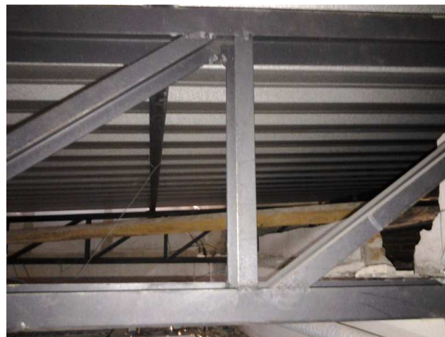
Figura 26C: Estrutura de cobertura em tesouras metálicas
