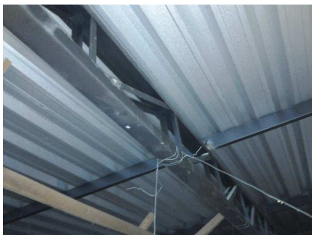
Figura 27C: Estrutura de cobertura em tesouras metálicas
