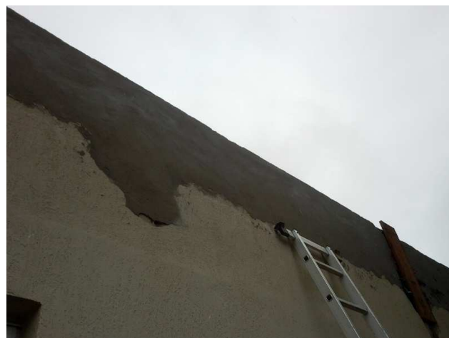
Figura 20C: emboço da platibanda nova
