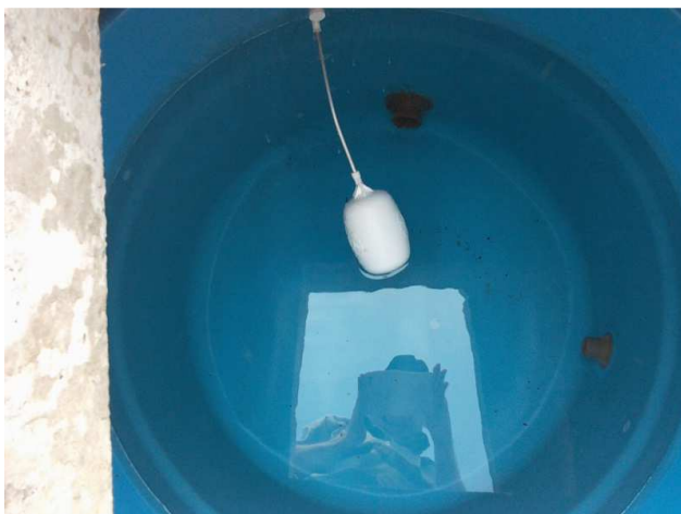
Figura 41C: reservatórios em polietileno 310L
