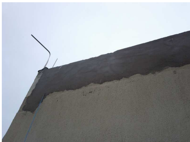
Figura 19C: emboço da platibanda nova
