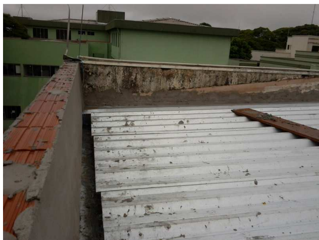
Figura 21C: emboço da platibanda nova
