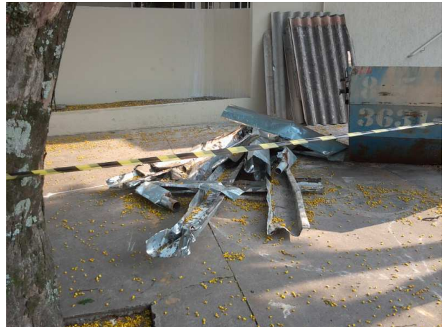
Figura 12C: rufos e calhas removidas
