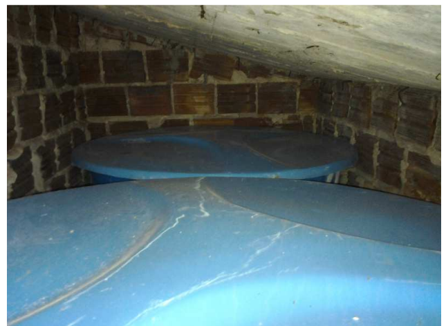
Figura 42C: reservatórios em polietileno 310L
