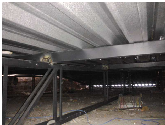
Figura 25C: Estrutura de cobertura em tesouras metálicas
