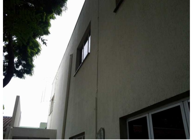
Figura 50C: parede lateral esquerda após
