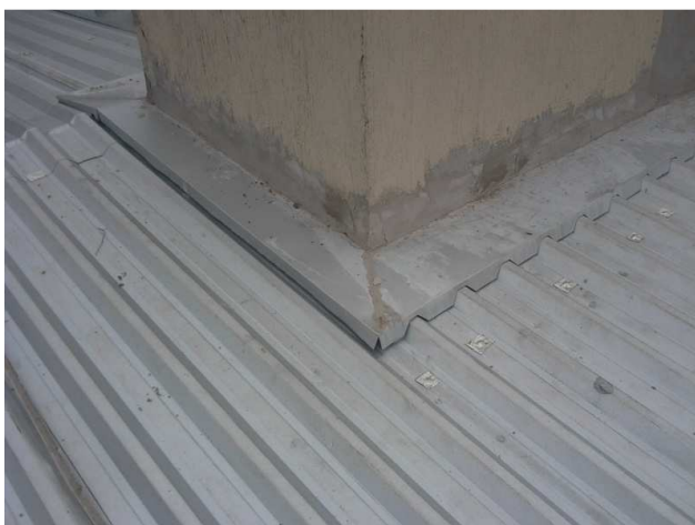
Figura 35C: rufo instalado no encontro da telha com alvenaria
