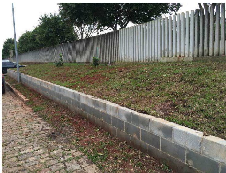
Figura 01 – Muro de arrimo finalizado com grama plantada
