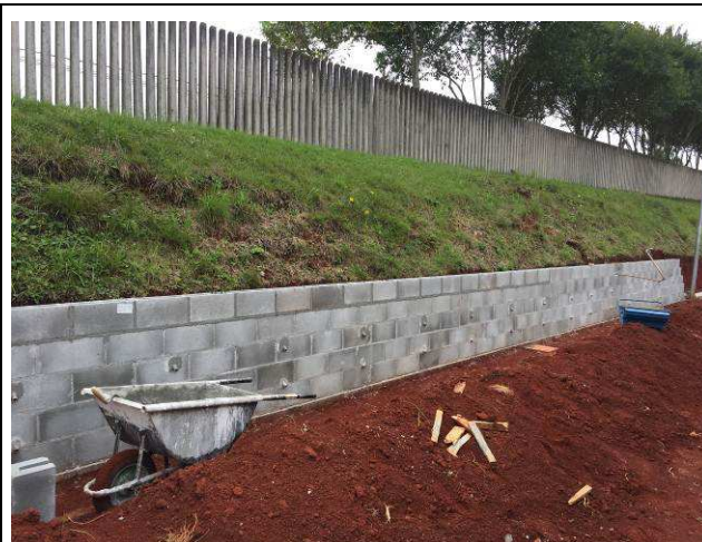
Figura 54C: Alvenaria e cinta superior - trecho B.
