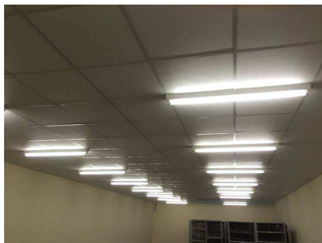
Figura 17C: Forro modular - Sala Refrigerada.
