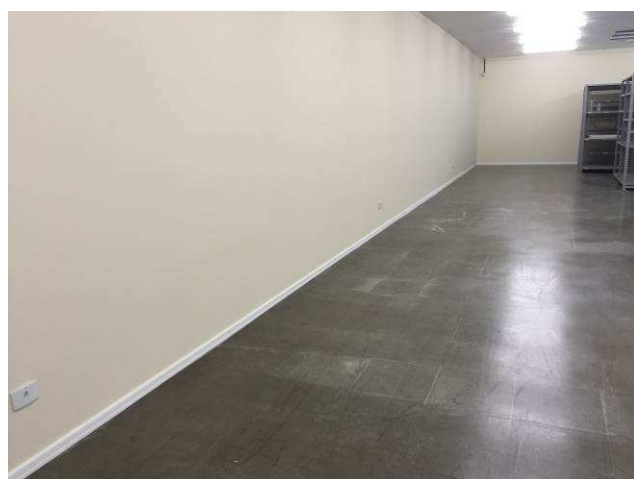
Figura 35C: Pintura interna - sala refrigerada.
