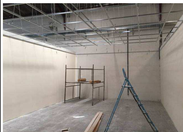
Figura 68C: Paredes de gesso acartonado / pintura interna / montagem do forro - ampliação depósito do RH.
