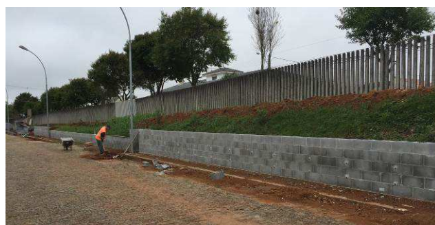
Figura 55C: Alvenaria e cinta superior - trecho B.
