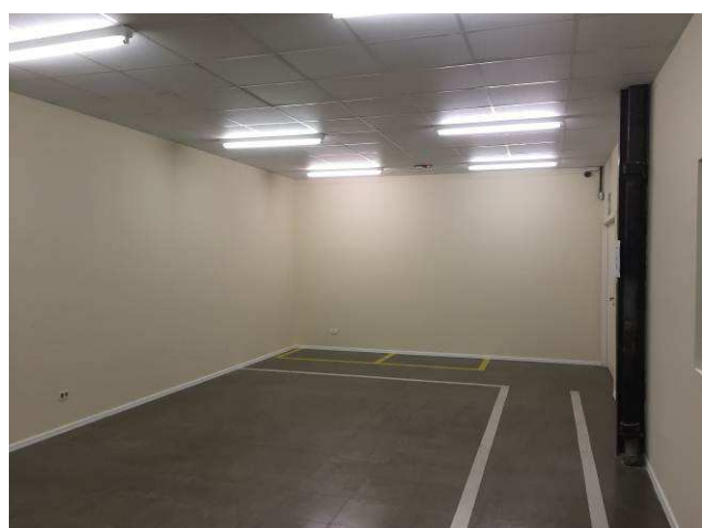
Figura 37C: Pintura interna - sala de reserva.
