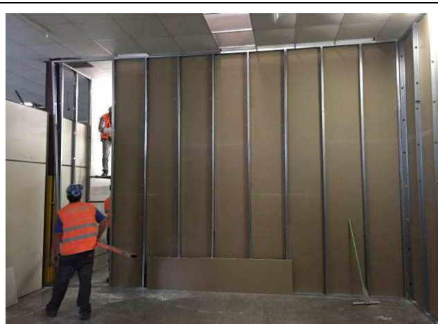
Figura 07C: Parede de divisa do laboratório Service Desk que faz divisa com o arquivo.
