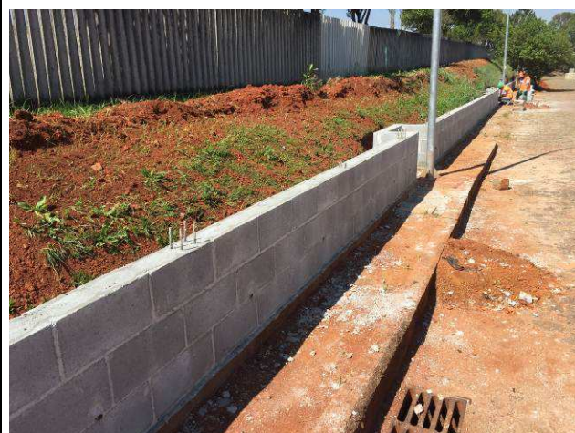
Figura 50C: Alvenaria e cinta superior - trecho A.
