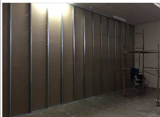
Figura 08C: Parede de divisa do laboratório Service Desk que faz divisa com o arquivo.
