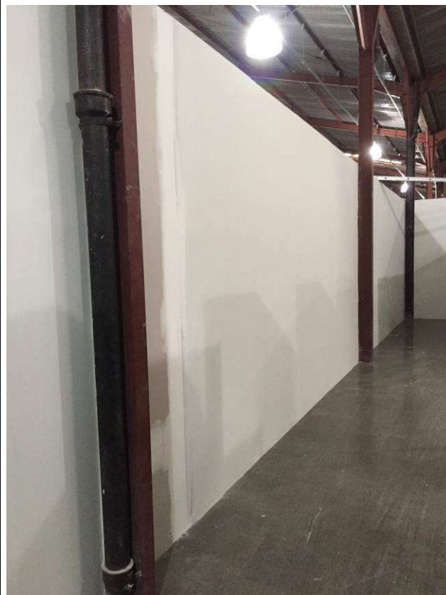
Figura 34C: Pintura interna - ampliação do arquivo.
