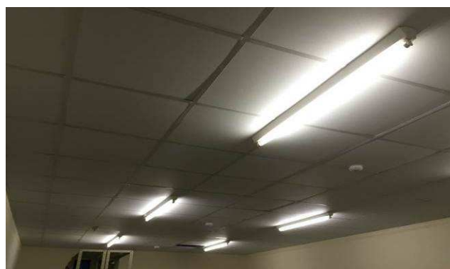
Figura 71C: Forro - ampliação depósito do RH.
