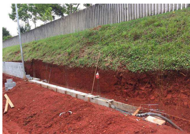
Figura 45C: Viga baldrame - trecho A.
