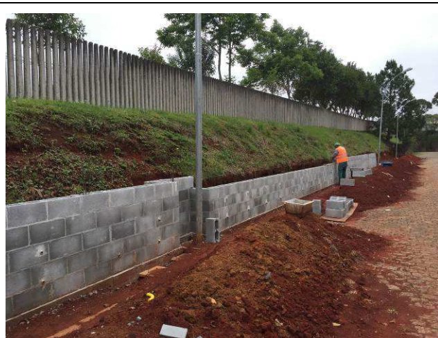
Figura 53C: Alvenaria e cinta superior - trecho B.
