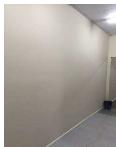
Figura 40C: Pintura interna - parede nova do depósito do RH.
