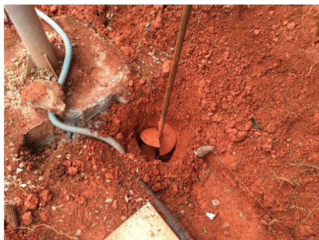
Figura 41C: Escavação das estacas - trecho A.
