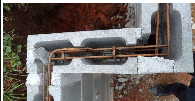
Figura 56C: Armação da canaleta - trecho A.
