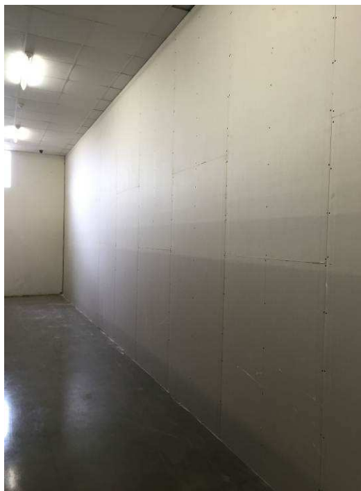
Figura 04C: Parede de divisa do laboratório Service Desk que faz divisa com o arquivo.
