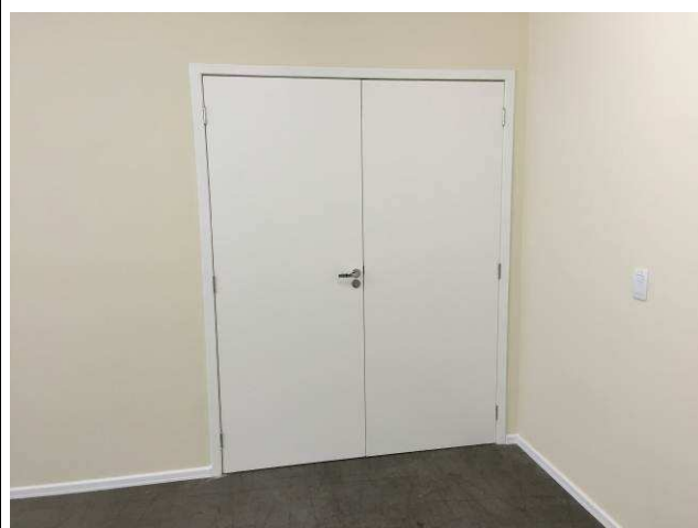
Figura 64C: Porta pintada - sala refrigerada.
