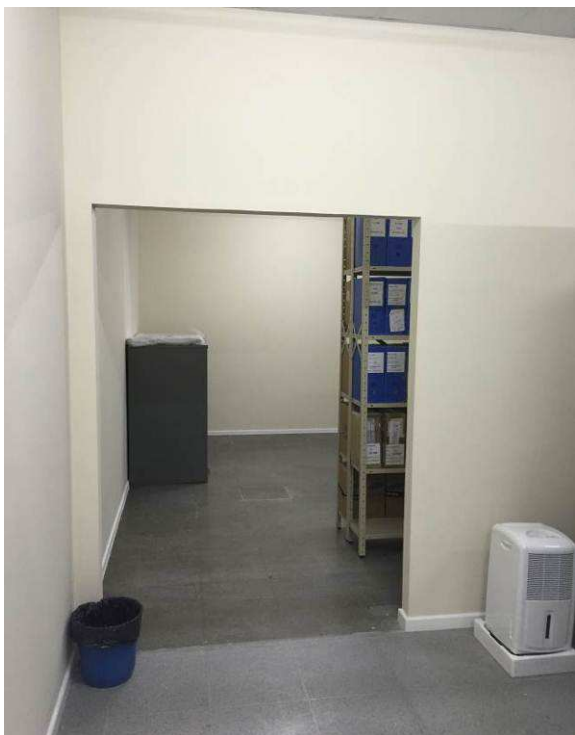
Figura 65C: Abertura entre o depósito do RH existente e sua ampliação.
