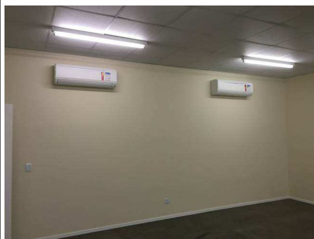
Figura 36C: Pintura interna - sala refrigerada.
