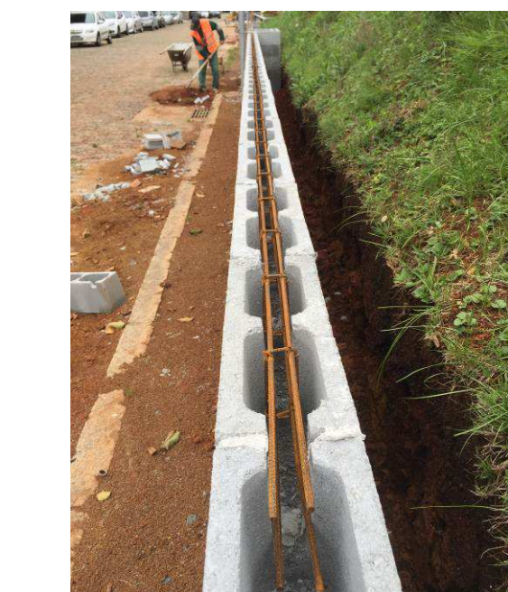
Figura 57C: Armação da canaleta - trecho A.
