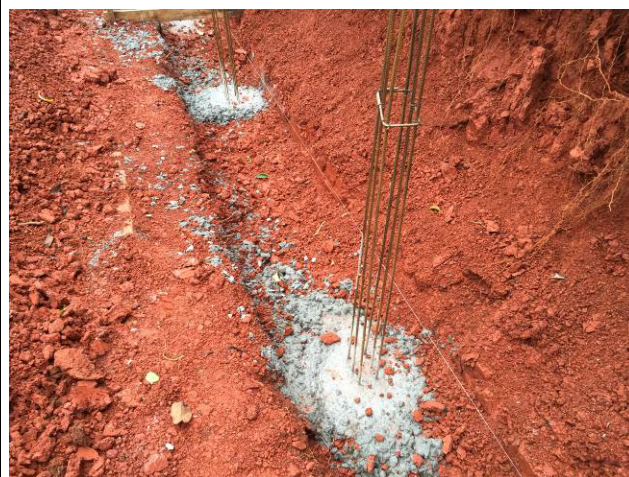
Figura 42C: Estacas concretadas - trecho A.
