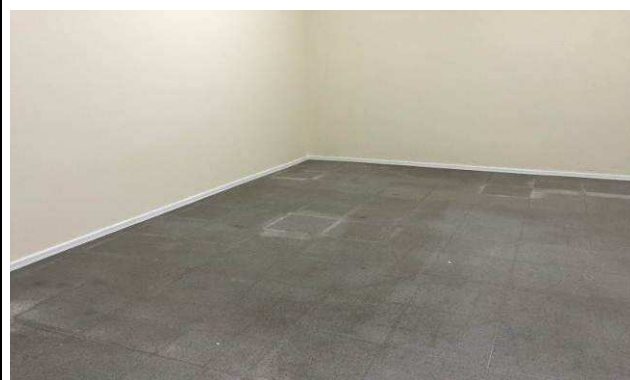
Figura 72C: Paredes de gesso acartonado / pintura interna / rodapé - ampliação depósito do RH.
