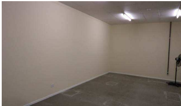
Figura 23E: tomadas elétricas - sala RH.
