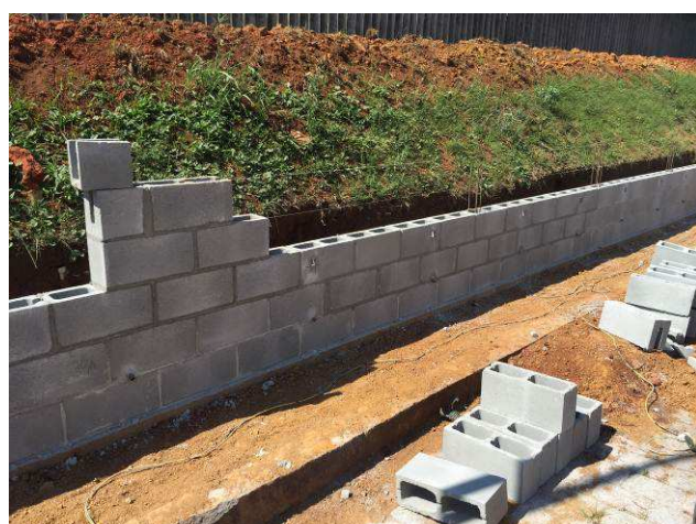
Figura 51C: Alvenaria e cinta superior - trecho B.
