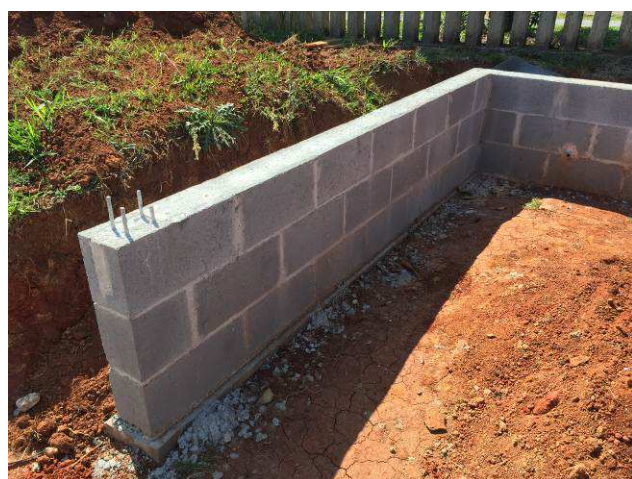
Figura 47C: Alvenaria e cinta superior - trecho A.
