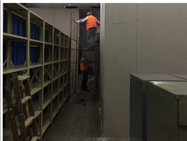
Figura 10C: Parede de divisa do laboratório Service Desk que faz divisa com o arquivo.
