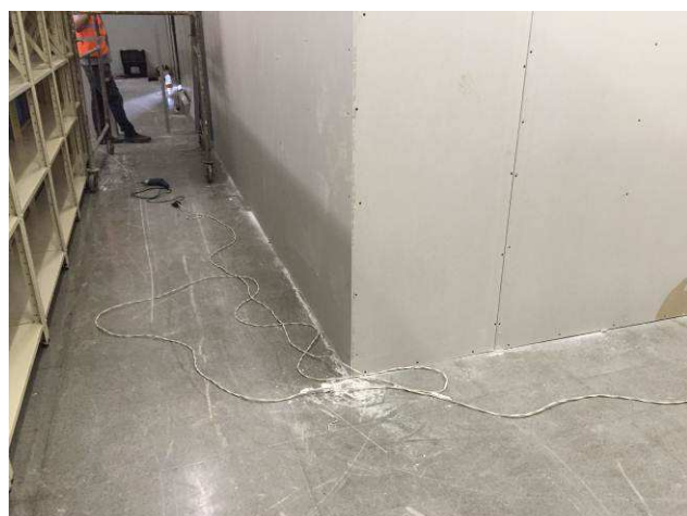
Figura 09C: Parede de divisa do depósito Service Desk que faz divisa com o arquivo.
