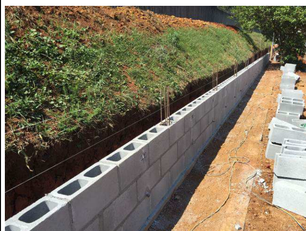
Figura 52C: Alvenaria e cinta superior - trecho B.
