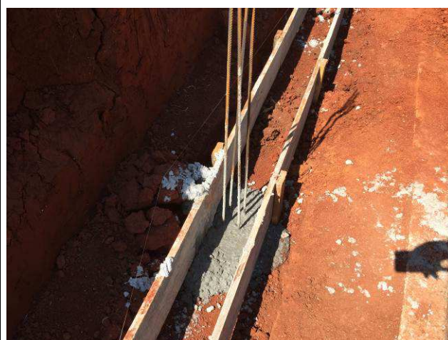
Figura 44C: Formas das vigas baldrame - trecho A.
