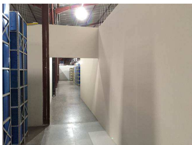
Figura 39C: Pintura externa - parede nova do depósito do RH.
