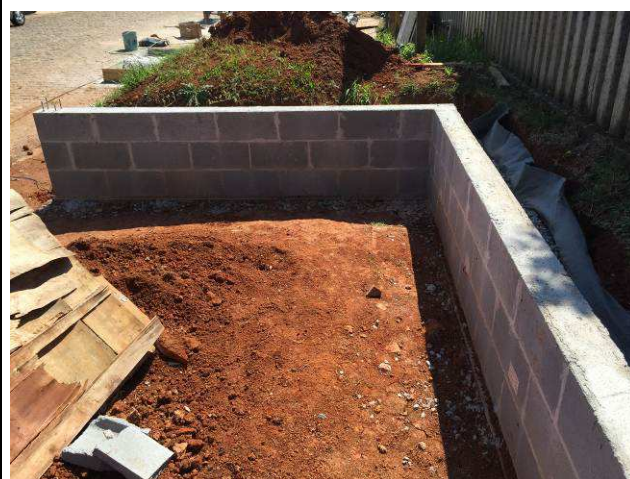
Figura 48C: Alvenaria e cinta superior - trecho A.
