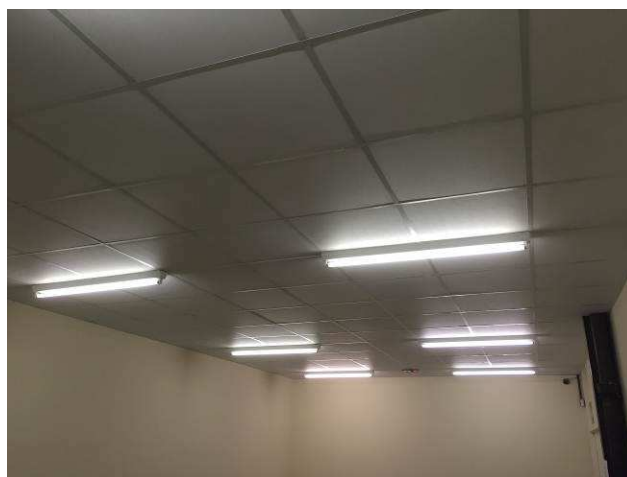
Figura 18C: Forro modular - Sala de Reserva.
