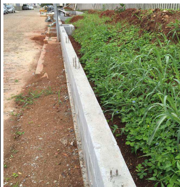
Figura 58C: Concretagem canaleta - trecho A.
