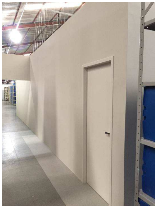
Figura 03C: Nova parede de gesso acartonado do depósito do RH.
