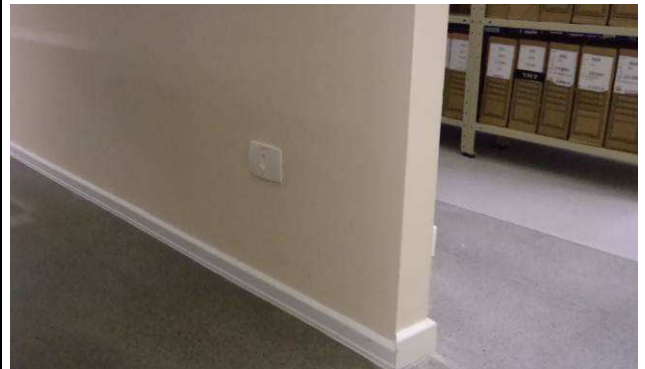
Figura 24E: tomadas elétricas - sala RH.
