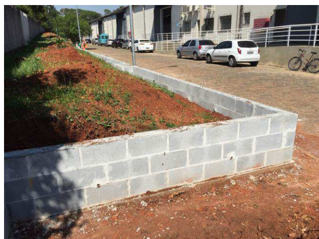
Figura 49C: Alvenaria e cinta superior - trecho A.
