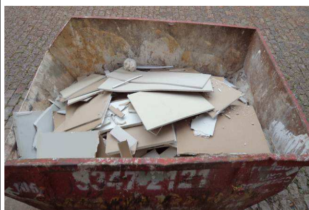
Figura 02C: Caçamba para resíduos de gesso acartonado.
