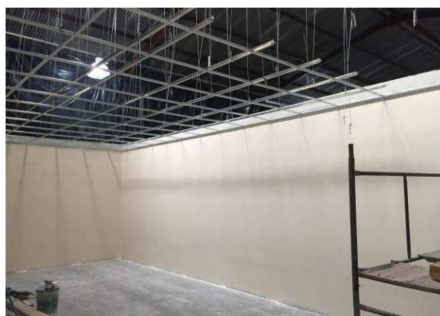
Figura 67C: Paredes de gesso acartonado / pintura interna / montagem do forro - ampliação depósito do RH.
