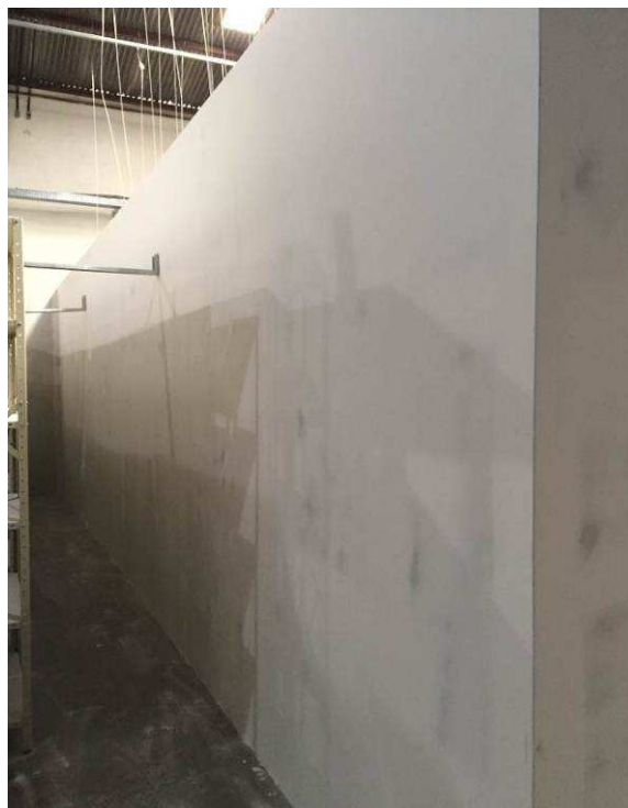
Figura 66C: Paredes de gesso acartonado / emassamento externo - ampliação depósito do RH.
