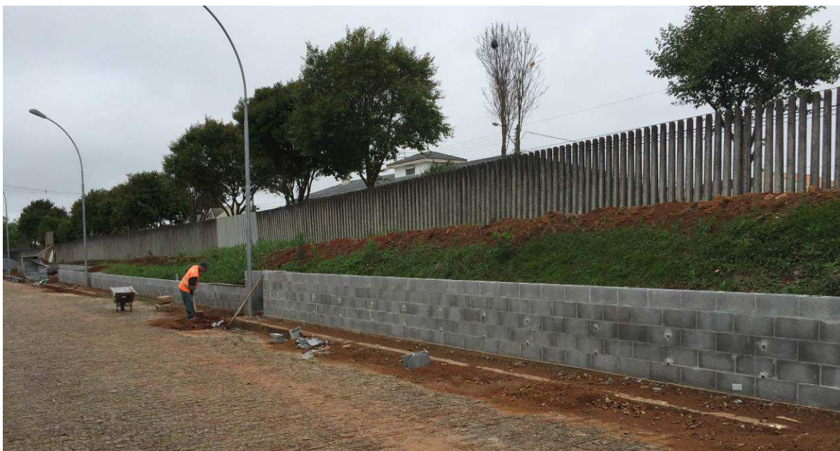
Figura 03 – Muro de arrimo
