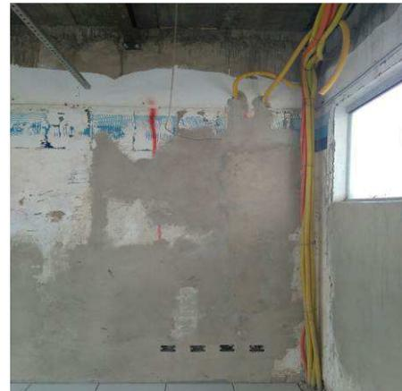
Figura 04E: Infraestrutura - caixas de passagem e eletrodutos - 1º pavimento
