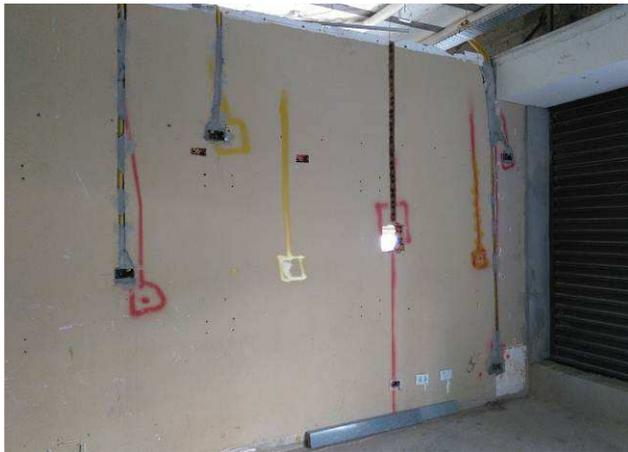
Figura 01E: Infraestrutura - caixas de passagem e eletrodutos - Térreo
