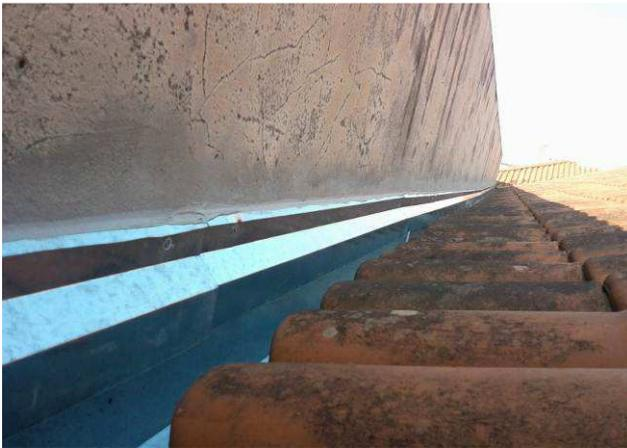
Figura 11C: Rufos instalados nos pontos de fixação da calha com platibanda
