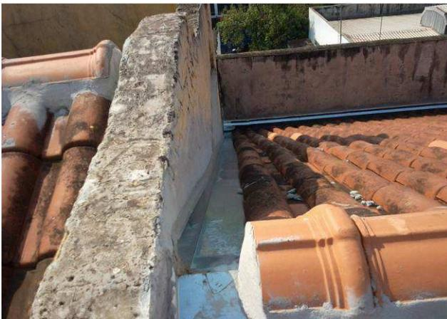
Figura 13C: Rufos instalados nos encontros das telhas com platibandas
