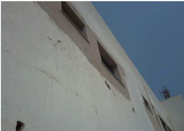
Figura 21C: Detalhe dos vãos adaptados no segundo pavimento, após chapisco, emboço e requadro
