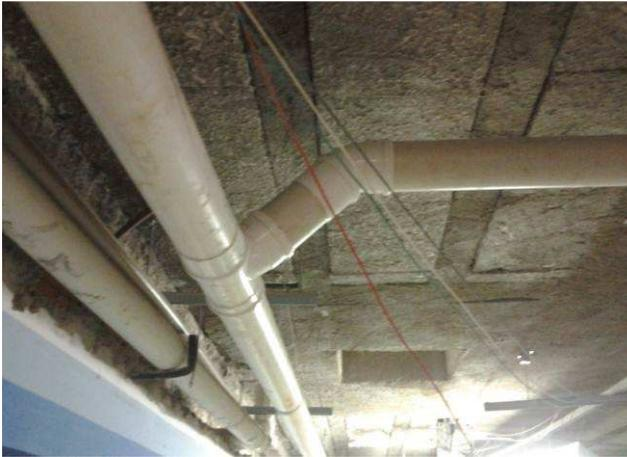
Figura 37C: Tubo de PVC 100mm utilizado na ligação das prumadas à rede coletora
