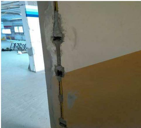
Figura 03E: Infraestrutura - caixas de passagem e eletrodutos - Térreo
