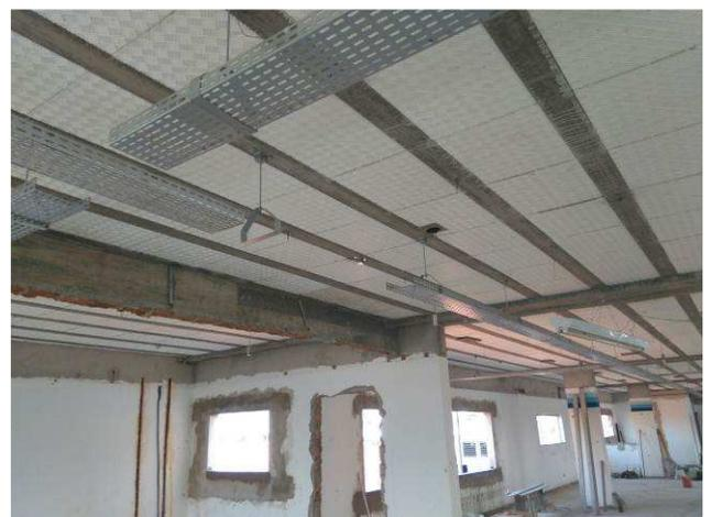
Figura 15E: Infraestrutura - eletrocalhas e perfilados - 1º pavimento
