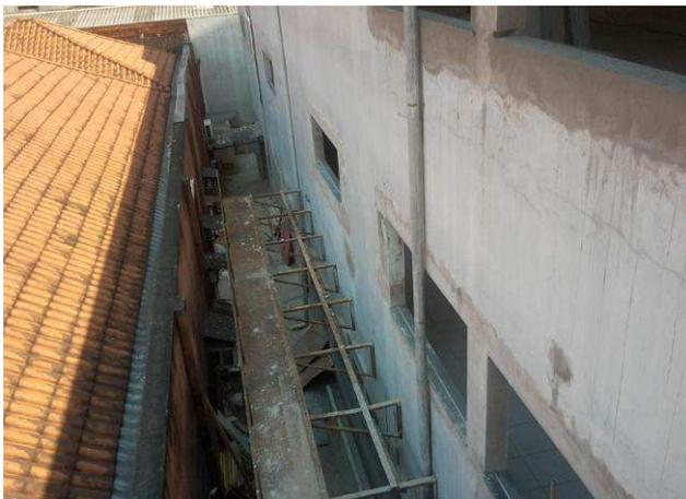
Figura 29C: Peitoris instalados no primeiro e segundo pavimentos
