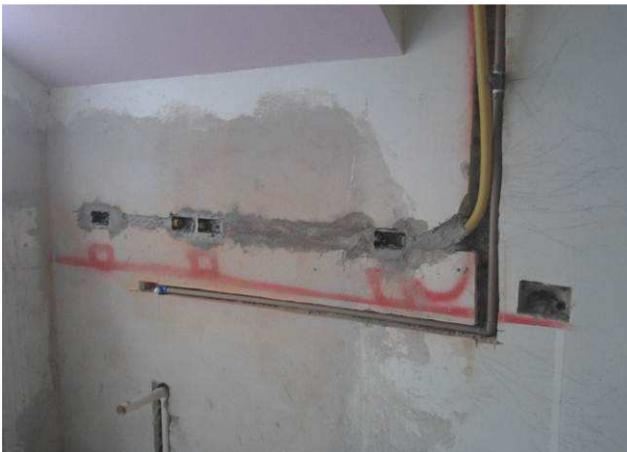
Figura 41C: ponto de água fria localizado no pavimento térreo - copa dos terceirizados
