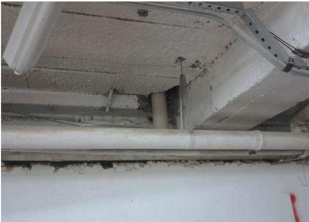
Figura 39C: Tubulação de ligação do esgoto predial à rede coletora
