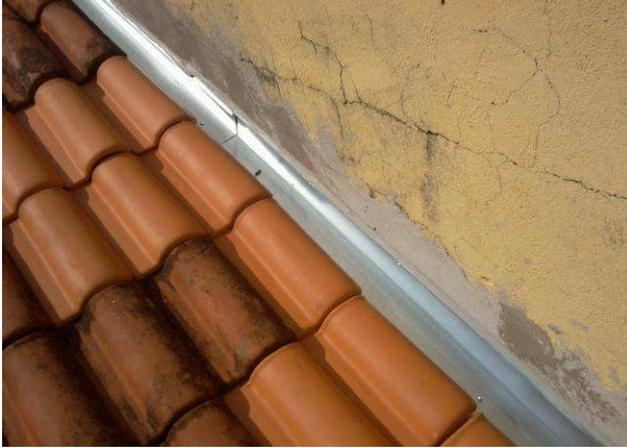
Figura 09C: Rufos instalados nos encontros das telhas com platibandas
