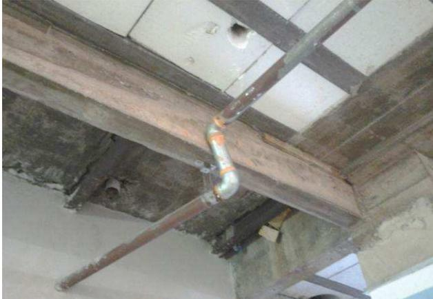
Figura 65C: detalhe das adaptações feitas nas tubulações para remanejamento de abrigos
