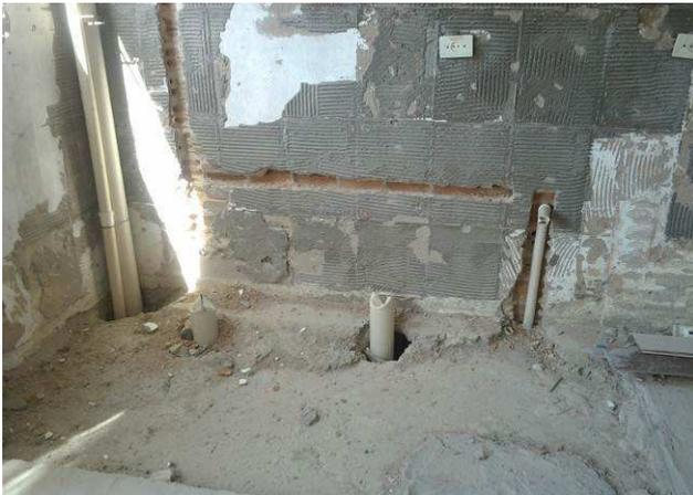
Figura 05C: Furos em laje, para passagem de tubulações de esgoto
