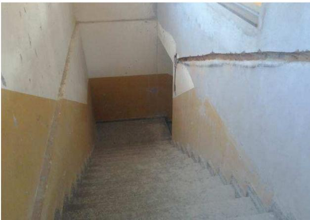
Figura 07C: Remoção do corrimão da escada de acesso ao primeiro pavimento
