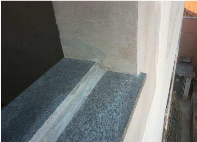
Figura 27C: Detalhe de peitoril instalado no primeiro pavimento
