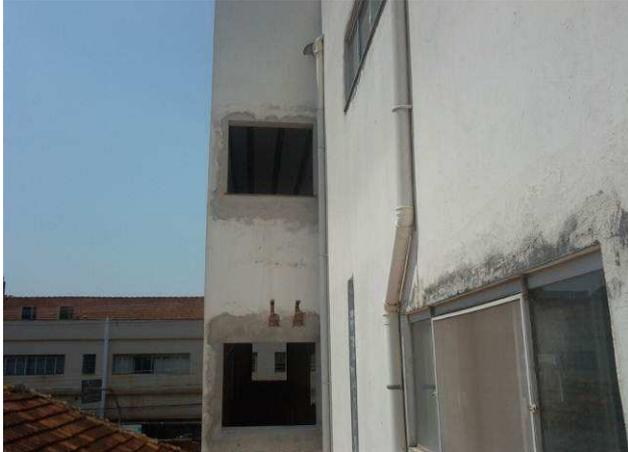
Figura 19C: Requadro de janelas no primeiro e segundo pavimentos
