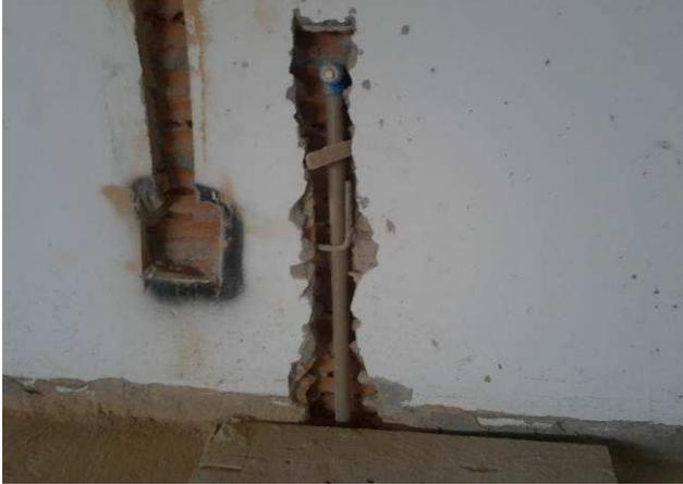
Figura 03C: Furos em laje, para passagem de tubulações de água fria
