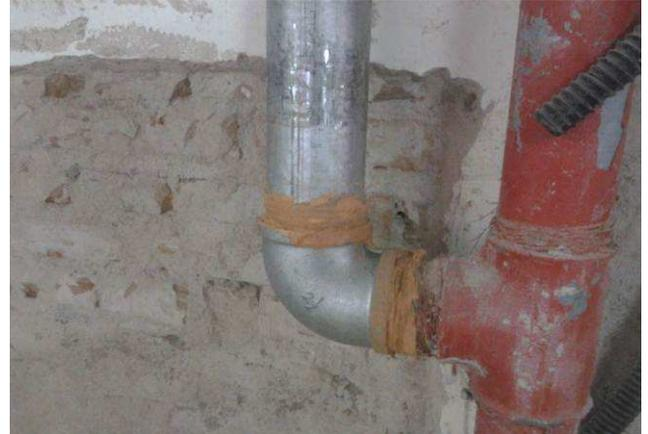
Figura 66C: Figura 65C: detalhe das adaptações feitas nas tubulações para remanejamento de abrigos
