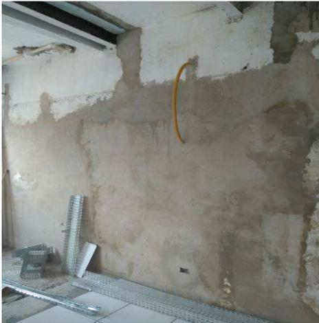
Figura 05E: Infraestrutura - caixas de passagem e eletrodutos - 1º pavimento
