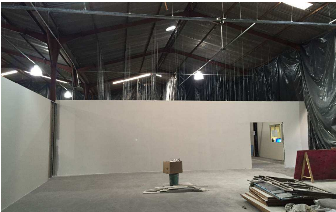
Figura 01 – Paredes de gesso acartonado - Ampliação Arquivo e Sala Refrigerada.
