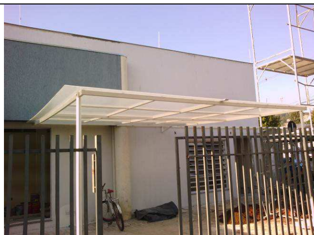
Figura 23C: Cobertura em policarbonato - vaga de estacionamento da 2ª VT.
