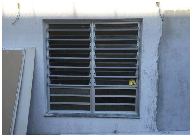
Figura 13C: Janela JA2E reinstalada no gabinete da juíza da 2ª VT.
