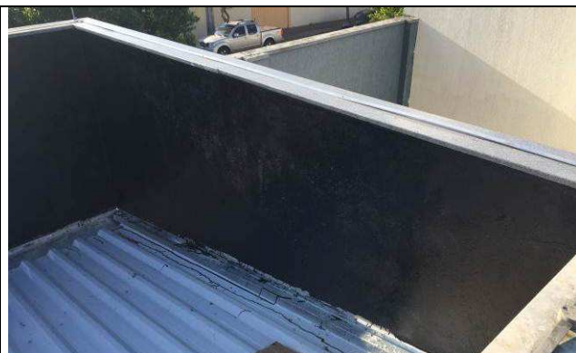
Figura 36C: Impermeabilização da platibanda da área da ampliação.
