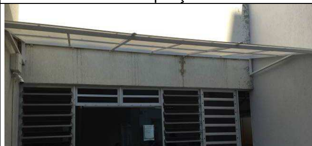
Figura 101C: Pintura esmalte nas estruturas metálicas de cobertura.
