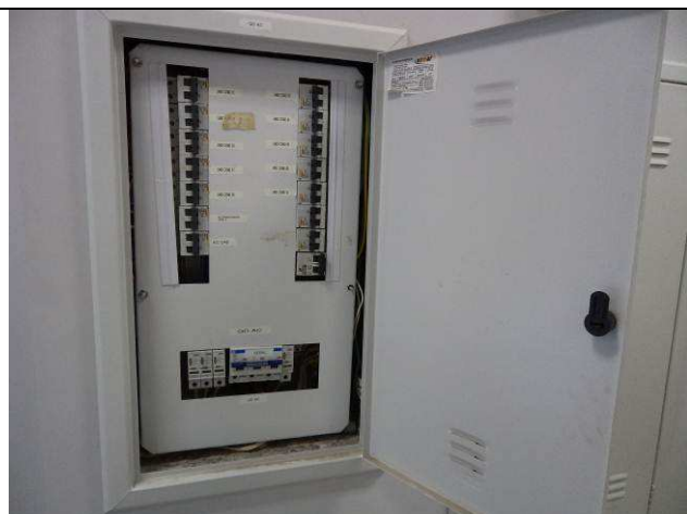
Figura 49E: intervenção quadro elétrico QDAC.
