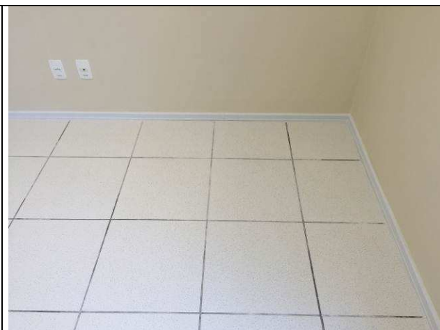
Figura 54C: Rodapé em poliestireno.
