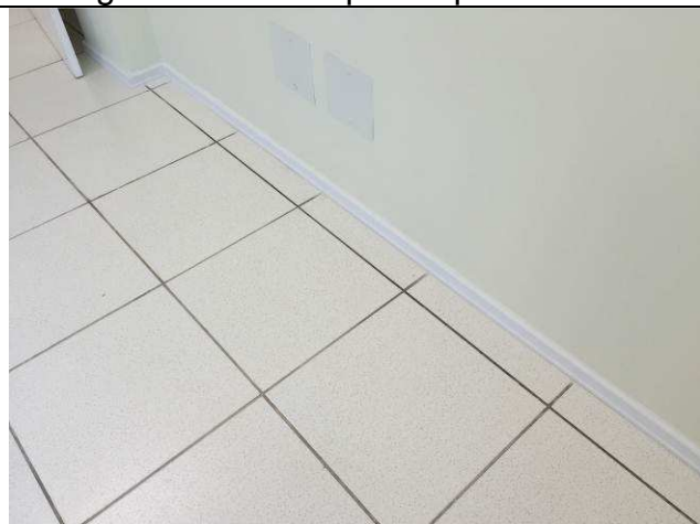
Figura 55C: Rodapé em poliestireno.
