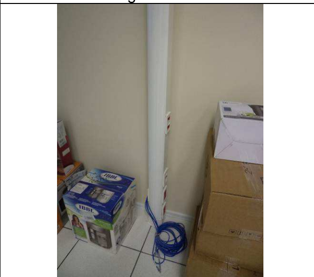
Figura 32E: colunas técnicas Dutotec.
