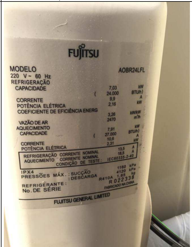
Figura 80C: Condensadora AOB24LFL - 24.000 BTU's.
