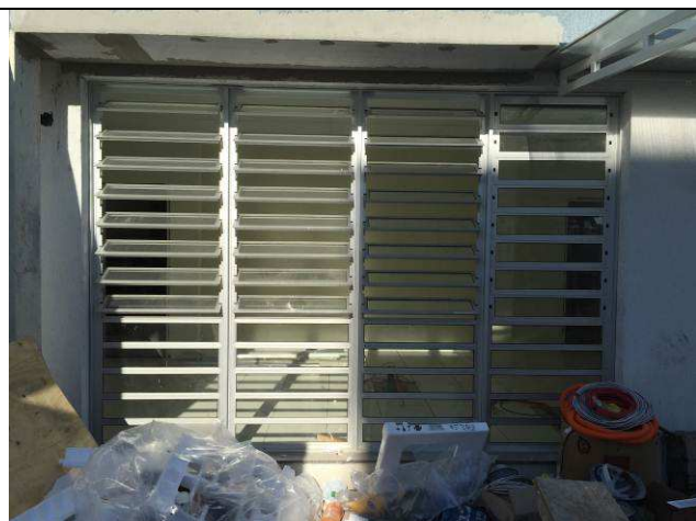
Figura 11C: Janela JA1E reinstalada na sala de audiências da 2ª VT.
