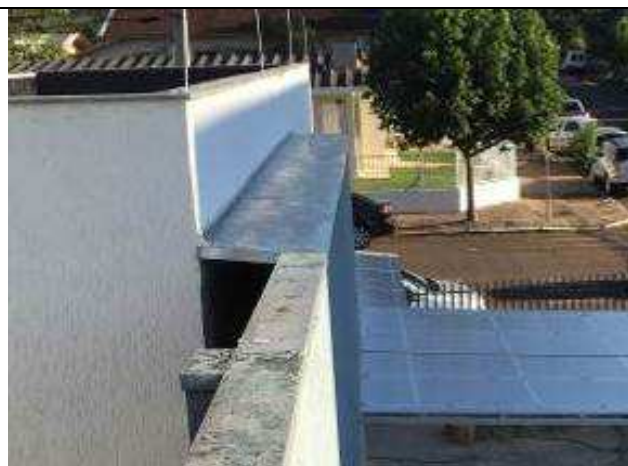
Figura 29C: Rufo instalado entre o pórtico da entrada e a fachada externa da área da ampliação.
