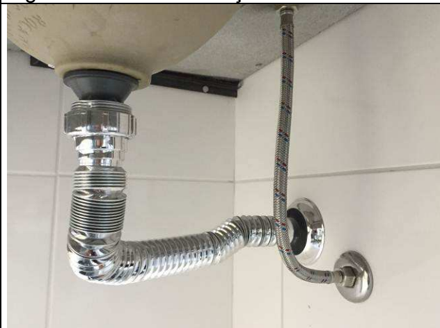
Figura 68C: Lavatório em granito - engate com malha inox e sifão cromado.
