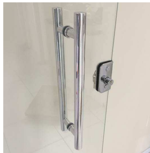
Figura 08C: Porta de vidro PV02, com mola de piso e acessórios cromados.
