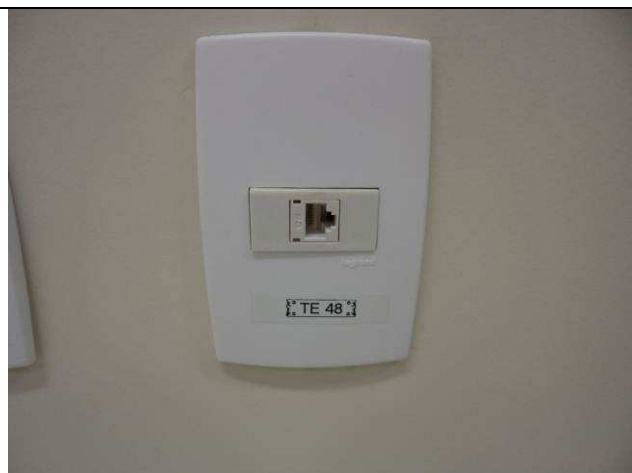
Figura 63E: conectores RJ45.
