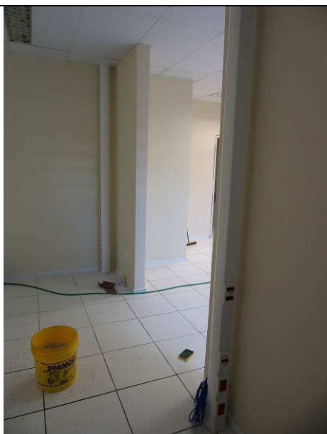
Figura 33E: colunas técnicas Dutotec, porta equipamentos e tomadas.
