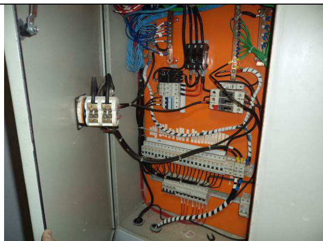
Figura 51E: intervenção quadro elétrico QDE.
