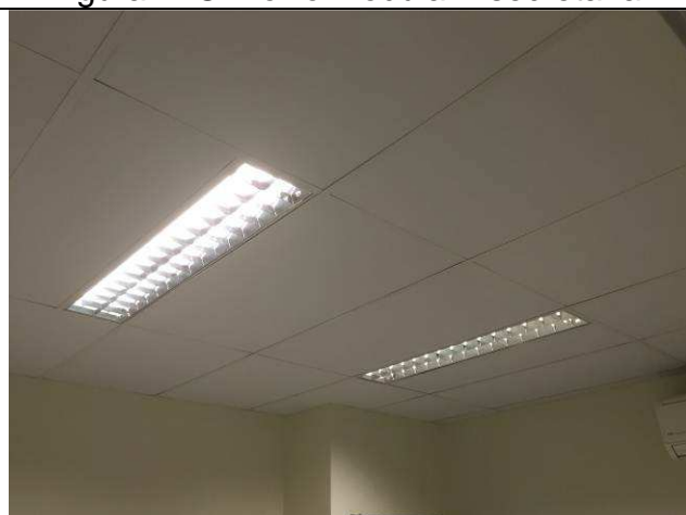
Figura 43C: Forro modular - sala de conciliação.
