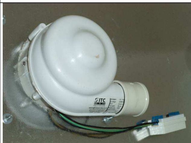
Figura 47E: exaustor banheiro gabinete.
