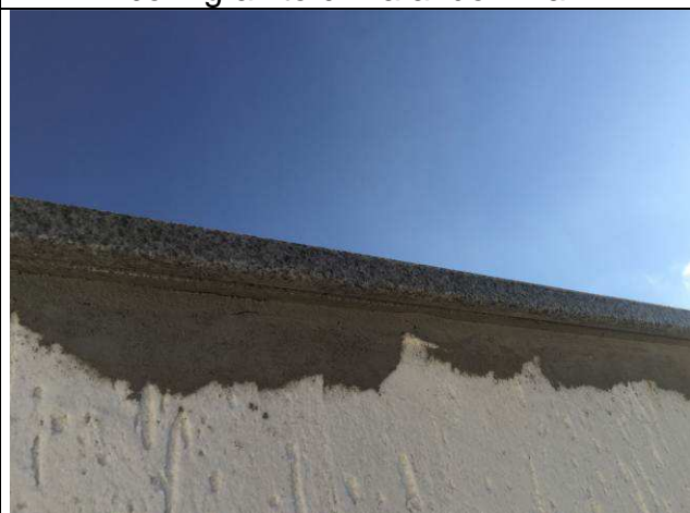
Figura 34C: Capeamento da platibanda com granito cinza andorinha.
