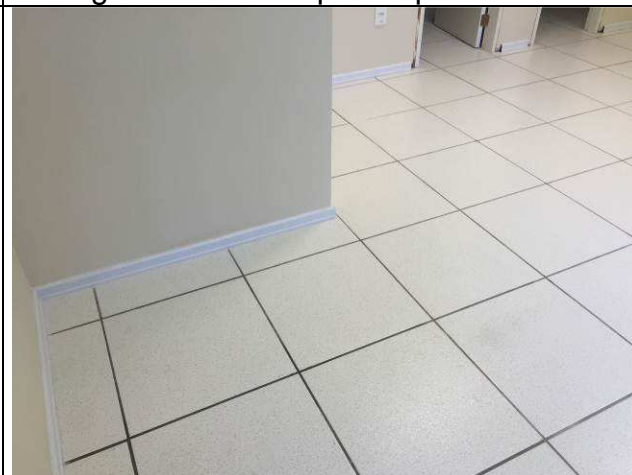
Figura 56C: Rodapé em poliestireno.
