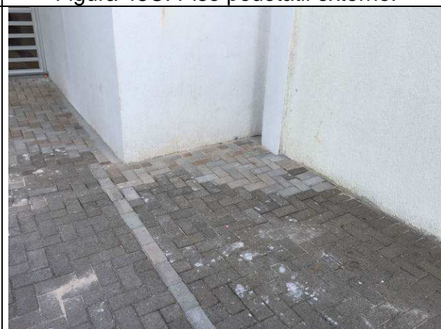
Figura 50C: Recomposição do paver.
