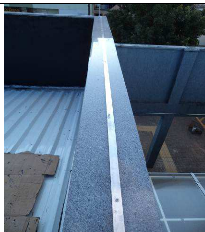
Figura 66E: fitas sobre a platibanda - Gaiola de Faraday.
