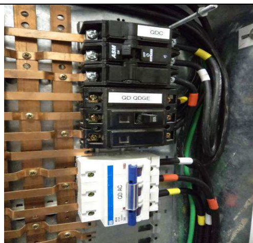
Figura 50E: intervenção quadro elétrico QDGFL.
