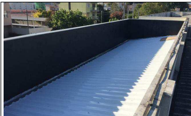
Figura 35C: Impermeabilização da platibanda da área da ampliação.
