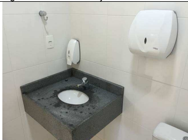
Figura 67C: Lavatório com tampo em granito e acessórios - bwc secretaria.
