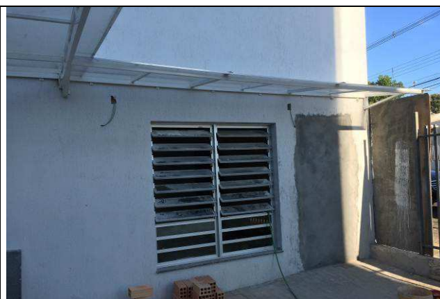
Figura 100C: Aplicação de grafiato na área da ampliação.
