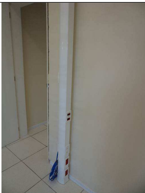
Figura 35E: colunas técnicas Dutotec, porta equipamentos e tomadas.
