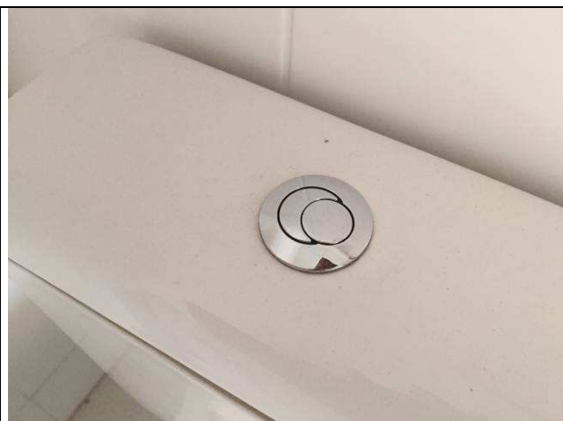
Figura 60C: Caixa acoplada - duplo botão de acionamento.
