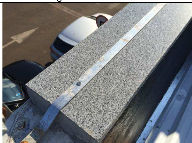
Figura 33C: Capeamento da platibanda com granito cinza andorinha.
