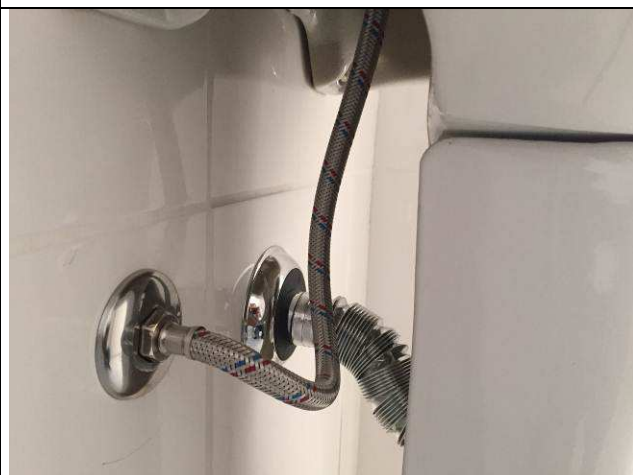
Figura 64C: Lavatório com coluna - engate com malha inox e sifão cromado.
