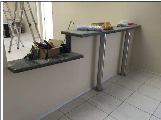
Figura 03C: Balcão de atendimento em granito da 2ª VT.
