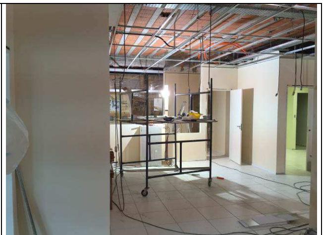
Figura 02C: Andaime utilizado para execução do forro.
