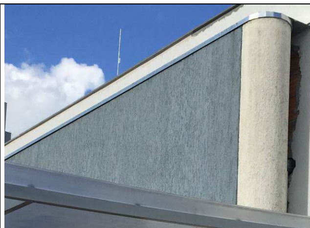
Figura 30C: Rufo instalado entre o pórtico da entrada e a fachada externa da área da ampliação.
