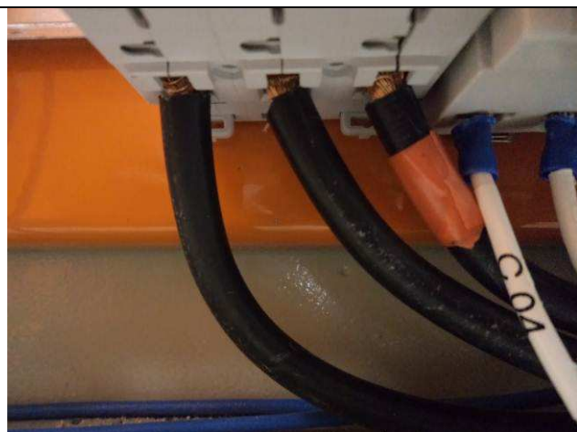
Figura 21E: ramal alimentador QDC.
