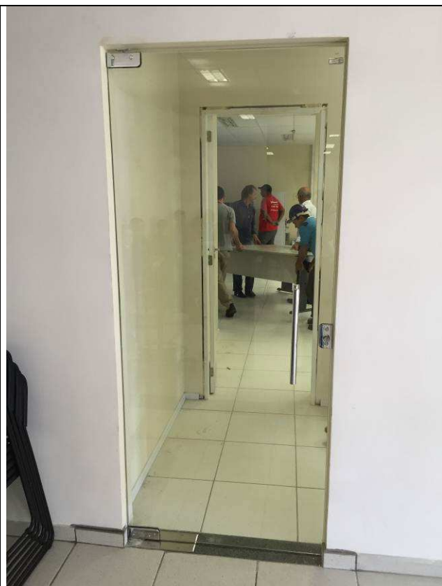
Figura 07C: Porta de vidro PV02, com ferragens e puxadores cromados.
