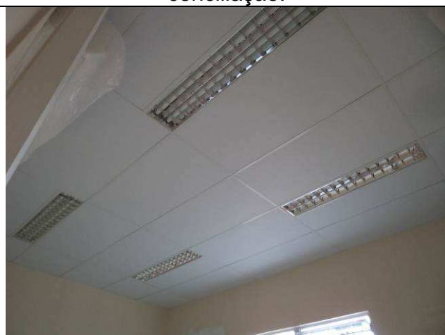
Figura 45C: Forro modular - gabinete do juiz.
