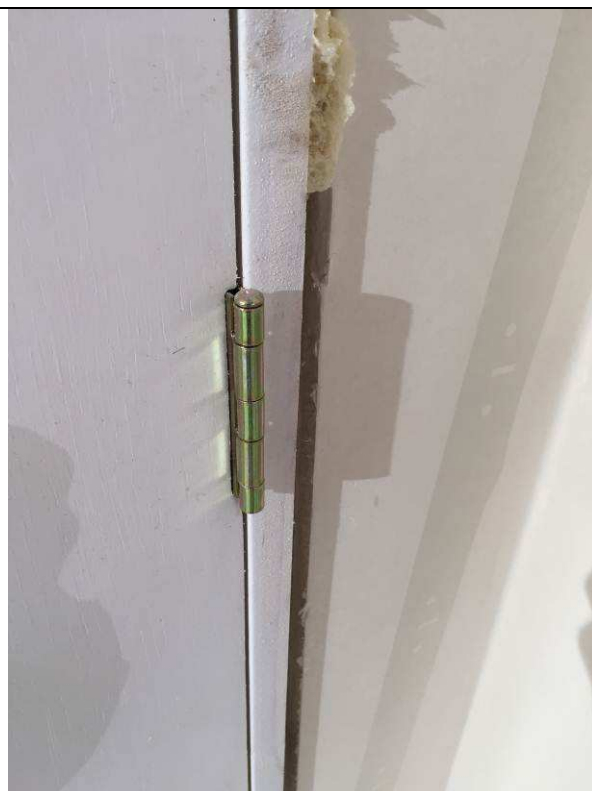
Figura 06C: Portas de madeira recusadas pela fiscalização por não atenderem às especificações e apresentarem baixa qualidade.
