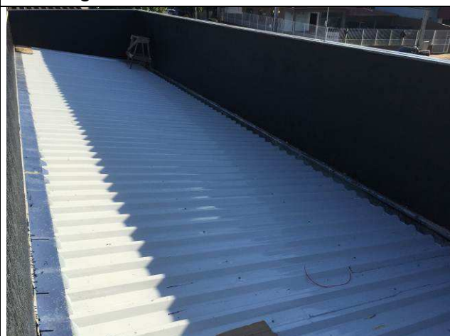
Figura 28C: Rufos instalados na cobertura.
