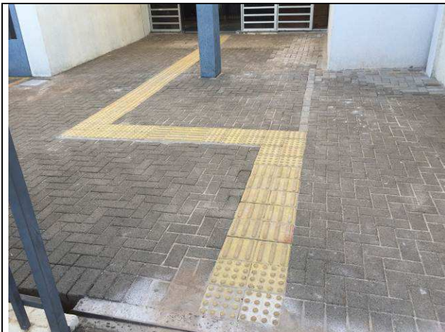
Figura 47C: Piso podotátil externo.
