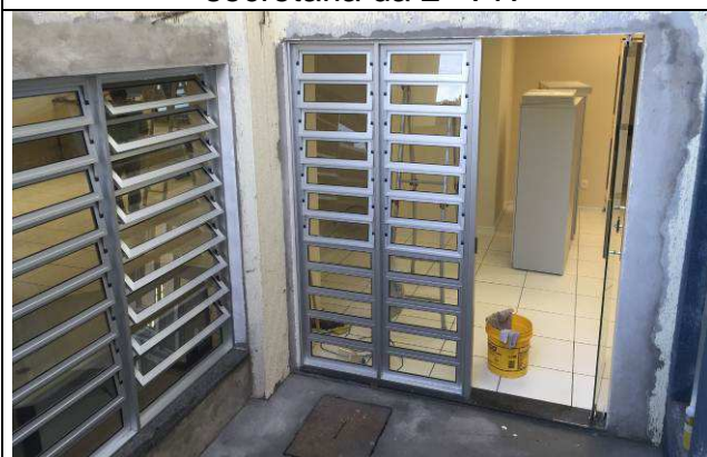
Figura 19C: Janelas PJA1 e JA3 instaladas na secretaria da 2ª VT.
