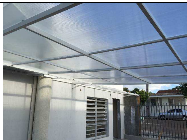
Figura 24C: Cobertura em policarbonato - vaga de estacionamento da 2ª VT.
