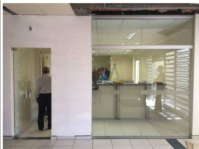
Figura 09C: Painéis de vidro VT1 reinstalados na área do balcão de atendimento da 2ª VT.
