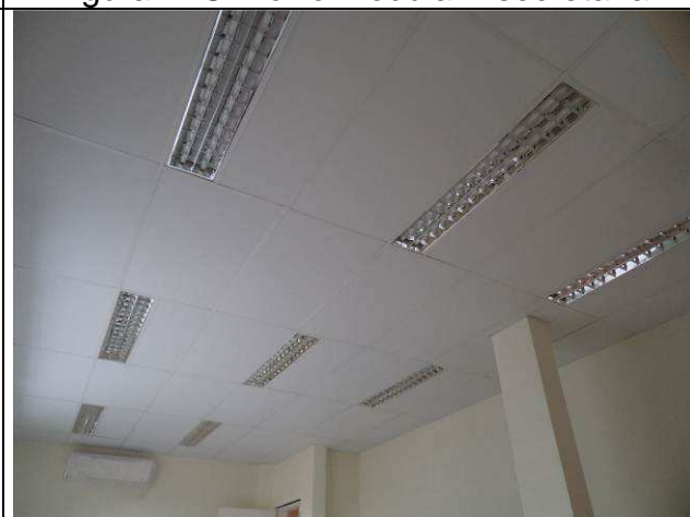
Figura 44C: Forro modular - sala de audiências.
