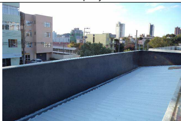
Figura 31C: Capeamento da platibanda com granito cinza andorinha.
