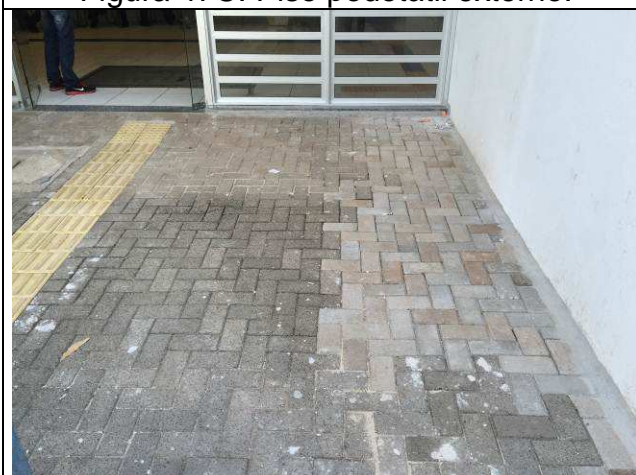
Figura 49C: Recomposição do paver.
