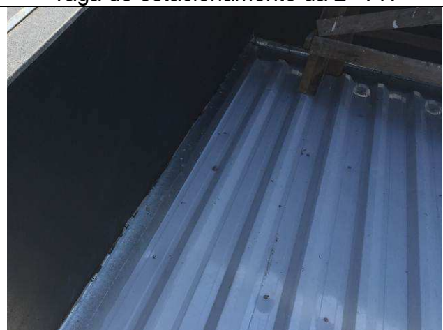
Figura 27C: Rufos instalados na cobertura.
