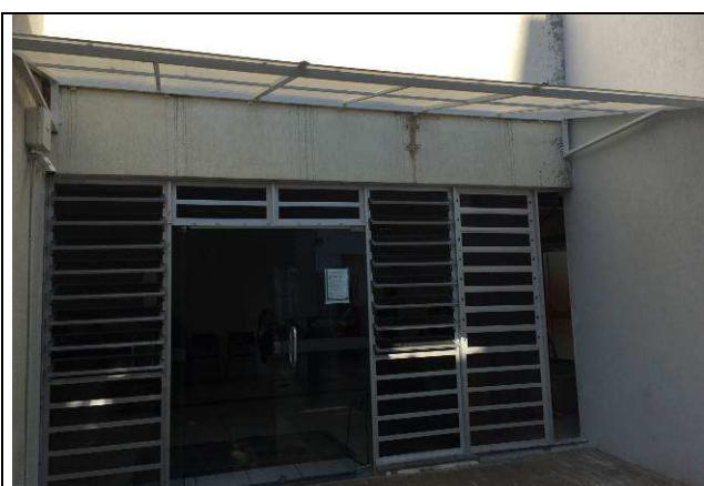
Figura 21C: Cobertura em policarbonato - hall de entrada do Fórum.
