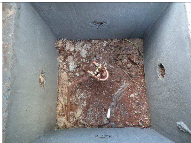
Figura 65E: malha de aterramento - caixa de inspeção.
