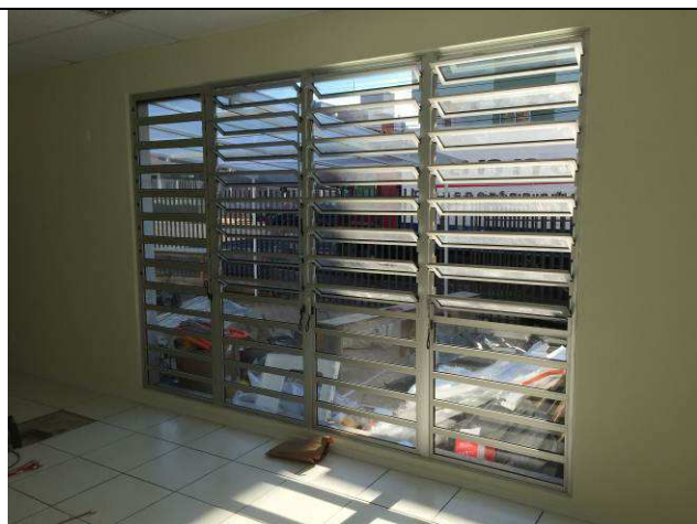
Figura 12C: Janela JA1E reinstalada na sala de audiências da 2ª VT.
