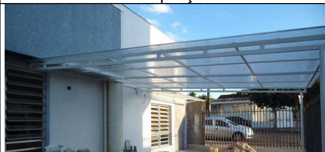
Figura 102C: Pintura esmalte nas estruturas metálicas de cobertura.
