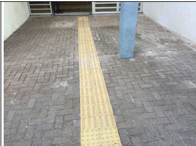
Figura 48C: Piso podotátil externo.
