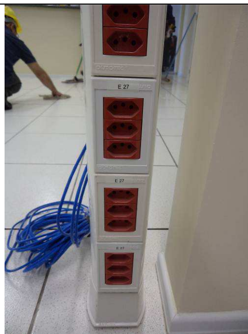
Figura 36E: colunas técnicas Dutotec, porta equipamentos e tomadas.
