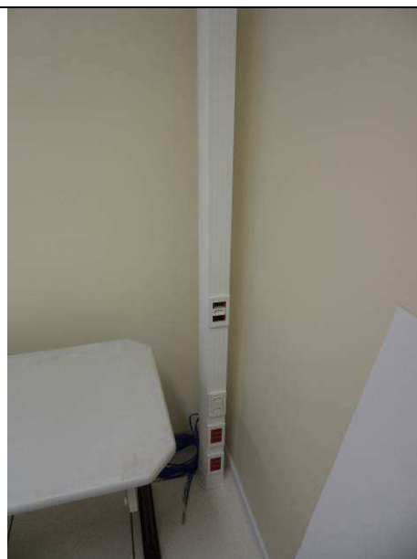
Figura 34E: colunas técnicas Dutotec, porta equipamentos e tomadas.
