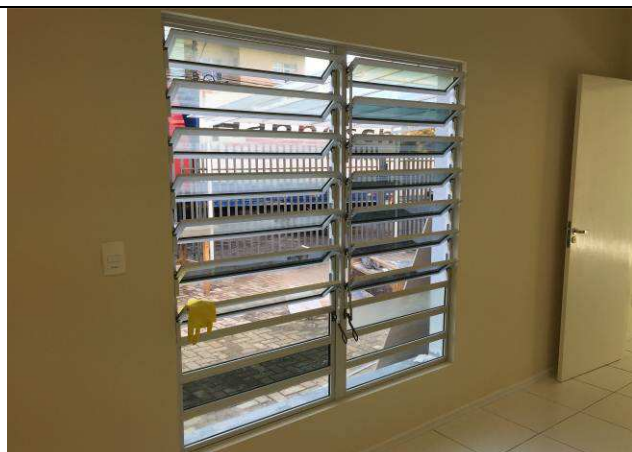
Figura 14C: Janela JA2E reinstalada no gabinete da juíza da 2ª VT.
