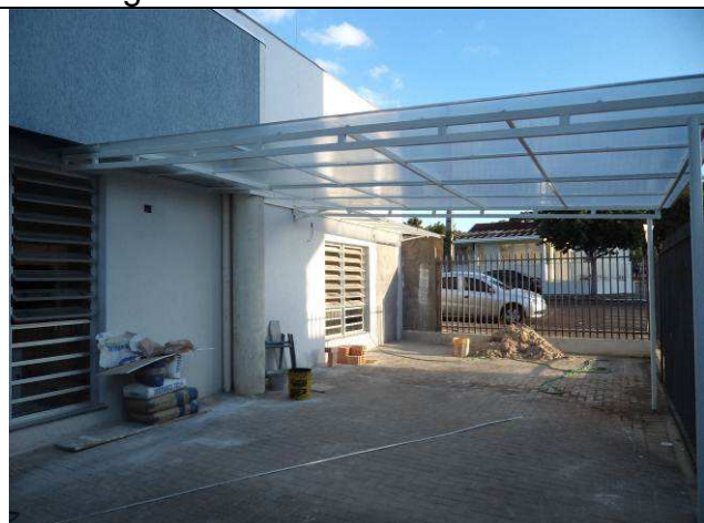
Figura 25C: Cobertura em policarbonato - vaga de estacionamento da 2ª VT.
