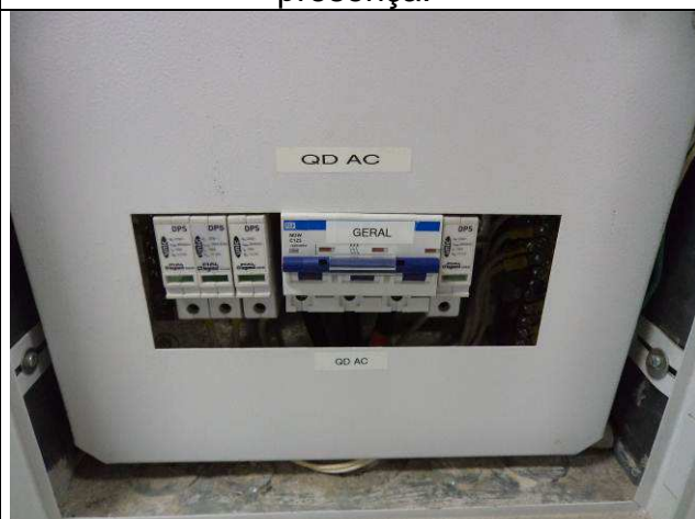
Figura 48E: intervenção quadro elétrico QDAC.
