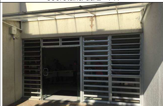
Figura 20C: Janela JA4 instalada na entrada do Fórum.
