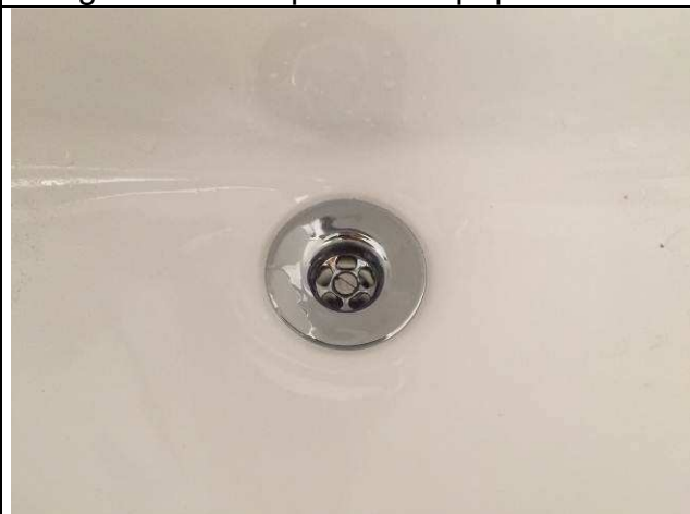
Figura 74C: Válvulas de lavatório.
