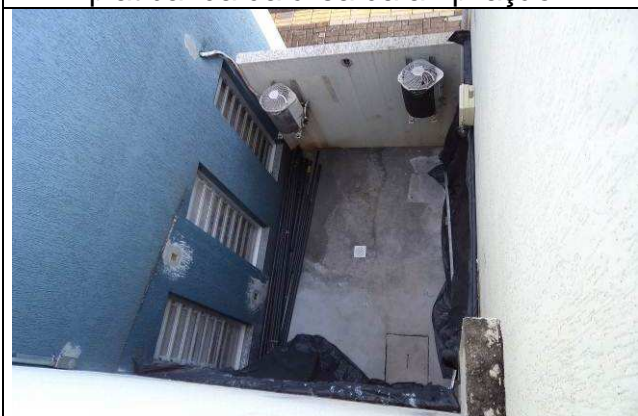
Figura 37C: Impermeabilização do jardim interno da 2ª VT.
