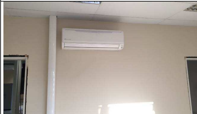
Figura 81C: Condensadora AOBR30LFT - 30.000 BTU's.
