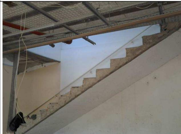
Figura 84C: Escada de acesso ao segundo pavimento, com corrimão removido do lado direito
