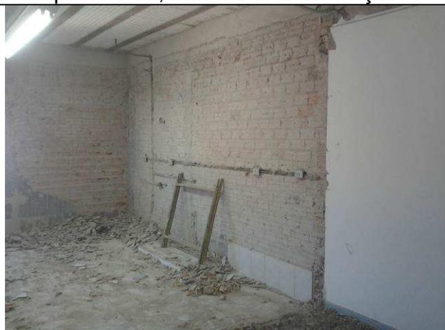
Figura 71C: Copa após demolição dos azulejos
