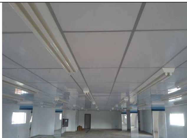
Figura 65C: Forro existente no segundo pavimento, antes de sua remoção
