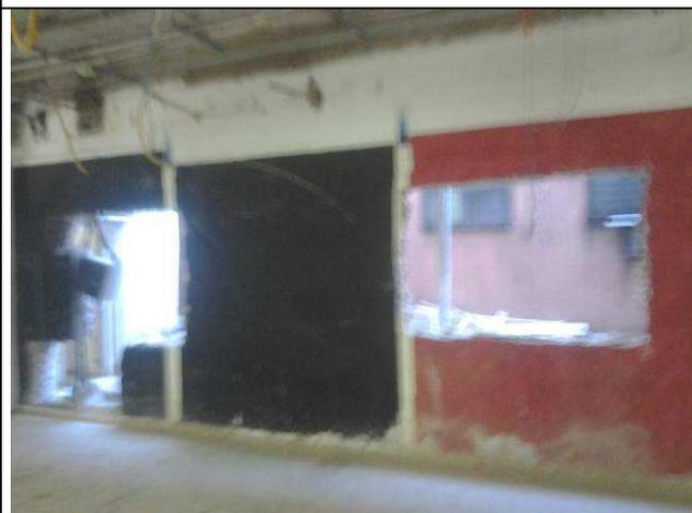
Figura 18C: Abertura de vão para instalação de janela
