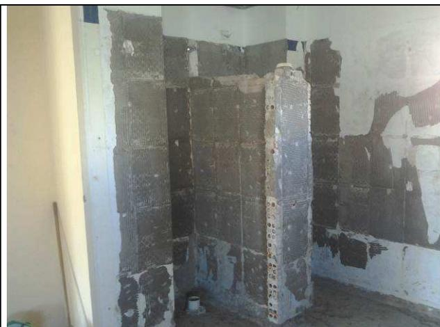
Figura 16C: Bwc no térreo, já com azulejos demolidos
