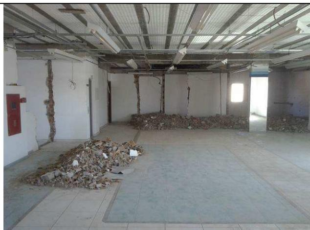
Figura 81C: Portas de madeira removidas na área dos sanitários
