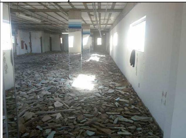
Figura 68C: Segundo pavimento, após remoção parcial do piso
