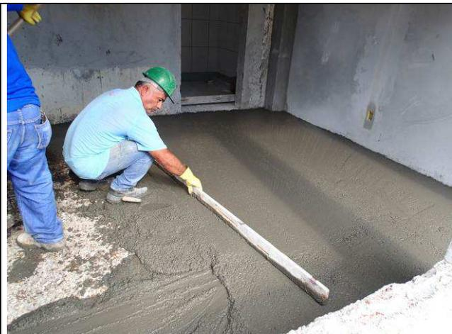
Figura 50C: Execução de lastro de concreto na área da ampliação.
