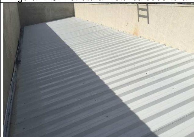
Figura 26C: Cobertura em telha metálica.
