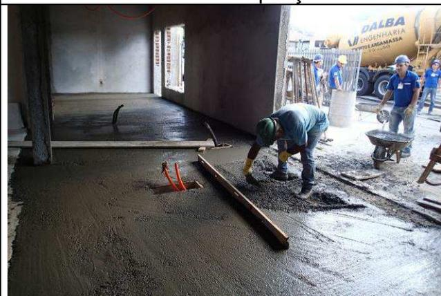
Figura 52C: Execução de lastro de concreto na área da ampliação.
