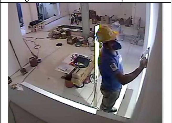
Figura 87C: Lixamento das paredes.
