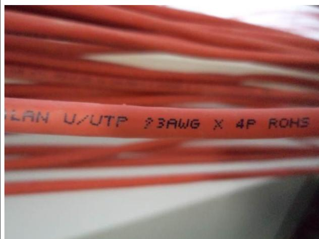
Figura 24E: cabeamento estruturado cat 6 UTP Furukawa.
