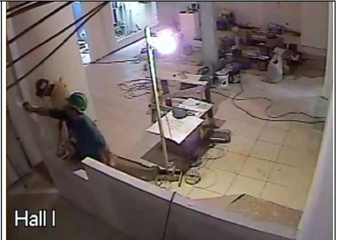
Figura 83C: Emassamento das paredes.
