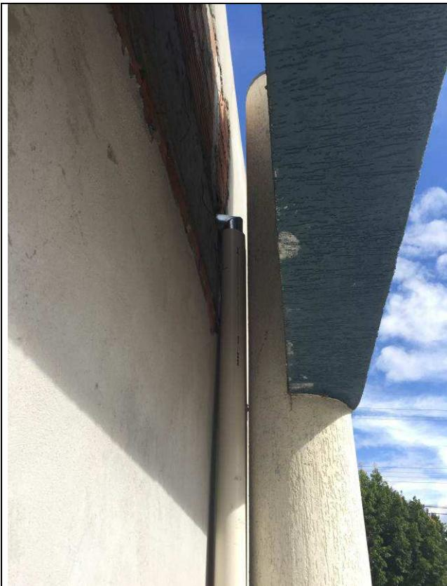
Figura 72C: Captação, condução de águas pluviais da ampliação.
