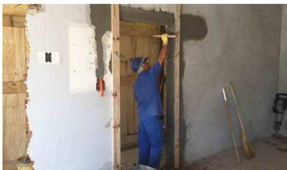
Figura 48C: Requardos de vãos de alvenaria.
