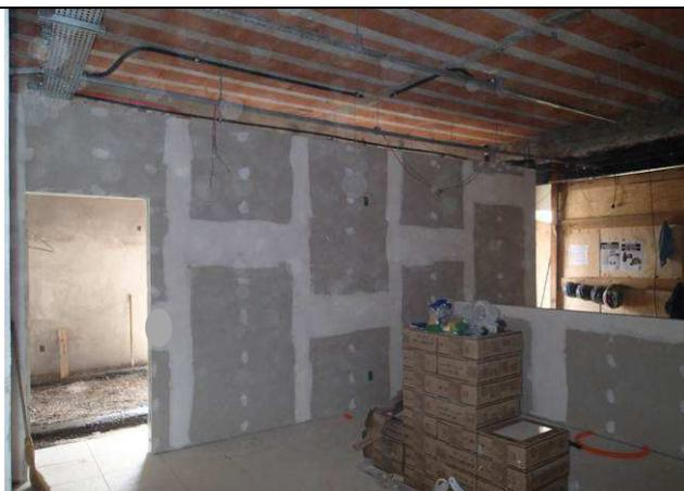
Figura 15C: Paredes de gesso acartonado ST dupla – sala de audiências.
