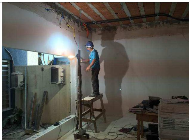
Figura 89C: Lixamento das paredes.
