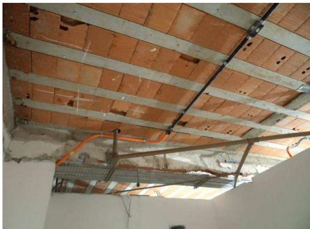
Figura 09E: Infraestrutura instalações elétricas - eletrodutos rígidos e corrugados.
