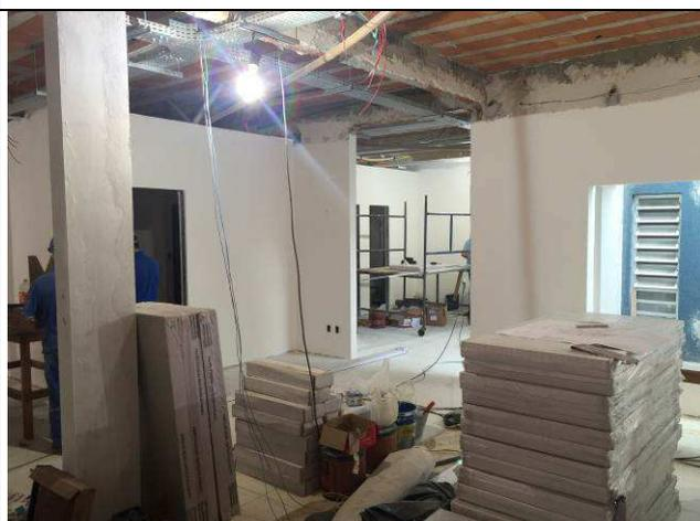
Figura 93C: Paredes emassadas e lixadas.
