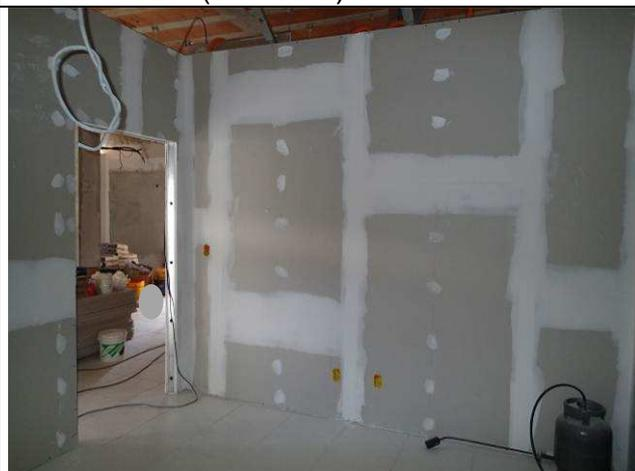
Figura 11C: Paredes de gesso acartonado ST dupla – sala de acordo.
