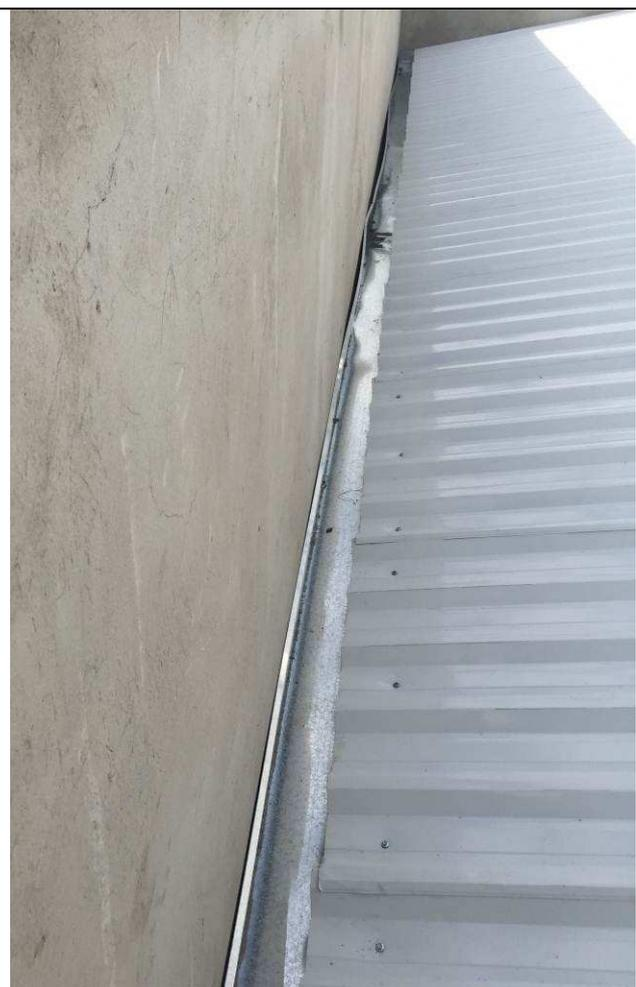
Figura 29C: Calha em aço galvanizado.
