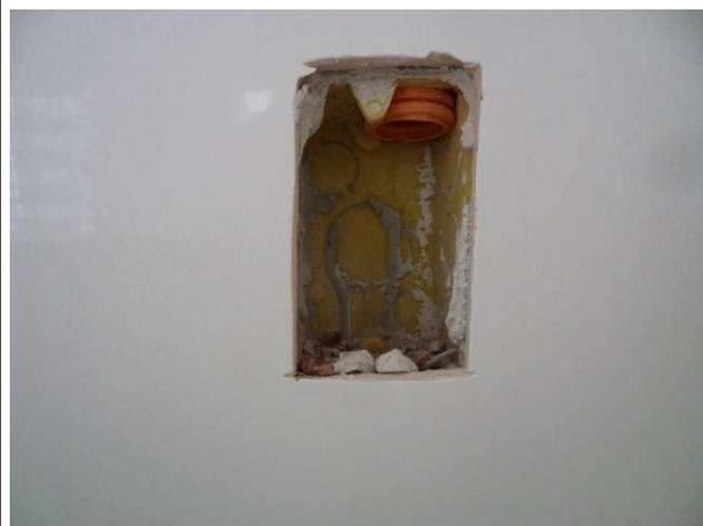
Figura 04E: Infraestrutura instalações elétricas - caixas 2x4" e eletrodutos corrugados.
