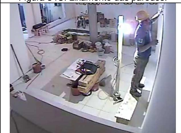
Figura 86C: Lixamento das paredes.
