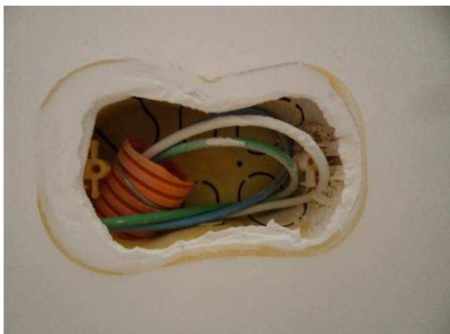
Figura 05E: Infraestrutura instalações elétricas - caixas 2x4" drywall e eletrodutos corrugados.
