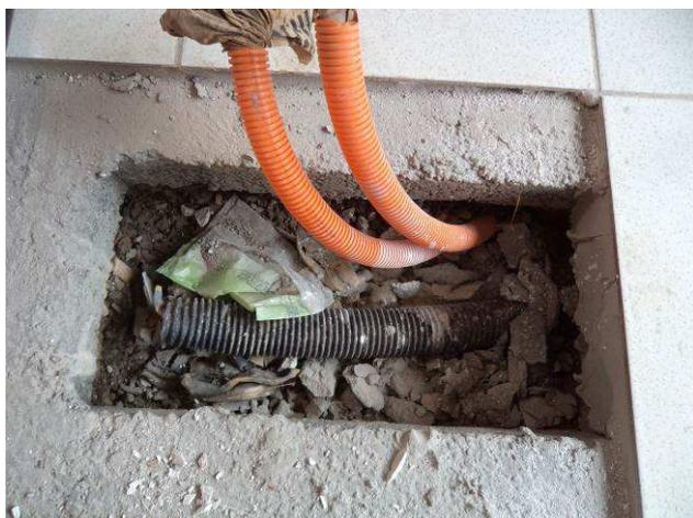
Figura 21E: Infraestrutura instalações cabeamento estruturado sob o piso da sala de audiências.
