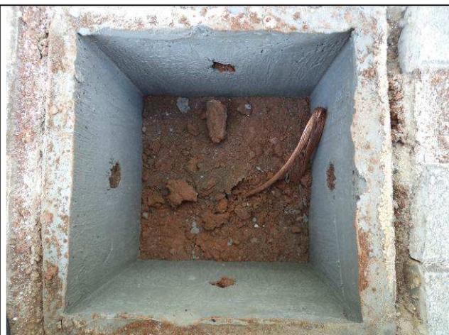
Figura 28E: malha de aterramento SPDA.
