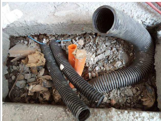
Figura 20E: Infraestrutura instalações cabeamento estruturado sob o piso da sala de audiências.
