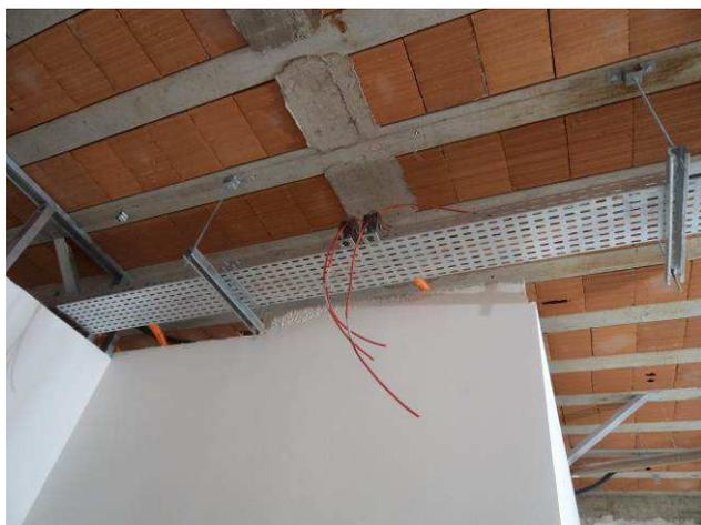
Figura 19E: Infraestrutura instalações cabeamento estruturado - condutores sistema genérico.
