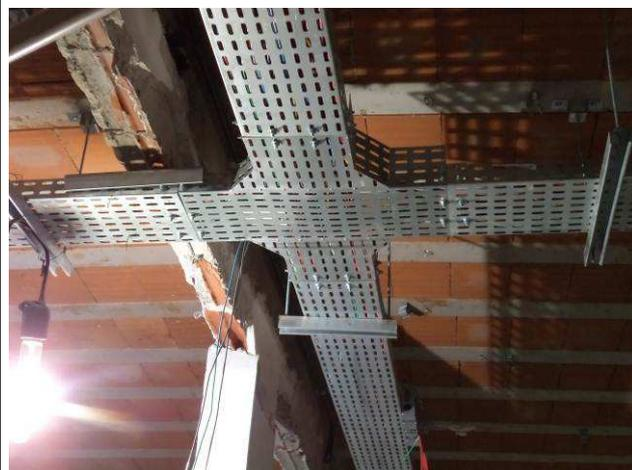
Figura 14E: Infraestrutura instalações elétricas - Eletrocalhas, cruzeta.
