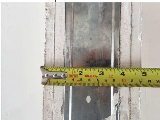
Figura 14C: Paredes de gesso acartonado ST dupla – sala de audiências.
