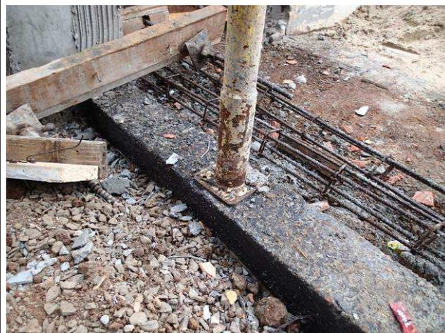
Figura 02C: Vigas baldrame impermeabilizadas com pintura asfáltica.
