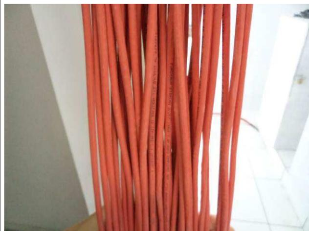
Figura 22E: cabeamento estruturado cat 6 UTP Furukawa.
