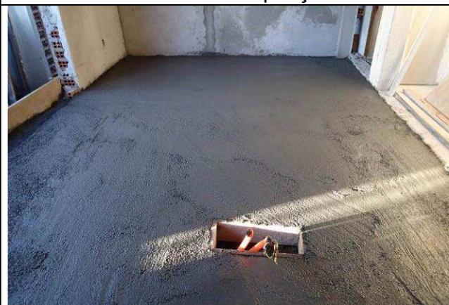
Figura 54C: Lastro de concreto executado na área da ampliação.
