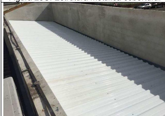
Figura 25C: Cobertura em telha metálica.
