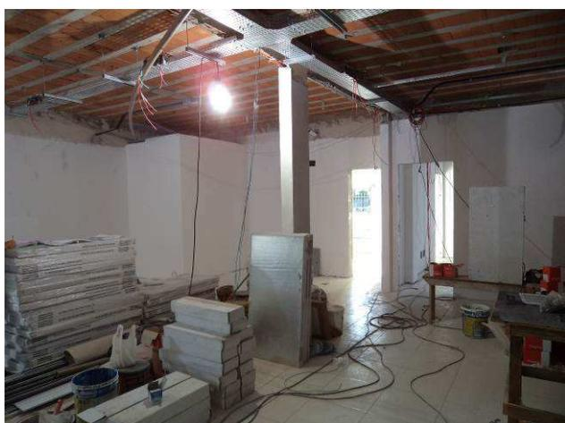
Figura 15E: Infraestrutura instalações elétricas - Eletrocalhas, perfilados.
