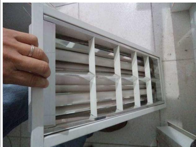
Figura 02E: Separação de materiais de iluminação a serem reaproveitados na obra.
