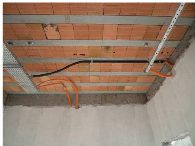
Figura 18E: Infraestrutura instalações cabeamento estruturado - eletrodutos rígidos e corrugados.
