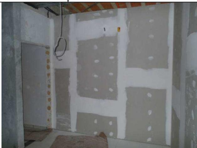
Figura 12C: Paredes de gesso acartonado ST dupla – sala de acordo.
