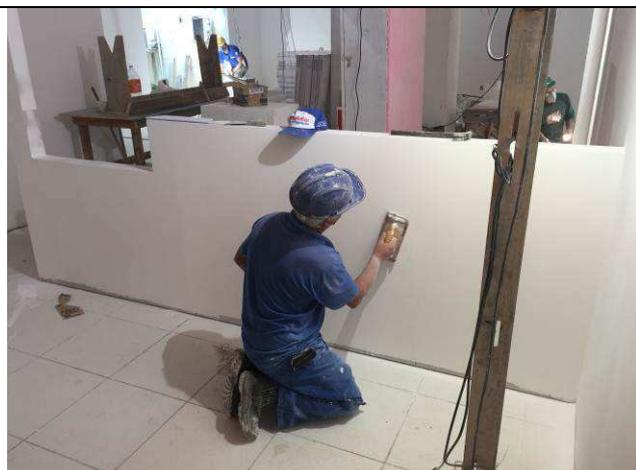
Figura 88C: Lixamento das paredes.
