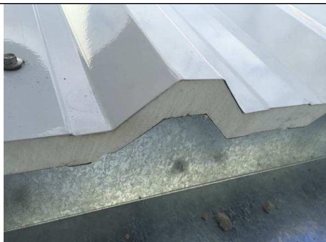
Figura 27C: Telha metálica termo-acústica.
