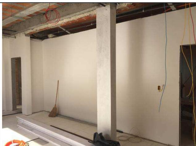
Figura 91C: Paredes emassadas e lixadas.
