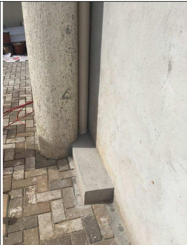
Figura 73C: Captação, condução de águas pluviais da ampliação.
