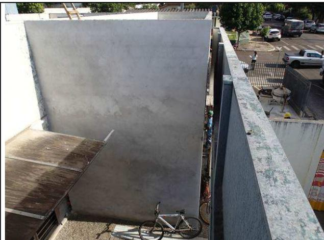
Figura 04C: Paredes de alvenaria com revestimento argamassado - ampliação.
