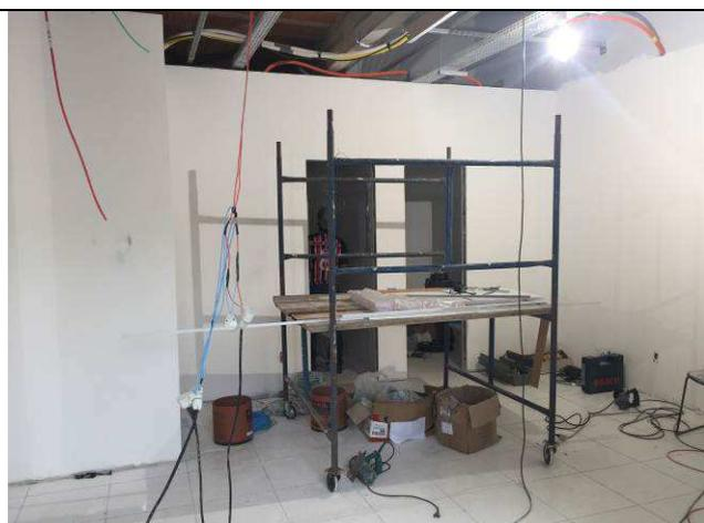
Figura 92C: Paredes emassadas e lixadas.
