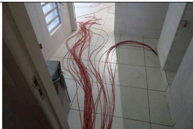
Figura 25E: cabearamento estruturado cat 6 UTP Furukawa.
