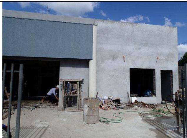
Figura 03C: Paredes de alvenaria com revestimento argamassado - ampliação.
