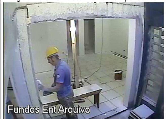
Figura 85C: Lixamento das paredes.
