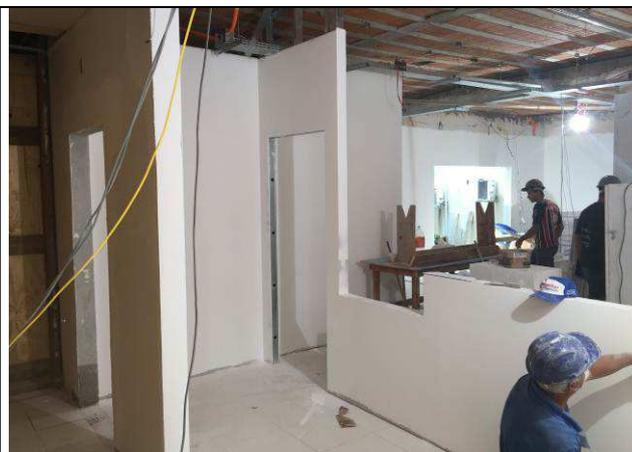
Figura 16C: Paredes de gesso acartonado ST simples – entrada e balcão.
