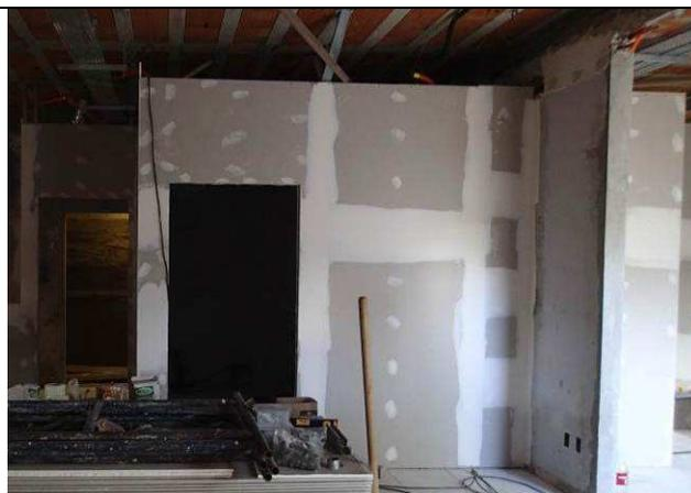
Figura 10C: Paredes de gesso acartonado ST dupla – sala de acordo.
