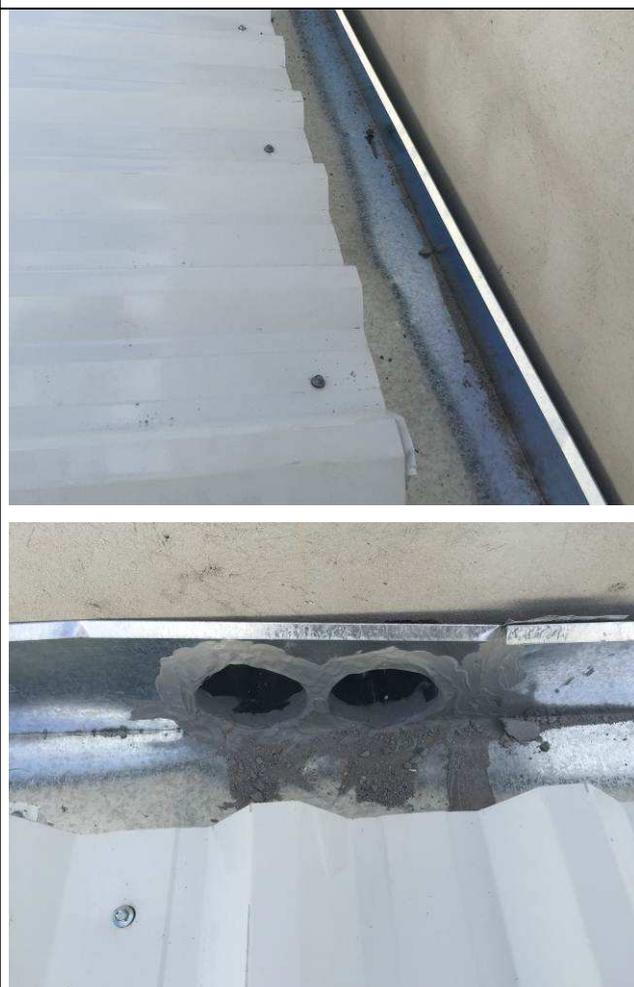
Figura 30C: Calha em aço galvanizado.
