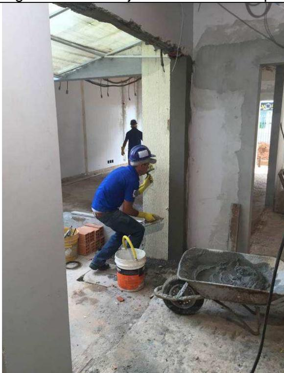
Figura 47C: Requardos de vãos de alvenaria.
