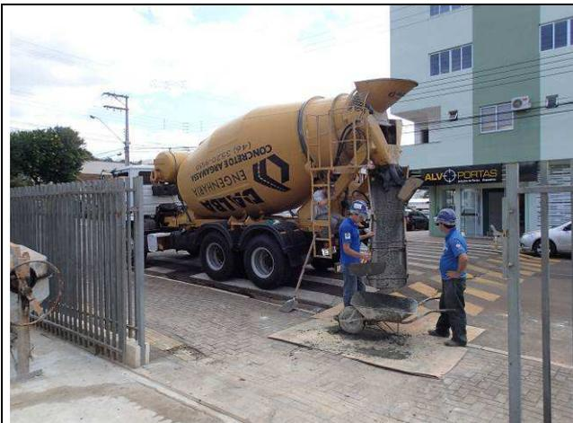
Figura 49C: Concreto usinado sendo descarregado para execução do piso.
