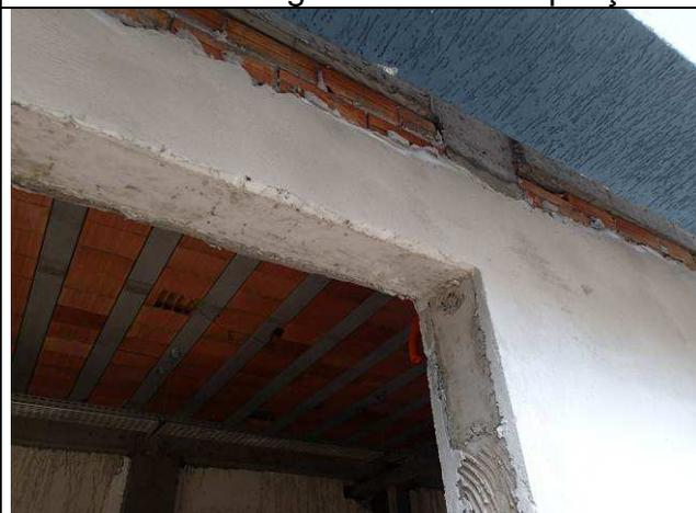
Figura 08C: Vergas de concreto armado.
