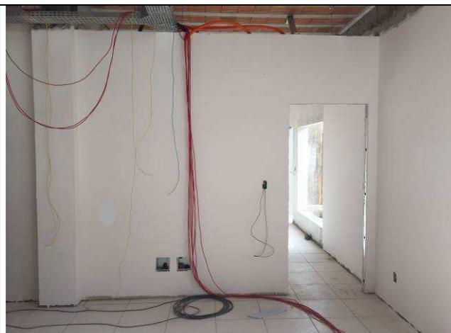
Figura 21C: Parede de gesso acartonado ST dupla – sala de audiências.
