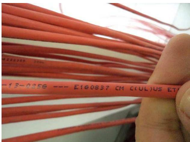
Figura 23E: cabeamento estruturado cat 6 UTP Furukawa.
