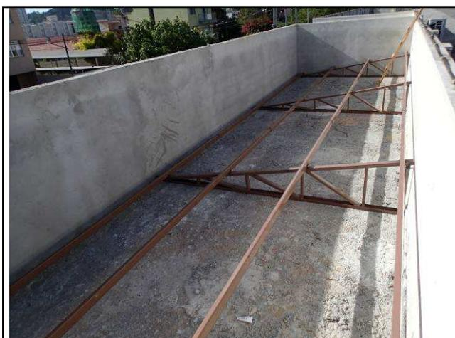
Figura 23C: Estrutura metálica cobertura.
