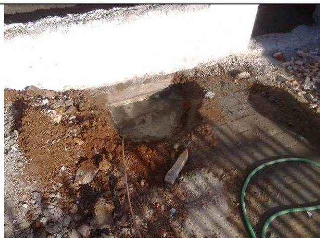
Figura 27E: malha de aterramento SPDA.
