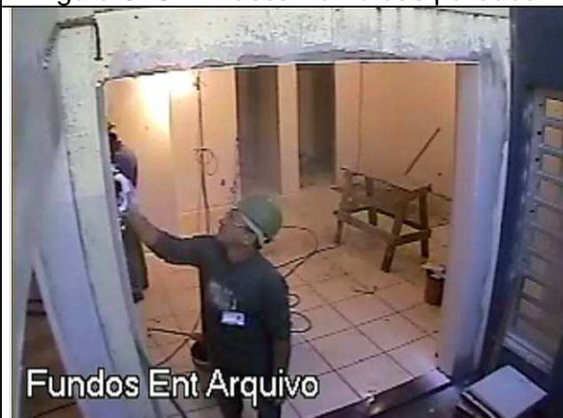
Figura 84C: Lixamento das paredes.
