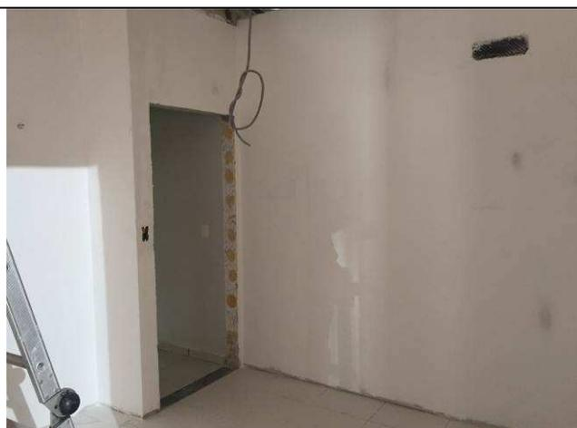
Figura 90C: Paredes emassadas e lixadas.
