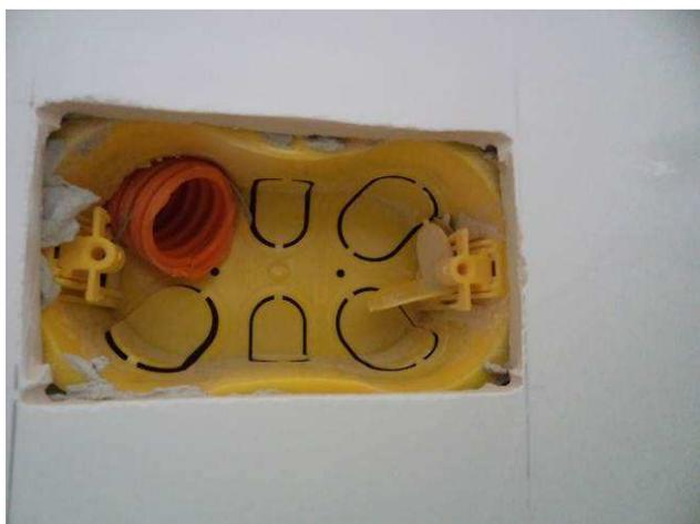
Figura 17E: Infraestrutura instalações cabeamento estruturado - caixas 2x4" e eletrodutos corrugados.
