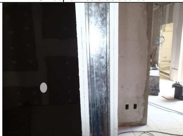
Figura 13C: Paredes de gesso acartonado ST dupla – sala de acordo.
