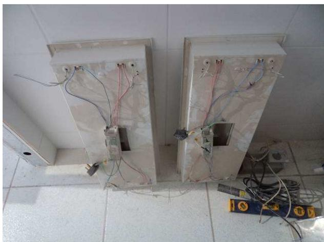
Figura 01E: Separação de materiais de iluminação a serem reaproveitados na obra.
