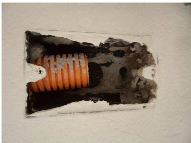
Figura 03E: Infraestrutura instalações elétricas - caixas 2x4" e eletrodutos corrugados.
