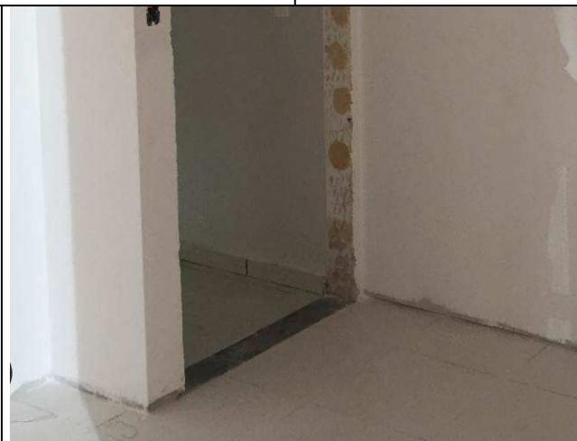
Figura 71C: Soleira em granito - PM4 da sala de acordo.
