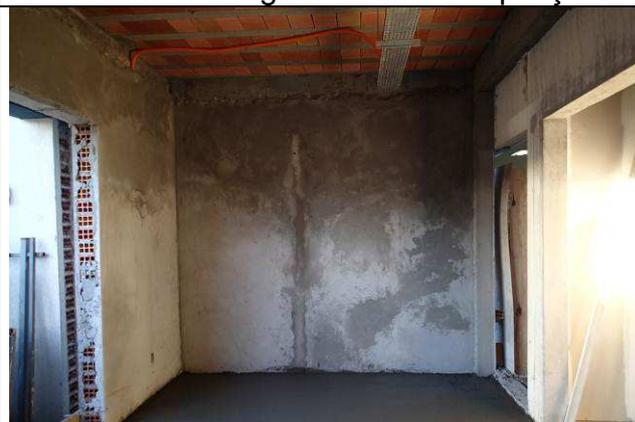
Figura 05C: Paredes de alvenaria com revestimento argamassado - ampliação.
