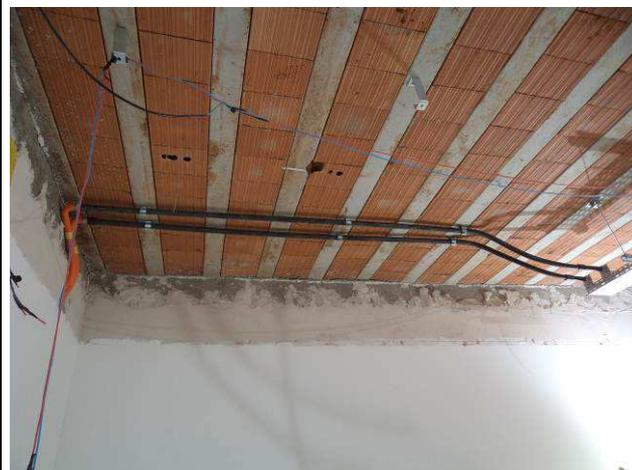
Figura 08E: Infraestrutura instalações elétricas - eletrodutos rígidos e corrugados.
