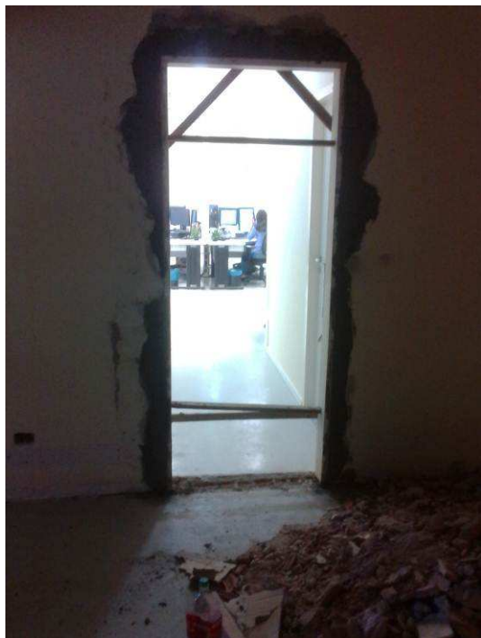
Figura 06C: Demolida parede em alvenaria para abertura de vão de porta localizada na Sala de Conciliação (passagem entre os barracões).
