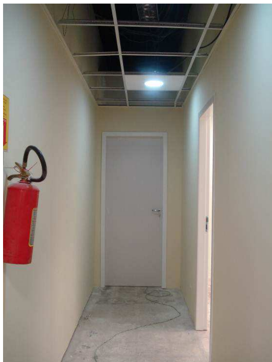
Figura 42C: Porta instalada no acesso à Sala de Audiências I (pela Circulação).
