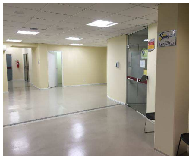
Figura 98C: Paredes da Sala de Espera da 3ª Vara emassadas e pintadas com tinta látex em duas demãos.
