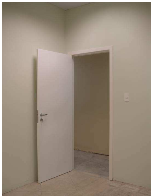
Figura 45C: Porta instalada no acesso à Sala de Conciliação (pela Circulação).
