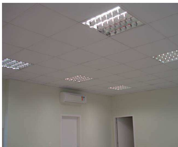
Figura 54C: Forro removível instalado na Sala de Audiências I.
