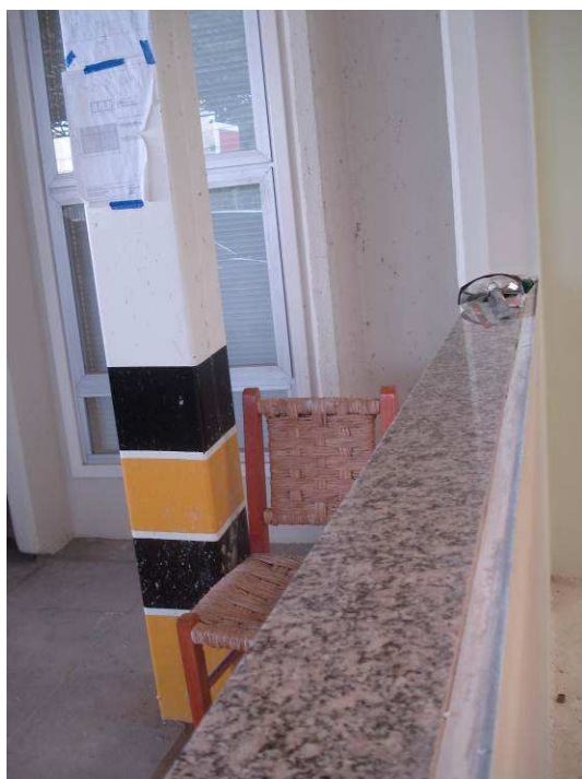
Figura 63C: Instalado peitoril em granito polido cinza andorinha na janela J01A da Sala de Audiências.
