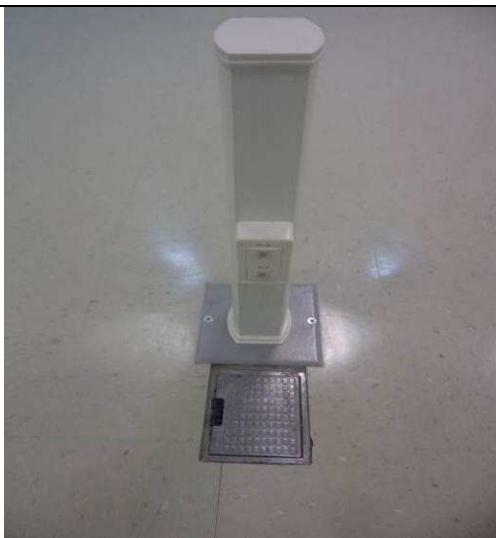
Figura 39E: pontos lógicos RJ45.
