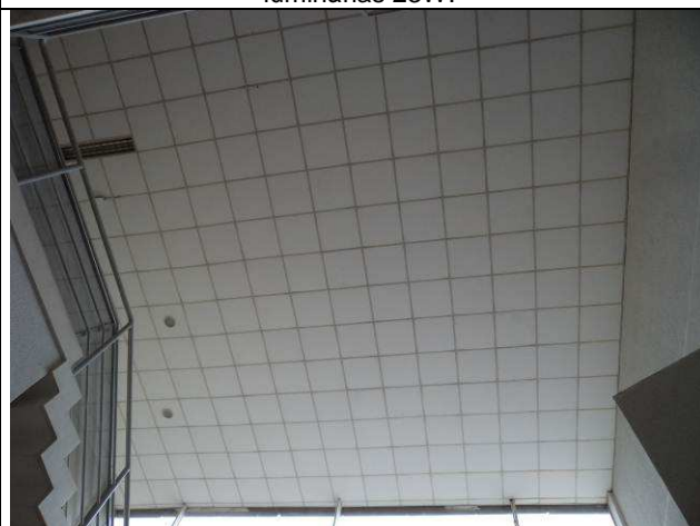
Figura 32E: retirada luminárias antigas hall principal.
