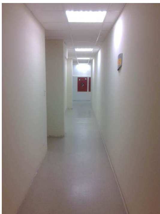
Figura 61C: Piso vinílico (Paviflex Dinamic), espessura 2 mm, instalado na Circulação.
