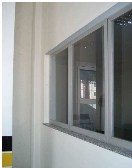
Figura 51C: Instalada esquadria metálica para janela J1A, na Sala de Audiências I.
