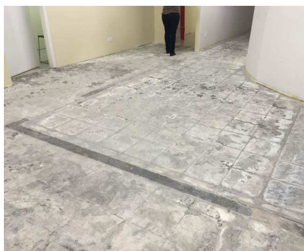
Figura 19C: Foram removidas as divisórias navais localizadas na Sala de Espera do Público.
