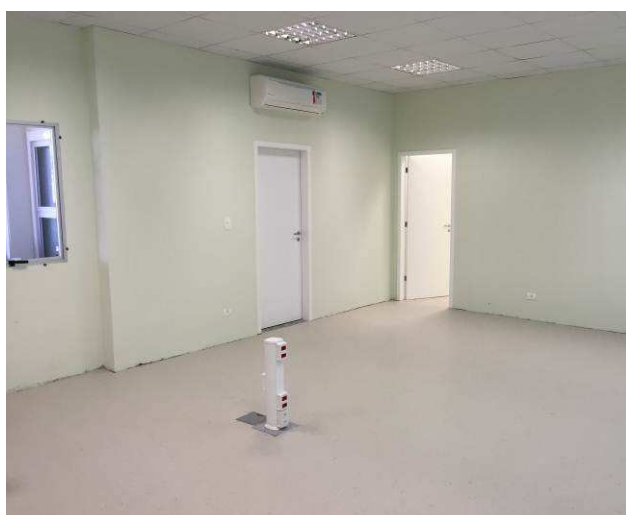
Figura 88C: Paredes da Sala de Audiência I emassadas e pintadas com tinta látex em duas demãos.
