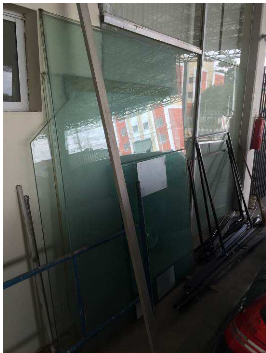
Figura 09C: Paineis em vidro temperado removido do local onde será instalada Sala de Audiências da 5ª Vara.
