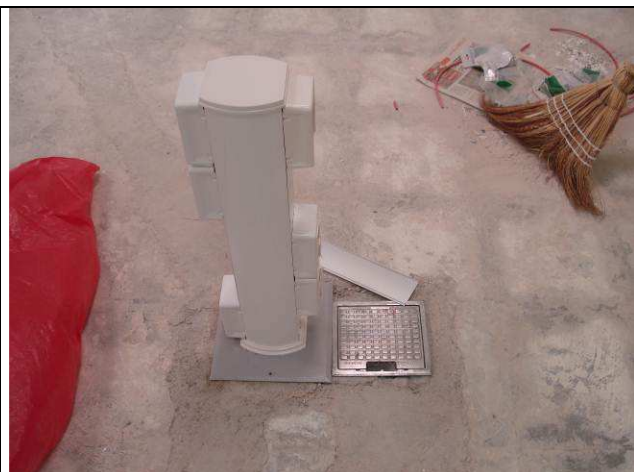
Figura 34E: caixas de passagem Dutotec para cabos monitor de vídeo.
