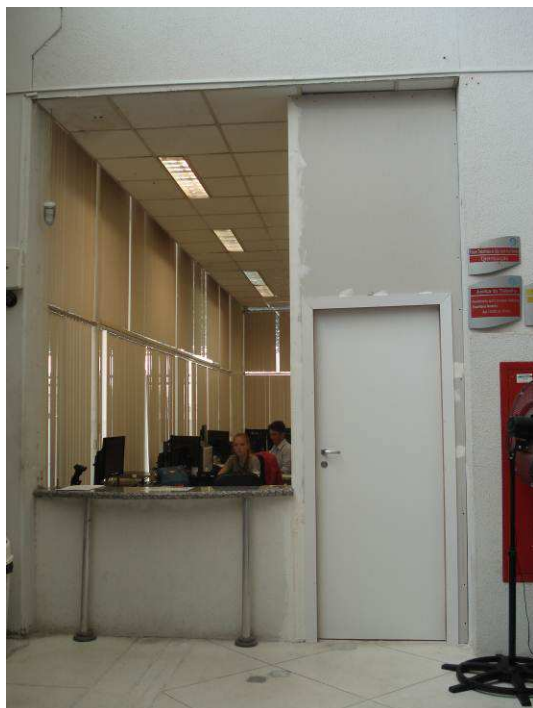
Figura 27C: Executado gesso acartonado simples no fechamento da parede do balcão da Distribuição.
