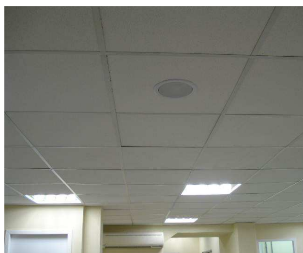
Figura 57C: Forro removível instalado na Sala de Espera do Público.
