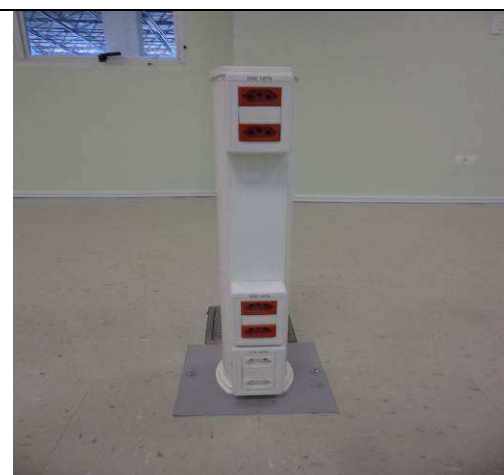
Figura 26E: Totens Dutotec, tomadas, porta equipamentos, caixa de passagem.
