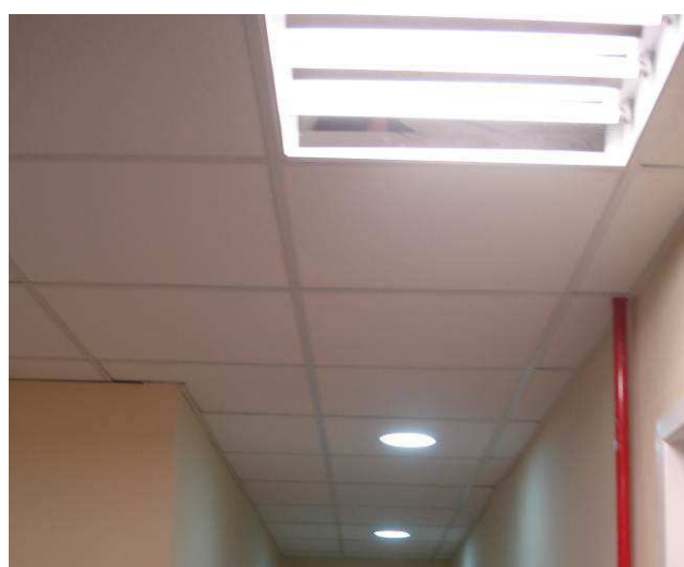
Figura 56C: Forro removível instalado na Circulação.
