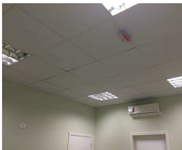
Figura 55C: Forro removível instalado na Sala de Conciliação.
