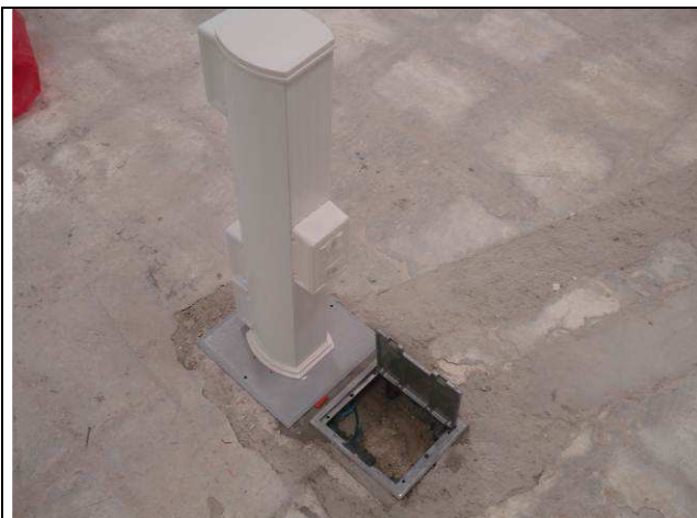
Figura 33E: caixas de passagem Dutotec para cabos monitor de vídeo.
