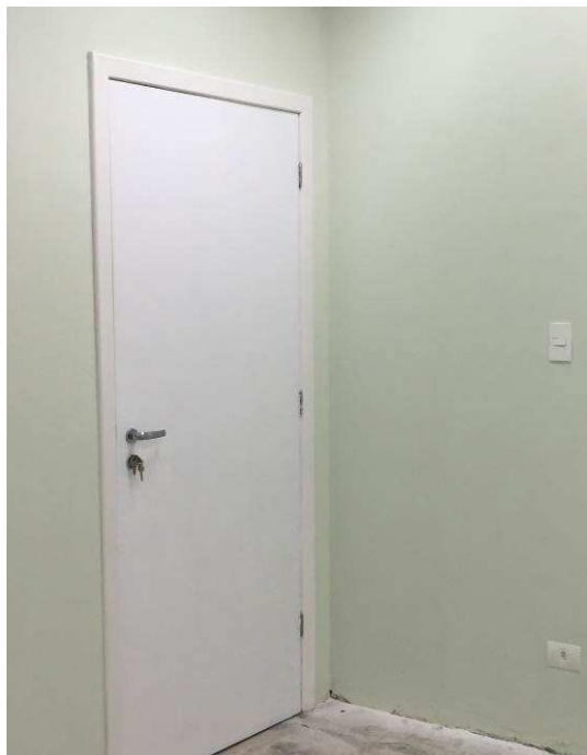
Figura 44C: Porta instalada na passagem da Sala de Audiências I para a Sala de Conciliação.
