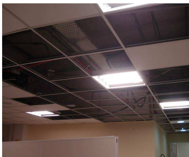
Figura 52C: Montagem do forro com utilização de perfis metálicos da marca Armstrong.
