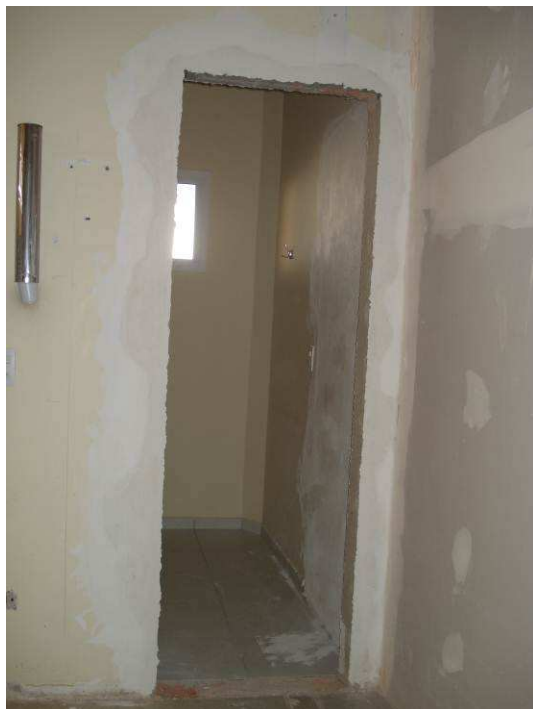
Figura 33C: Executado gesso acartonado no fechamento de vão da porta entre a Sala de Audiências I e banheiro da Distribuição (parede interna).
