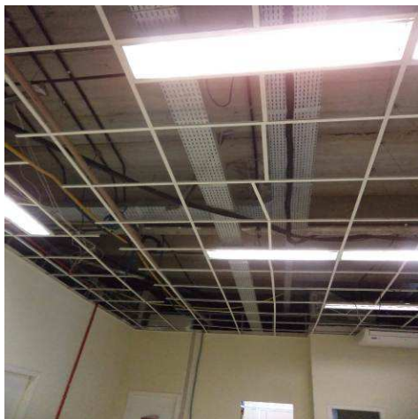
Figura 05E: novas eletrocalhas área sala de audiências, conciliação e distribuição.
