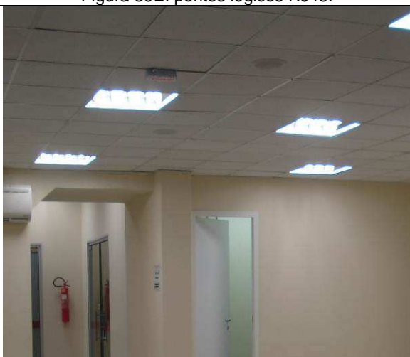
Figura 41E: instalação sonorização.
