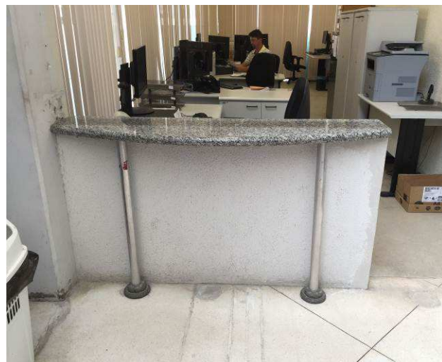
Figura 34C: Executada adaptação da base em alvenaria (diminuição de altura) e instalado tampo em granito polido cinza andorinha. Pendente substituição dos tubos cromados existentes.
