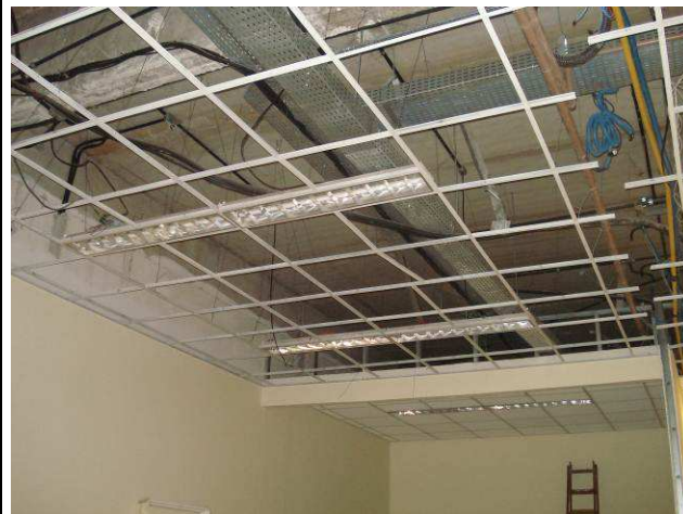
Figura 06E: novas eletrocalhas área sala de audiências, conciliação e distribuição.
