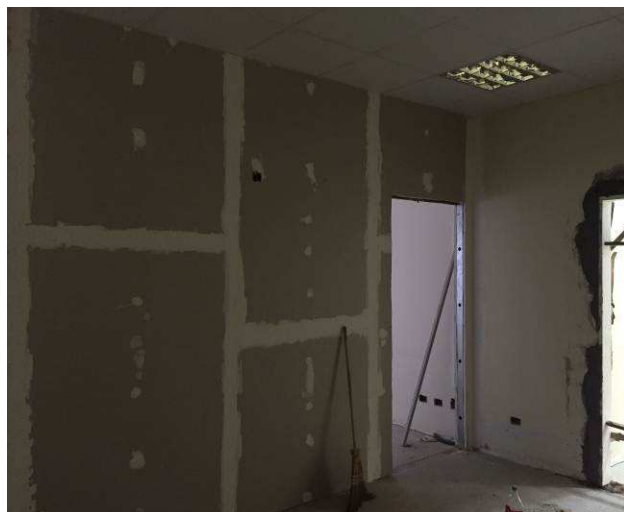
Figura 30C: Parede mostrada ao lado, vista da Sala de Conciliação. Juntas fitadas e emassadas.
