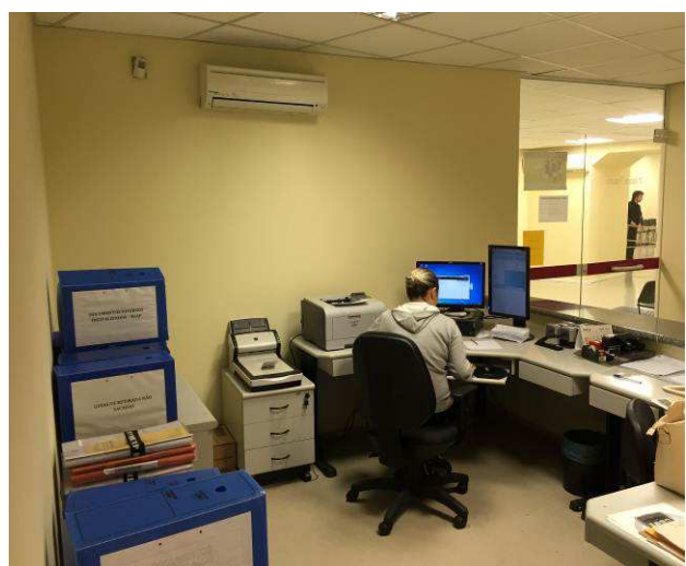
Figura 97C: Paredes da Sala de Atendimento da 3ª Vara emassadas e pintadas com tinta látex em duas demãos.
