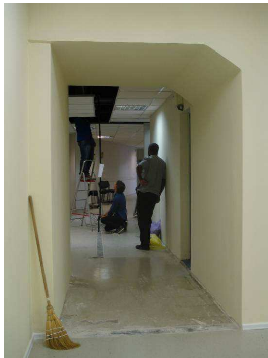
Figura 07C: Foi removida parede em alvenaria na passagem entre os barracões, localizada na Sala de Espera do Público.
