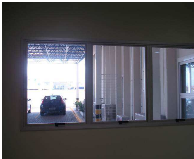
Figura 50C: Instalada esquadria metálica para janela J1A, na Sala de Audiências I.
