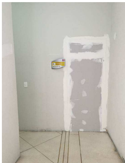
Figura 12C: Porta removida na passagem da sala de audiências I para hall de entrada do Fórum (local fechado com gesso acartonado).
