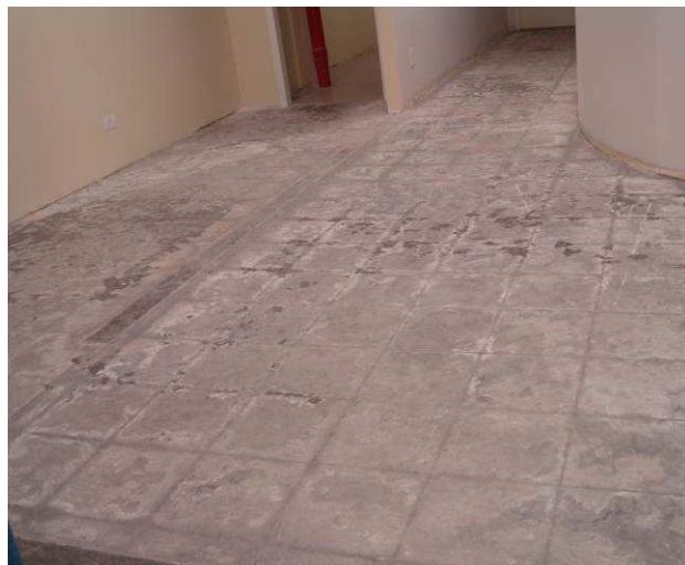
Figura 22C: Piso removido na Sala de Espera do Público.
