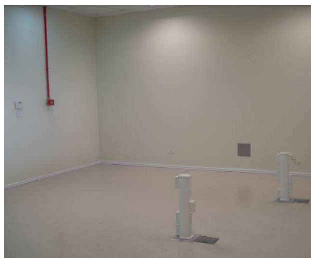
Figura 64C: Rodapé Santa Luzia, com 15 mm de espessura e 5 cm de altura, instalado na Sala de Audiências I (5ª Vara).
