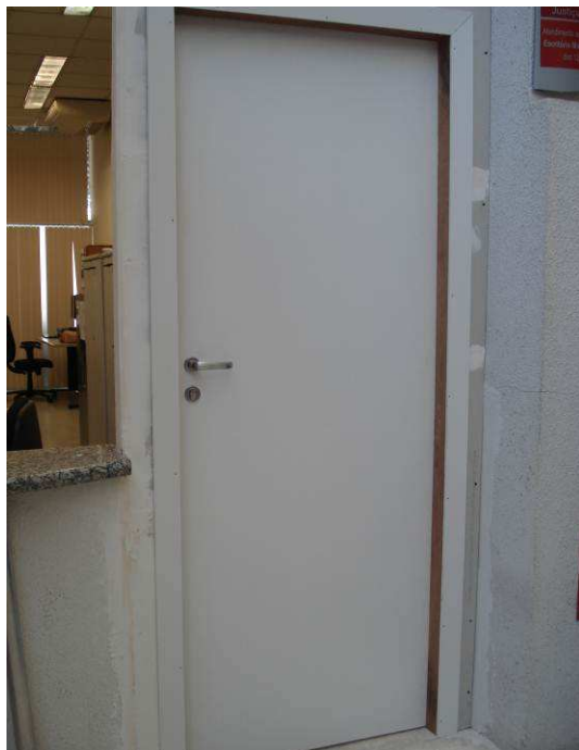
Figura 40C: Porta instalada no acesso à Distribuição (pelo hall de entrada).
