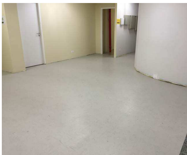
Figura 62C: Piso vinílico (Paviflex Dinamic), espessura 2 mm, instalado em parte da Sala de Espera do Público.
