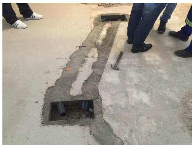
Figura 03E: infraestrutura sob o piso – sala de audiências
