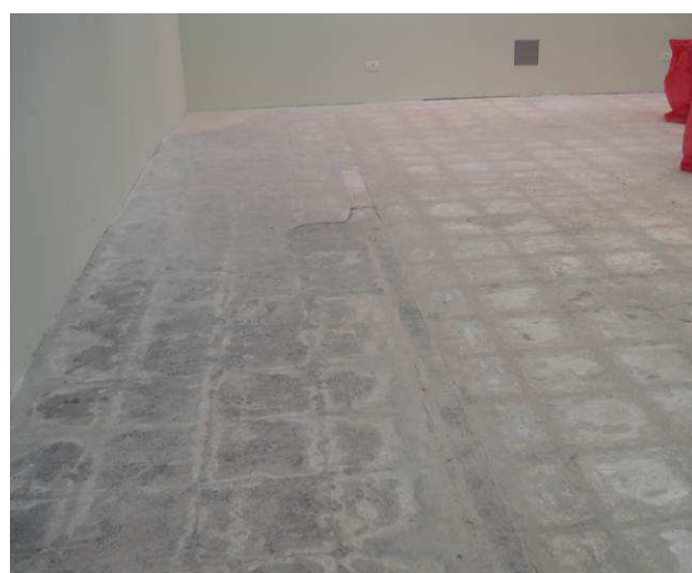
Figura 20C: Piso removido na Sala de Audiências I.
