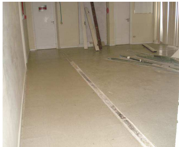
Figura 18C: Foram removidas as divisórias navais para instalação da atual Sala de Audiências I.
