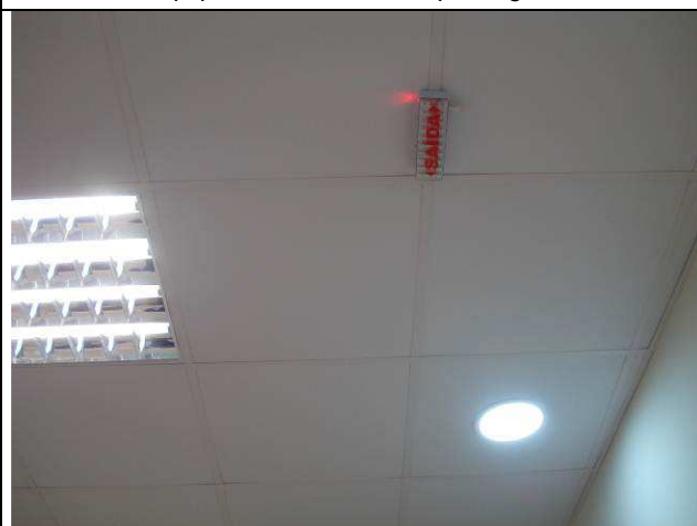
Figura 28E: blocos de emergência, luminárias 4x16W e luminárias 23W.
