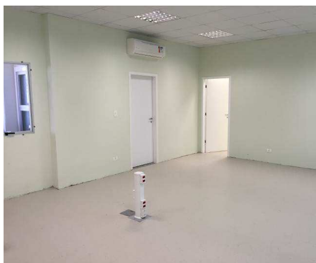
Figura 59C: Piso vinílico (Paviflex Dinamic), espessura 2 mm, instalado na Sala de Audiências I (5ª Vara). Executada prévia regularização.
