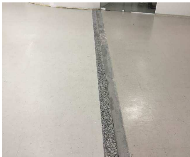
Figura 74C: Instalada soleira em granito cinza andorinha polido no limite das áreas de piso substituído e aquele existente (Espera do Público).
