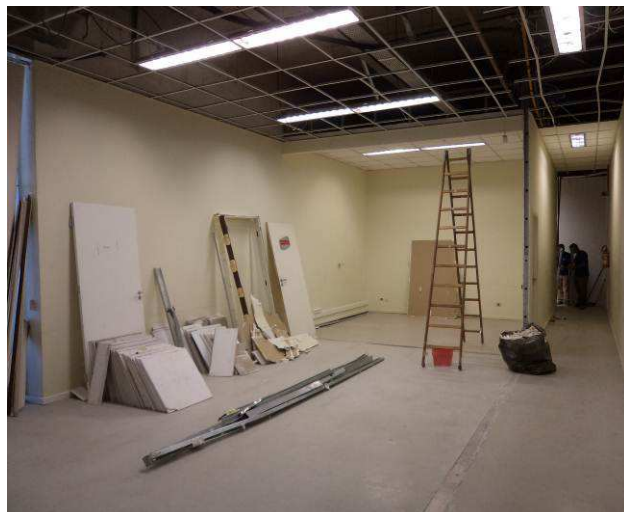
Figura 10C: Portas removidas nas áreas onde serão instaladas a Sala de Audiências I e Conciliação, ambas da 5ª Vara.
