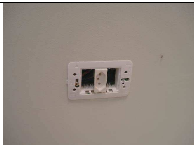
Figura 17E: caixas 2x4" e eletrodutos.
