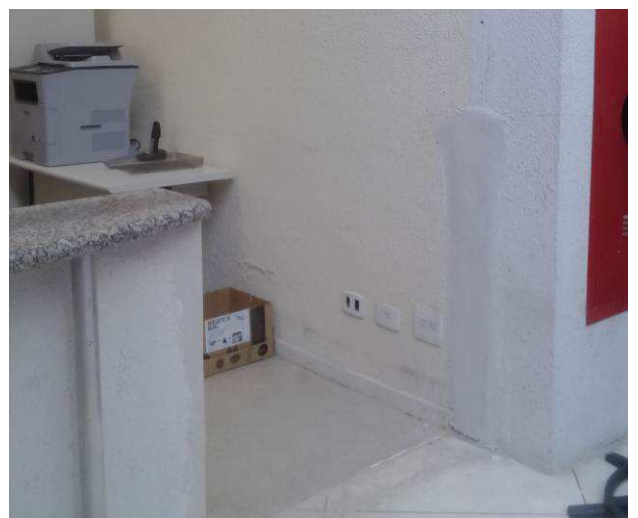
Figura 03C: Detalhe da alvenaria removida.
