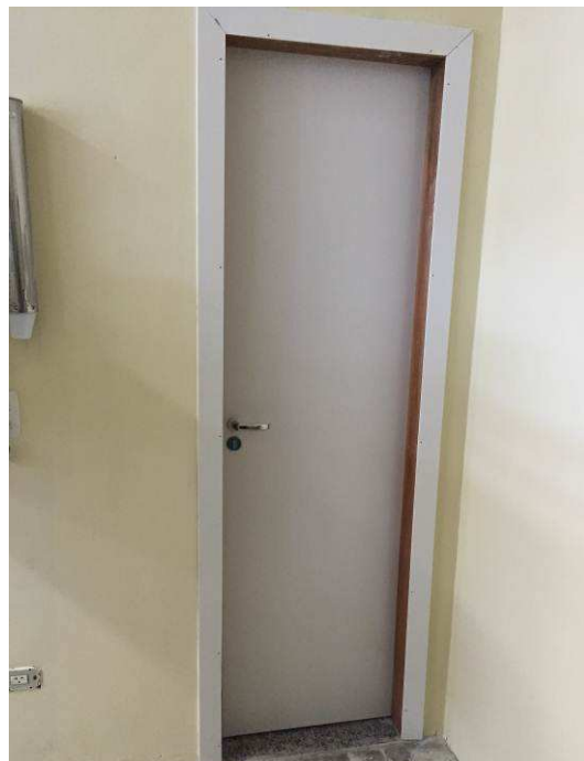
Figura 41C: Porta instalada no acesso ao banheiro da Distribuição.
