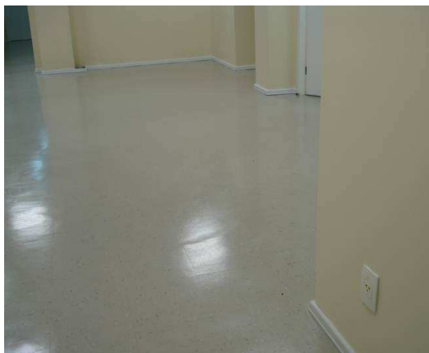
Figura 69C: Rodapé Santa Luzia, com 15 mm de espessura e 5 cm de altura, instalado na Sala de Espera do Público.
