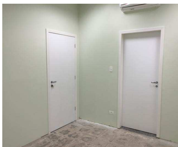
Figura 89C: Paredes da Sala de Conciliação emassadas e pintadas com tinta látex em duas demãos.
