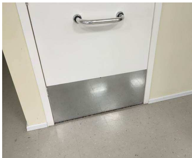
Figura 37C: Barra de 30 cm instalada na porta PM90 IS, localizada no banheiro PNE, com respectiva instalação de acabamento melamínico.
