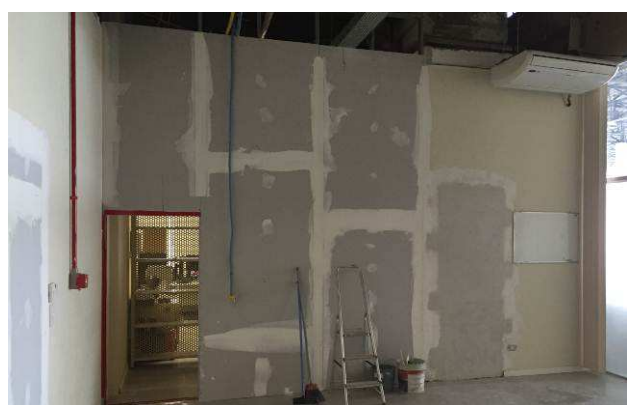
Figura 29C: Executado gesso acartonado duplo na divisa das salas de Audiências I e Conciliação.
