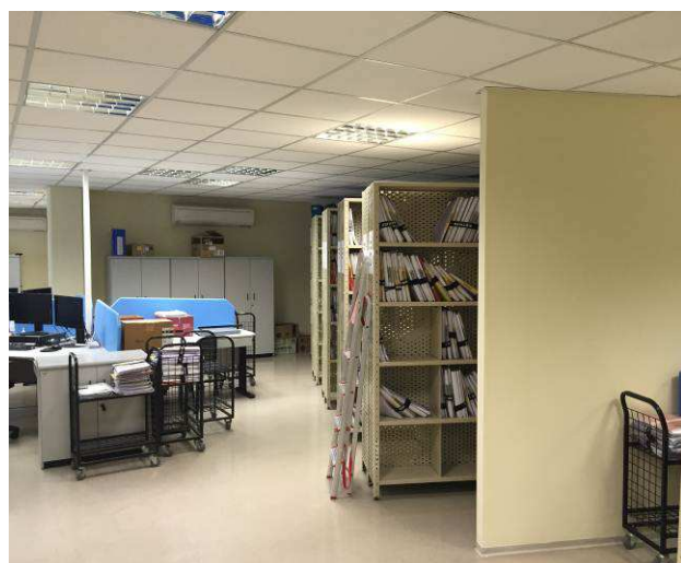
Figura 91C: Paredes da Secretaria da 3ª Vara emassadas e pintadas com tinta látex em duas demãos.
