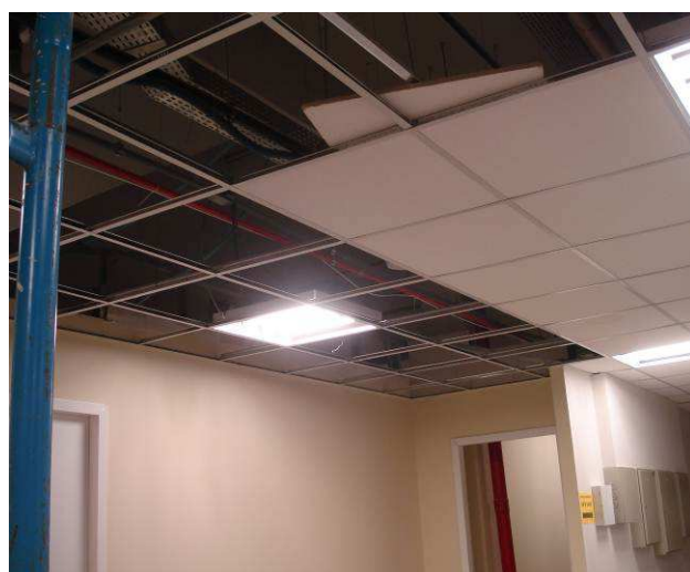
Figura 53C: Placas de gesso 0,65x 0,65m, com face inferior revestida com película vinílica branca.
