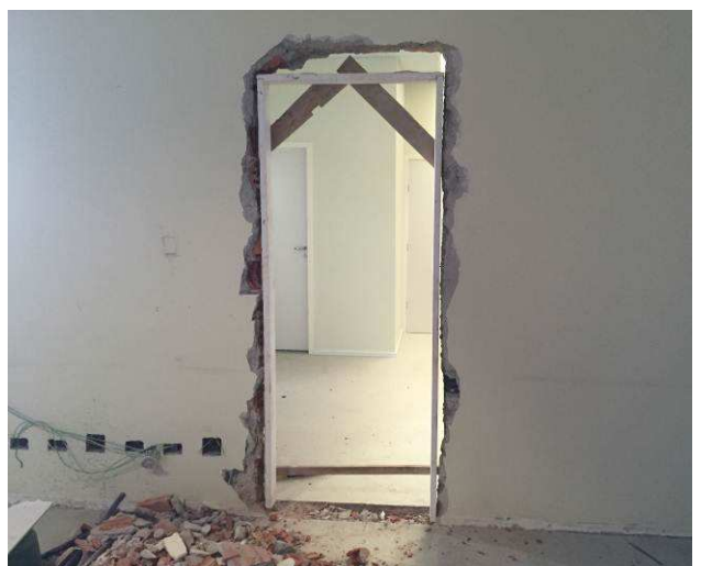
Figura 05C: Demolido parede em alvenaria para abertura de vão de porta localizada na Sala de Audiências I (passagem entre os barracões).
