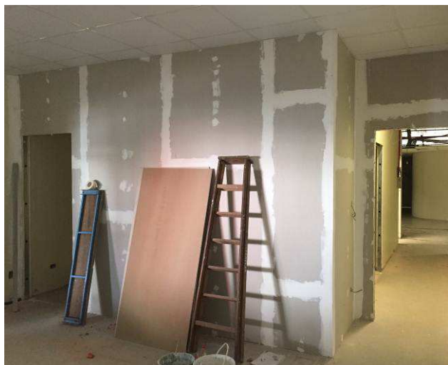
Figura 29C: Executado gesso acartonado duplo na divisa das salas de Audiências I e Conciliação.
