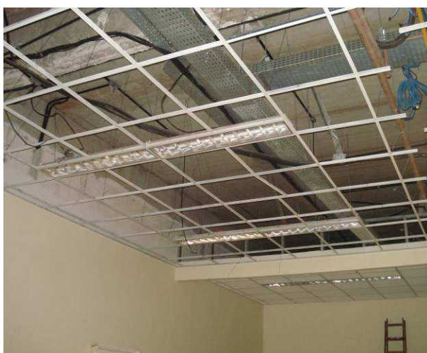
Figura 15C: Remoção do forro de gesso no local onde serão instaladas a Sala de Audiências e Sala de Conciliação.
