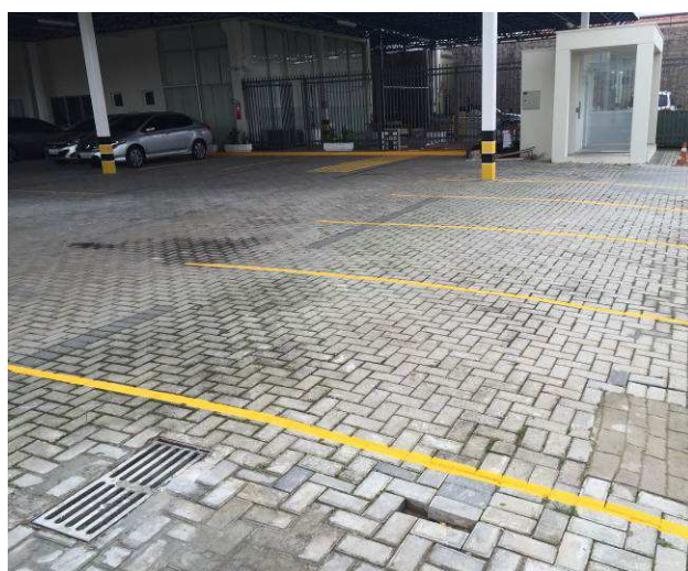
Figura 109C: Executada pintura acrílica de faixas de demarcação de vagas de estacionamento, no estacionamento coberto.
