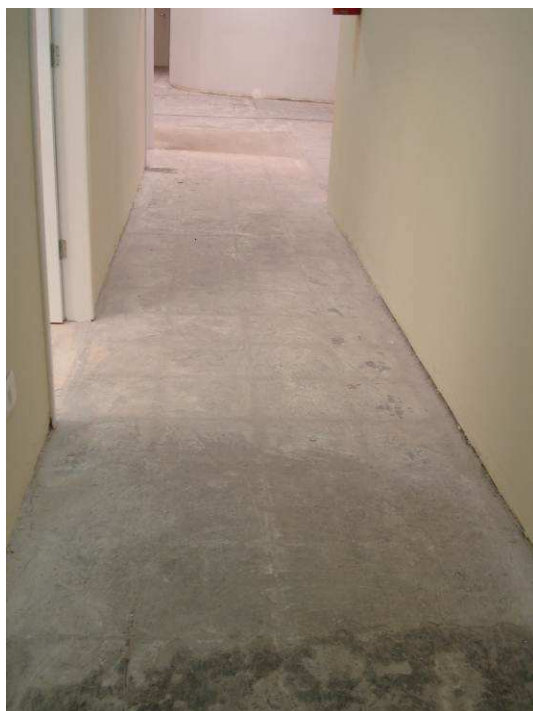
Figura 23C: Piso removido na circulação de acesso à Sala de Audiências I e Sala de Conciliação.
