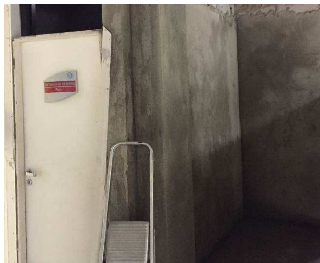
Figura 14C: Houve remoção de porta do banheiro demolido (anexo à sala site).
