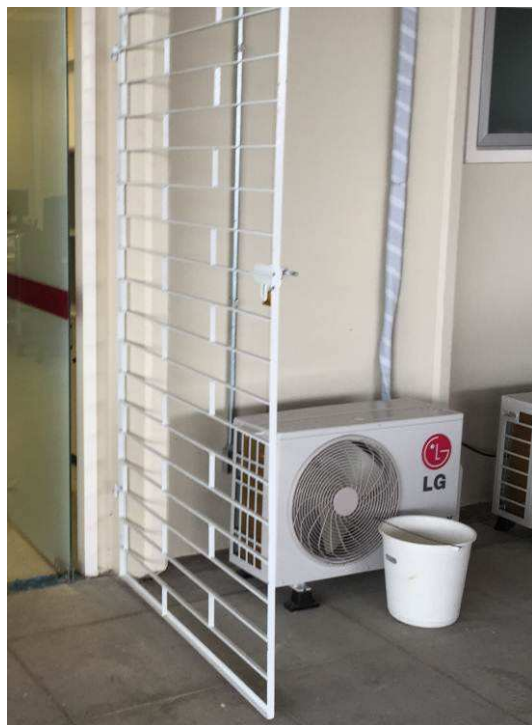
Figura 39C: Porta de ferro tipo grade vazada, instalada junto à porta de acesso à Secretaria da 5ª Vara. Fundo zarcão e duas demãos de esmalte sintético aplicados.
