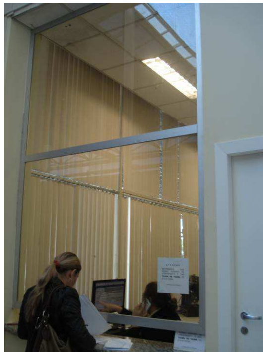
Figura 49C: Instalado painel em vidro temperado fixo (e=10mm), acima do balcão da Distribuição.
