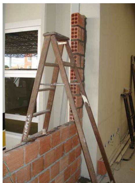
Figura 26C: Detalhe da alvenaria mostrada ao lado.
