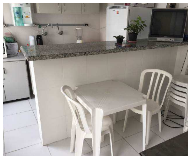
Figura 36C: Instalado tampo em granito polido cinza andorinha no balcão da copa de terceirizados.
