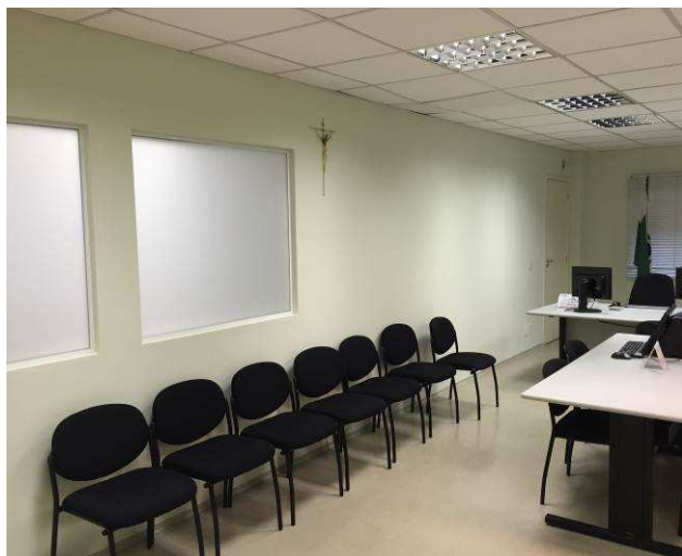
Figura 95C: Paredes da Sala de Audiências II da 3ª Vara emassadas e pintadas com tinta látex em duas demãos.
