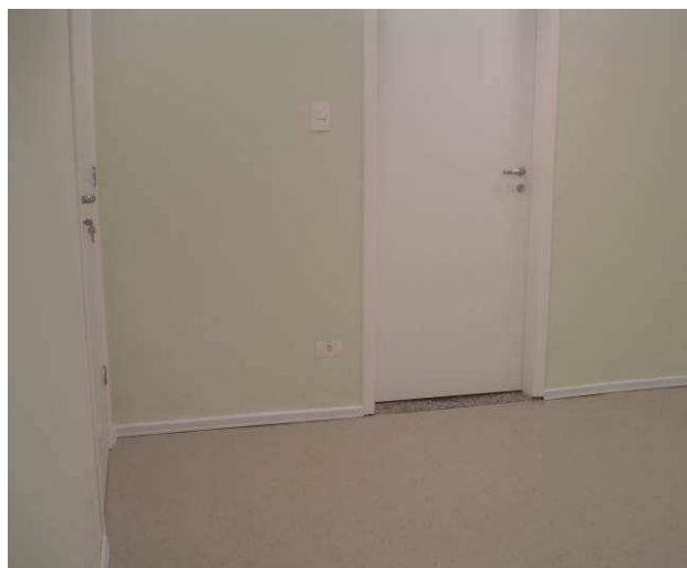
Figura 66C: Rodapé Santa Luzia, com 15 mm de espessura e 5 cm de altura, instalado na Sala de Conciliação (5ª Vara).
