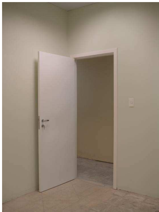
Figura 105C: Porta pintada no acesso à Sala de Conciliação, pela Circulação.
