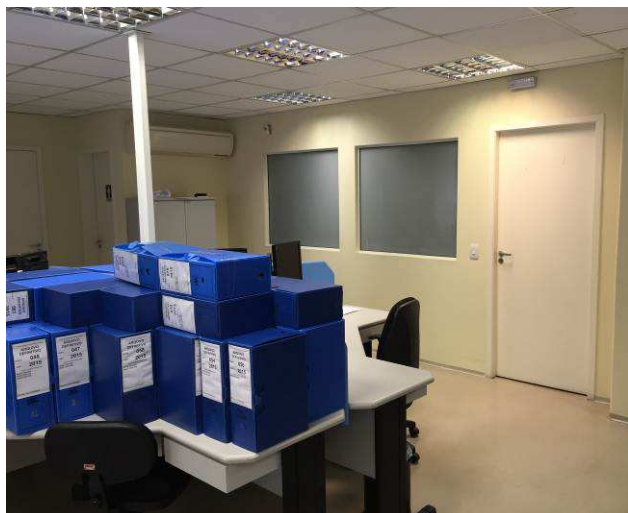
Figura 92C: Paredes da Secretaria da 3ª Vara emassadas e pintadas com tinta látex em duas demãos.
