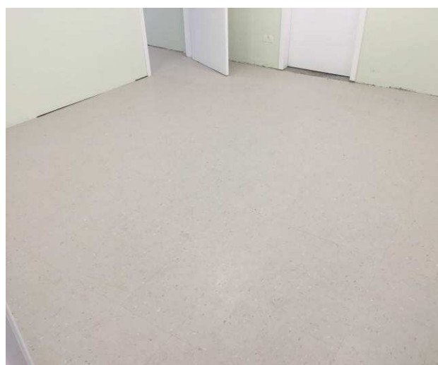
Figura 60C: Piso vinílico (Paviflex Dinamic), espessura 2 mm, instalado na Sala de Conciliação da 5ª Vara.
