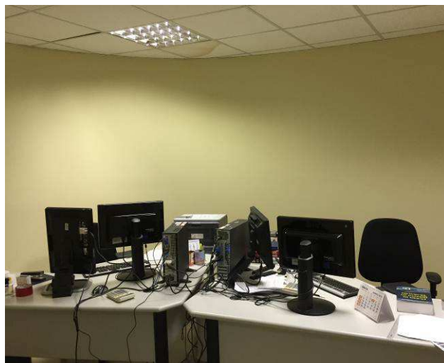
Figura 96C: Paredes da Sala de Pré-acordo da 3ª Vara emassadas e pintadas com tinta látex em duas demãos.
