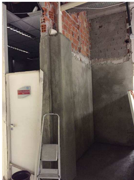
Figura 28C: Executada alvenaria no fechamento de parede da Sala Site.
