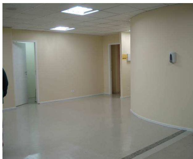
Figura 90C: Paredes da Sala de Espera do Público emassadas e pintadas com tinta látex em duas demãos.
