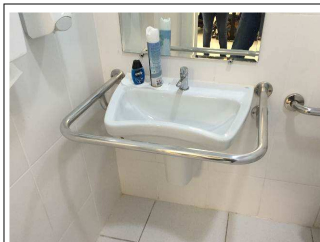
Figura 76C: Instalada barra de apoio no lavatório do banheiro PNE (fase 01).
