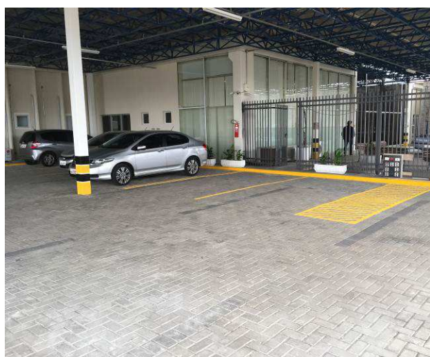
Figura 108C: Realizada limpeza de superfícies com jato de alta pressão de ar e água no piso do estacionamento coberto.
