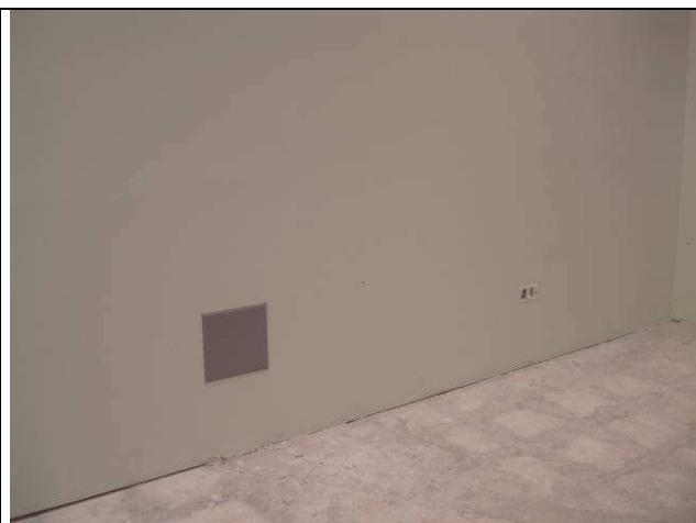
Figura 18E: caixas de passagem e eletrodutos.
