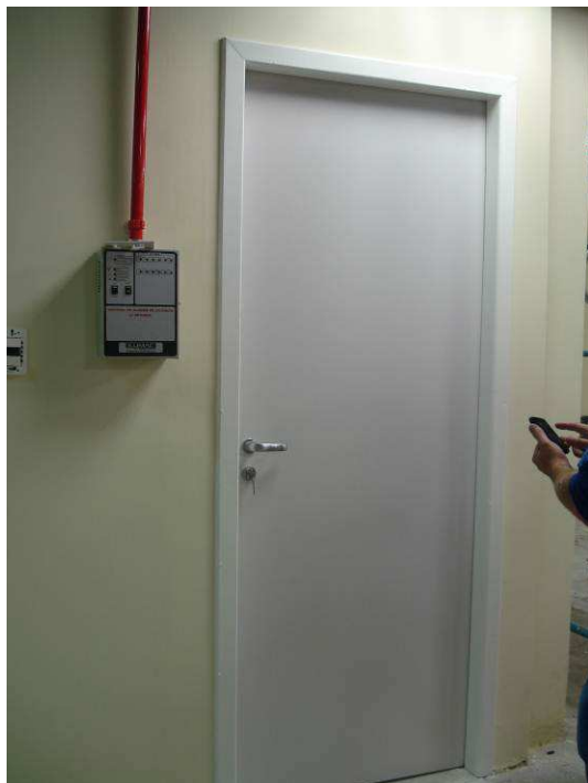
Figura 48C: Porta instalada na Sala Site.
