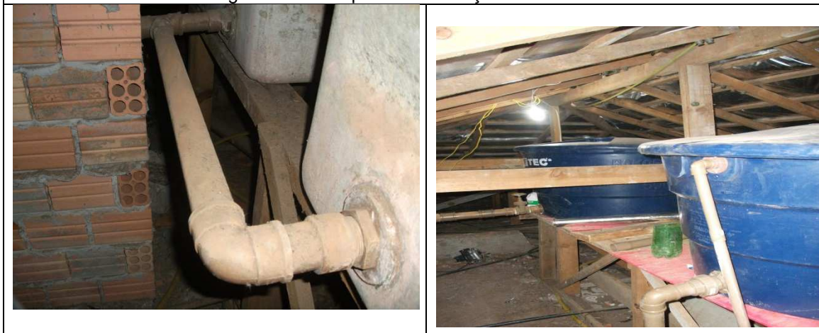
Imagens antes e após a substituição do reservatório
