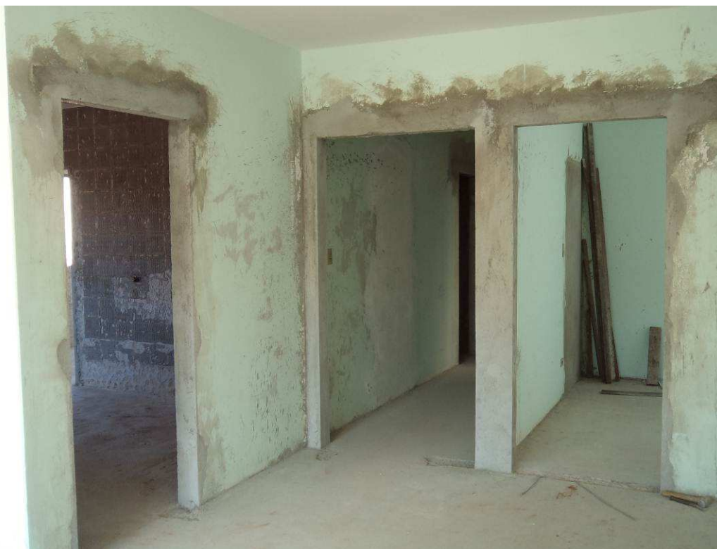
Figura 3 – Vista interna – pavimento superior
