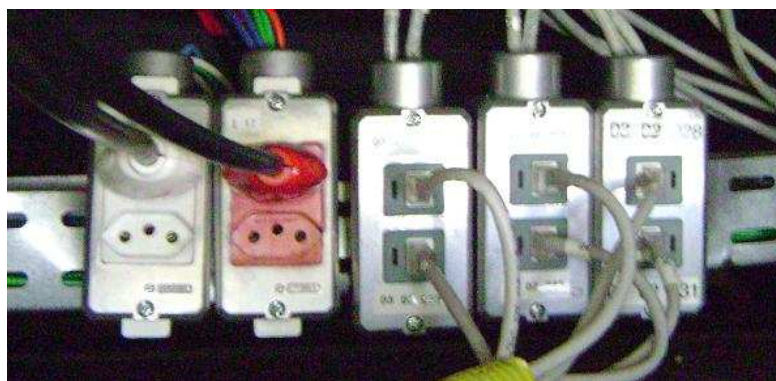
Tomadas sobre o forro, instaladas em condutes
