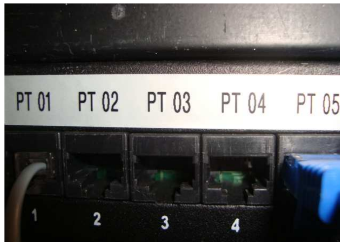
Circuito identificado por etiqueta no patch pannel
