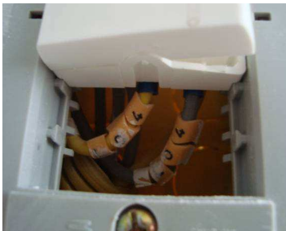
Circuitos identificados por anilhas nos cabos e etiquetas no espelho
