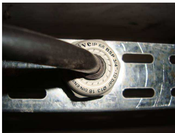
Prensa-cabos (derivações para as luminárias)
