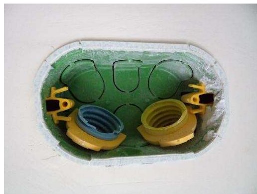
Caixas embutidas em alvenaria e dry-wall
