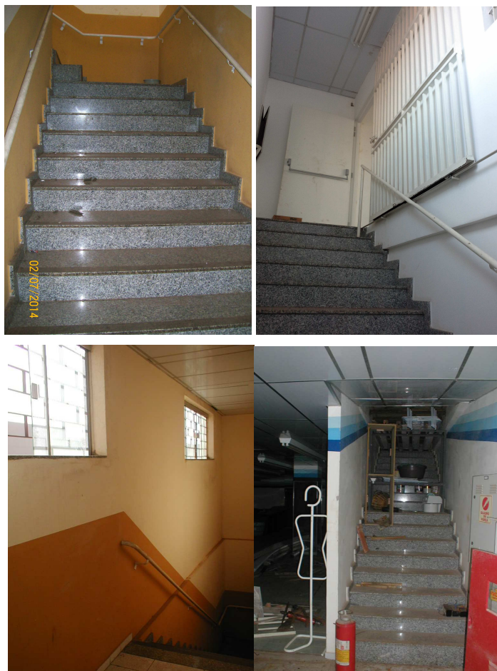
Vista geral escada – substituir guarda corpo metálico
