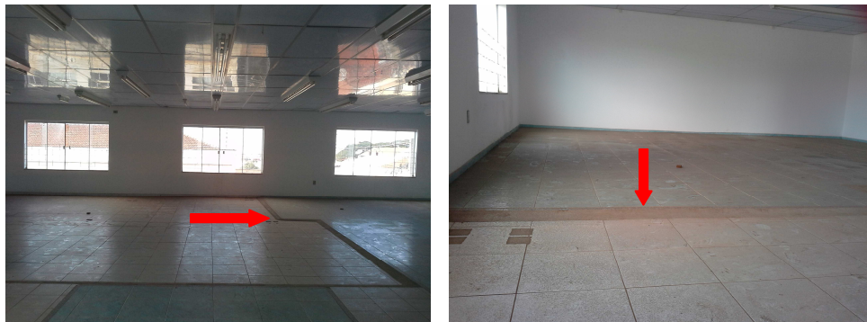
Demolição das irregularidades do piso – além da remoção de todo revestimento
