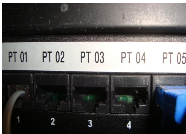
Figura 15 – Patch panel com identificação de pontos
