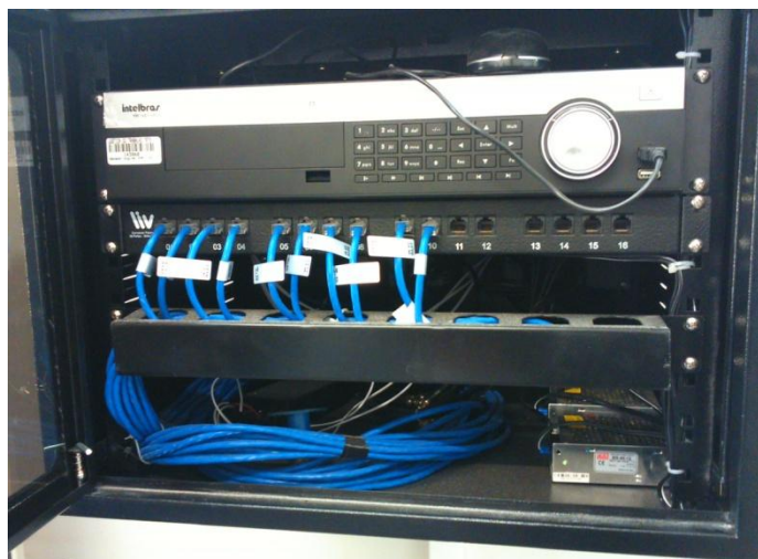
Figura 18 – DVR e painel de baluns passivo instalado em rack
