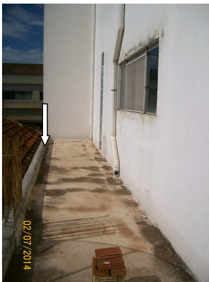
Instalar rufo metálico na mureta
