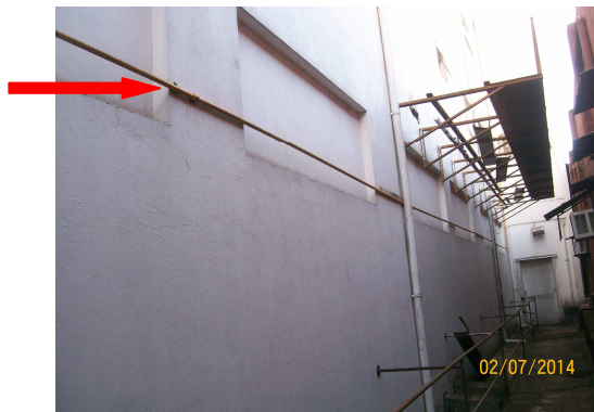
Tubulação de gás a remover
