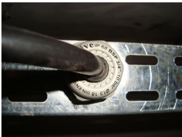
Figura 7 – Derivação para luminárias (prensa-cabo e plug)
