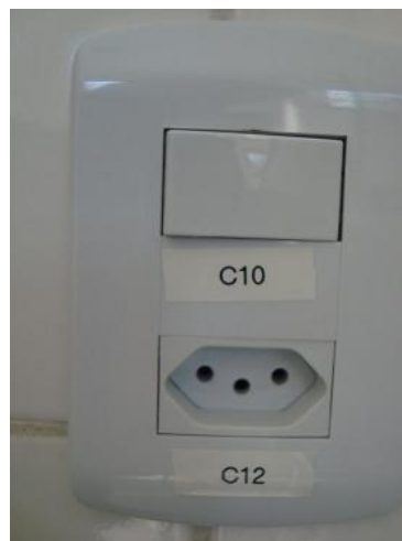
Figura 4 - Identificação de condutores, tomadas e interruptores
