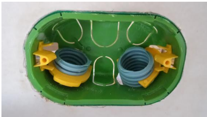
Figura 21 – Caixa de ligação para drywall
