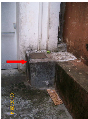
Demolição de caixa de gordura
