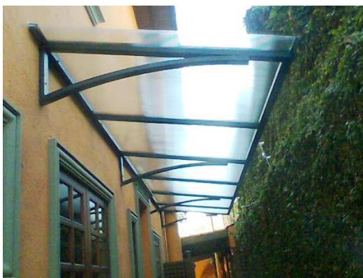
Modelo cobertura polycarbonato alveolar a instalar Porta lateral dupla (corta fogo) e porta aos fundos (terceirizados)
