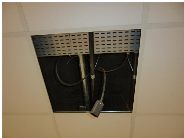
Figura 7 – Derivação para luminárias (prensa-cabo e plug)
