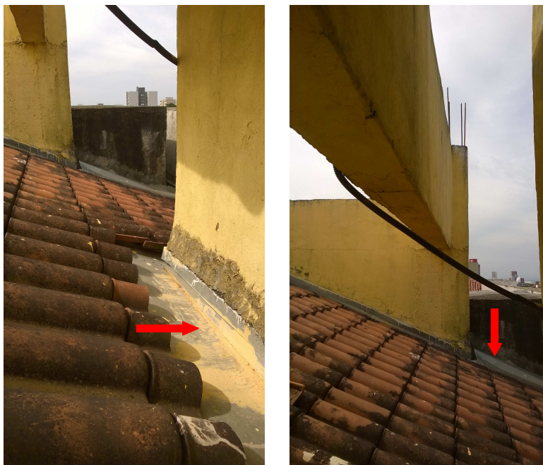
Arremates do telhado a remover
