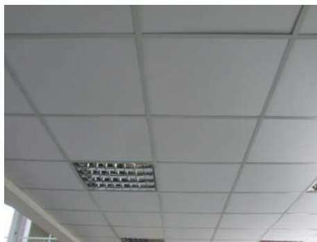
Forro Modular em gesso acartonado – 62,5x62,5 Com película vinílica
