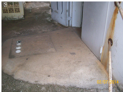
Local onde será executado lastro em concreto Nivelamento do piso
