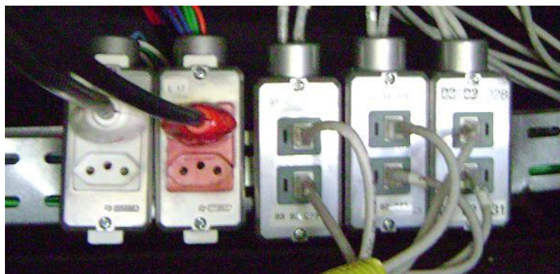
Figura 19 – Padrão genérico (tomadas sobre o forro)
