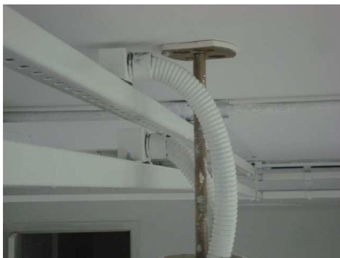
Figura 20 – Derivação para circuitos
