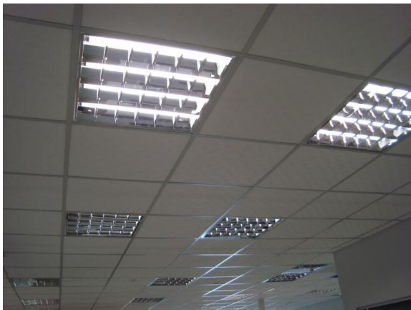
Figura 8 – Luminárias embutidas 4x16 W
