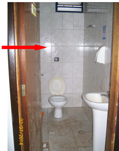
IS térreo – remover todo revestimento de parede (azulejo) e de piso
