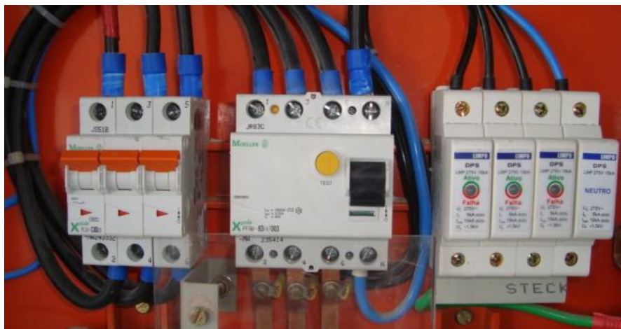
Figura 3 – Disjuntor, dispositivo DR e DPS em quadro
