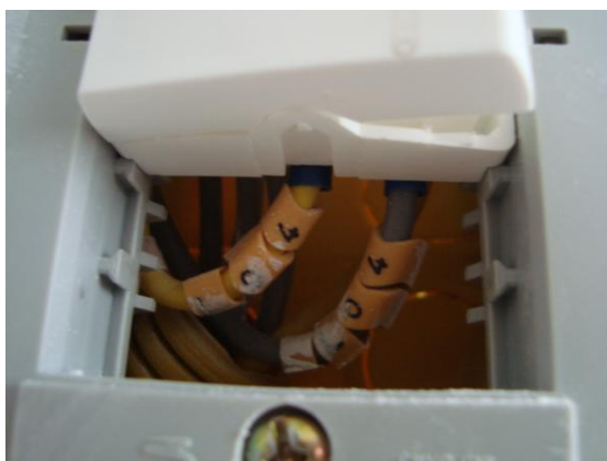
Figura 4 - Identificação de condutores, tomadas e interruptores
