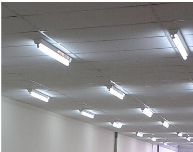
Figura 10 – Luminárias comercial 1x32 W
