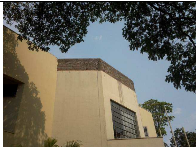
Figura 05C: Platibanda com pilaretes executados – Face externa
