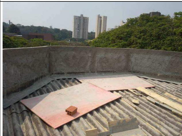
Figura 06C: Platibanda com pilaretes executados – Face interna
