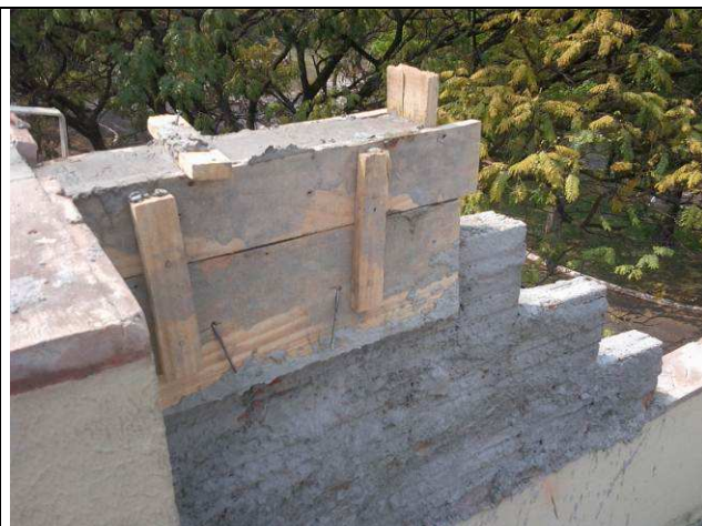
Figura 04C: Vigas-cinta – travamento da alvenaria
