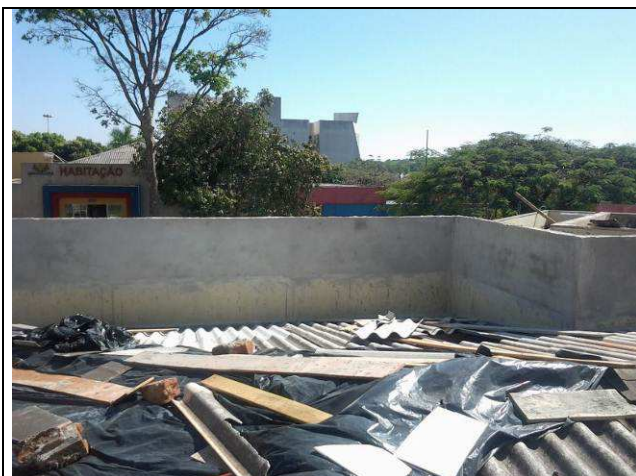
Figura 09C: Platibandas com aplicação de emboço paulista (emboço + reboco)
