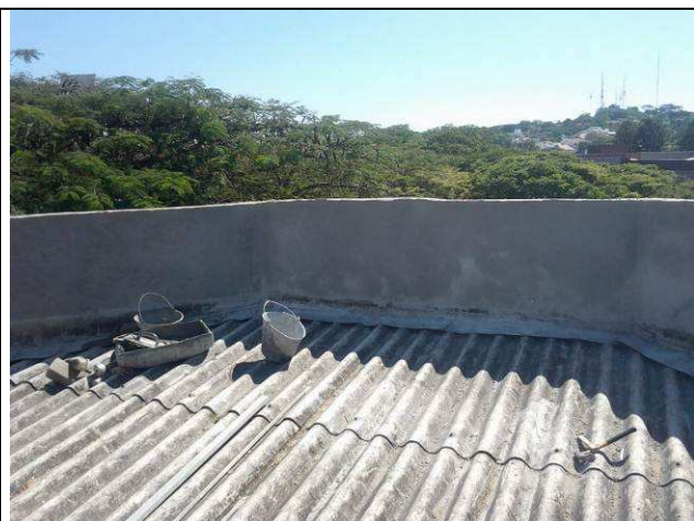
Figura 10C: Platibandas com aplicação de emboço paulista (emboço + reboco)
