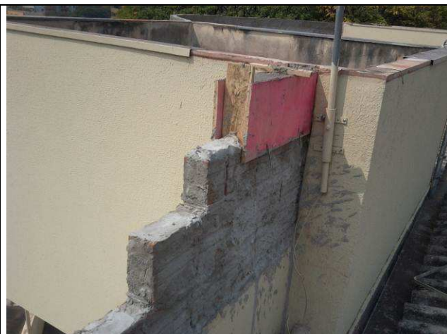
Figura 03C: Vigas-cinta – travamento da alvenaria
